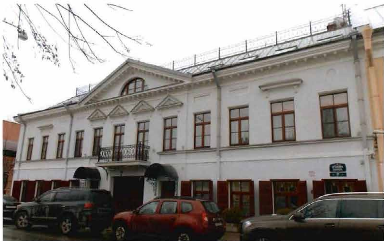
10. Фасад со стороны Крюкова канала 27.
