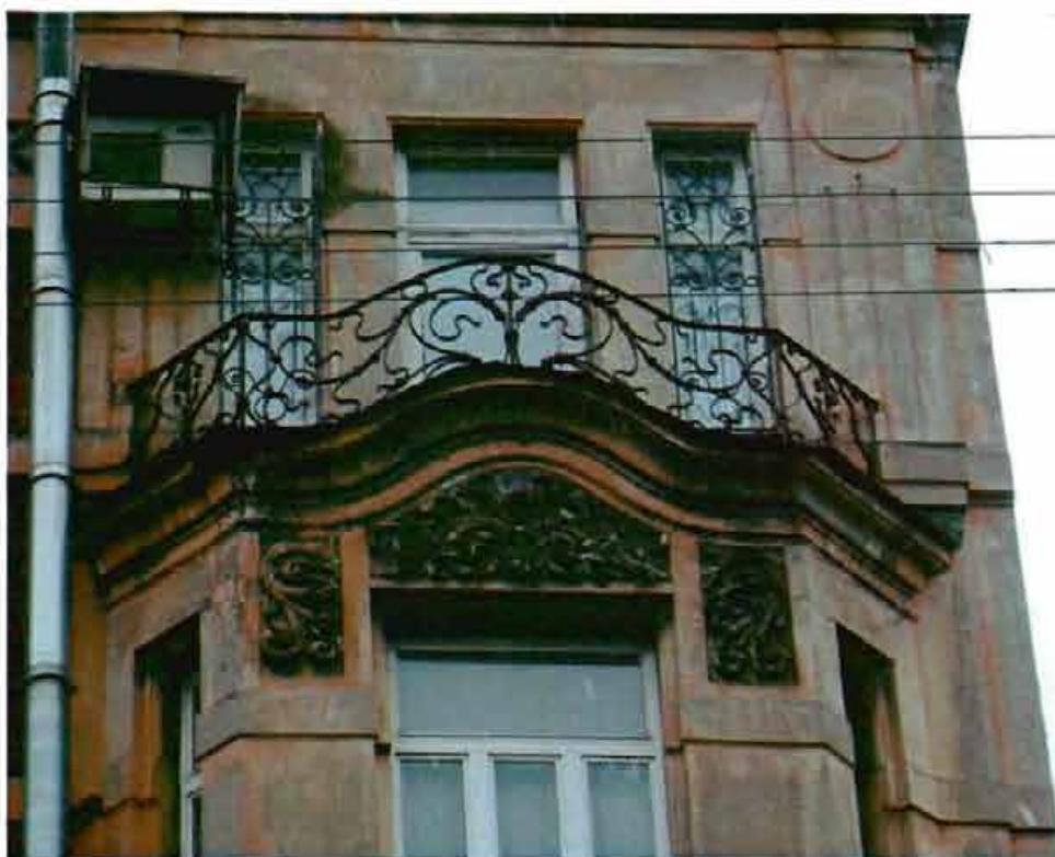
2. Фасад по переулку Макаренко 10. Балкон.
