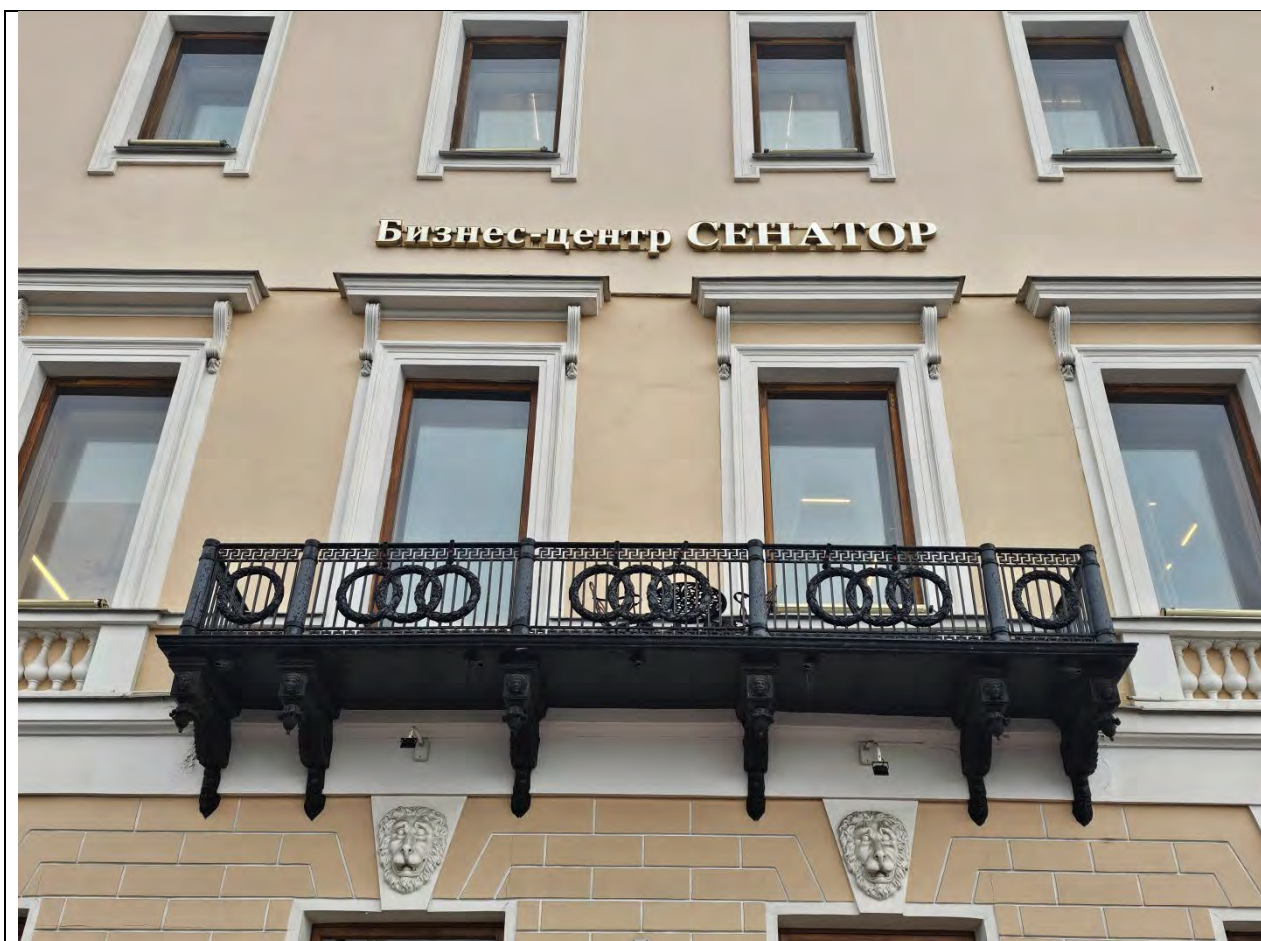
Фрагмент южного фасада с балконом.
