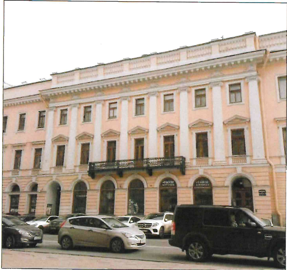
2. Западный фасад. Фрагмент.
