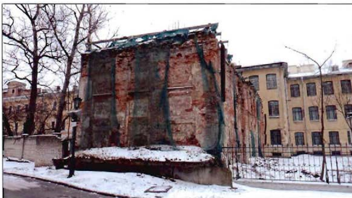
4. Объект культурного наследия. Северный фасад.
