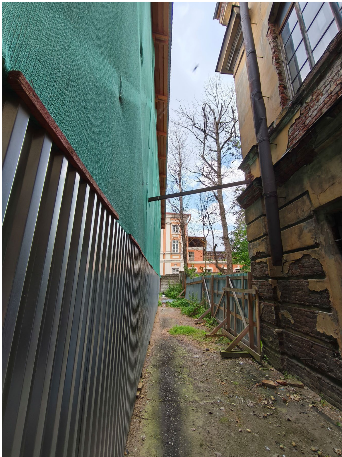
Фото 6. Восточная сторона ОКН.
