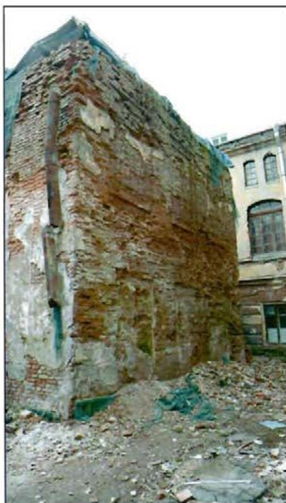
4. Южный фасад. Вид с юго-запада.
