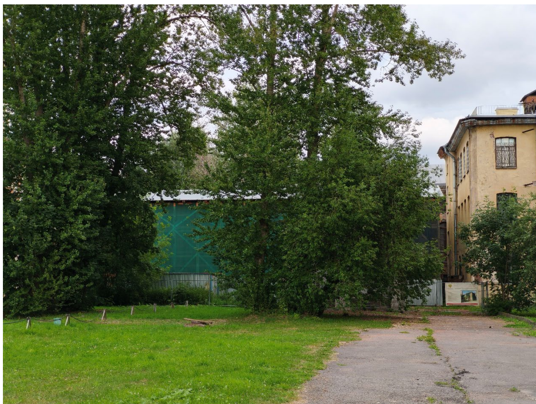
Фото 1. Общий вид на ОКН (на фотографии слева закрыт строительными лесами)
