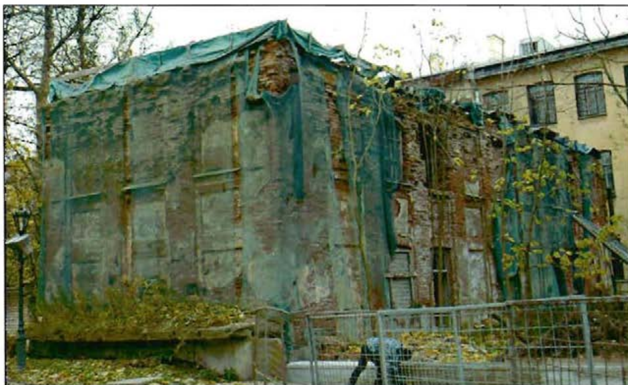
2. Общий вид с северо-запада.
