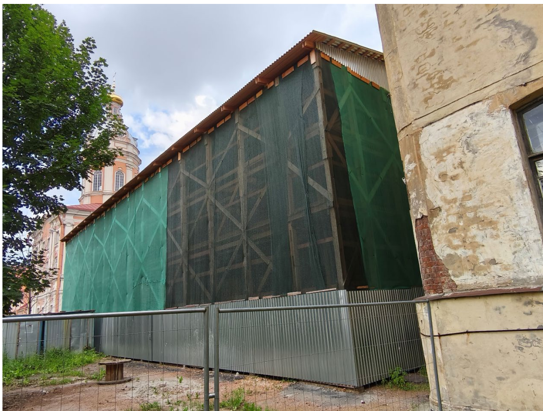
Фото 5. Западный фасад ОКН.
