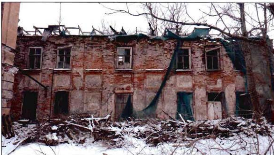
3. Объект культурного наследия. Восточный фасад.
