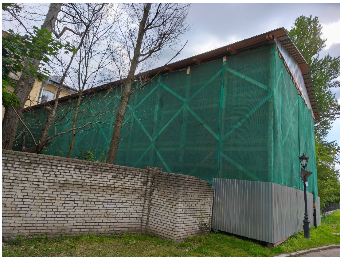
Фото 2. Вид на ОКН со стороны внутреннего проезда.
