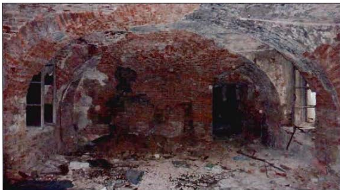
6. Коробовые с распалубкой своды. Помещение первого этажа.
