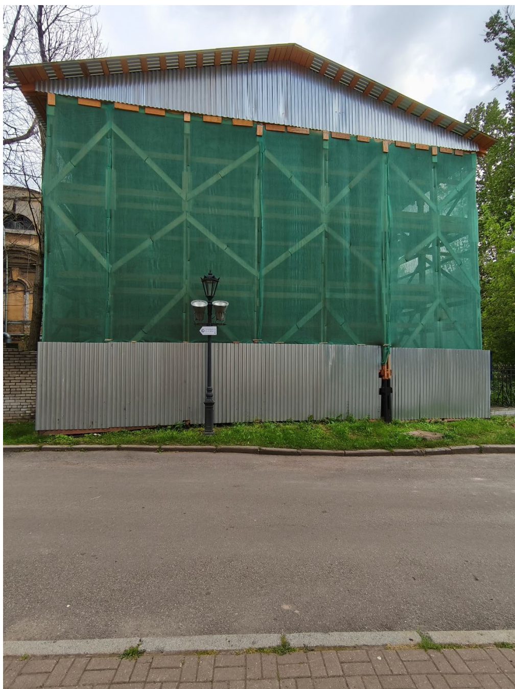
Фото 3. Вид на ОКН со стороны северного фасада.
