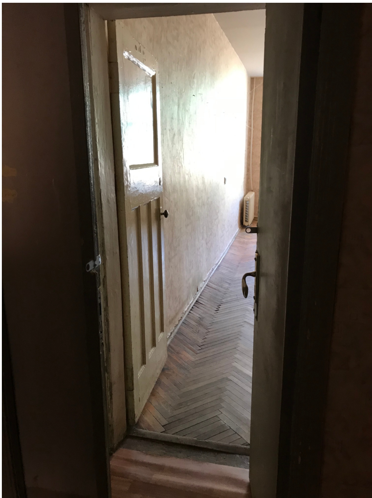
11. «Доходные дома М.С. Воронина». Санкт-Петербург, наб.реки Мойки, д.82, литера А,Б,Ш. Фрагмент интерьера кв. №12. Вход в пом.12. Фото: 20.10.2025.
