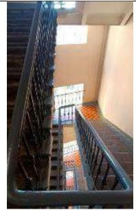
перильное ограждение оконных проемов площадок вспомогательной лестницы – черного металла с декоративными деталями бронзового литья (рисунок вертикальные прутья геометрическим дубовые профилированные поручни;
