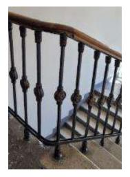
вспомогательная двухмаршевая лестница слева от парадной лестницы - c известняковыми металлическим ступенями ПО косоурам, с перильным ограждением черного металла с декоративными деталями бронзового литья (рисунок вертикальные прутья геометрическим орнаментом); дубовые профилированные поручни;
