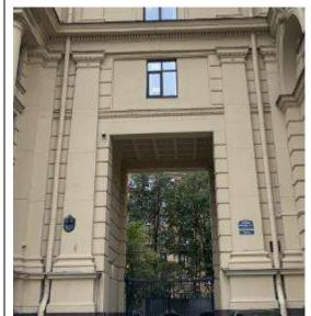
оформление проезда, расположенного в переходе — цоколь, облицованный плитами красного гранита, кирпичный руст стен, квадратные кессоны перекрытия;
