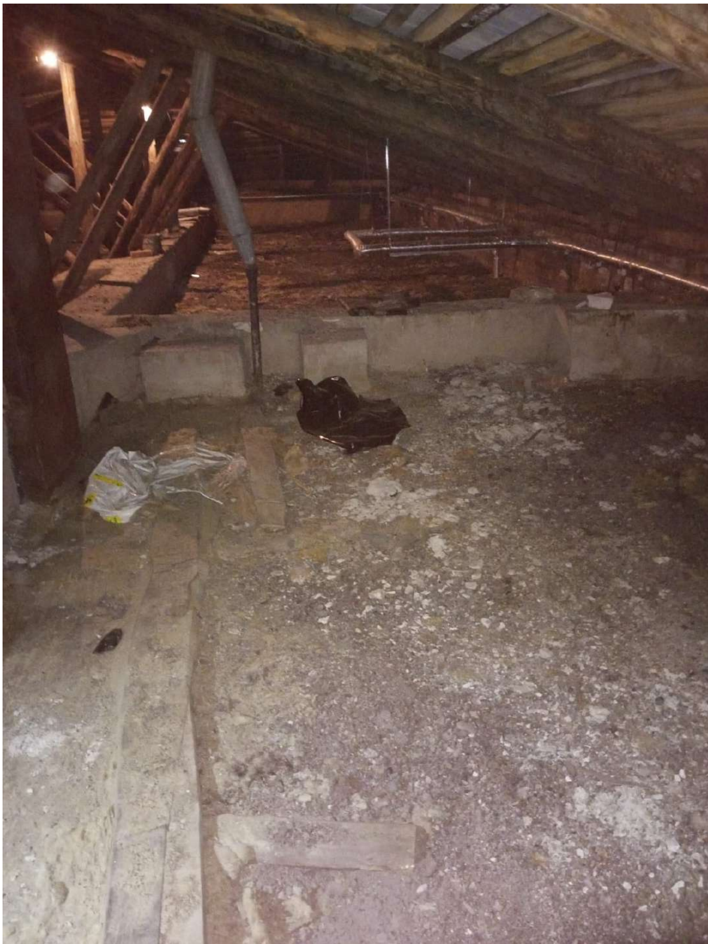
Фото 23. Общий вид чердачного пространства. Дата фотофиксации - 28.09.2024г.
