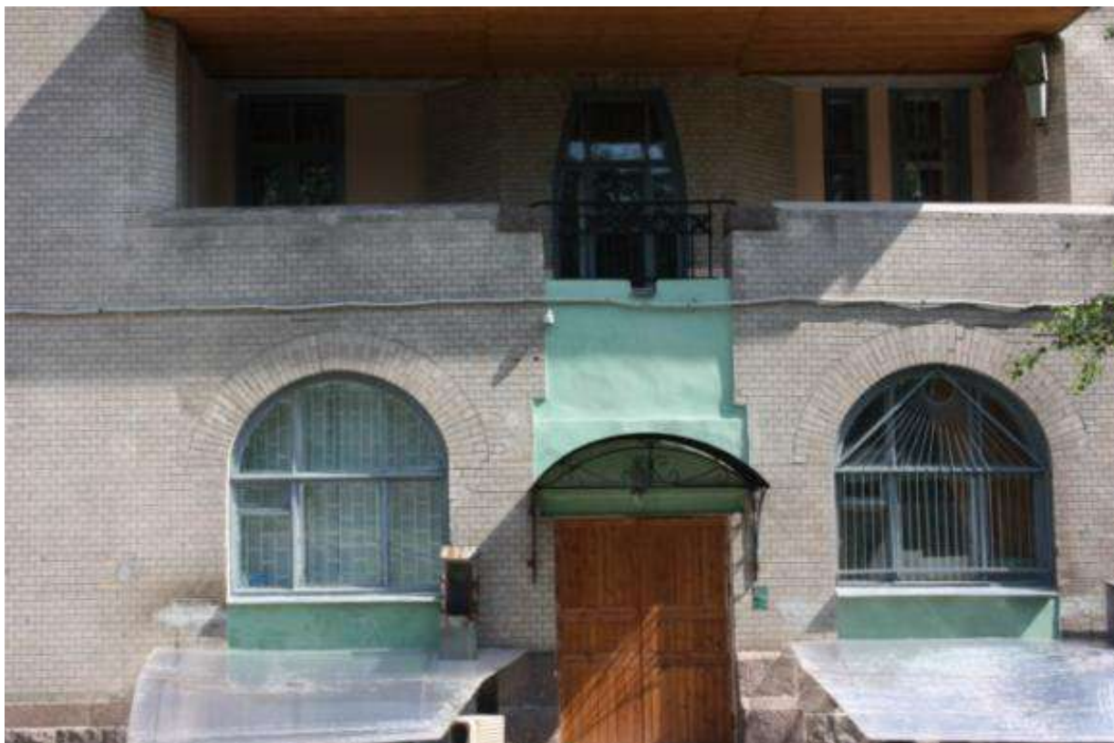
11. Фрагмент дворового фасада. Фото 13.06.2009. https://www.citywalls.ru/
