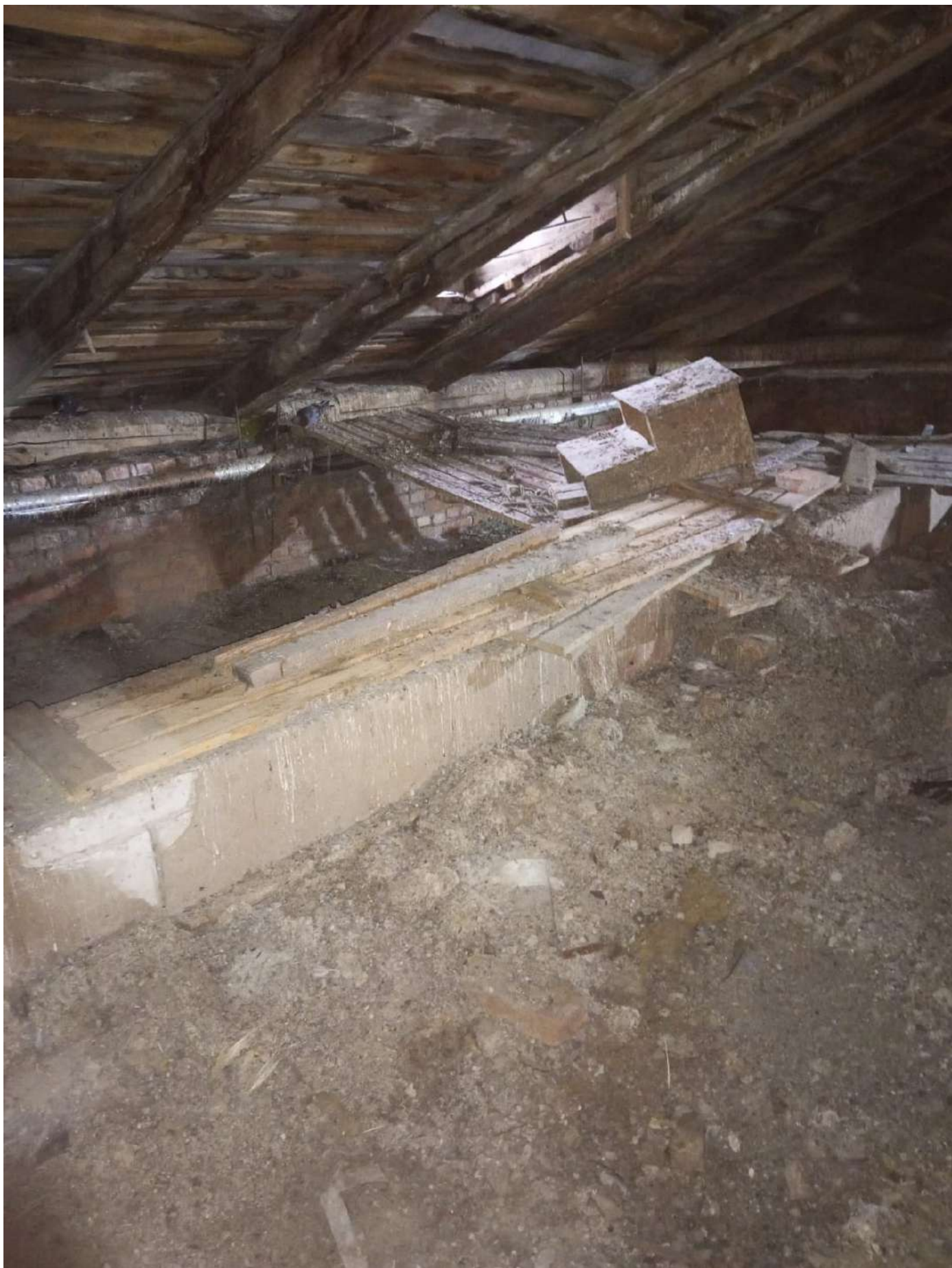
Фото 19. Общий вид чердачного пространства. Дата фотофиксации - 28.09.2024г.
