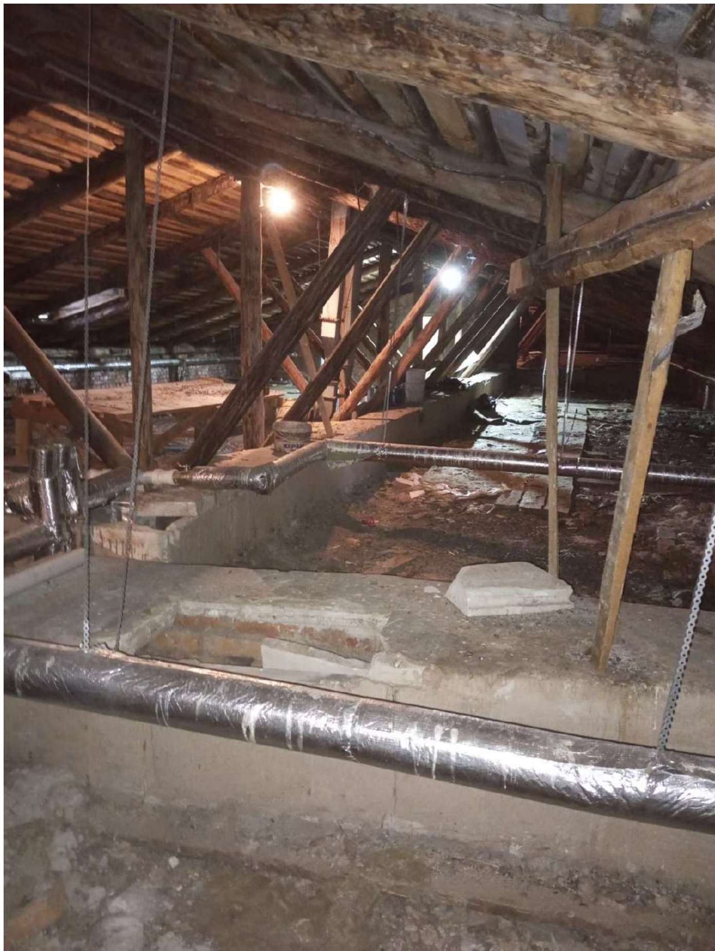
Фото 22. Общий вид чердачного пространства. Дата фотофиксации - 28.09.2024г.
