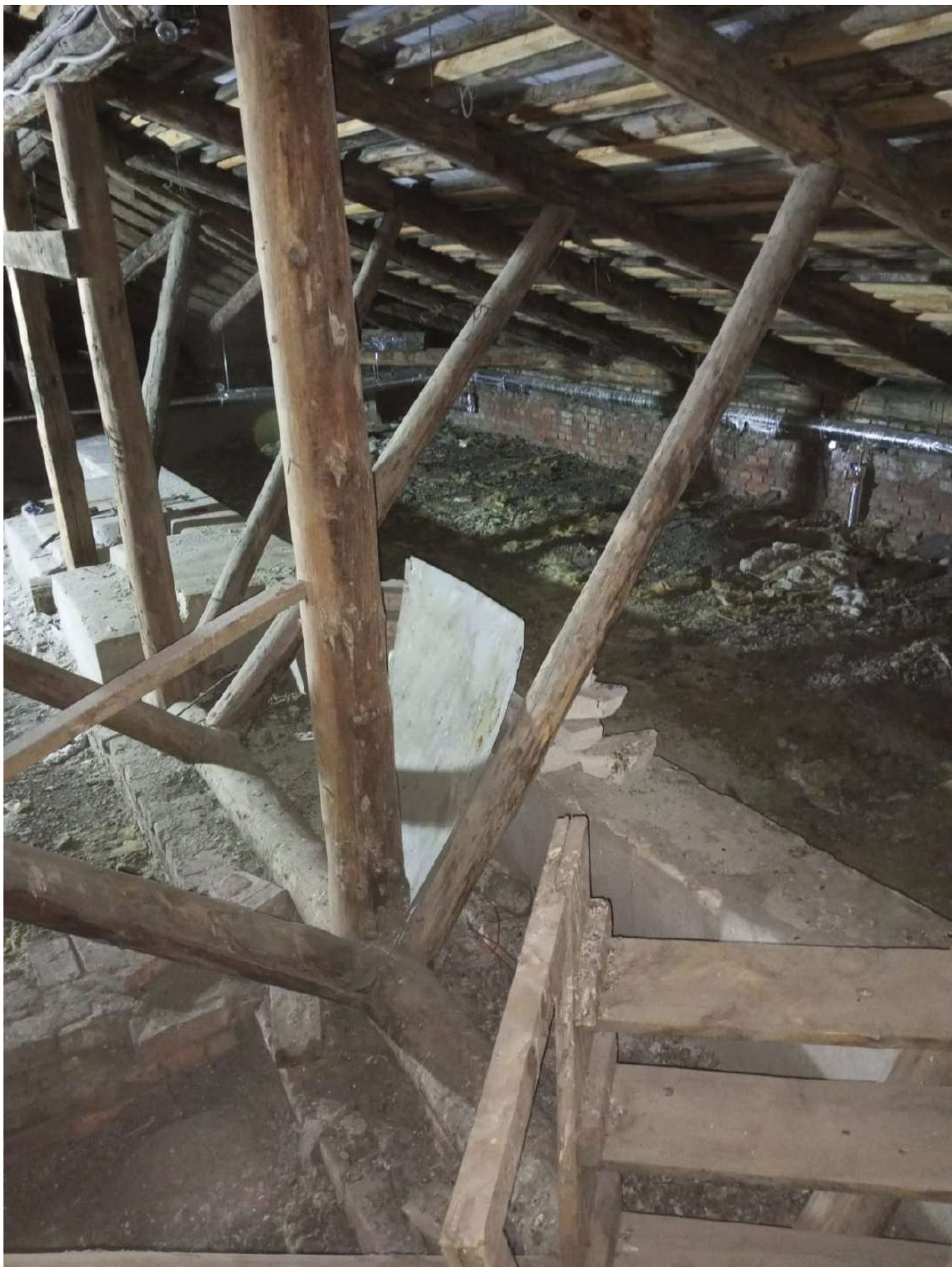
Фото 20. Общий вид чердачного пространства. Дата фотофиксации - 28.09.2024г.
