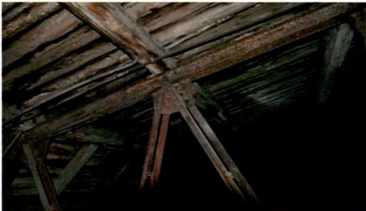
8. Деревянная стропильная система по металлическим клепаным фермам.
