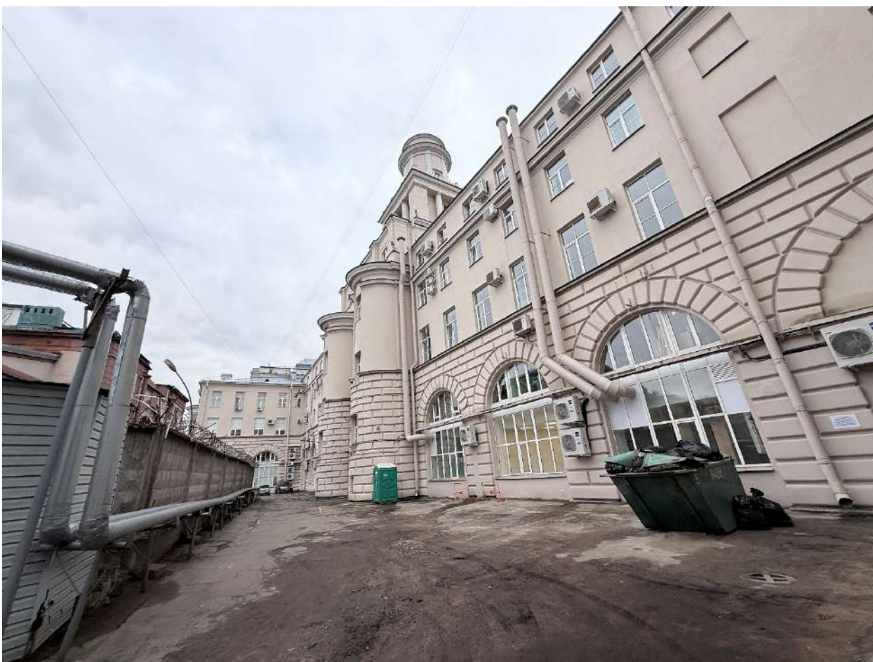
Фото 2. Общий вид дворового фасада.
