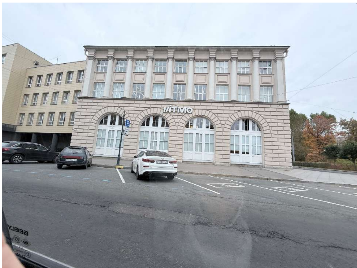
Фото 3. Общий вид фасада со стороны Саблинской ул.
