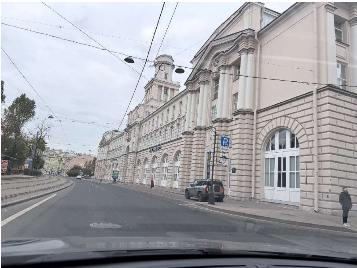
Фото 1. Общий вид фасада со стороны Кронверкского пр.
