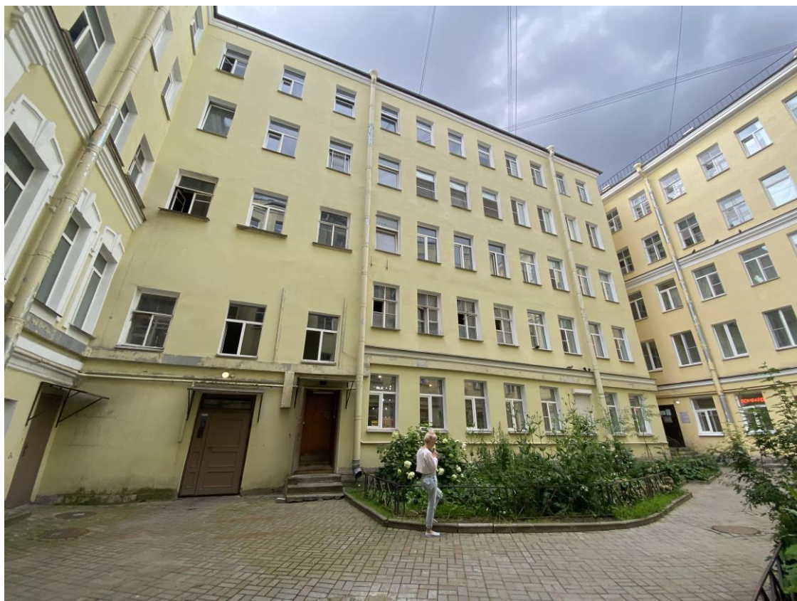
Фото 4. Вид на фасад северного дворового корпуса выявленного объекта культурного наследия «Дом А.Н. Успенской».
