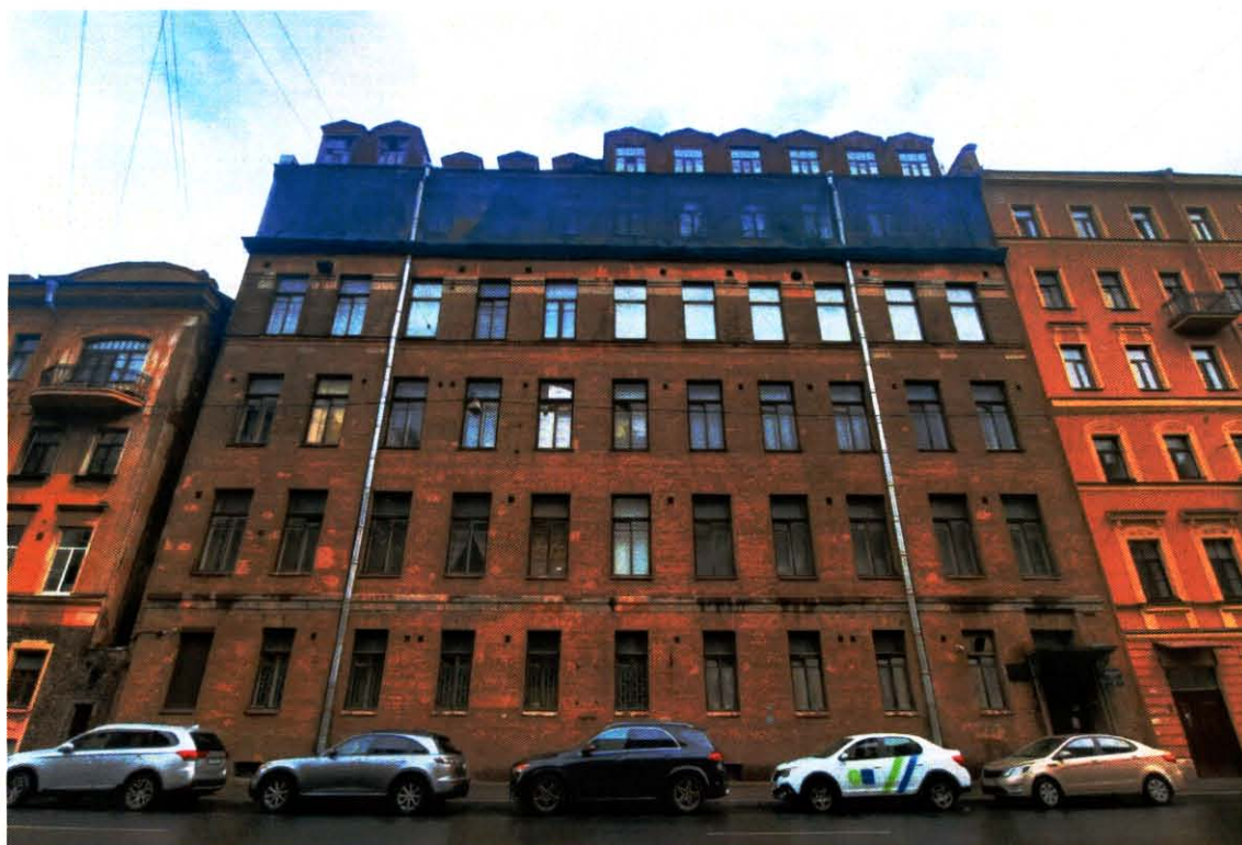
1. Общий вид на юго-западный фасад здания (27.09.2024)
