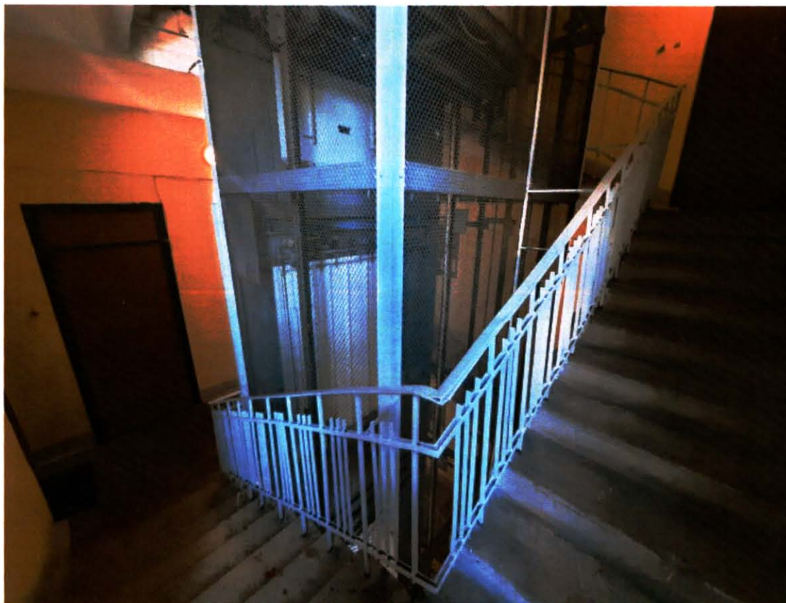
18. Лестница Л-3 здания (30.09.2024)
