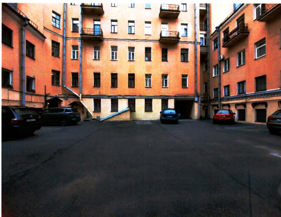
20. Общий вид на часть территории объекта культурного наследия, южный двор (03.10.2024)
