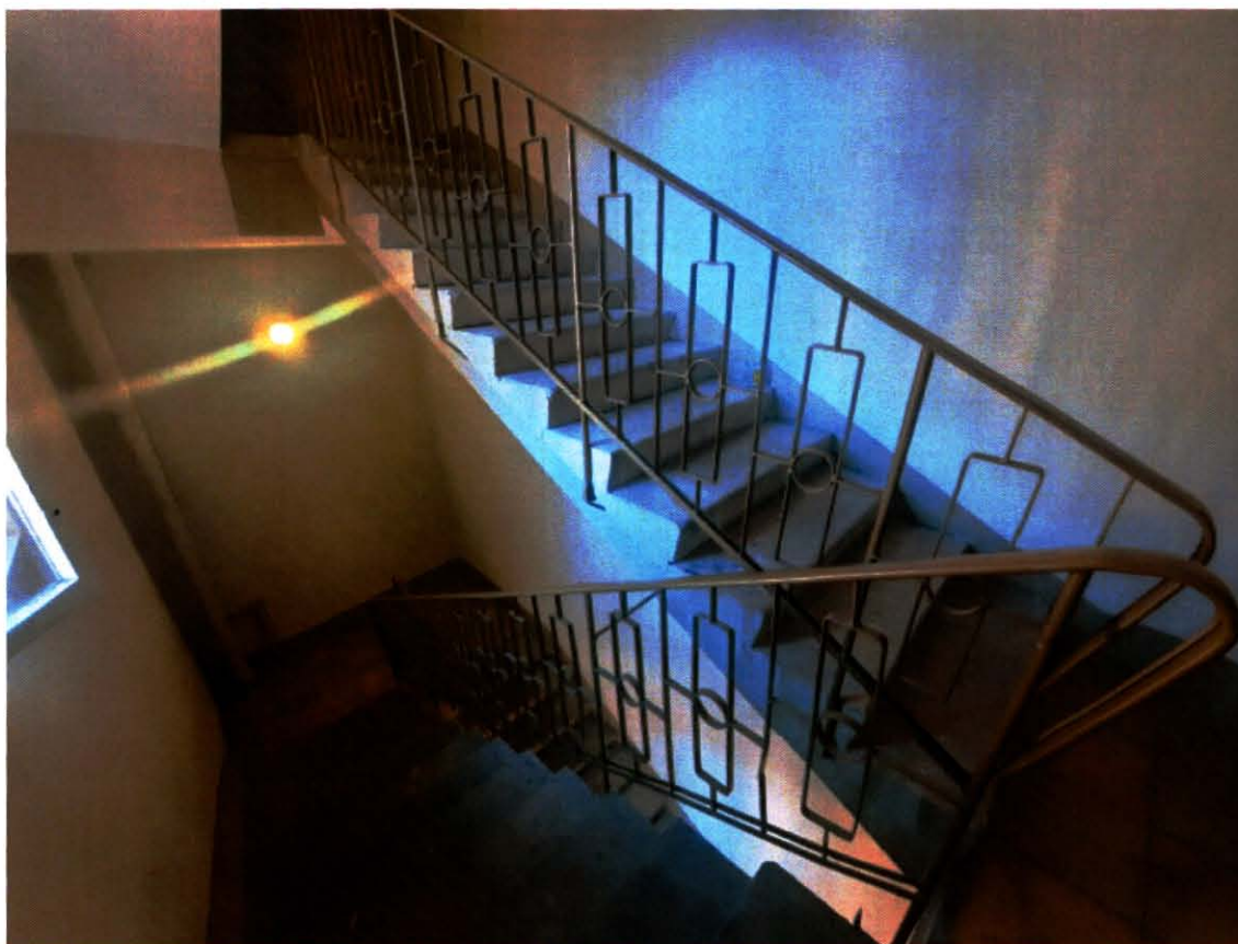
17. Лестница Л-2 здания (30.09.2024)
