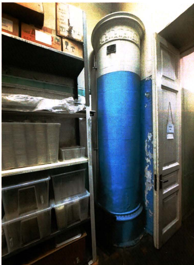
4. Печь в помещениях 3 этажа здания (27.09.2024)
