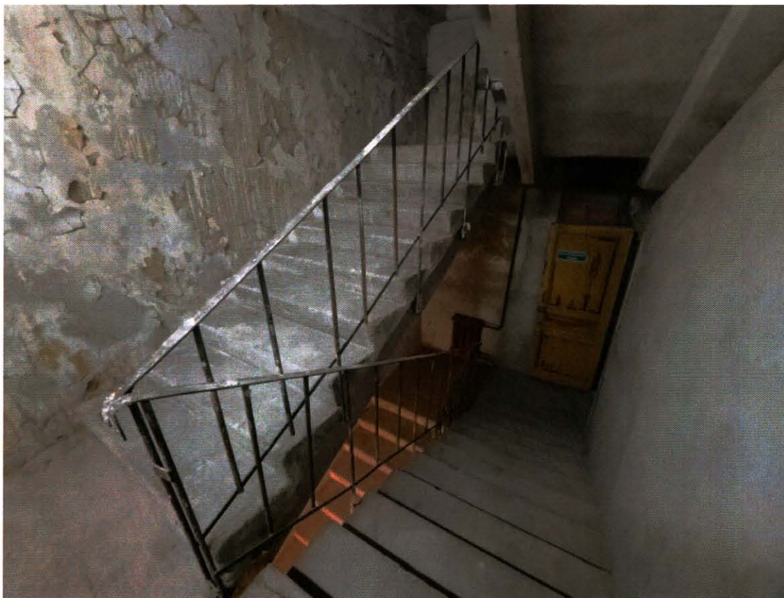
5. Лестница Л-1 здания (27.09.2024)
