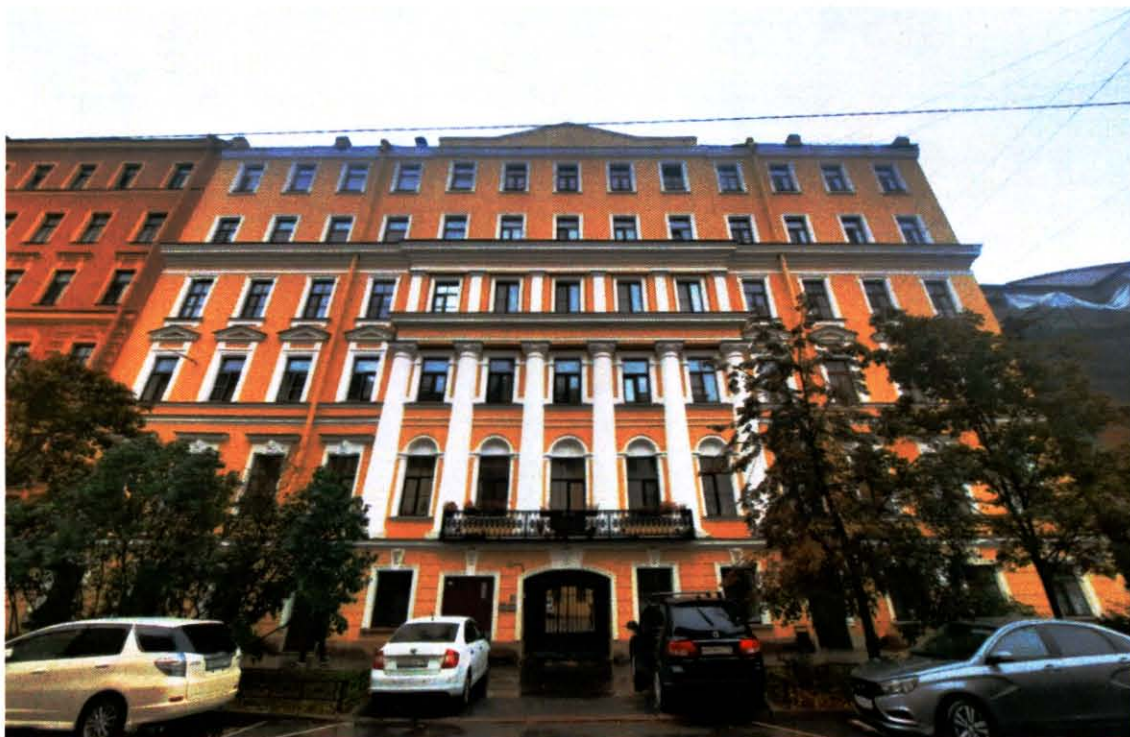
7. Общий вид на юго-восточный фасад здания (04.10.2024)
