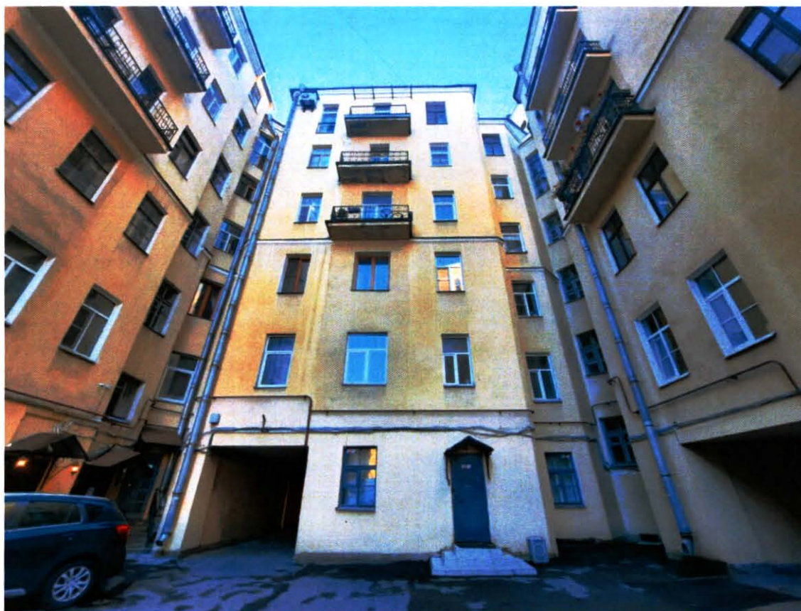
13. Общий вид на дворовый юго-восточный фасад здания (северный двор) (30.09.2024)
