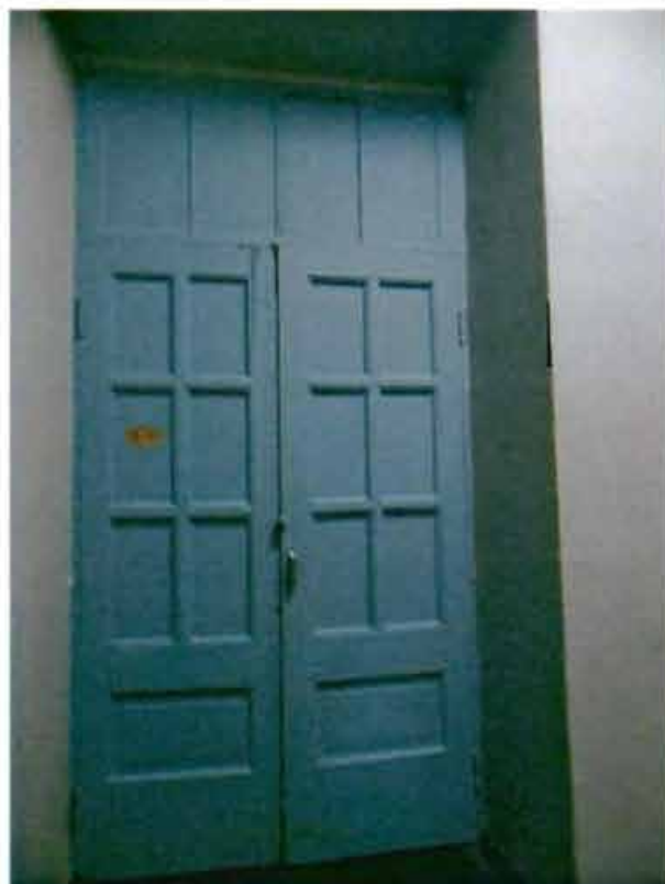
12. Дверные заполнения помещений.
