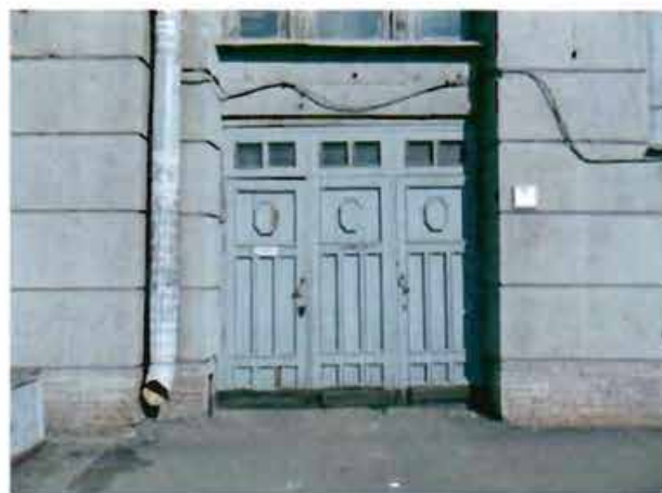
2. Фрагмент южного фасада.
