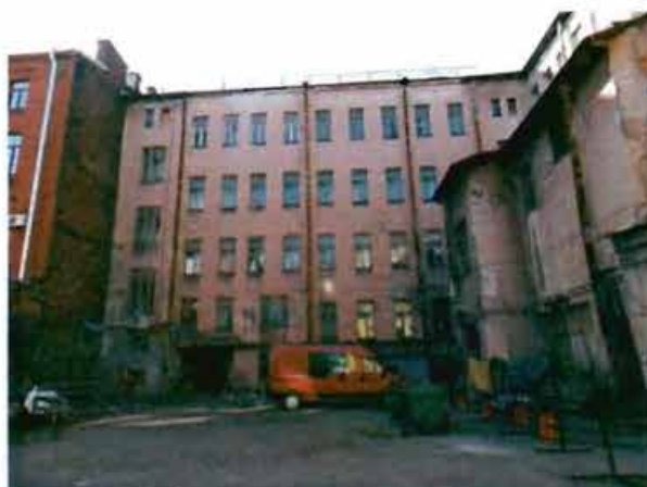
6. Северный дворовой фасад.
