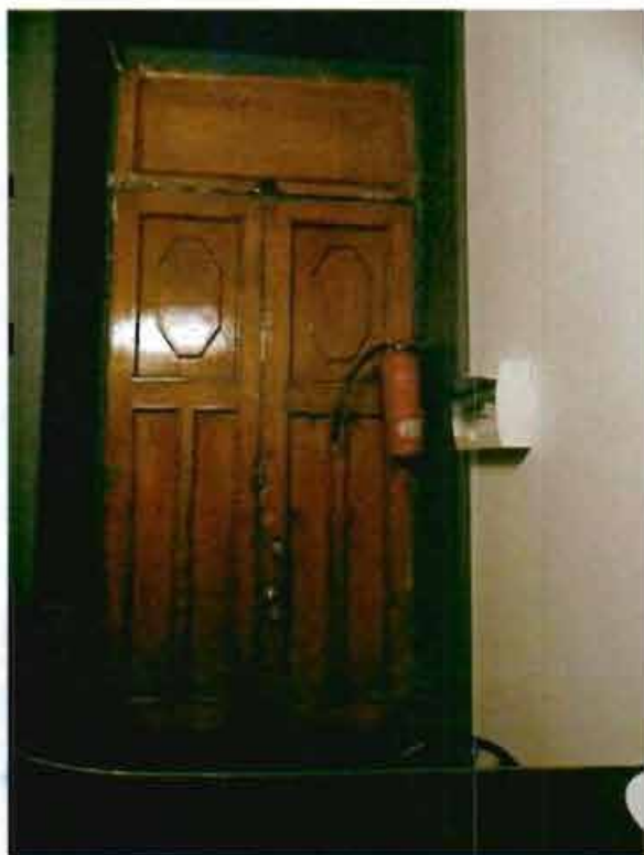
11. Дверные заполнения помещений.
