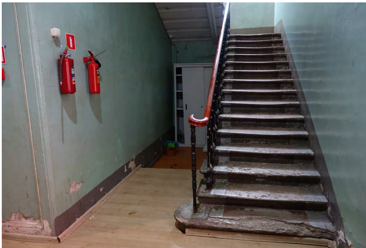
30. «Особняк и контора О.Ф. Кирхнера» в составе ОКН(Р) «Комплекс картонажно-переплетной фабрики товарищества "Отто Кирхнер"» (Б. Пушкарская ул., 10, лит. Г)
