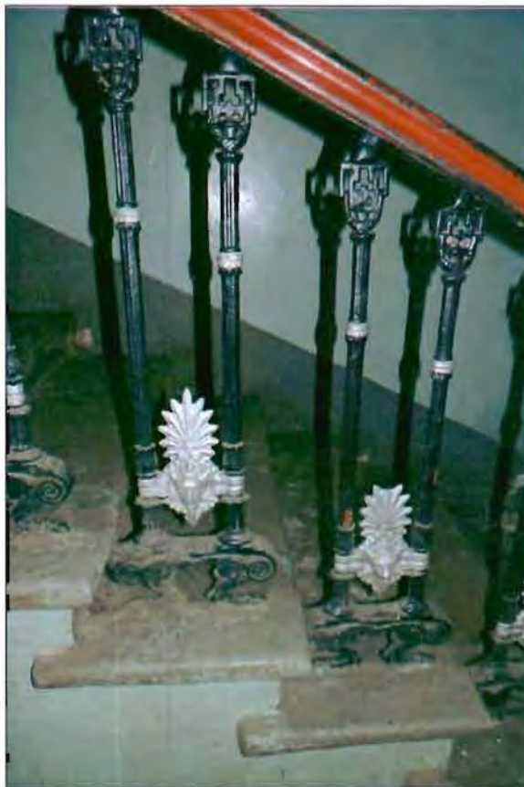
2. Интерьер. Фрагмент лестничного ограждения.
