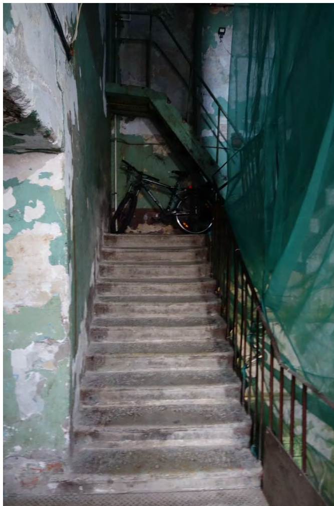
43. «Производственное здание (главная контора и типография)» в составе ОКН(Р) «Комплекс картонажно-переплетной фабрики товарищества "Отто Кирхнер"» (Б. Пушкарская ул., 10, лит. Е)
