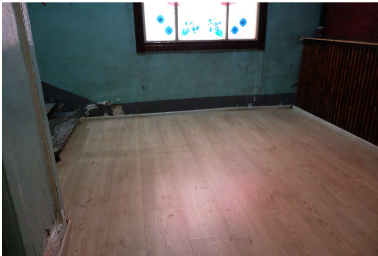
33. «Особняк и контора О.Ф. Кирхнера» в составе ОКН(Р) «Комплекс картонажно-переплетной фабрики товарищества "Отто Кирхнер"» (Б. Пушкарская ул., 10, лит. Г)
