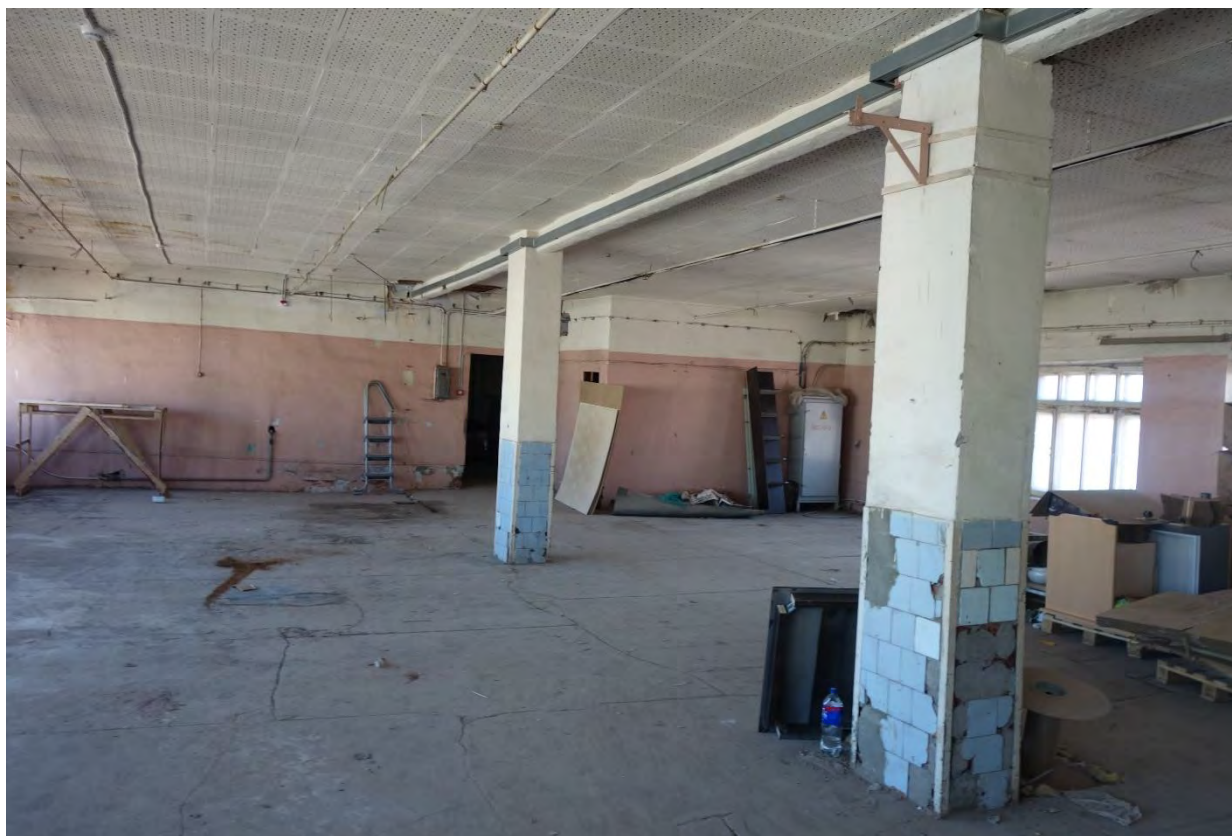
45. «Производственное здание (главная контора и типография)» в составе ОКН(Р) «Комплекс картонажно-переплетной фабрики товарищества "Отто Кирхнер"» (Б. Пушкарская ул., 10, лит. Е)
