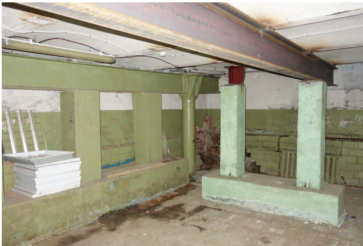
36. «Производственное здание (главная контора и типография)» в составе ОКН(Р) «Комплекс картонажно-переплетной фабрики товарищества "Отто Кирхнер"» (Б. Пушкарская ул., 10, лит. Е)
