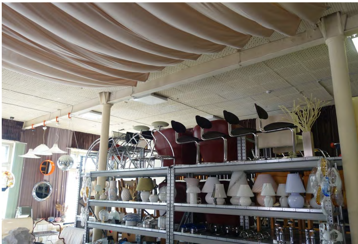
39. «Производственное здание (главная контора и типография)» в составе ОКН(Р) «Комплекс картонажно-переплетной фабрики товарищества "Отто Кирхнер"» (Б. Пушкарская ул., 10, лит. Е)
