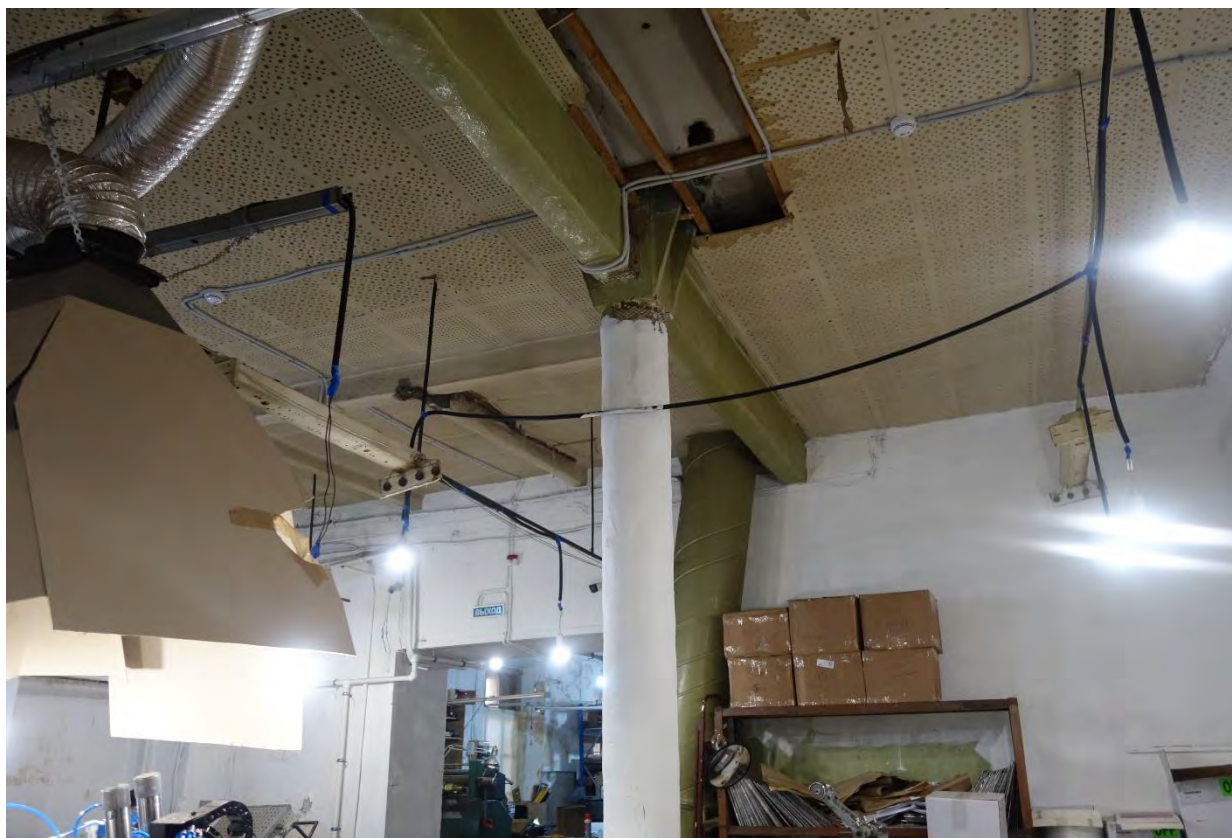
41. «Производственное здание (главная контора и типография)» в составе ОКН(Р) «Комплекс картонажно-переплетной фабрики товарищества "Отто Кирхнер"» (Б. Пушкарская ул., 10, лит. Е)
