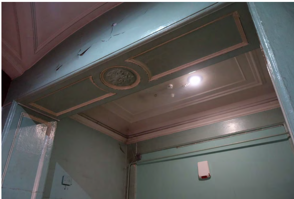
32. «Особняк и контора О.Ф. Кирхнера» в составе ОКН(Р) «Комплекс картонажно-переплетной фабрики товарищества "Отто Кирхнер"» (Б. Пушкарская ул., 10, лит. Г)
