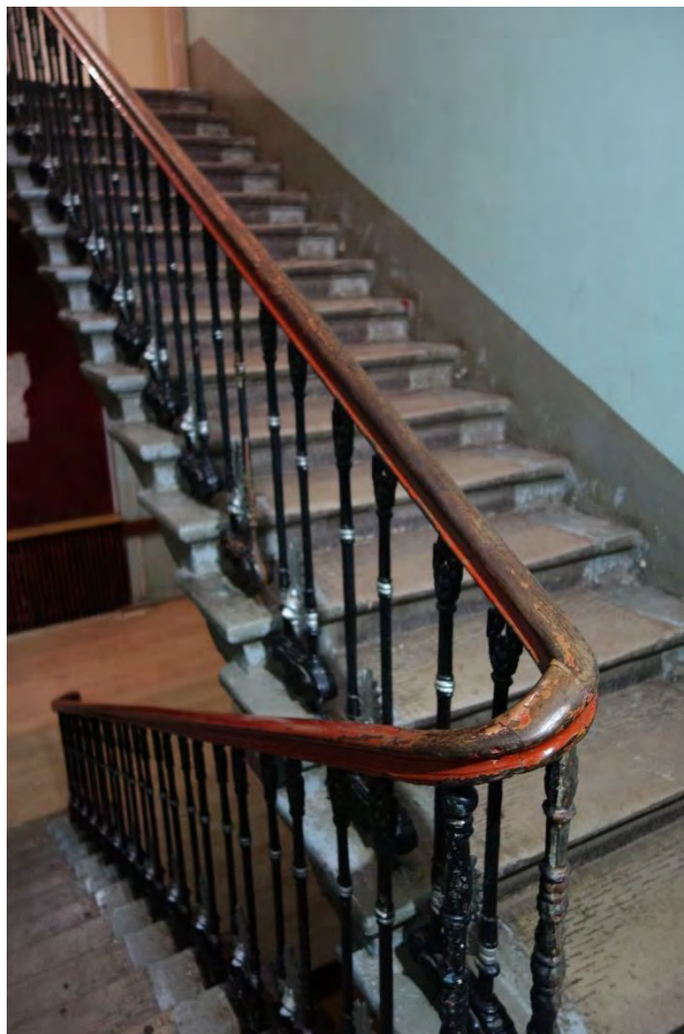
31. «Особняк и контора О.Ф. Кирхнера» в составе ОКН(Р) «Комплекс картонажно-переплетной фабрики товарищества "Отто Кирхнер"» (Б. Пушкарская ул., 10, лит. Г)
