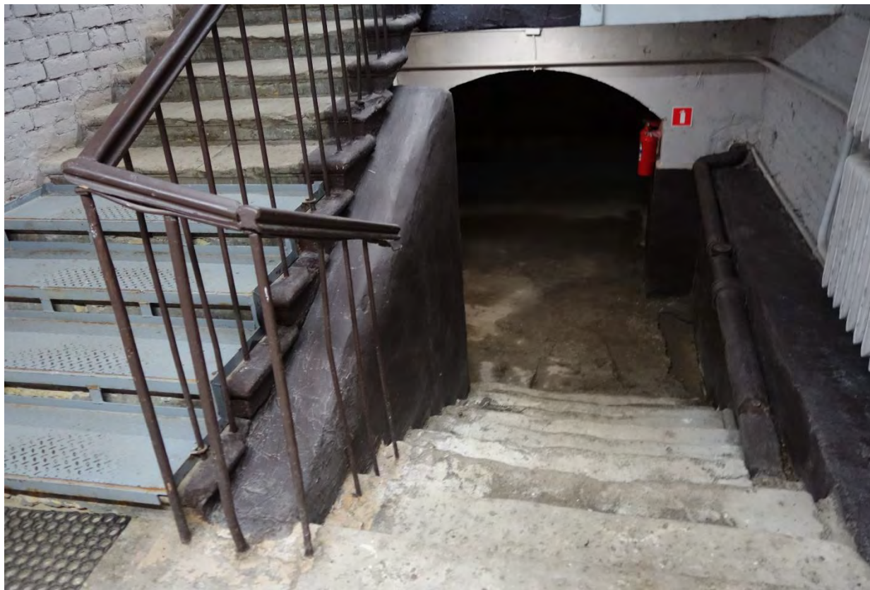
34. «Производственное здание (главная контора и типография)» в составе ОКН(Р) «Комплекс картонажно-переплетной фабрики товарищества "Отто Кирхнер"» (Б. Пушкарская ул., 10, лит. Е)
