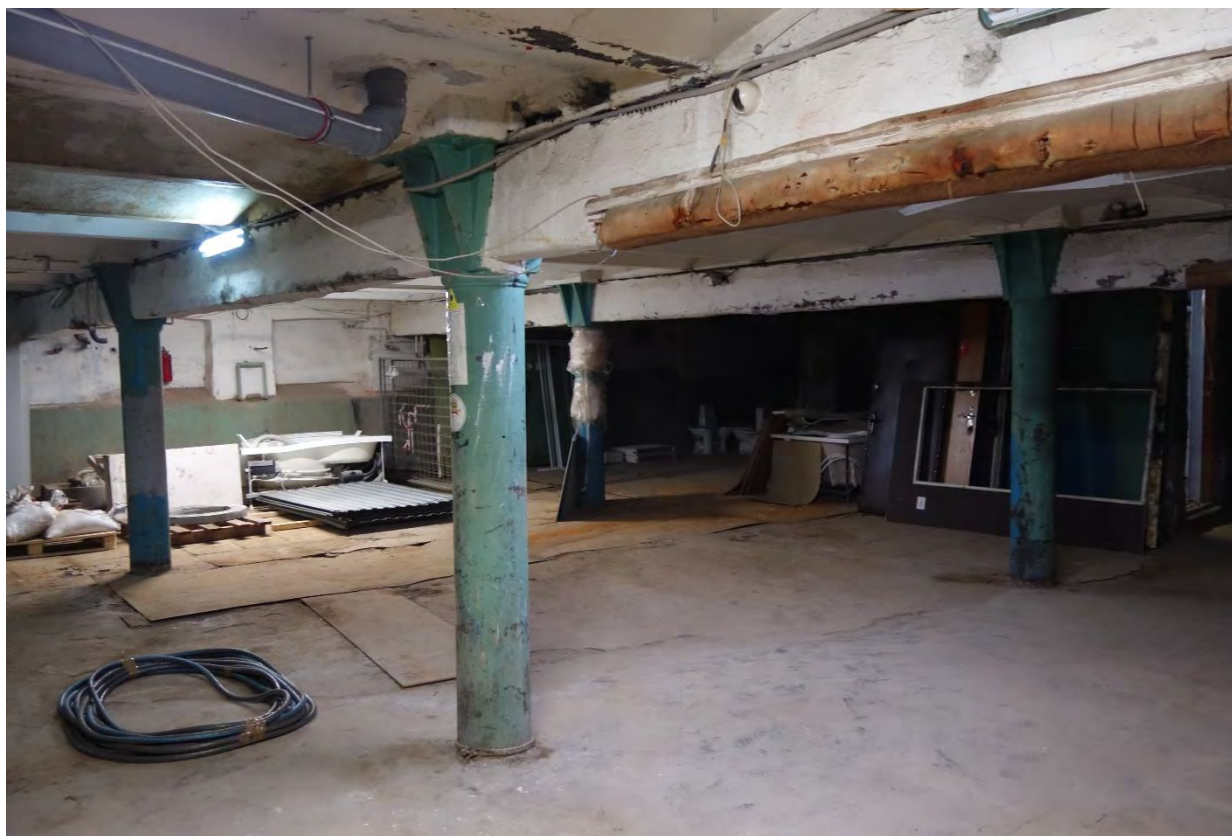
35. «Производственное здание (главная контора и типография)» в составе ОКН(Р) «Комплекс картонажно-переплетной фабрики товарищества "Отто Кирхнер"» (Б. Пушкарская ул., 10, лит. Е)
