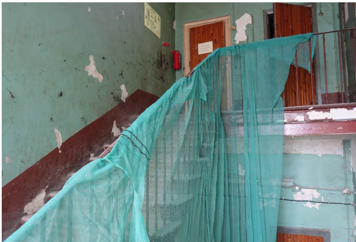
46. «Производственное здание (главная контора и типография)» в составе ОКН(Р) «Комплекс картонажно-переплетной фабрики товарищества "Отто Кирхнер"» (Б. Пушкарская ул., 10, лит. Е)
