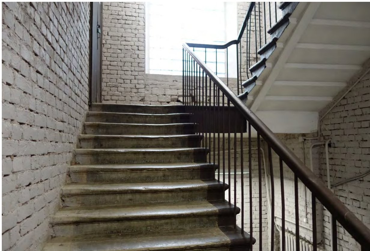
38. «Производственное здание (главная контора и типография)» в составе ОКН(Р) «Комплекс картонажно-переплетной фабрики товарищества "Отто Кирхнер"» (Б. Пушкарская ул., 10, лит. Е)
