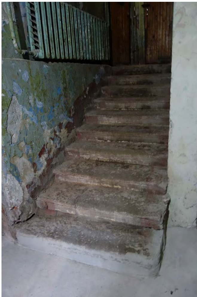
40. «Производственное здание (главная контора и типография)» в составе ОКН(Р) «Комплекс картонажно-переплетной фабрики товарищества "Отто Кирхнер"» (Б. Пушкарская ул., 10, лит. Е)
