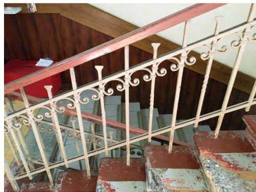
две исторические лестницы в торцах здания: местоположение, габариты, конфигурация, тип (двухмаршевые на косоуре), с известняковыми ступенями и металлическими ограждениями из прутьев круглого сечения и поручня.
