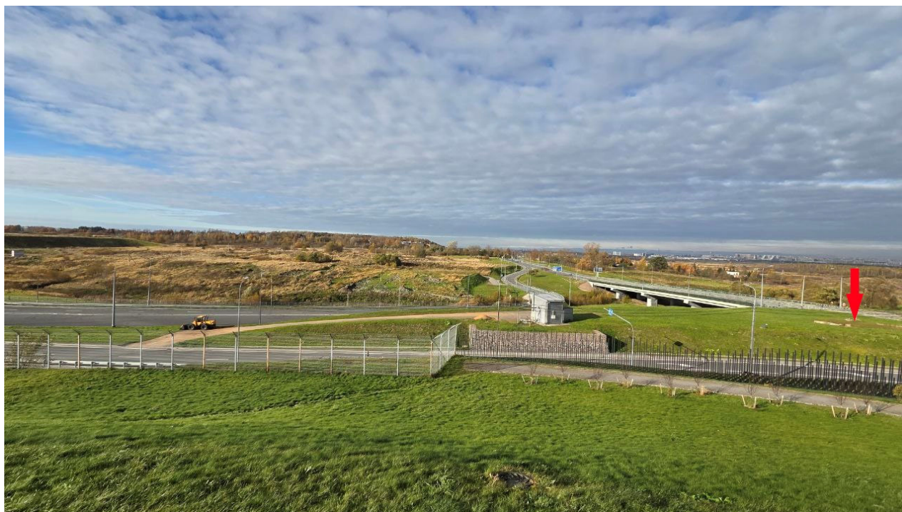
Рис. 34. Вид с юга (со стороны современной церкви) на развязку Соколиной ул. и руинированные остатки церкви Смоленской Божьей Матери (отмечены красной стрелкой). Фотофиксация 2025 г.
