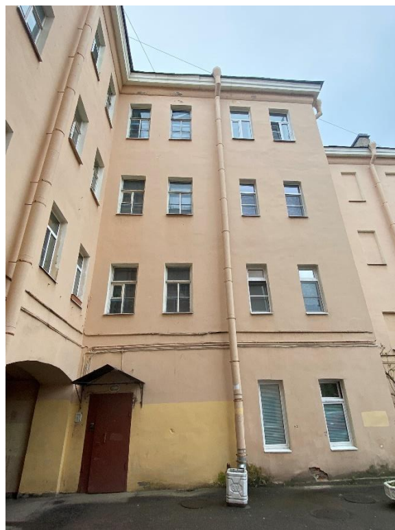
Фото 12. Вид на дворовой фасад объекта культурного наследия «Угловой дом».
