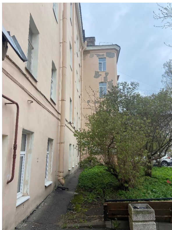
Фото 13. Вид на дворовой фасад объекта культурного наследия «Угловой дом».
