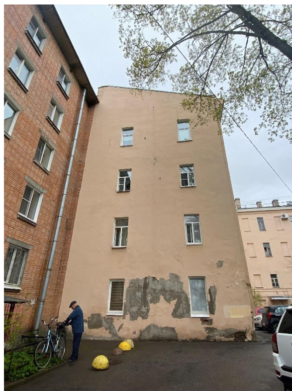
Фото 14. Вид на дворовой фасад объекта культурного наследия «Угловой дом».
