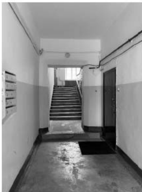
Фото 16. Вид лестницы 2 ЛК.
