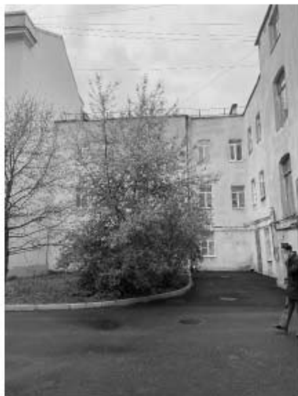
Фото 10. Вид на дворовый фасад дома № 12 по улице Ленинградской.
