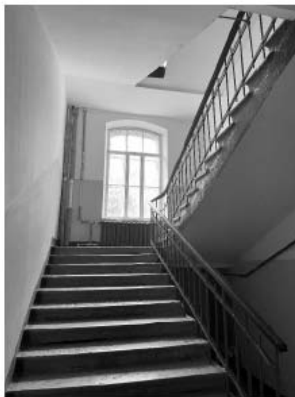
Фото 17. Вид лестницы 2 ЛК.
