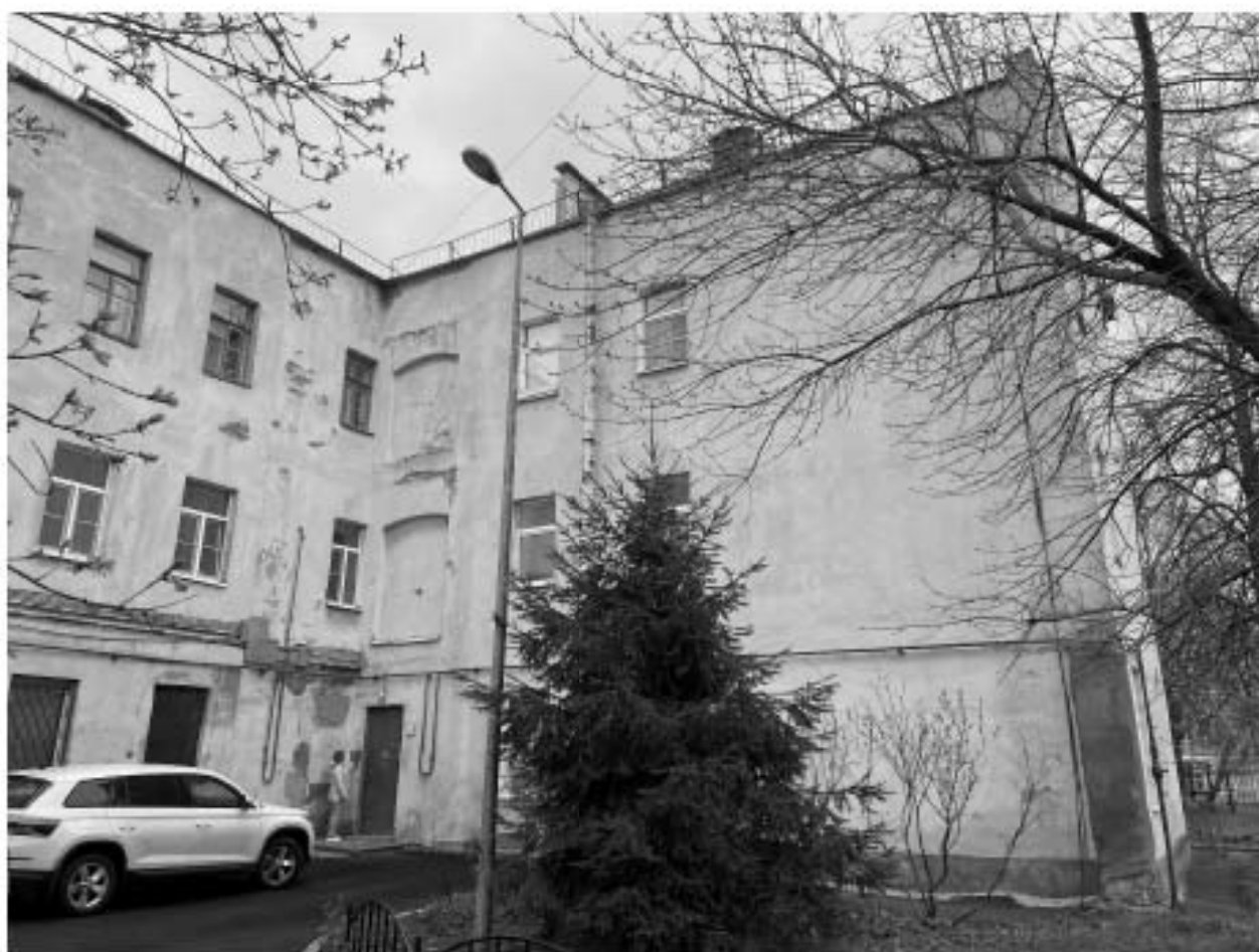
Фото 9. Вид на дворовые фасады дома № 12 по Ленинградской улице.
