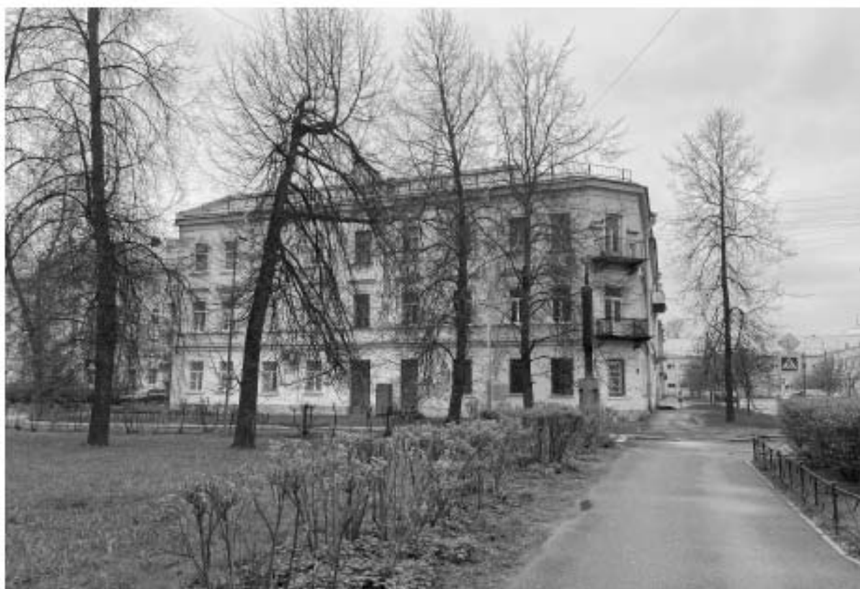
Фото 5. Вид на дом № 12 по улице Ленинградской.
