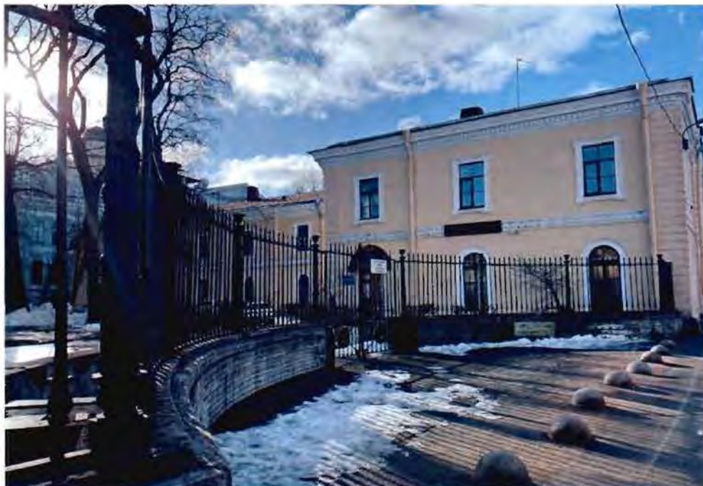
1. Общий вид на объект культурного наследия.
