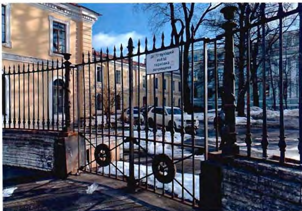
2. Общий вид на объект культурного наследия.
