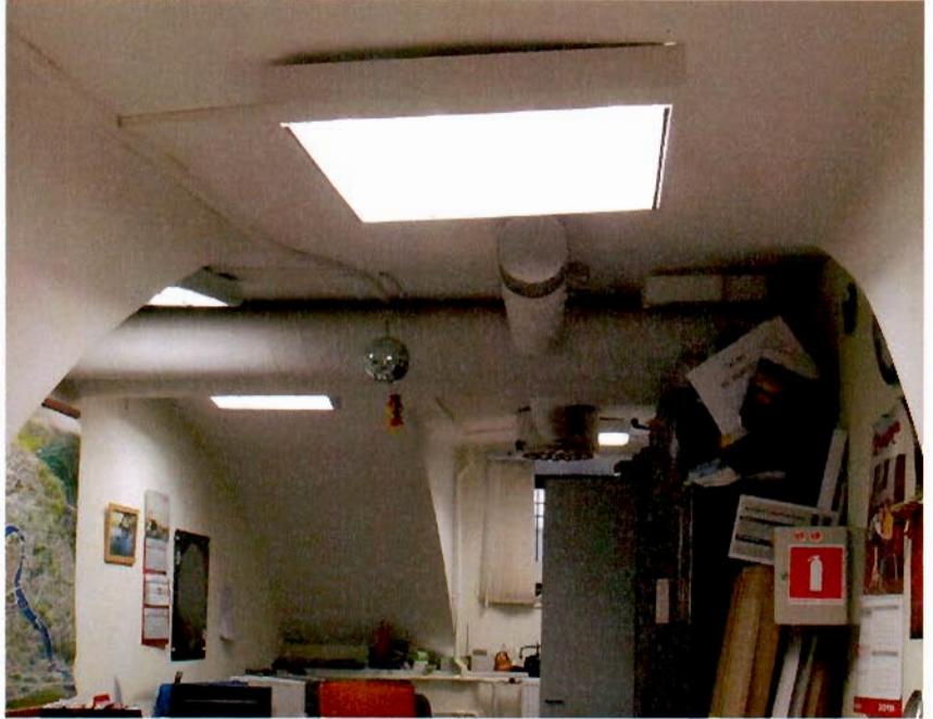
9. Своды подвальных помещений.
