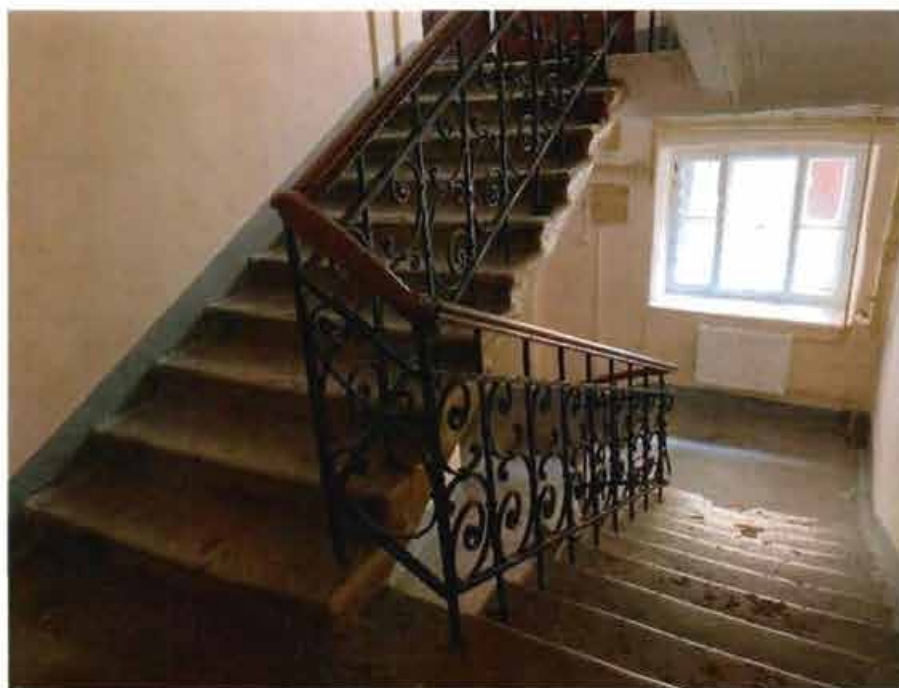
4. Помещение лестницы 2ЛК объекта культурного наследия.
