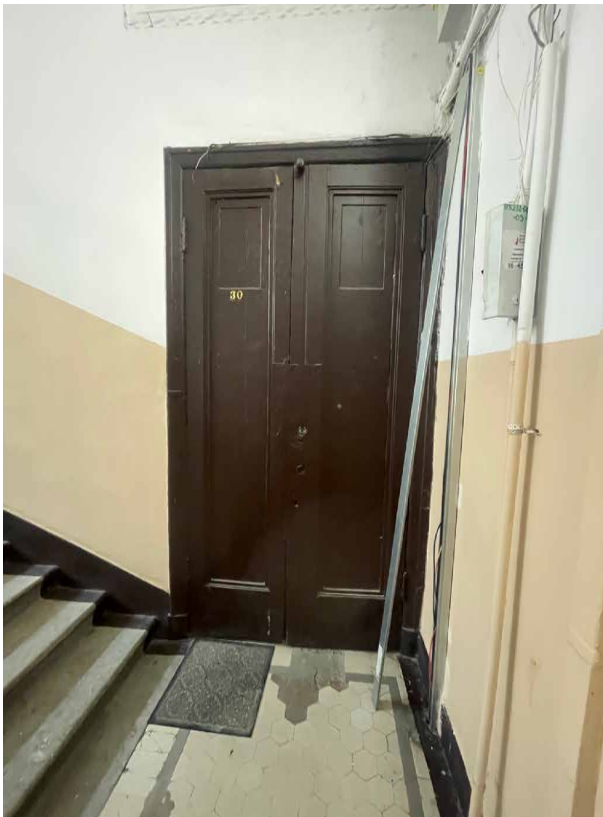
3. Входная дверь квартиры со стороны лестничной клетки.
