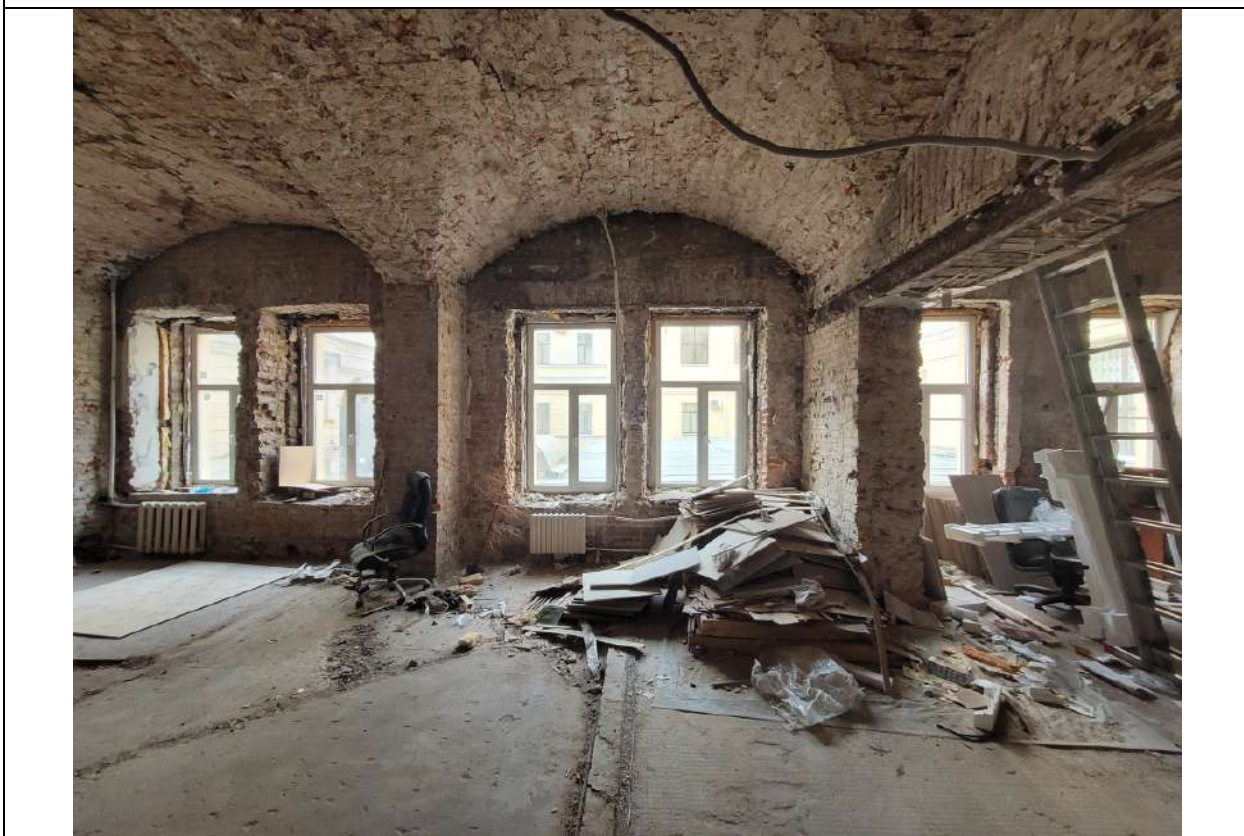
Фото № 14. ОКНРЗ «Особняк Дурново П.П.». Интерьеры помещения 15-Н (помещения 1–10 восточного крыла северного корпуса по планам ПИБ 2013г.). Крестовый свод. Вид на угловые опоры. Исторические оконные проемы. Дата съемки: 20.10.2025г.
