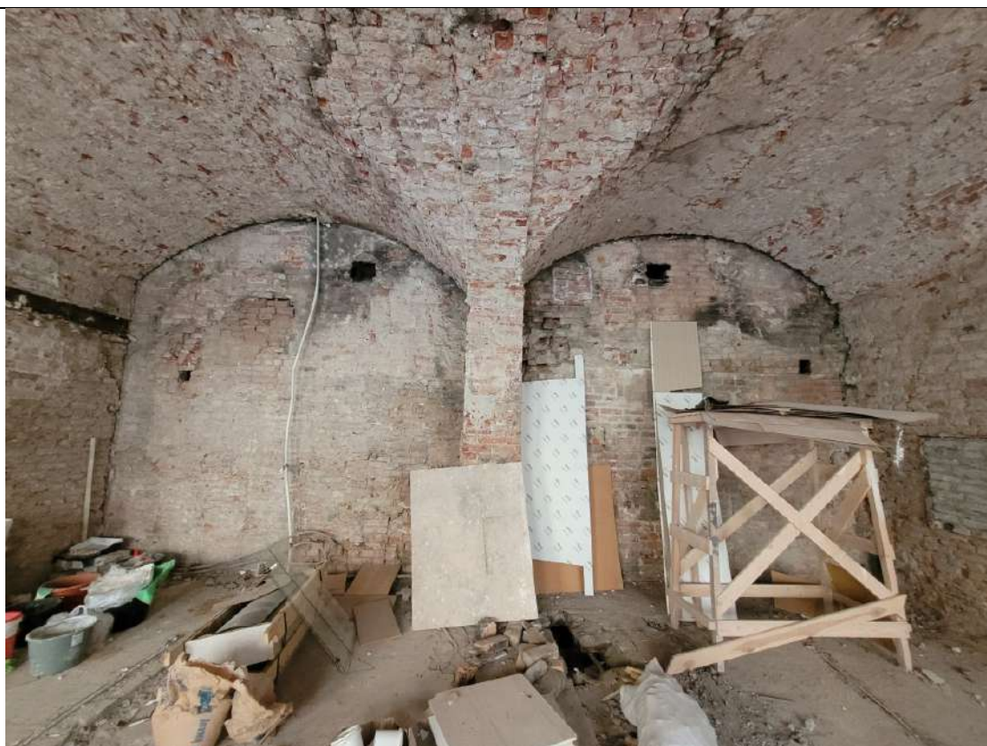
Фото № 28. ОКНРЗ «Особняк Дурново П.П.». Интерьеры помещения 15-Н (помещения 1–10 восточного крыла северного корпуса по планам ПИБ 2013г.). Общий вид. Крестовые своды. Вид на торцевые арки крестового свода. Дата съемки: 20.10.2025г.
