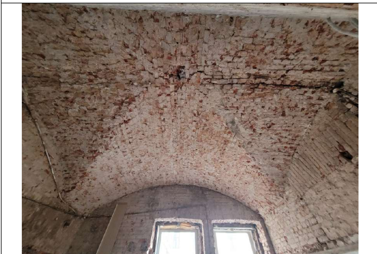
Фото № 20. ОКНРЗ «Особняк Дурново П.П.». Интерьеры помещения 15-Н (помещения 1–10 восточного крыла северного корпуса по планам ПИБ 2013г.). Элемент конструктивной системы – крестовый свод. Дата съемки: 20.10.2025г.
