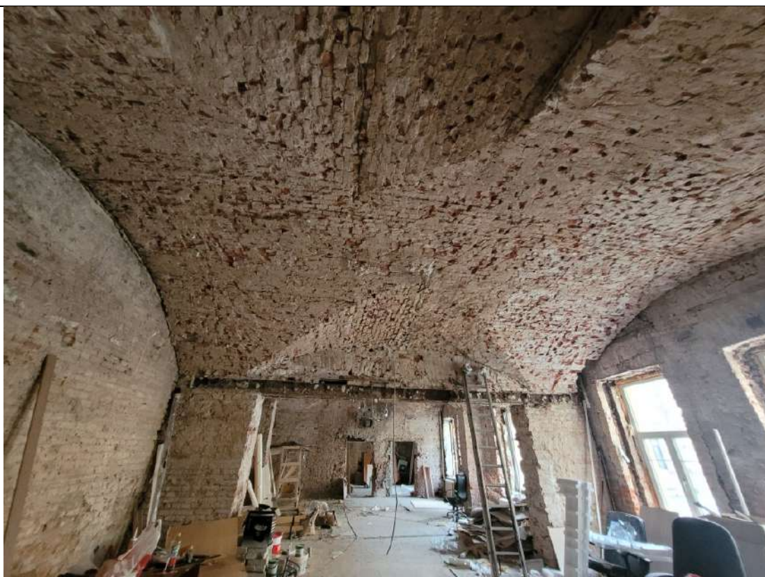
Фото № 2. ОКНРЗ «Особняк Дурново П.П.». Интерьеры помещения 15-Н (помещения 1–10 восточного крыла северного корпуса по планам ПИБ 2013г.). Элемент конструктивной системы – крестовый свод. Дата съемки: 20.10.2025г.
