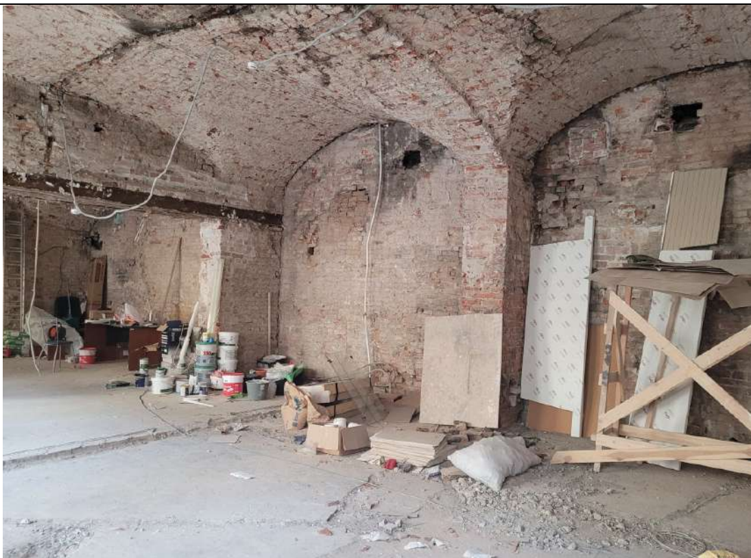
Фото № 25. ОКНРЗ «Особняк Дурново П.П.». Интерьеры помещения 15-Н (помещения 1–10 восточного крыла северного корпуса по планам ПИБ 2013г.). Крестовый свод. Вид на торцевые арки крестового свода. Дата съемки: 20.10.2025г.
