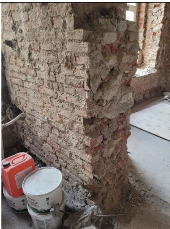
Фото № 24. ОКНРЗ «Особняк Дурново П.П.». Интерьеры помещения 15-Н (помещения 1–10 восточного крыла северного корпуса по планам ПИБ 2013г.). Фрагмент кладки исторической внутренней стены. Дата съемки: 20.10.2025г.
