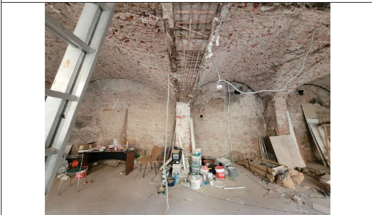
Фото № 8. ОКНРЗ «Особняк Дурново П.П.». Интерьеры помещения 15-Н (помещения 1–10 восточного крыла северного корпуса по планам ПИБ 2013г.). Крестовый свод. Вид на торцевые арки крестового свода. Дата съемки: 20.10.2025г.
