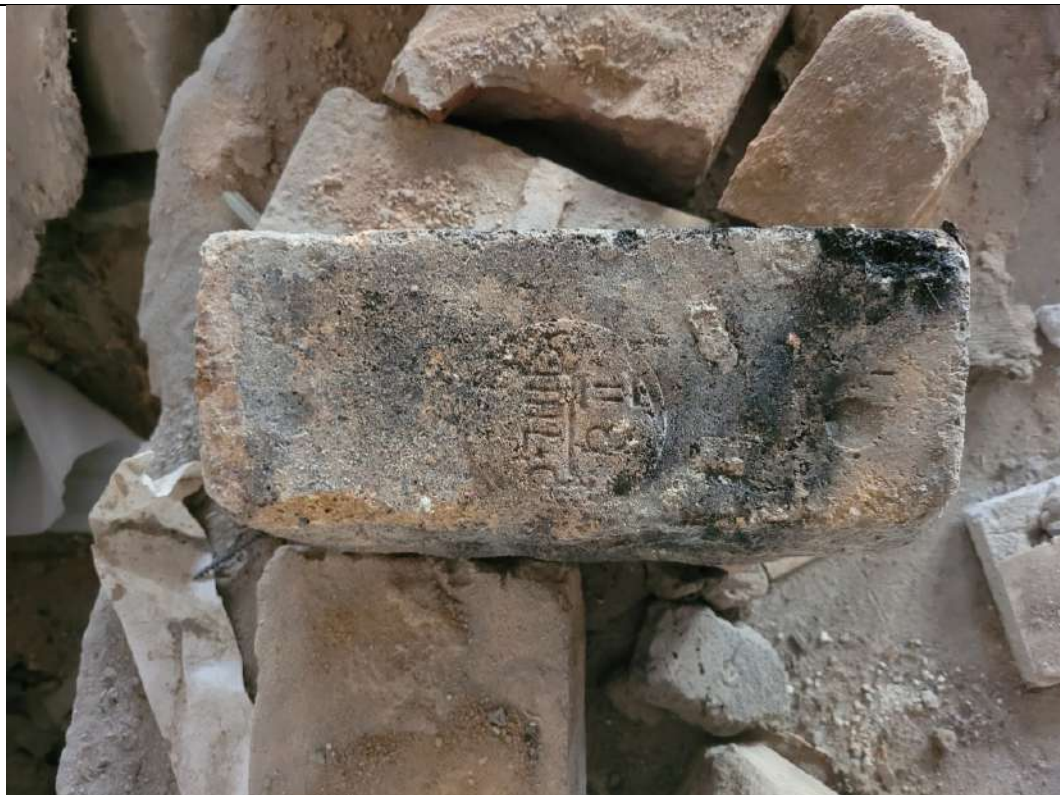
Фото № 34. ОКНРЗ «Особняк Дурново П.П.». Интерьеры помещения 15-Н (помещения 1–10 восточного крыла северного корпуса по планам ПИБ 2013г.). Материал – кирпич – исторических наружных и внутренних капитальных стен. Дата съемки: 20.10.2025г.
