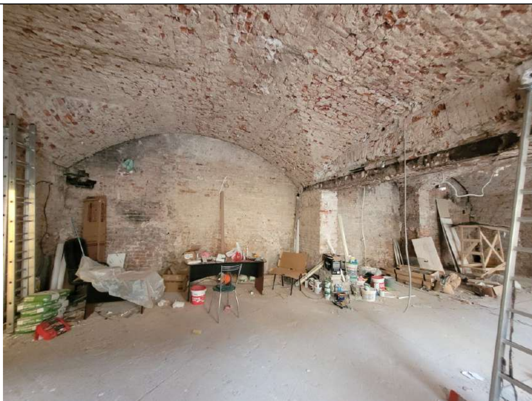
Фото № 5. ОКНРЗ «Особняк Дурново П.П.». Интерьеры помещения 15-Н (помещения 1–10 восточного крыла северного корпуса по планам ПИБ 2013г.). Крестовый свод. Вид на торцевые арки. Дата съемки: 20.10.2025г.
