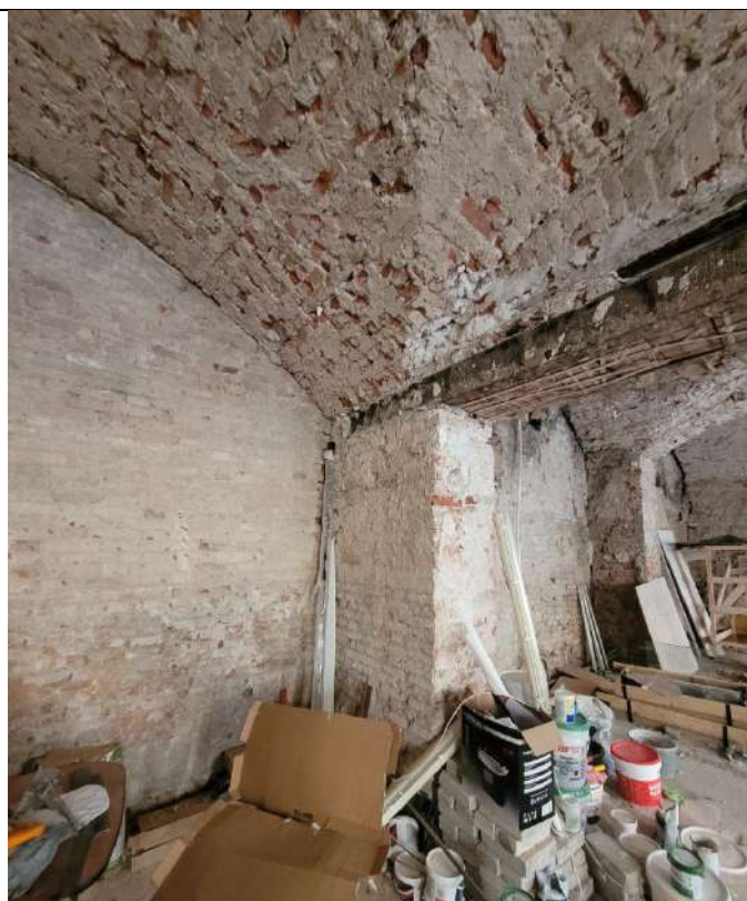
Фото № 4. ОКНРЗ «Особняк Дурново П.П.». Интерьеры помещения 15-Н (помещения 1–10 восточного крыла северного корпуса по планам ПИБ 2013г.). Крестовый свод. Опора крестового свода. Дата съемки: 20.10.2025г.
