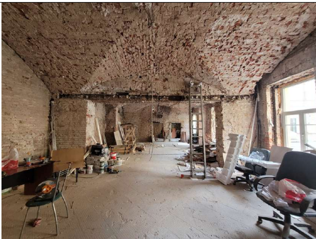
Фото № 1. ОКНРЗ «Особняк Дурново П.П.». Интерьеры помещения 15-Н (помещения 1–10 восточного крыла северного корпуса по планам ПИБ 2013г.). Общий вид. Дата съемки: 20.10.2025г.
