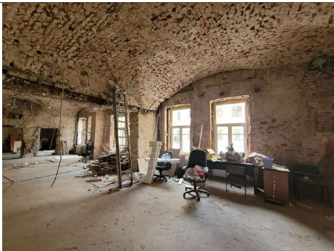
Фото № 10. ОКНРЗ «Особняк Дурново П.П.». Интерьеры помещения 15-Н (помещения 1–10 восточного крыла северного корпуса по планам ПИБ 2013г.). Крестовый свод. Вид на угловые опоры. Исторические оконные проемы. Дата съемки: 20.10.2025г.
