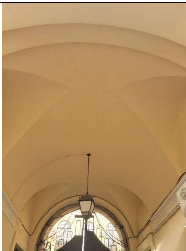
Фото № 13. ОКНРЗ «Особняк Дурново П.П.». Воротный проезд поперечного дворового корпуса. Свод – цилиндрический с распалубками. Дата съемки: 20.10.2025г.
