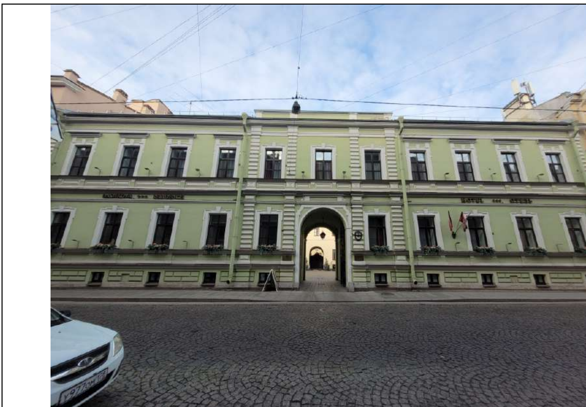
Фото № 19. ОКНРЗ «Особняк Дурново П.П.». Вид на лицевой фасад по Галерной улице. Материал отделки цоколя – известняк. Профилированные междуэтажные тяги и карнизы. Венчающий профилированный раскрепованный карниз. Аттик. Дата съемки: 20.10.2025г.
