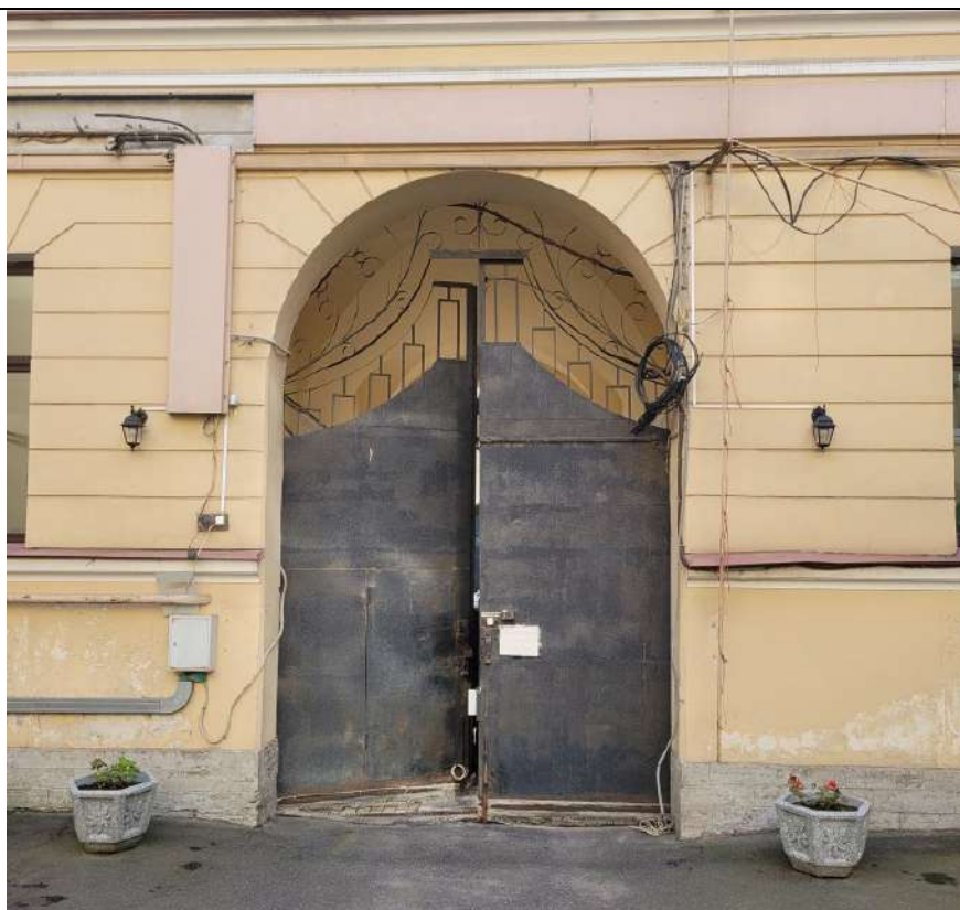
Фото № 11. ОКНРЗ «Особняк Дурново П.П.». Воротный проезд поперечного дворового корпуса. Ворота. Дата съемки: 20.10.2025г.
