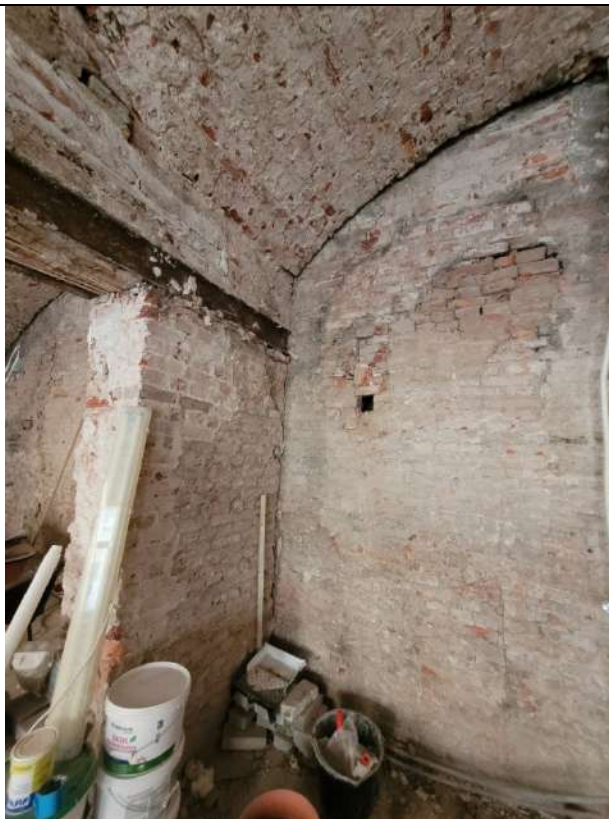
Фото № 11. ОКНРЗ «Особняк Дурново П.П.». Интерьеры помещения 15-Н (помещения 1–10 восточного крыла северного корпуса по планам ПИБ 2013г.). Крестовый свод. Угловая опора. Дата съемки: 20.10.2025г.
