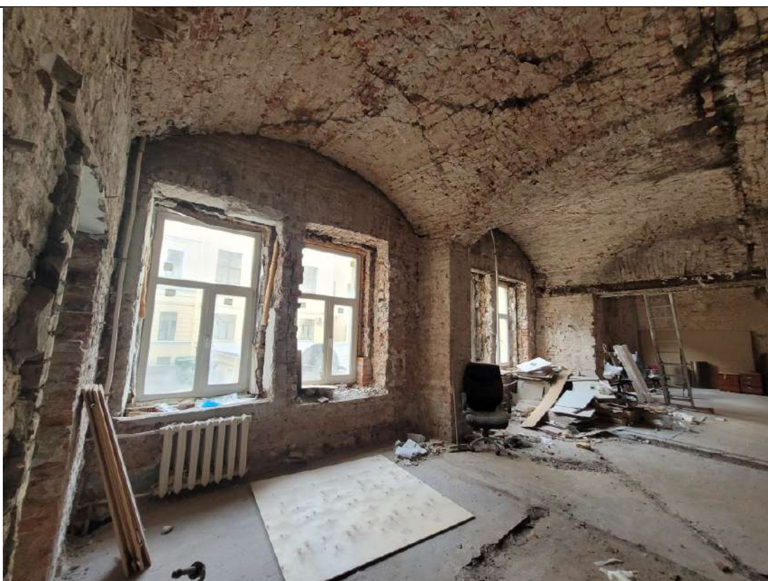
Фото № 16. ОКНРЗ «Особняк Дурново П.П.». Интерьеры помещения 15-Н (помещения 1–10 восточного крыла северного корпуса по планам ПИБ 2013г.). Крестовый свод. Вид на угловые опоры. Исторические оконные проемы. Дата съемки: 20.10.2025г.
