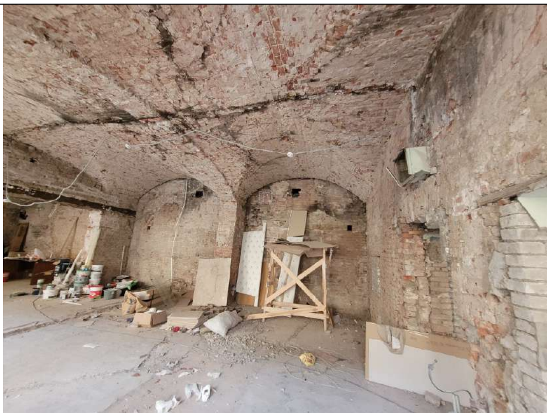
Фото № 17. ОКНРЗ «Особняк Дурново П.П.». Интерьеры помещения 15-Н (помещения 1–10 восточного крыла северного корпуса по планам ПИБ 2013г.). Крестовый свод. Вид на угловые опоры. Торцевые арки. Дата съемки: 20.10.2025г.
