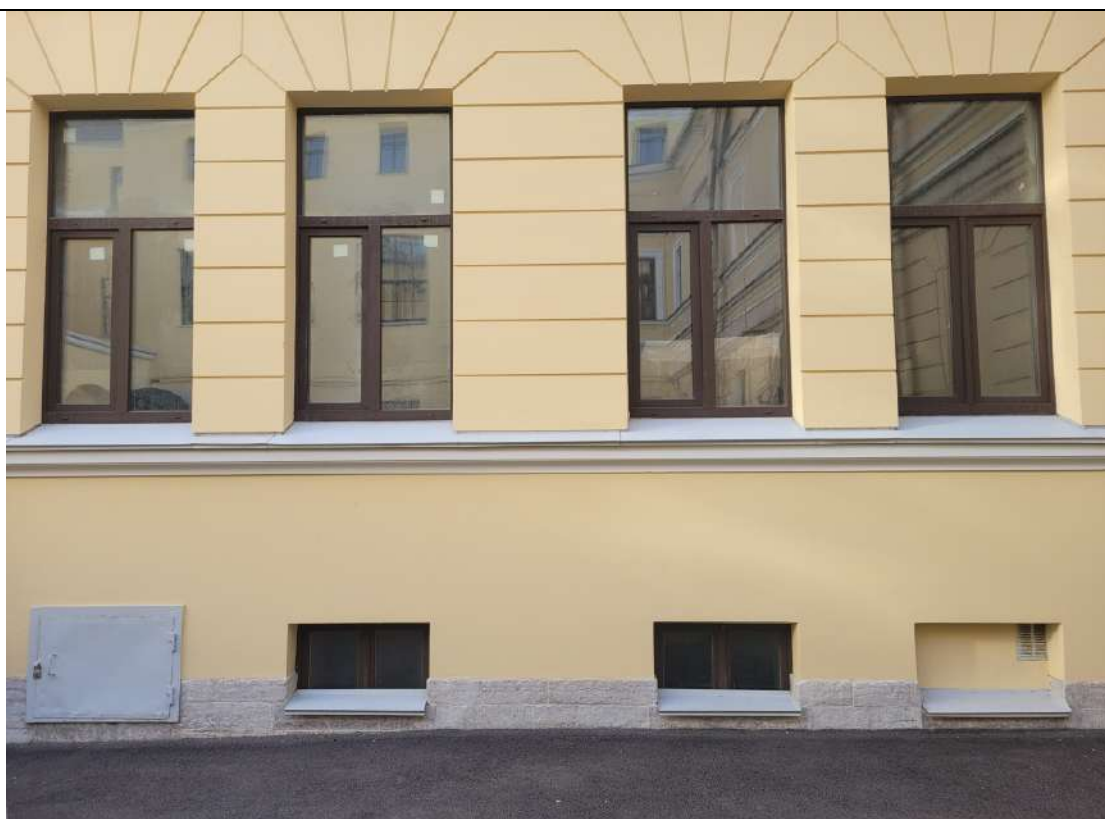
Фото № 10. ОКНРЗ «Особняк Дурново П.П.». Вид дворового фасада северного двора. Подоконная тяга. Дата съемки: 20.10.2025г.
