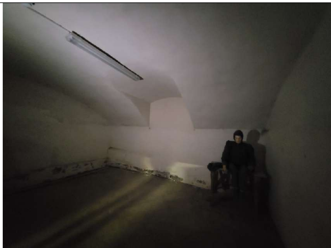
Фото № 9. ОКНРЗ «Особняк Дурново П.П.». Интерьеры подвала. Цилиндрический свод с распалубками подвала лицевого корпуса по Английской набережной. Дата съемки: 20.10.2025г.
