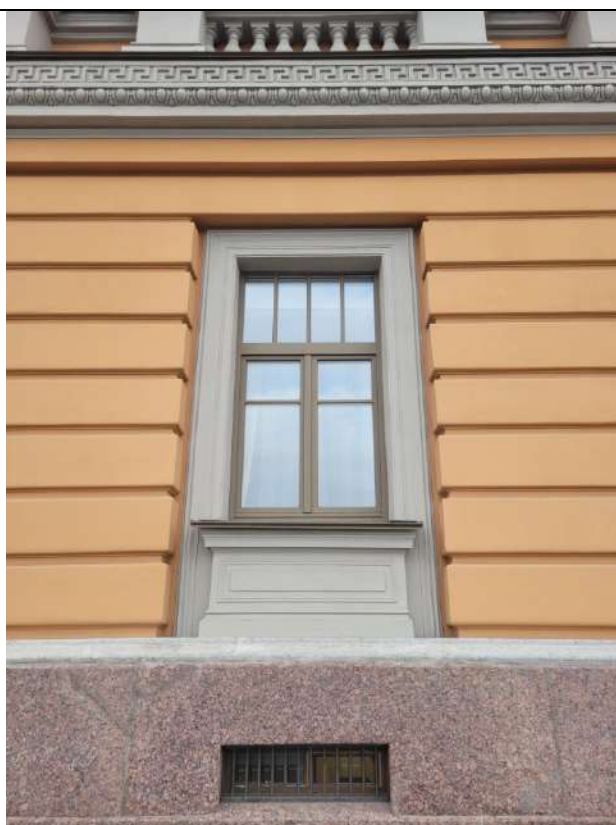
Фото № 4. ОКНРЗ «Особняк Дурново П.П.». Вид на лицевой фасад по Английской набережной. Материал отделки цоколя – красный гранит. Исторические оконные проемы с оформлением заглубленными рамочными наличниками и подоконными досками с лежащими филенками. Дата съемки: 20.10.2025г.
