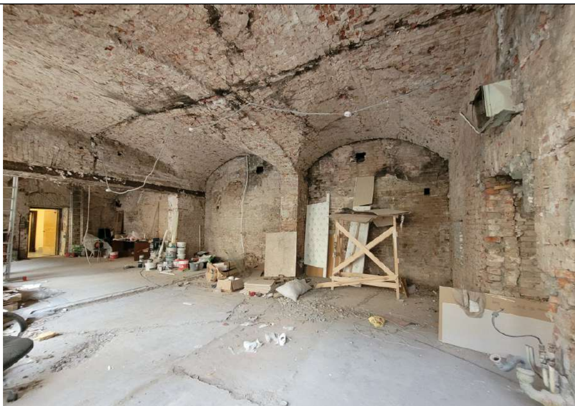
Фото № 26. ОКНРЗ «Особняк Дурново П.П.». Интерьеры помещения 15-Н (помещения 1–10 восточного крыла северного корпуса по планам ПИБ 2013г.). Общий вид. Крестовые своды. Вид на торцевые арки крестового свода. Дата съемки: 20.10.2025г.
