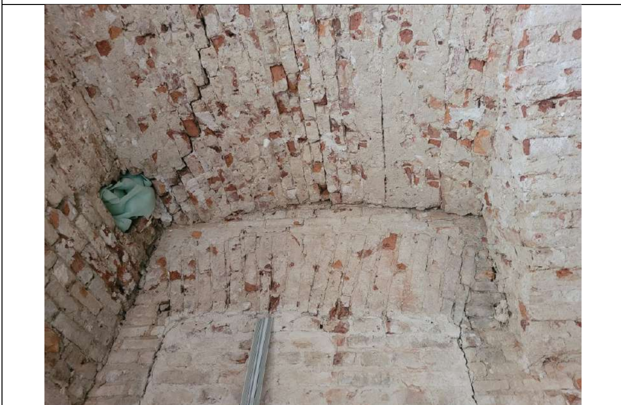
Фото № 32. ОКНРЗ «Особняк Дурново П.П.». Интерьеры помещения 15-Н (помещения 1–10 восточного крыла северного корпуса по планам ПИБ 2013г.). Фрагмент кладки исторической внутренней капитальной стены. Дата съемки: 20.10.2025г.
