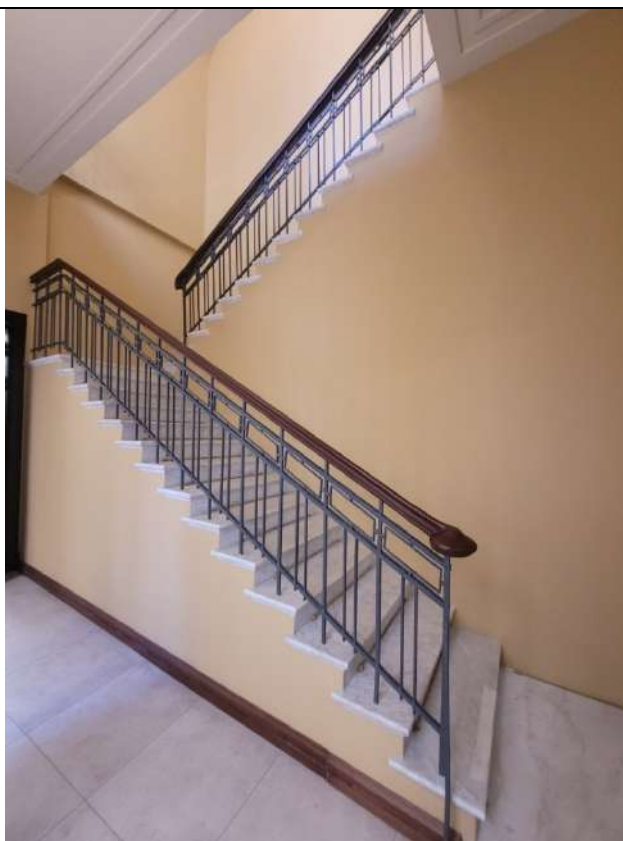
Фото № 3. ОКНРЗ «Особняк Дурново П.П.». Западная лестница лицевого корпуса по Английской набережной. Дата съемки: 20.10.2025г.
