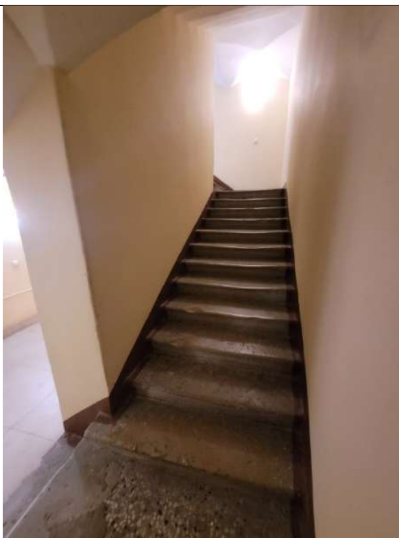
Фото № 4. ОКНРЗ «Особняк Дурново П.П.». Восточная лестница лицевого корпуса по Английской набережной. Дата съемки: 20.10.2025г.
