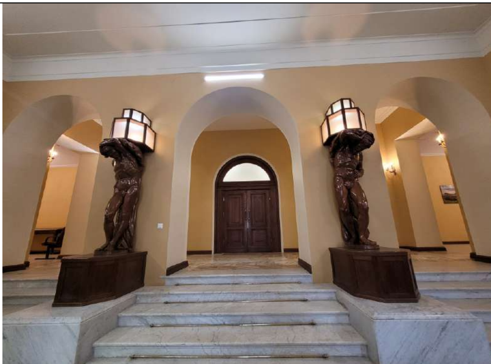
Фото № 1. ОКНРЗ «Особняк Дурново П.П.». Двухуровневый вестибюль с с тремя арочными проемами к коридору. Парадная лестница лицевого корпуса по Английской набережной – в уровне вестибюля, междустенная; материал – мрамор. Деревянные торшеры в виде атлантов. Дата съемки: 20.10.2025г.
