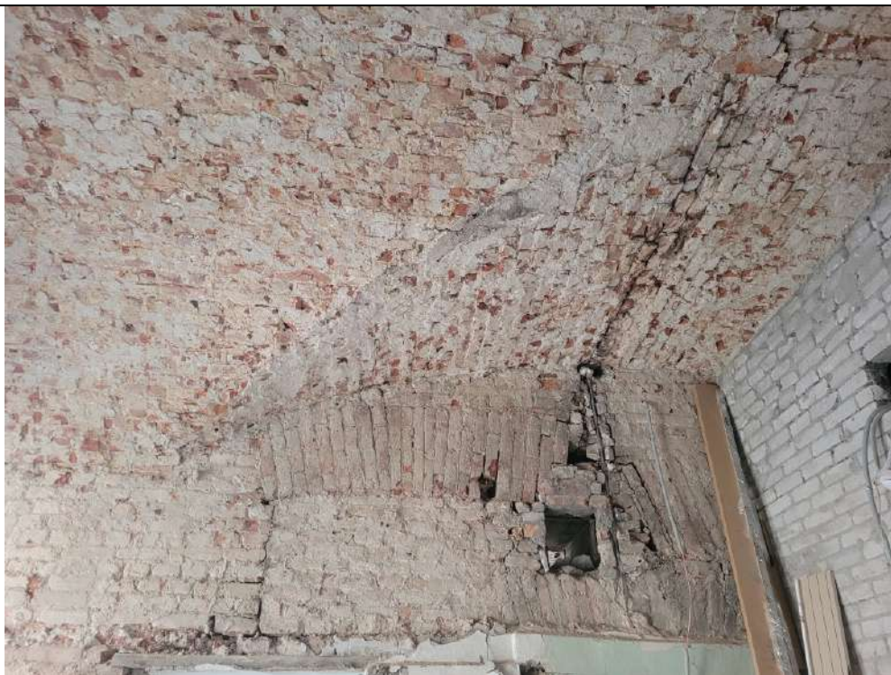
Фото № 21. ОКНРЗ «Особняк Дурново П.П.». Интерьеры помещения 15-Н (помещения 1–10 восточного крыла северного корпуса по планам ПИБ 2013г.). Фрагмент кладки исторической внутренней стены. Дата съемки: 20.10.2025г.
