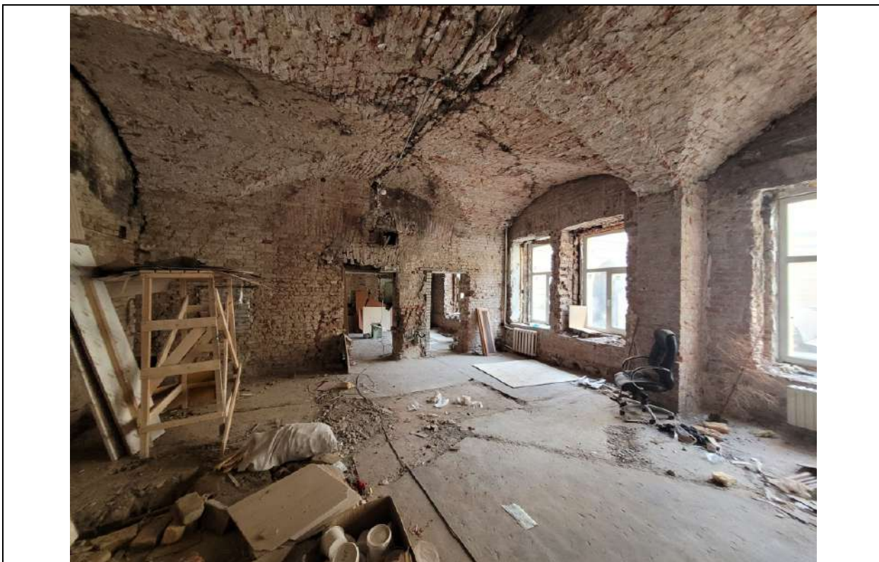
Фото № 13. ОКНРЗ «Особняк Дурново П.П.». Интерьеры помещения 15-Н (помещения 1–10 восточного крыла северного корпуса по планам ПИБ 2013г.). Крестовый свод. Вид на угловые опоры. Исторические оконные проемы. Дата съемки: 20.10.2025г.
