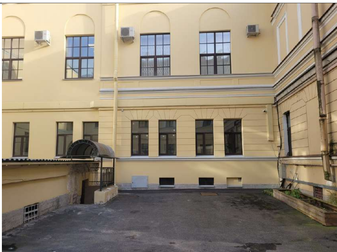
Фото № 8. ОКНРЗ «Особняк Дурново П.П.». Вид дворового фасада северного двора. Вид материала отделки цоколя – известняк. Линейный руст в уровне первого этажа. Гладкая штукатурка. Дата съемки: 20.10.2025г.
