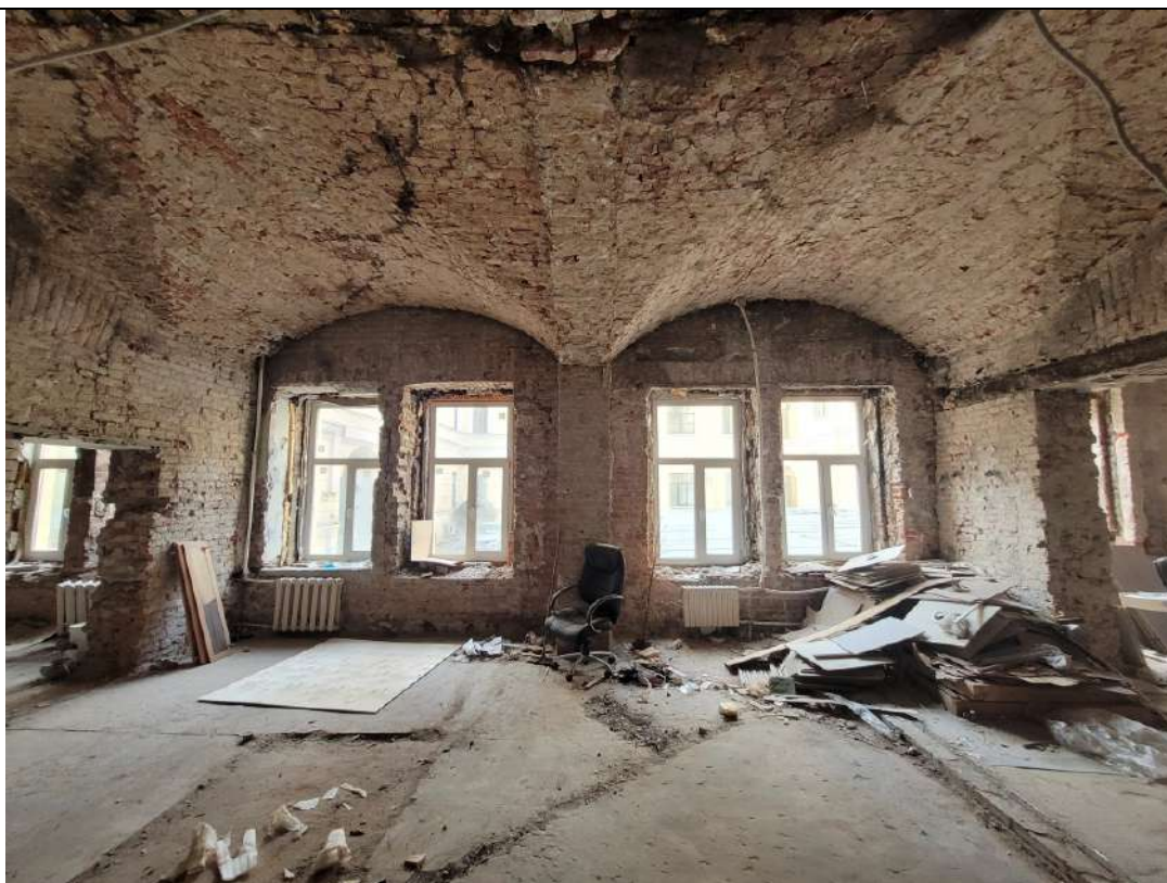
Фото № 29. ОКНРЗ «Особняк Дурново П.П.». Интерьеры помещения 15-Н (помещения 1–10 восточного крыла северного корпуса по планам ПИБ 2013г.). Общий вид. Крестовые своды. Вид на торцевые арки крестового свода. Исторические оконные проемы. Дата съемки: 20.10.2025г.
