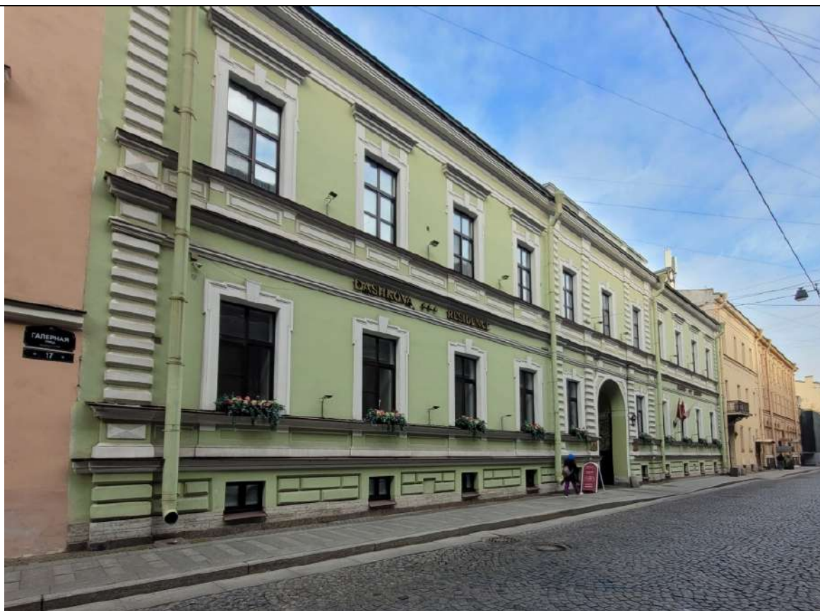
Фото № 18. ОКНРЗ «Особняк Дурново П.П.». Вид на лицевой фасад по Галерной улице. Дата съемки: 20.10.2025г.
