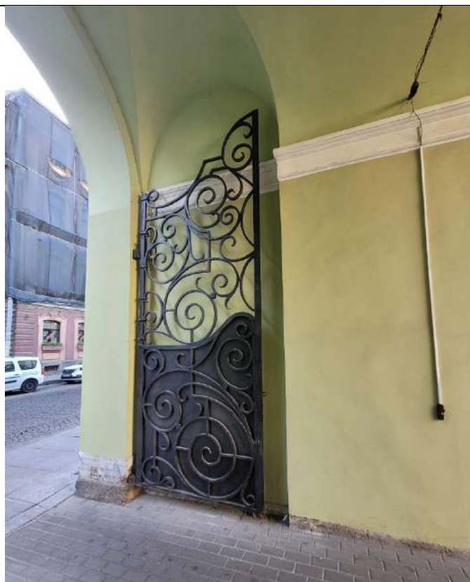
Фото № 16. ОКНРЗ «Особняк Дурново П.П.». Воротный проезд лицевого корпуса по Галерной улице. Металлические ворота (ковка). Дата съемки: 20.10.2025г.
