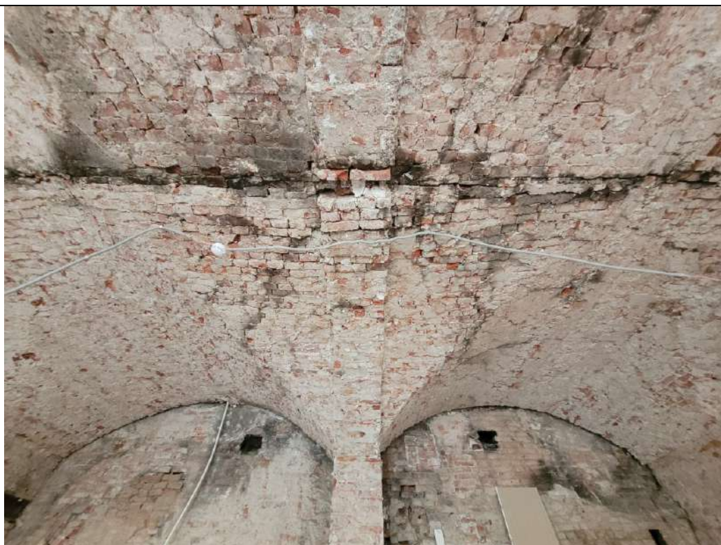
Фото № 27. ОКНРЗ «Особняк Дурново П.П.». Интерьеры помещения 15-Н (помещения 1–10 восточного крыла северного корпуса по планам ПИБ 2013г.). Общий вид. Крестовые своды. Дата съемки: 20.10.2025г.
