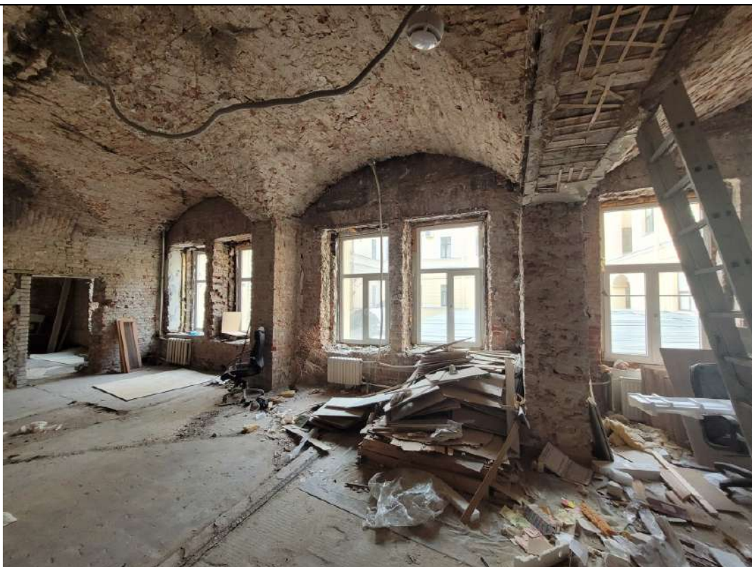
Фото № 9. ОКНРЗ «Особняк Дурново П.П.». Интерьеры помещения 15-Н (помещения 1–10 восточного крыла северного корпуса по планам ПИБ 2013г.). Крестовый свод. Вид на угловые опоры. Исторические оконные проемы. Дата съемки: 20.10.2025г.
