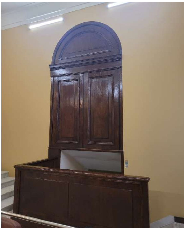
Фото № 2. ОКНРЗ «Особняк Дурново П.П.». Полуциркульный дверной проем. Заполнение: материал – дерево; двери двустворчатые с полуциркульными фрамугами. Дата съемки: 20.10.2025г.
