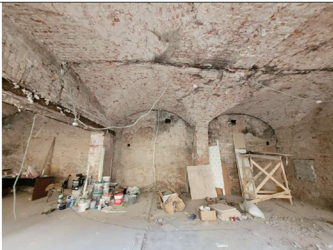
Фото № 15. ОКНРЗ «Особняк Дурново П.П.». Интерьеры помещения 15-Н (помещения 1–10 восточного крыла северного корпуса по планам ПИБ 2013г.). Крестовый свод. Вид на угловые опоры. Торцевые арки. Дата съемки: 20.10.2025г.
