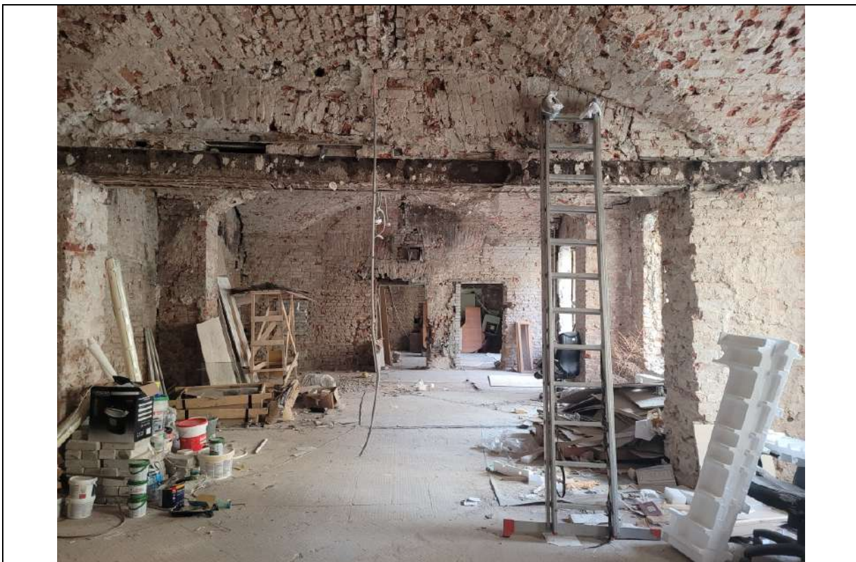
Фото № 31. ОКНРЗ «Особняк Дурново П.П.». Интерьеры помещения 15-Н (помещения 1–10 восточного крыла северного корпуса по планам ПИБ 2013г.). Общий вид. Дата съемки: 20.10.2025г.
