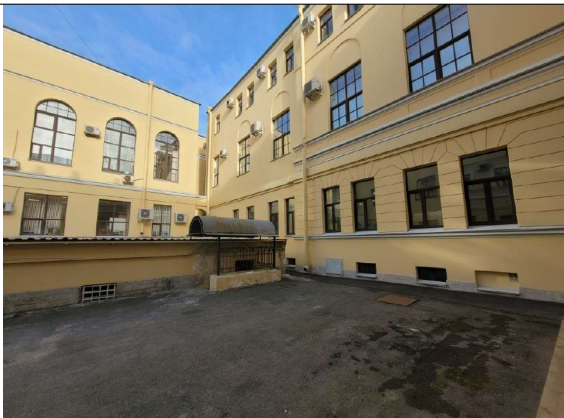
Фото № 9. ОКНРЗ «Особняк Дурново П.П.». Вид дворовых фасадов северного двора. Историческое заполнение и материал оконных проемов, рисунок расстекловки. Дата съемки: 20.10.2025г.
