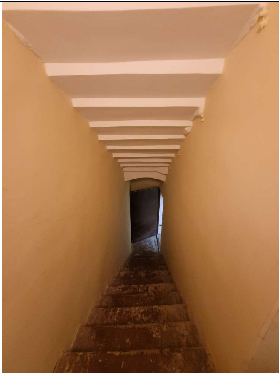
Фото № 5. ОКНРЗ «Особняк Дурново П.П.». Служебная лестница. Дата съемки: 20.10.2025г.
