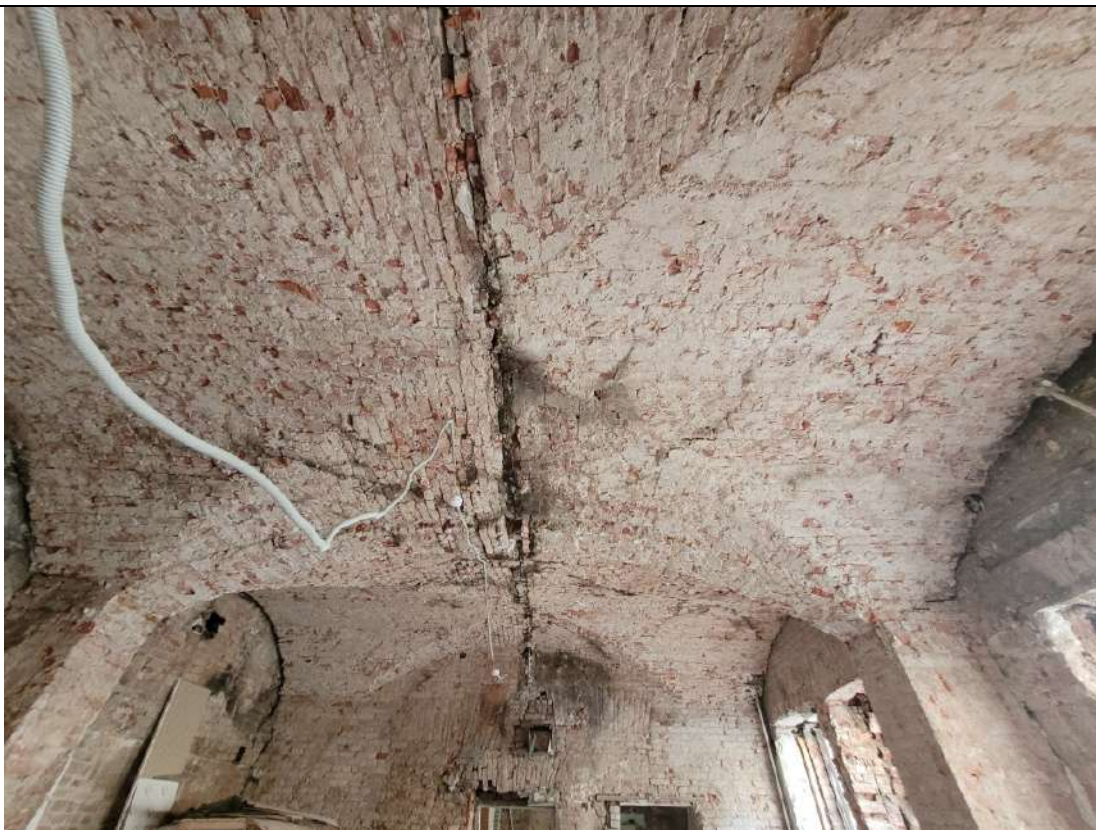
Фото № 33. ОКНРЗ «Особняк Дурново П.П.». Интерьеры помещения 15-Н (помещения 1–10 восточного крыла северного корпуса по планам ПИБ 2013г.). Элемент конструктивной системы – крестовый свод. Дата съемки: 20.10.2025г.
