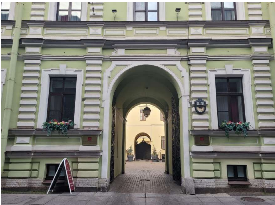
Фото № 20. ОКНРЗ «Особняк Дурново П.П.». Вид на лицевой фасад по Галерной улице. Исторические оконные проемы, заполнение, рисунок расстекловки. Колесоотбойная тумба. Рустованные лопатки. Дата съемки: 20.10.2025г.
