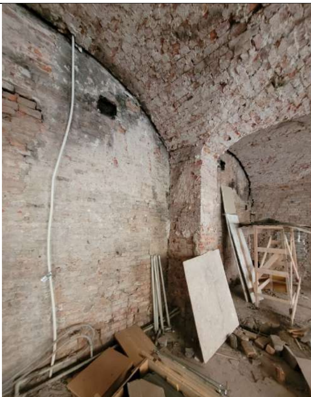
Фото № 12. ОКНРЗ «Особняк Дурново П.П.». Интерьеры помещения 15-Н (помещения 1–10 восточного крыла северного корпуса по планам ПИБ 2013г.). Крестовый свод. Угловая опора. Дата съемки: 20.10.2025г.
