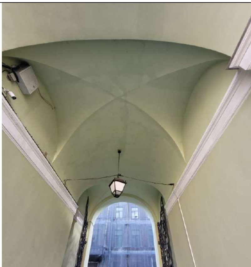
Фото № 15. ОКНРЗ «Особняк Дурново П.П.». Воротный проезд лицевого корпуса по Галерной улице. Свод – цилиндрический с распалубками. Дата съемки: 20.10.2025г.
