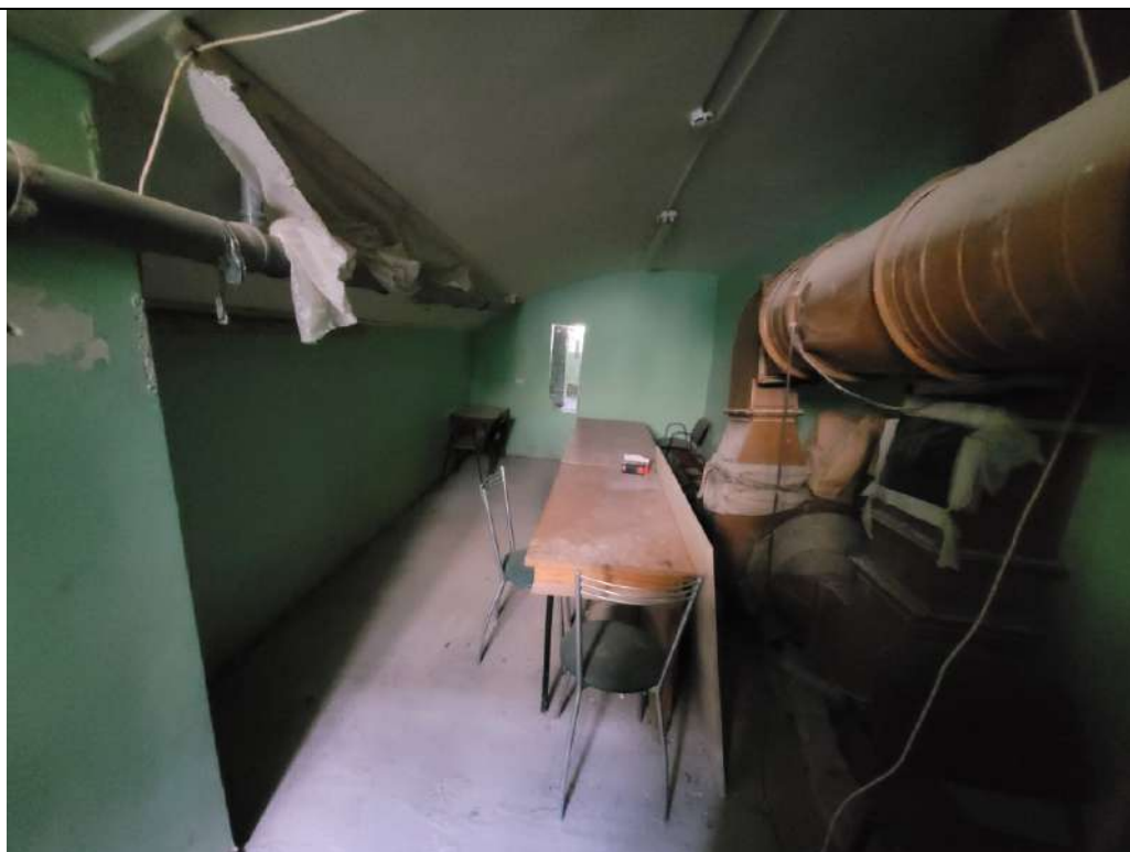
Фото № 6. ОКНРЗ «Особняк Дурново П.П.». Интерьеры подвала. Цилиндрический свод подвала лицевого корпуса по Английской набережной. Дата съемки: 20.10.2025г.
