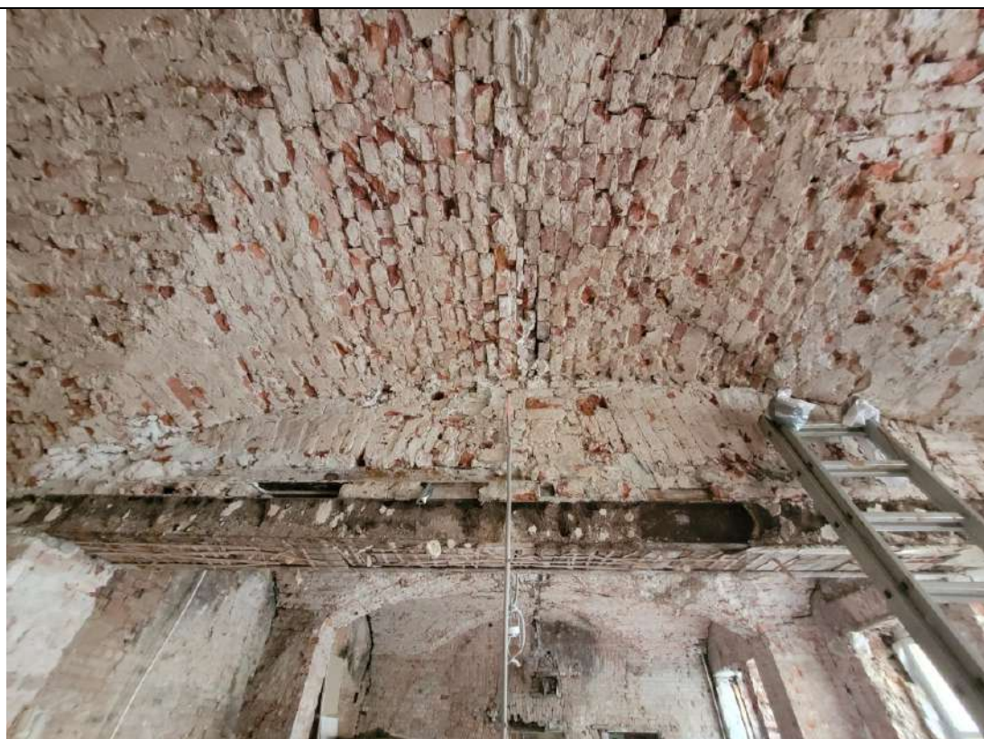
Фото № 6. ОКНРЗ «Особняк Дурново П.П.». Интерьеры помещения 15-Н (помещения 1–10 восточного крыла северного корпуса по планам ПИБ 2013г.). Крестовый свод. Один из двух равновеликих цилиндрических сводов, образующих крестовый свод. Дата съемки: 20.10.2025г.
