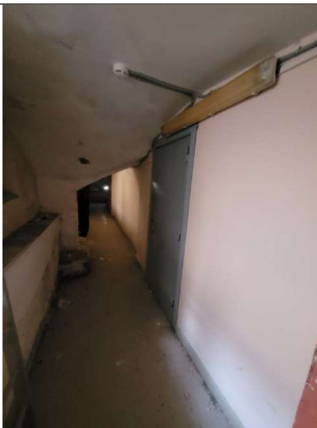
Фото № 7. ОКНРЗ «Особняк Дурново П.П.». Интерьеры подвала. Цилиндрический свод подвала лицевого корпуса по Английской набережной. Дата съемки: 20.10.2025г.
