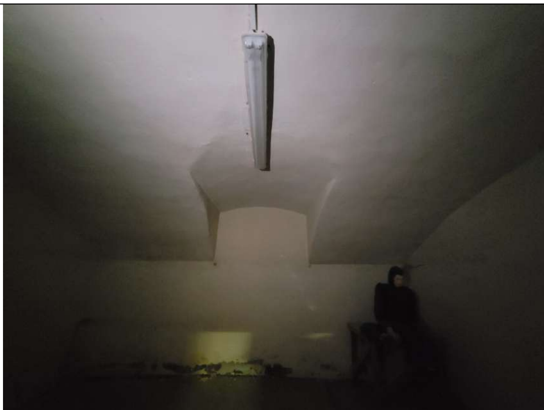
Фото № 8. ОКНРЗ «Особняк Дурново П.П.». Интерьеры подвала. Цилиндрический свод с распалубками подвала лицевого корпуса по Английской набережной. Дата съемки: 20.10.2025г.
