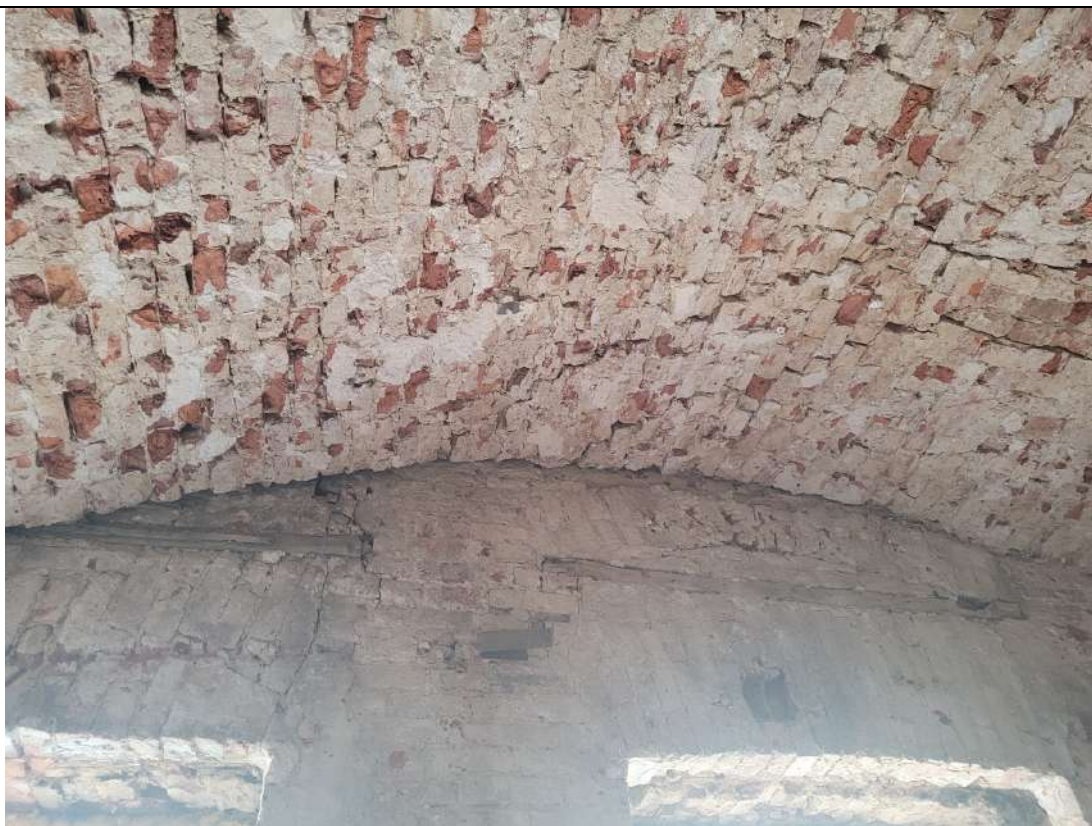
Фото № 30. ОКНРЗ «Особняк Дурново П.П.». Интерьеры помещения 15-Н (помещения 1–10 восточного крыла северного корпуса по планам ПИБ 2013г.). Фрагмент кладки исторической наружной капитальной стены. Дата съемки: 20.10.2025г.
