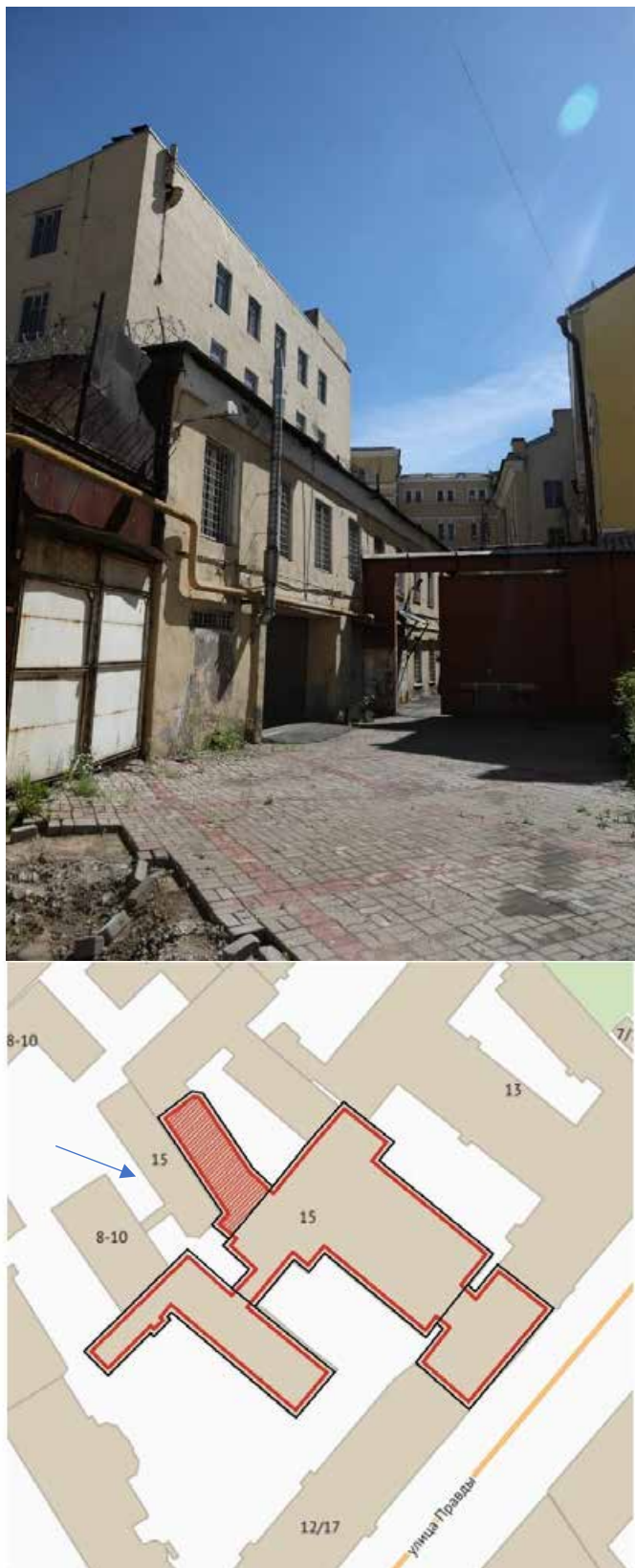
Илл. 44. Объект культурного наследия федерального значения «Синодальная типография», расположенный по адресу: г. Санкт-Петербург, улица Правды, дом 15, литера А. Северо-западный трапециевидный в плане, 5-ти-этажный корпус.
