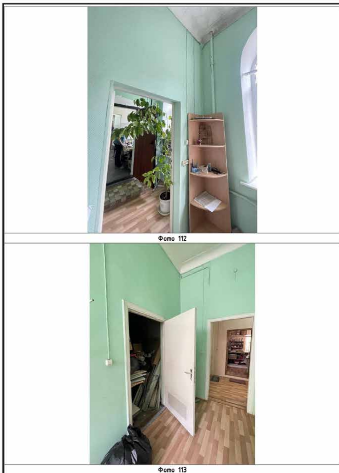
Илл. 94. Корпус по ул. Правды (главный четырехэтажный корпус). Фотофиксация 3-го этажа. Фото 112, 113 на схеме (Илл. 84).
