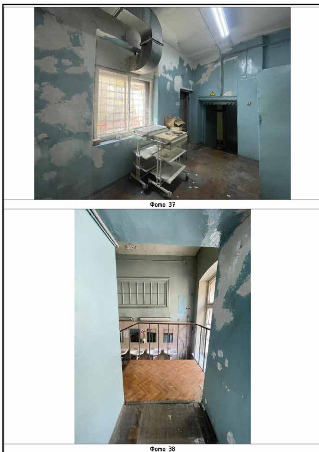
Илл. 256. Северо-западный трапецевидный в плане корпус. Фотофиксация 2-го этажа. Фото 37, 38 на схеме (Илл. 244).
