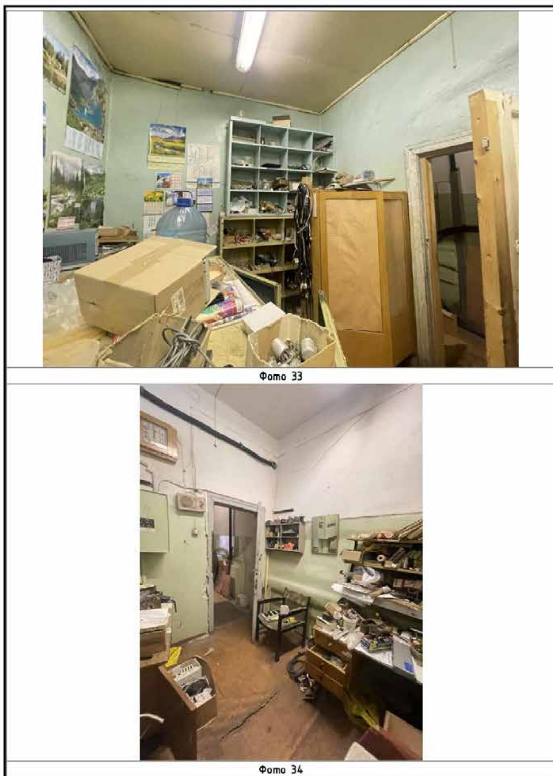
Илл. 254. Северо-западный трапецевидный в плане корпус. Фотофиксация 2-го этажа. Фото 33, 34 на схеме (Илл. 244).
