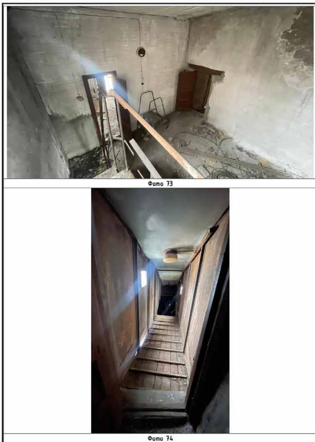
Илл. 279. Северо-западный трапецевидный в плане корпус. Фотофиксация чердачного помещения. Фото 73, 74 на схеме (Илл. 277).
