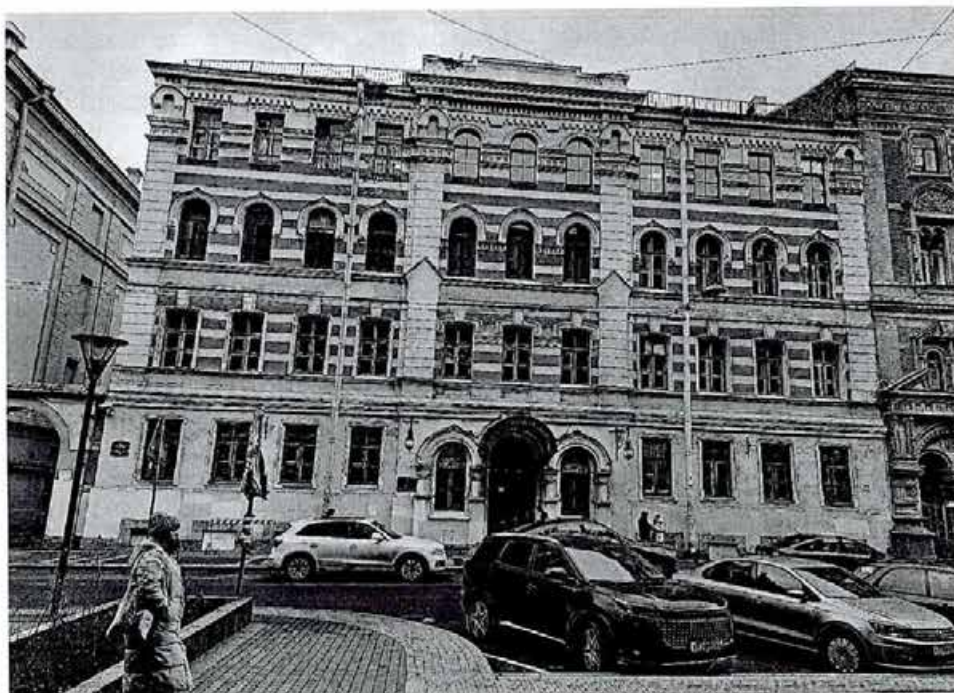
1. Лицевой фасад (общий вид)
