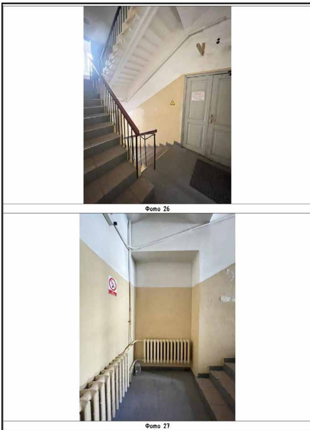
Илл. 49. Корпус по ул. Правды (главный четырехэтажный корпус). Фотофиксация 1-го этажа. Фото 26, 27 на схеме (Илл. 48).
