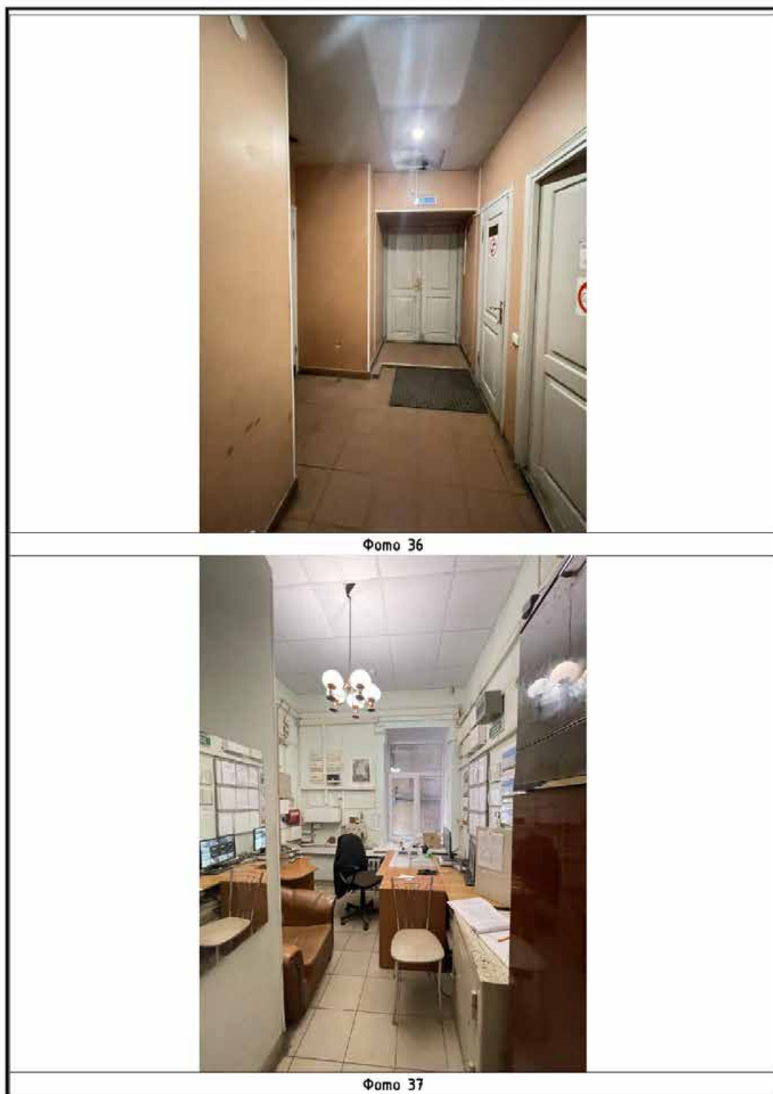
Илл. 53. Корпус по ул. Правды (главный четырехэтажный корпус). Фотофиксация 1-го этажа. Фото 36, 37 на схеме (Илл. 48).
