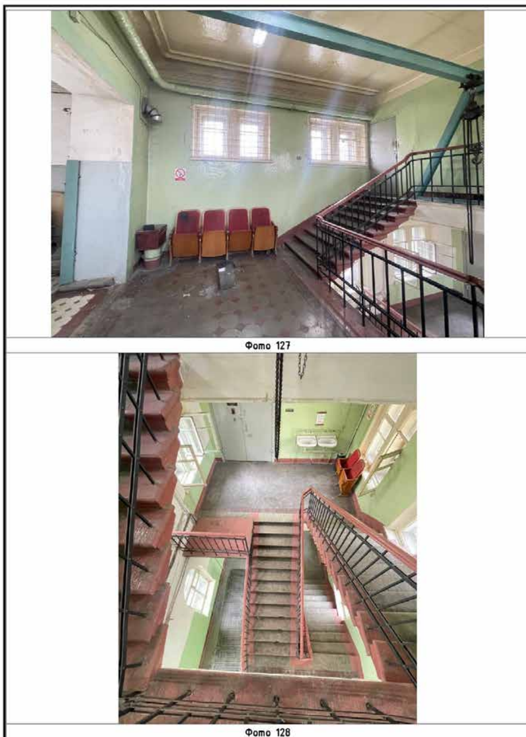
Илл. 171. Средний дворовой Т-образный в плане корпус. Фотофиксация лестниц и верхне-этажного помещения. Фото 127, 128 на схеме (Илл. 170).
