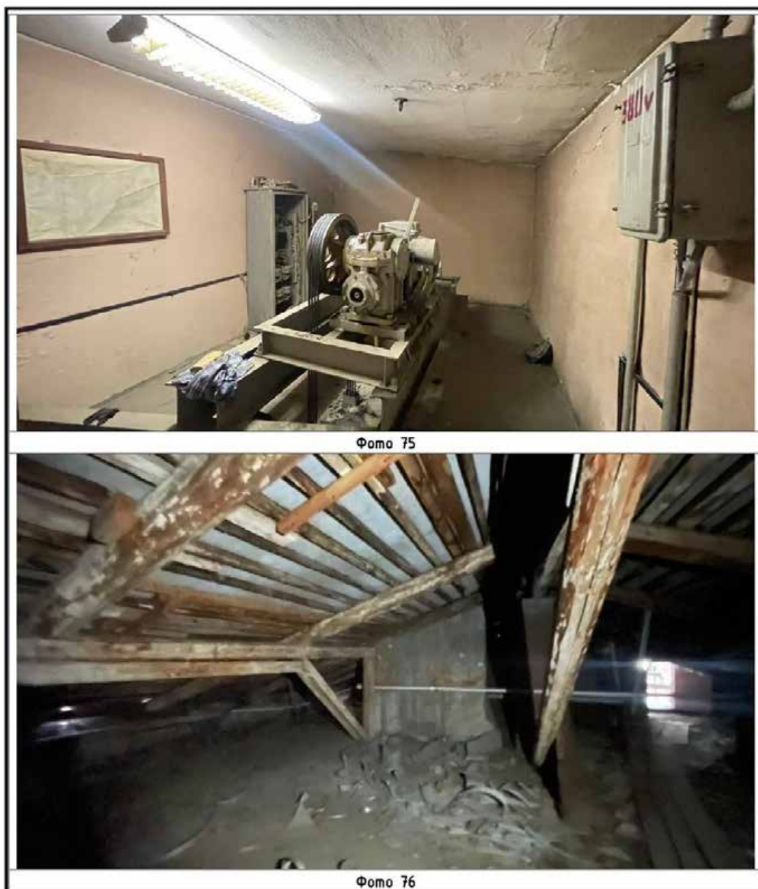
Илл. 280. Северо-западный трапецевидный в плане корпус. Фотофиксация чердачного помещения. Фото 75, 76 на схеме (Илл. 277).
