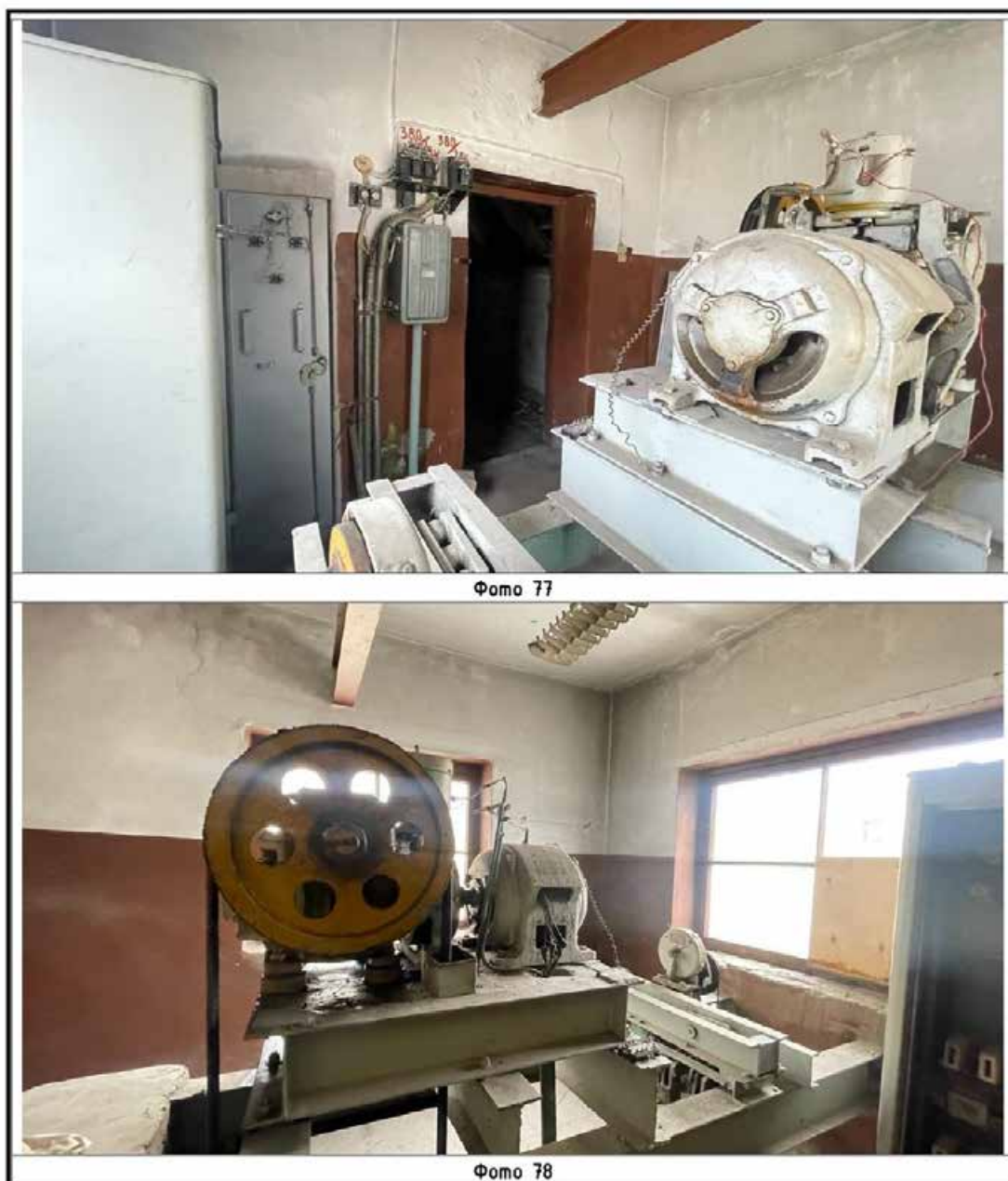
Илл. 281. Северо-западный трапецевидный в плане корпус. Фотофиксация чердачного помещения. Фото 77, 78 на схеме (Илл. 277).
