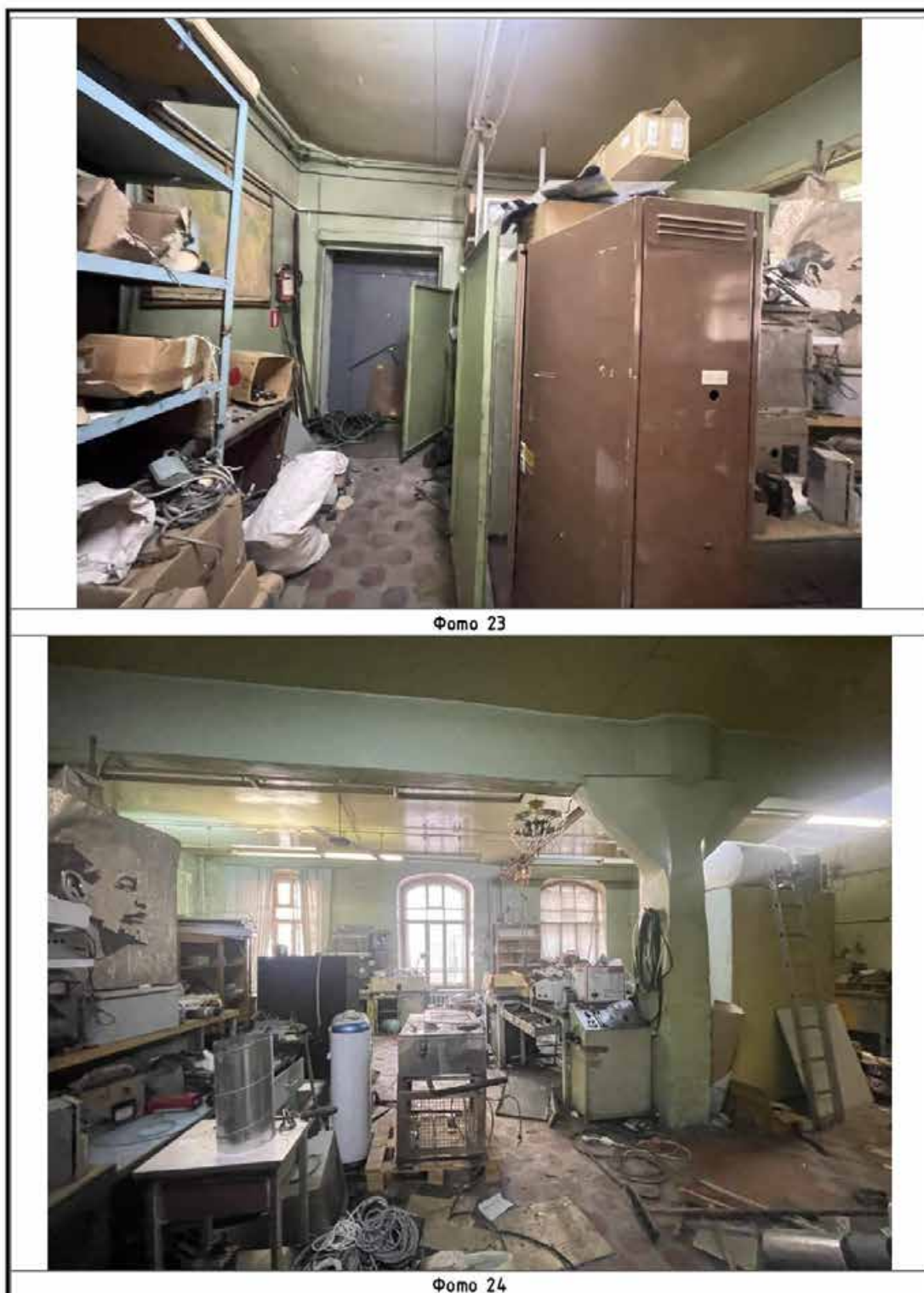
Илл. 249. Северо-западный трапецевидный в плане корпус. Фотофиксация 2-го этажа. Фото 23, 24 на схеме (Илл. 244).
