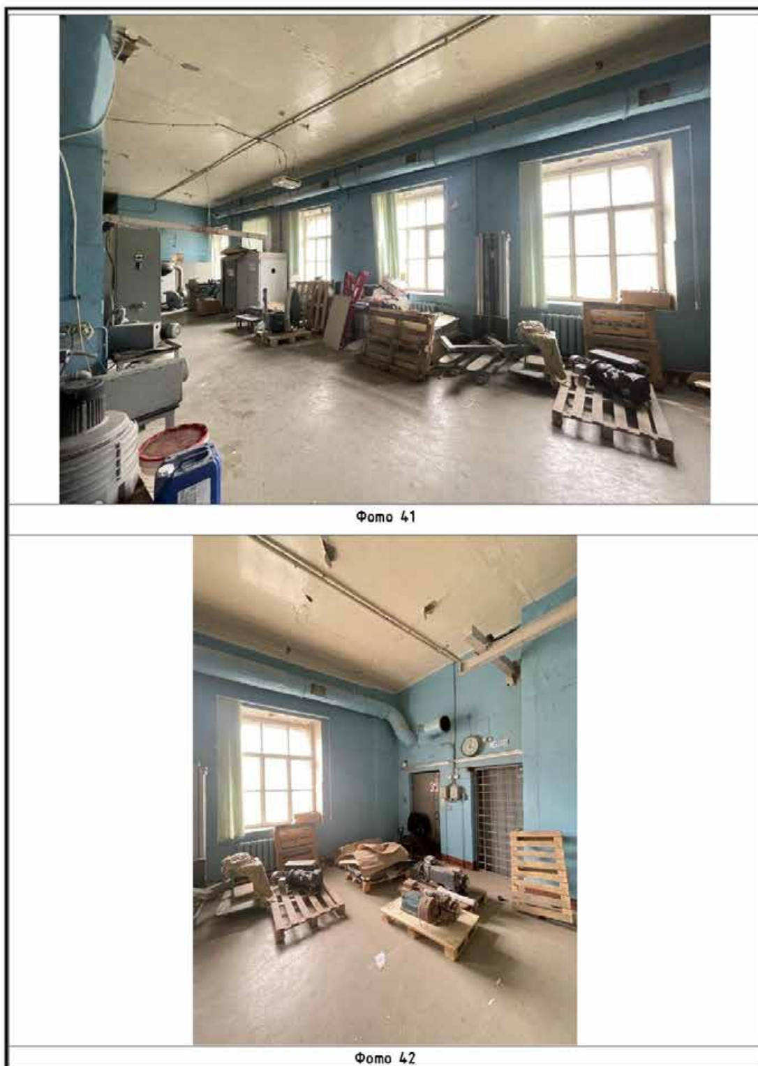
Илл. 259. Северо-западный трапецевидный в плане корпус. Фотофиксация 3-го этажа. Фото 41, 42 на схеме (Илл. 257).
