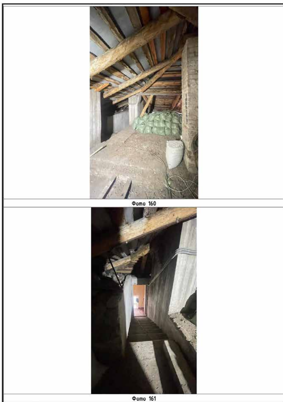
Илл. 121. Корпус по ул. Правды (главный четырехэтажный корпус). Фотофиксация чердачного помещения. Фото 160, 161 на схеме (Илл. 117).
