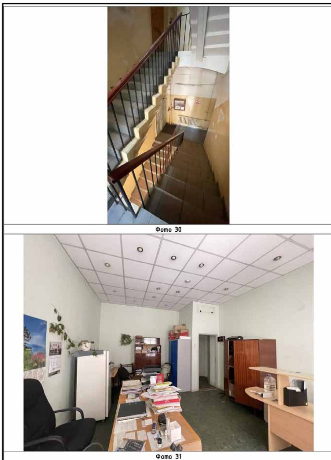
Илл. 51. Корпус по ул. Правды (главный четырехэтажный корпус). Фотофиксация 1-го этажа. Фото 30, 31 на схеме (Илл. 48).
