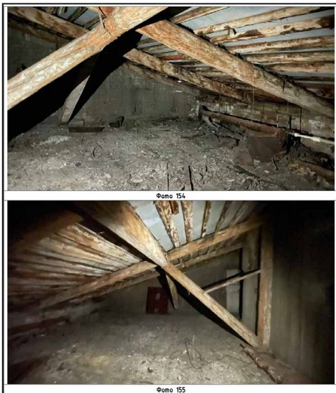
Илл. 118. Корпус по ул. Правды (главный четырехэтажный корпус). Фотофиксация чердачного помещения. Фото 154, 155 на схеме (Илл. 117).
