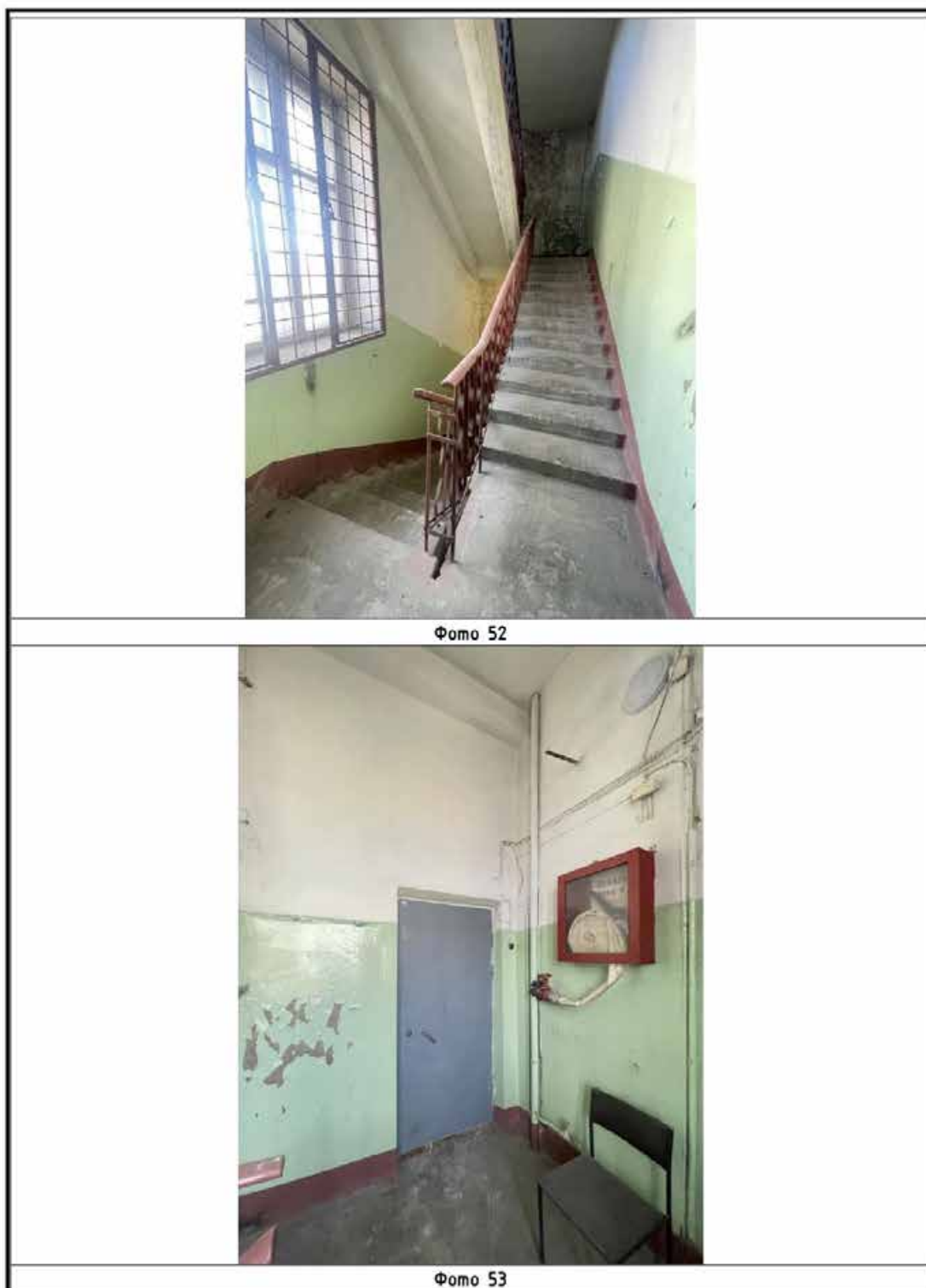
Илл. 266. Северо-западный трапецевидный в плане корпус. Фотофиксация 4-го этажа. Фото 52, 53 на схеме (Илл. 265).
