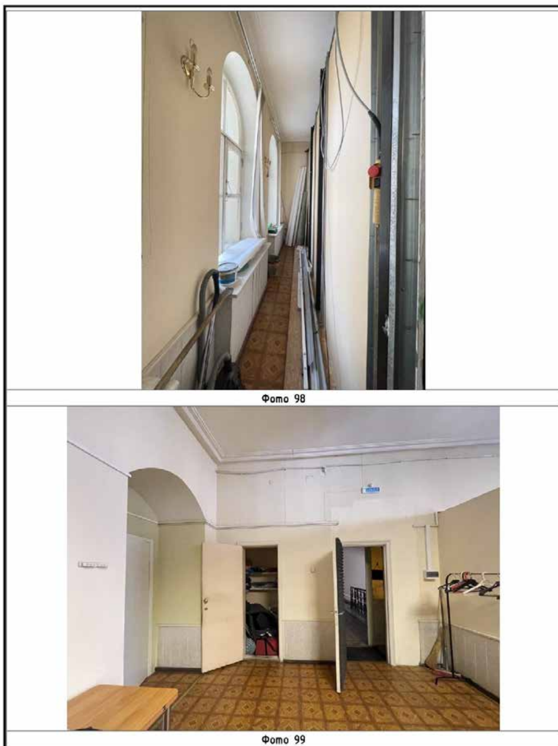
Илл. 87. Корпус по ул. Правды (главный четырехэтажный корпус). Фотофиксация 3-го этажа. Фото 98, 99 на схеме (Илл. 84).
