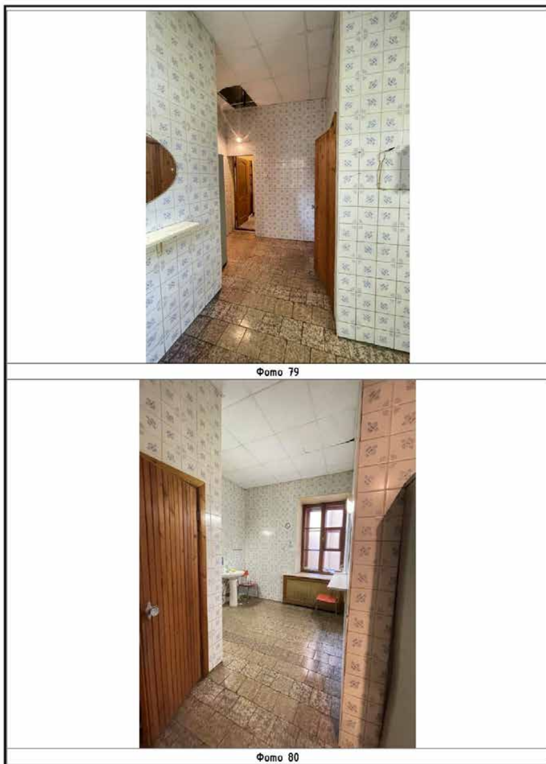
Илл. 76. Корпус по ул. Правды (главный четырехэтажный корпус). Фотофиксация 2-го этажа. Фото 79, 80 на схеме (Илл. 69).
