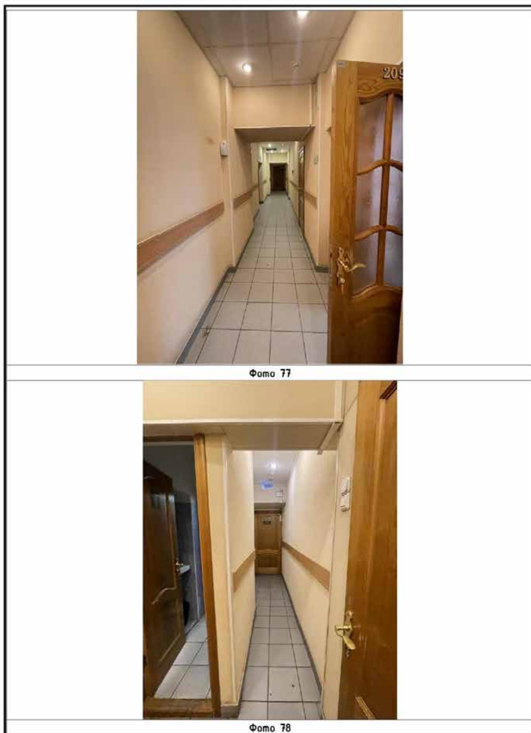
Илл. 75. Корпус по ул. Правды (главный четырехэтажный корпус). Фотофиксация 2-го этажа. Фото 77, 78 на схеме (Илл. 69).
