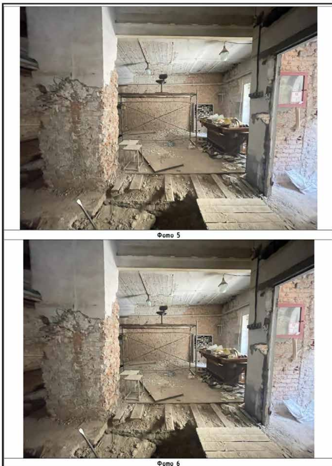
Илл. 239. Северо-западный трапецевидный в плане корпус. Фотофиксация 1-го этажа. Фото 5, 6 на схеме (Илл. 236).
