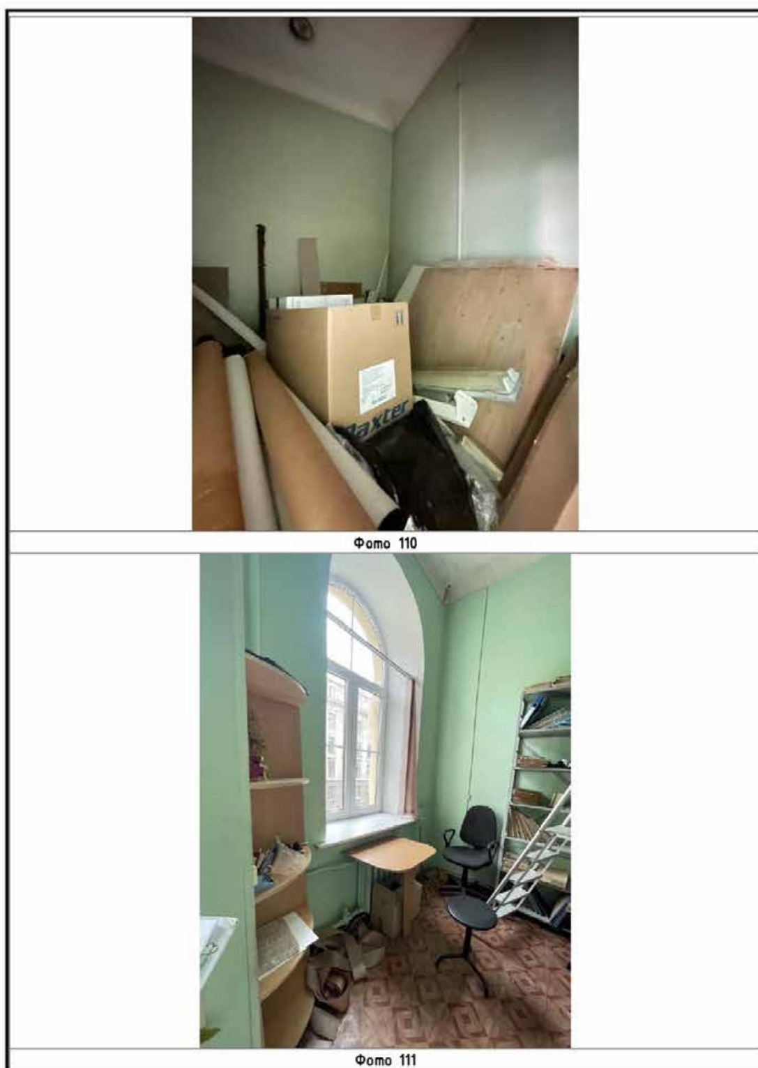
Илл. 93. Корпус по ул. Правды (главный четырехэтажный корпус). Фотофиксация 3-го этажа. Фото 110, 111 на схеме (Илл. 84).
