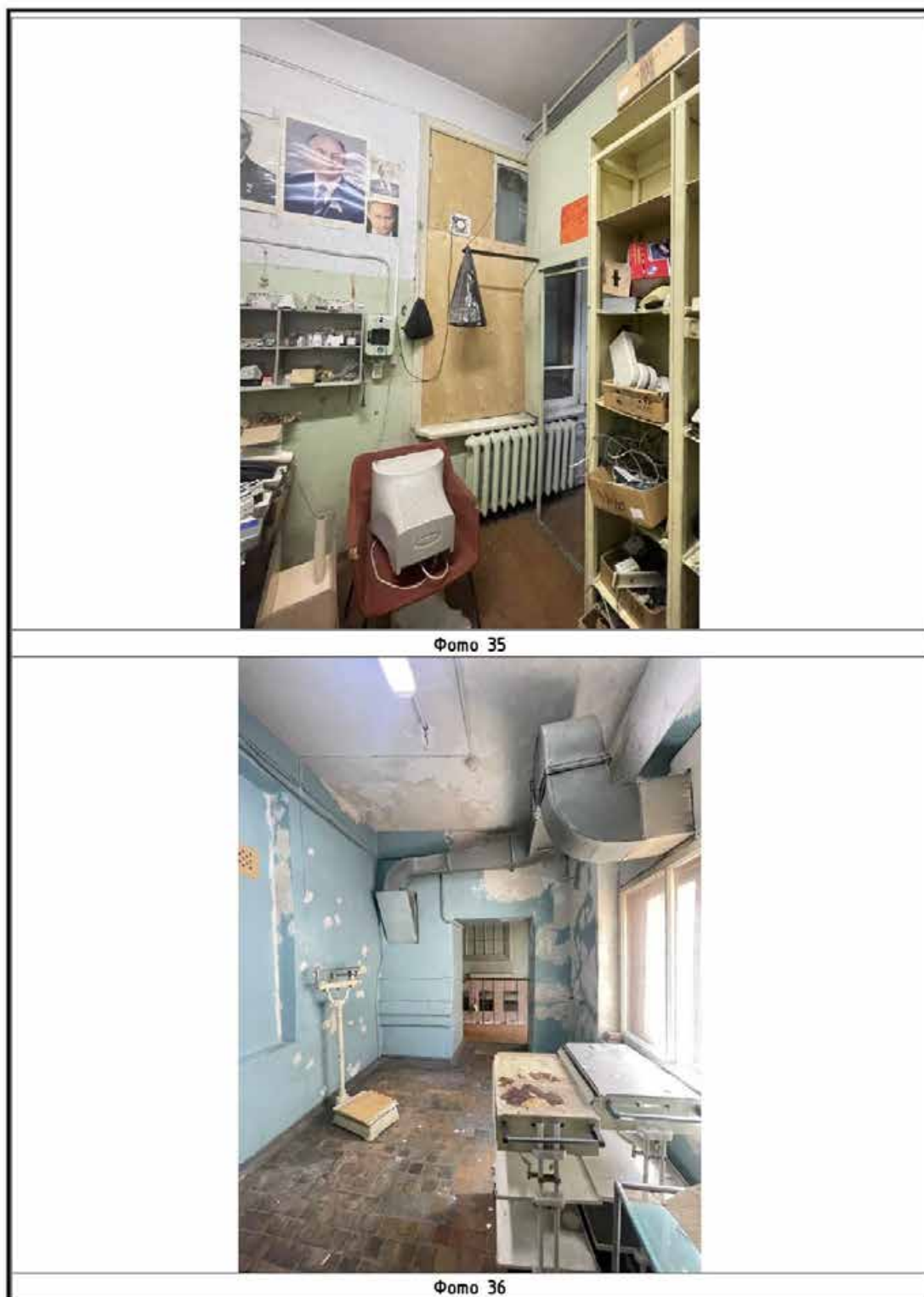
Илл. 255. Северо-западный трапецевидный в плане корпус. Фотофиксация 2-го этажа. Фото 35, 36 на схеме (Илл. 244).
