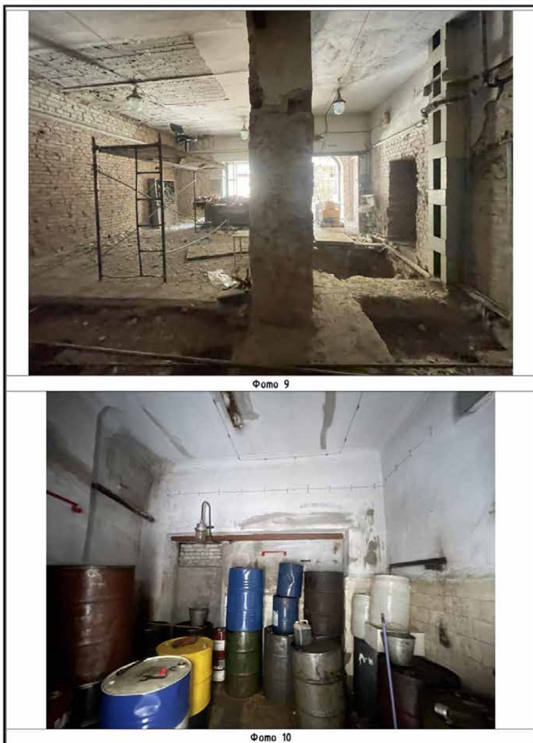
Илл. 241. Северо-западный трапецевидный в плане корпус. Фотофиксация 1-го этажа. Фото 9, 10 на схеме (Илл. 236).
