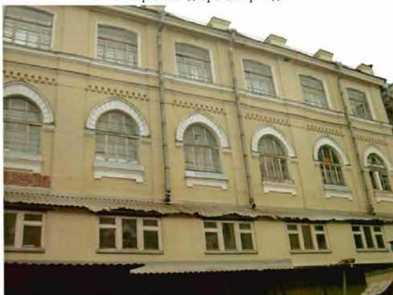
2. Фрагмент дворового фасада
