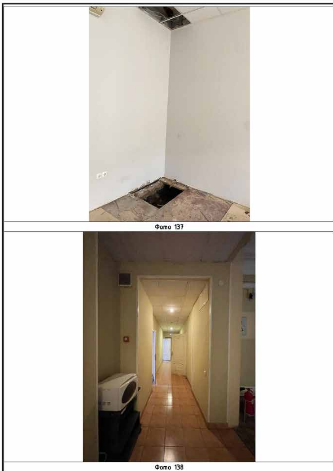
Илл. 108. Корпус по ул. Правды (главный четырехэтажный корпус). Фотофиксация 4-го этажа. Фото 137, 138 на схеме (Илл. 100).
