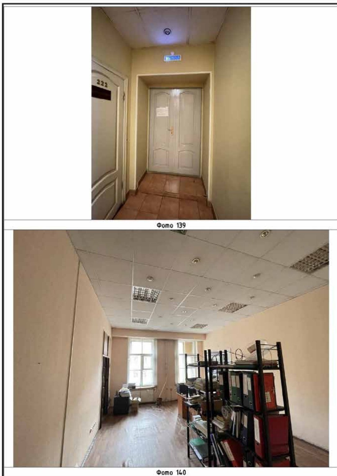
Илл. 109. Корпус по ул. Правды (главный четырехэтажный корпус). Фотофиксация 4-го этажа. Фото 139, 140 на схеме (Илл. 100).
