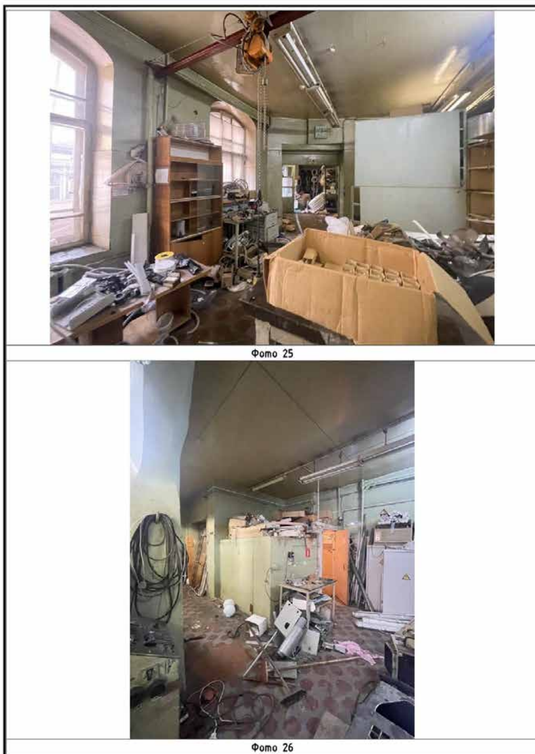
Илл. 250. Северо-западный трапецевидный в плане корпус. Фотофиксация 2-го этажа. Фото 25, 26 на схеме (Илл. 244).
