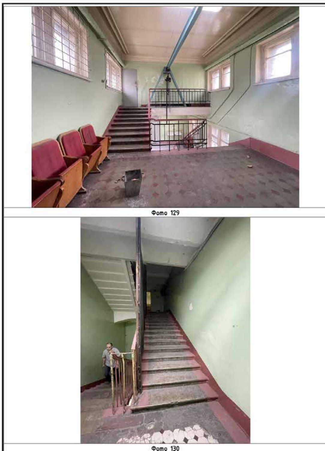
Илл. 172. Средний дворовой Т-образный в плане корпус. Фотофиксация лестниц и верхне-этажного помещения. Фото 129, 130 на схеме (Илл. 170).
