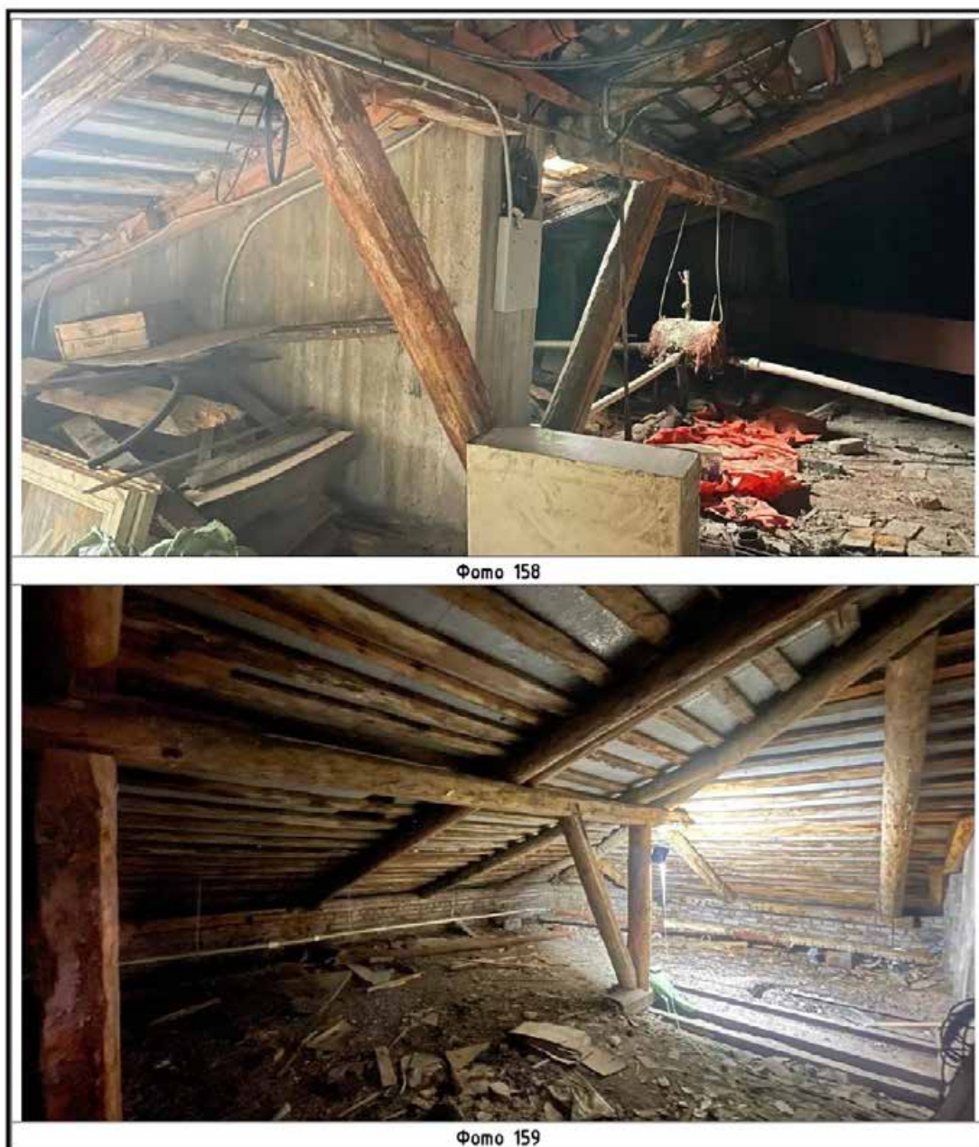
Илл. 120. Корпус по ул. Правды (главный четырехэтажный корпус). Фотофиксация чердачного помещения. Фото 158, 159 на схеме (Илл. 117).
