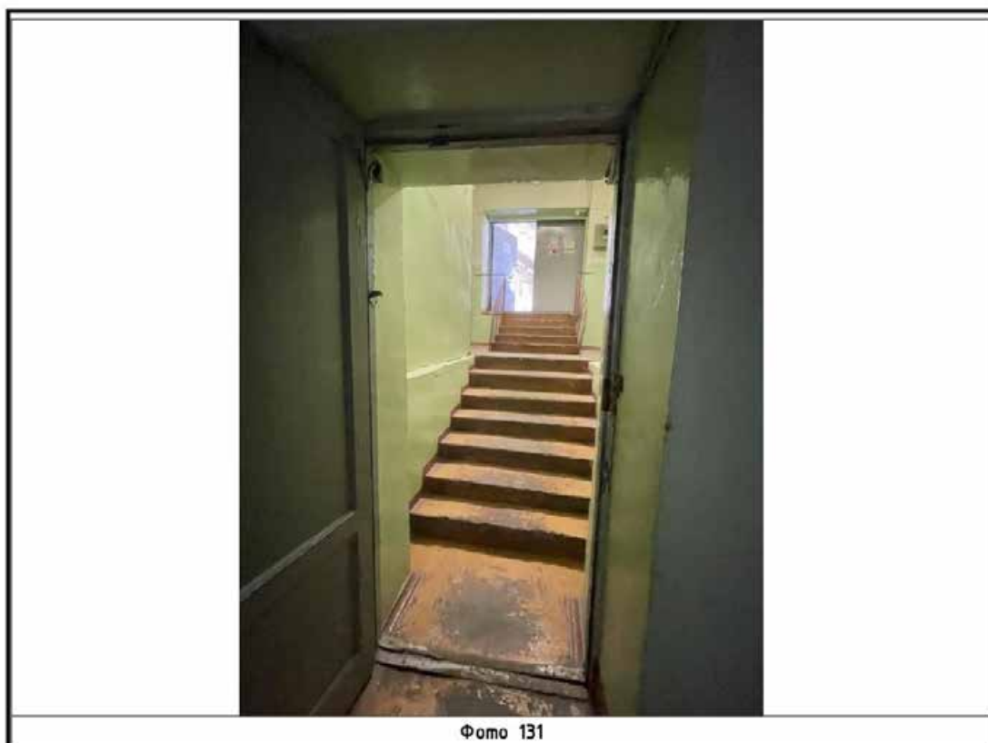
Илл. 173. Средний дворовой Т-образный в плане корпус. Фотофиксация лестниц и верхне-этажного помещения. Фото 131 на схеме (Илл. 170).
