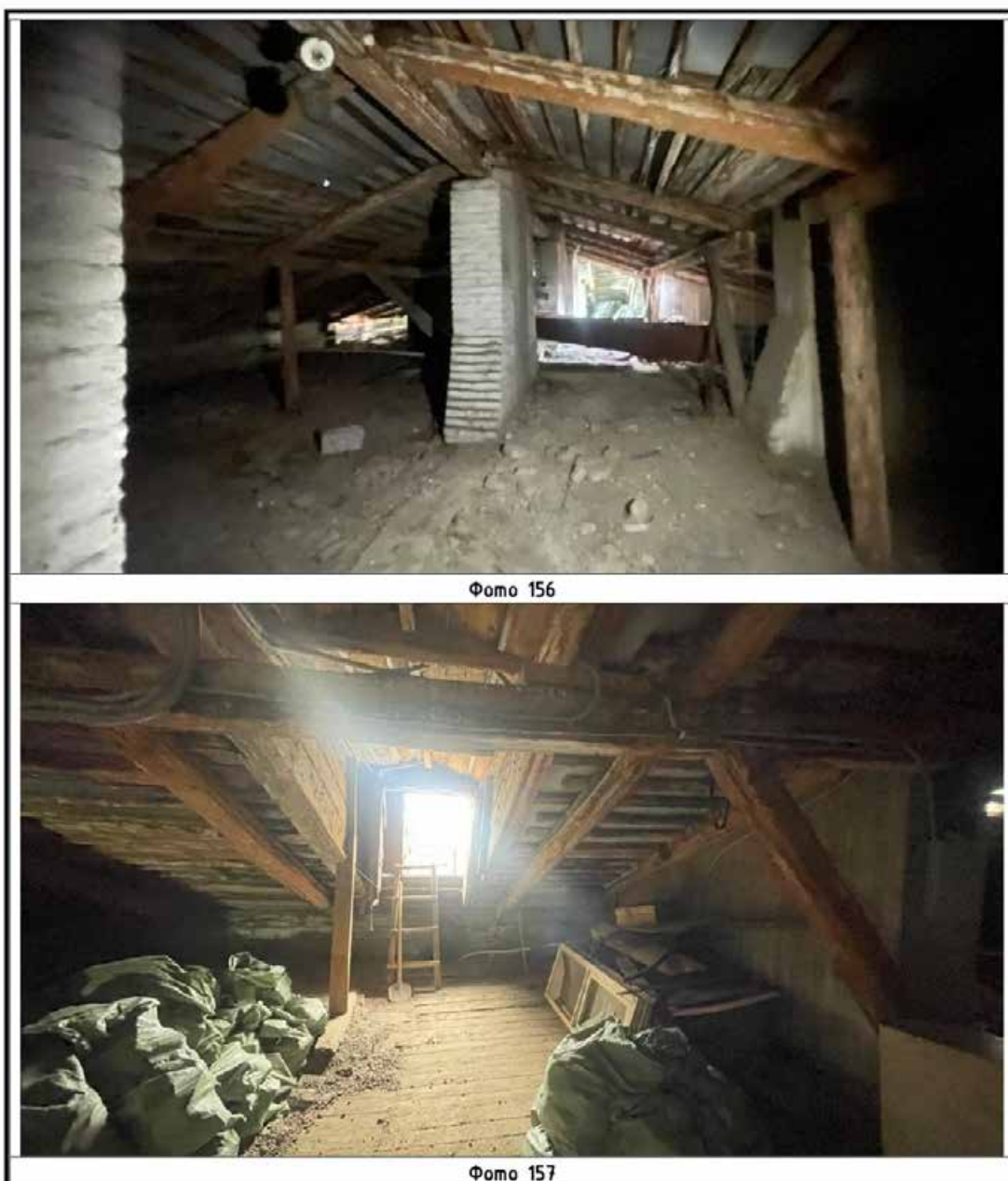
Илл. 119. Корпус по ул. Правды (главный четырехэтажный корпус). Фотофиксация чердачного помещения. Фото 156, 157 на схеме (Илл. 117).
