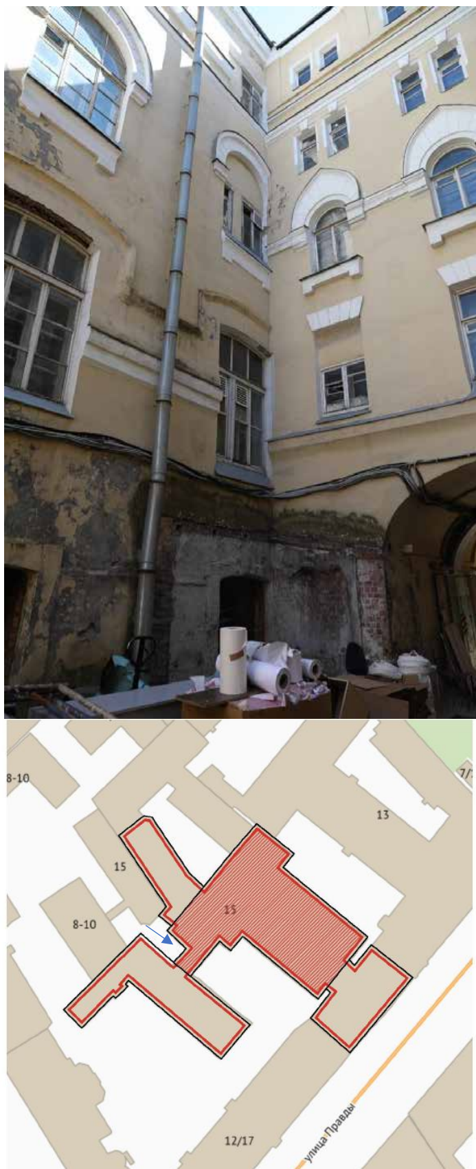
Илл. 30. Объект культурного наследия федерального значения «Синодальная типография», расположенный по адресу: г. Санкт-Петербург, улица Правды, дом 15, литера А. Средний дворовый Т-образный в плане корпус.
