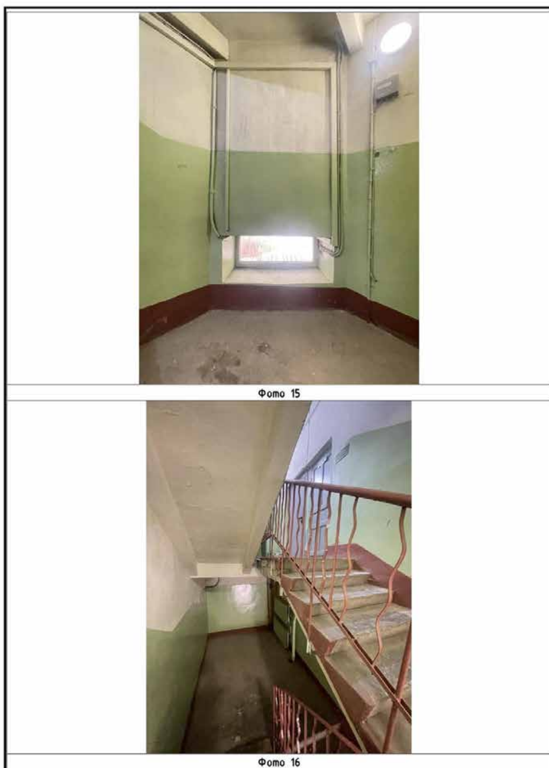
Илл. 245. Северо-западный трапецевидный в плане корпус. Фотофиксация 2-го этажа. Фото 15, 16 на схеме (Илл. 244).
