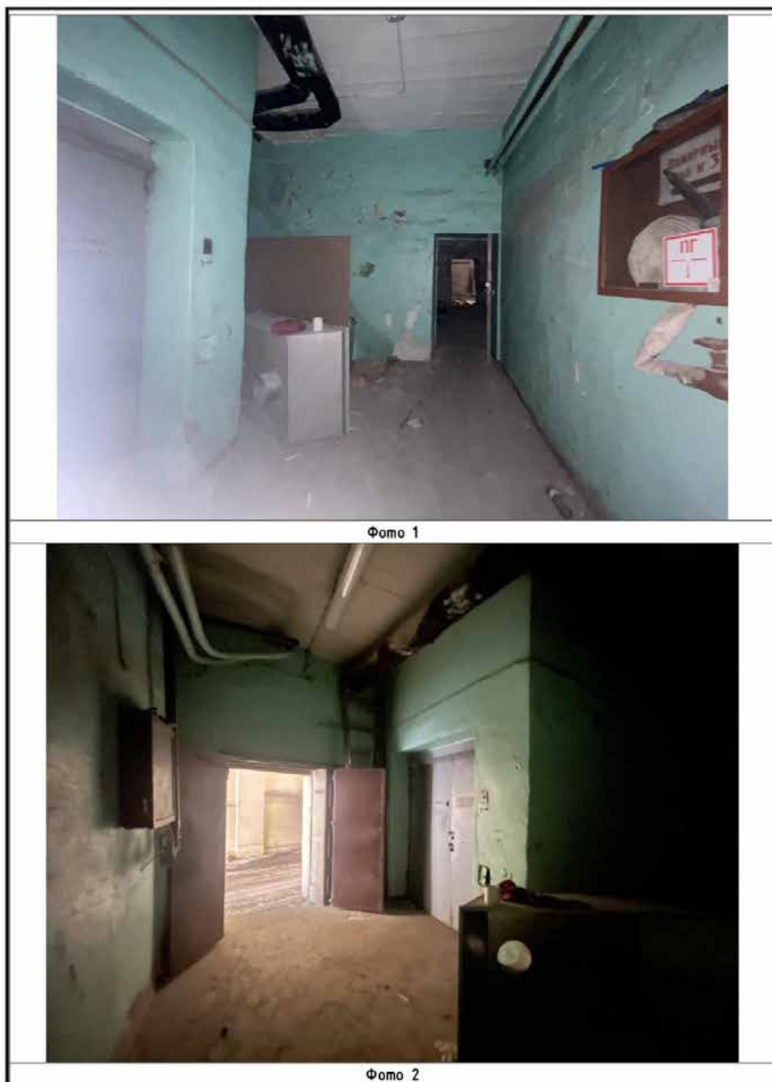
Илл. 237. Северо-западный трапецевидный в плане корпус. Фотофиксация 1-го этажа. Фото 1, 2 на схеме (Илл. 236).
