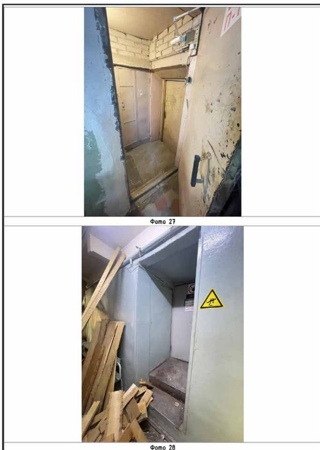
Илл. 251. Северо-западный трапецевидный в плане корпус. Фотофиксация 2-го этажа. Фото 27, 28 на схеме (Илл. 244).
