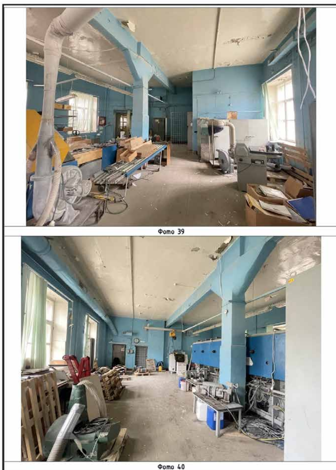
Илл. 258. Северо-западный трапецевидный в плане корпус. Фотофиксация 3-го этажа. Фото 39, 40 на схеме (Илл. 257).
