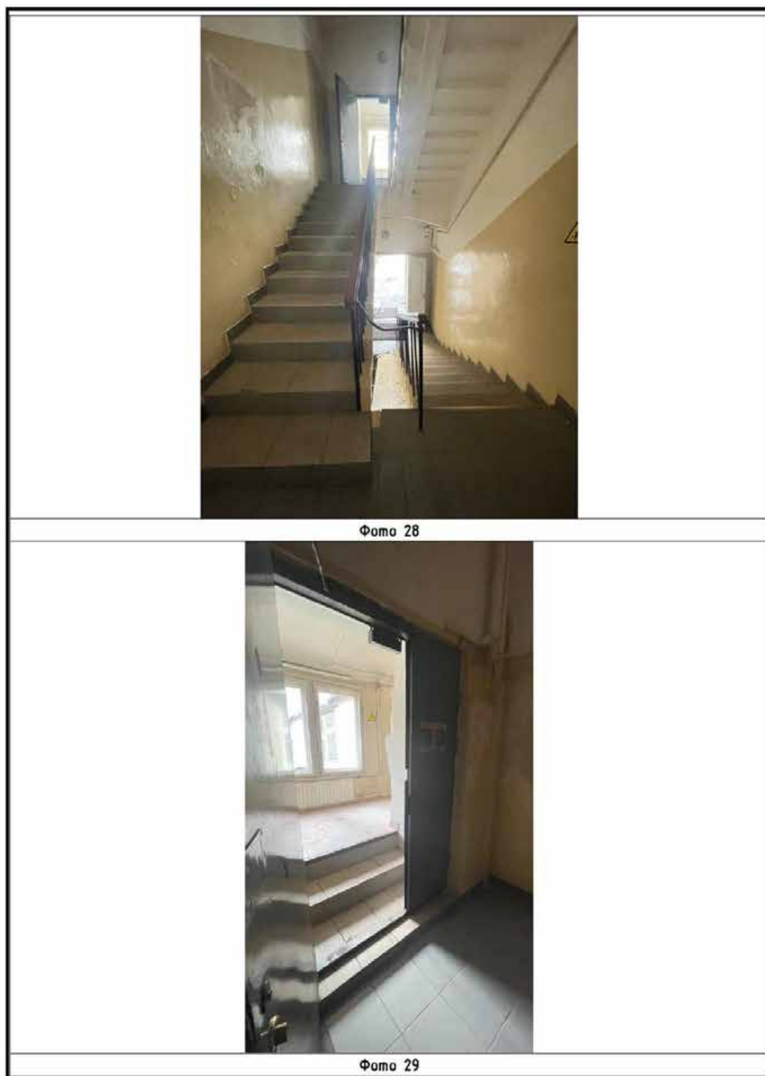
Илл. 50. Корпус по ул. Правды (главный четырехэтажный корпус). Фотофиксация 1-го этажа. Фото 28, 29 на схеме (Илл. 48).
