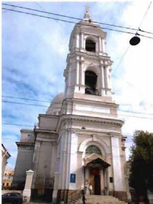
1. Юго-западный фасад объекта культурного наследия.
