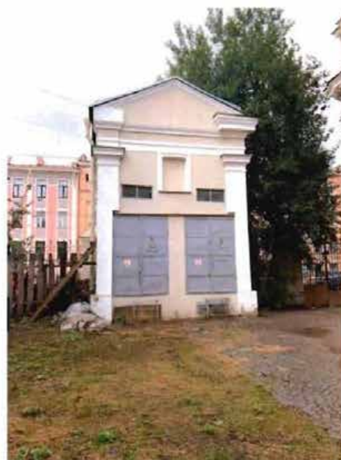
14. Северо-восточный фасад юго-восточной Часовни.
