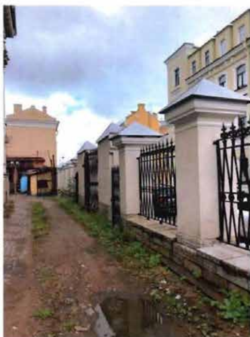
16. Фрагмент ограды вдоль Тучкова переулка. Юго-западный фасад.
