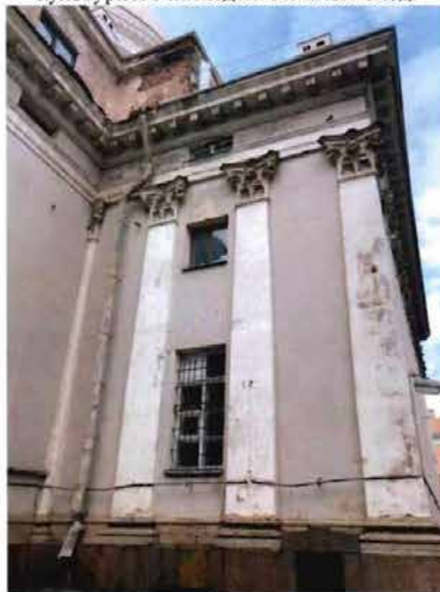
4. Фрагмент юго-восточного фасада объекта культурного наследия.
