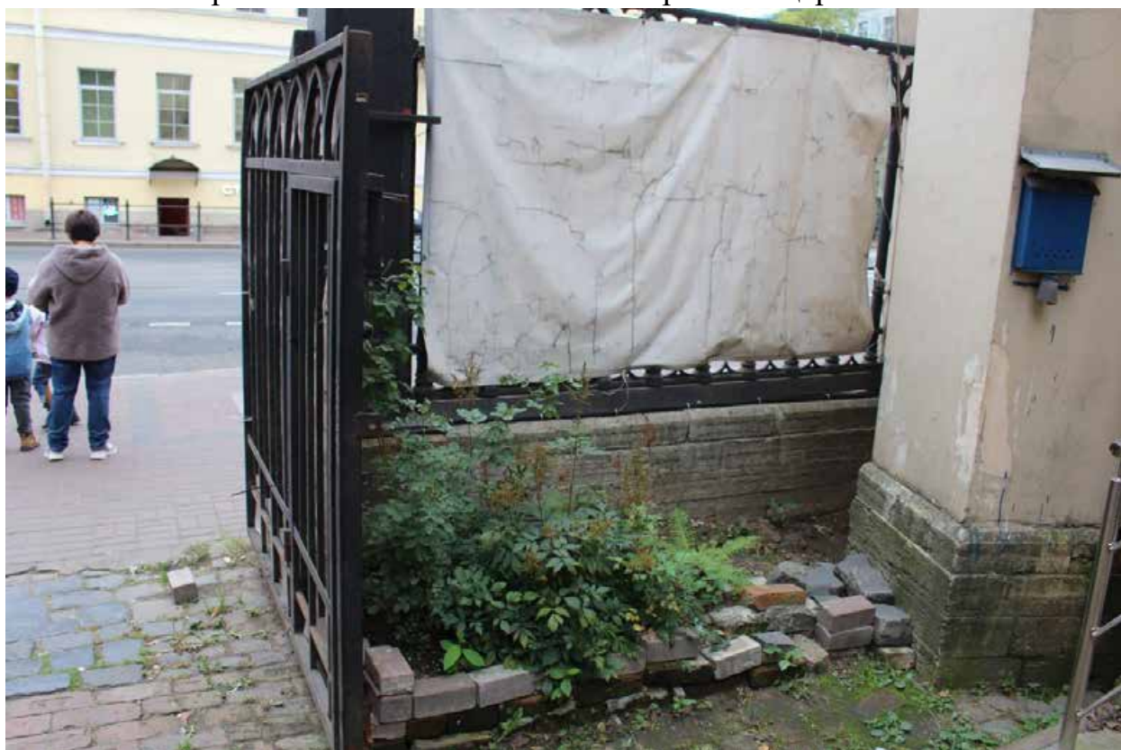
Фото 18. Вид на ограду объекта культурного наследия регионального значения «Лютеранская церковь».
