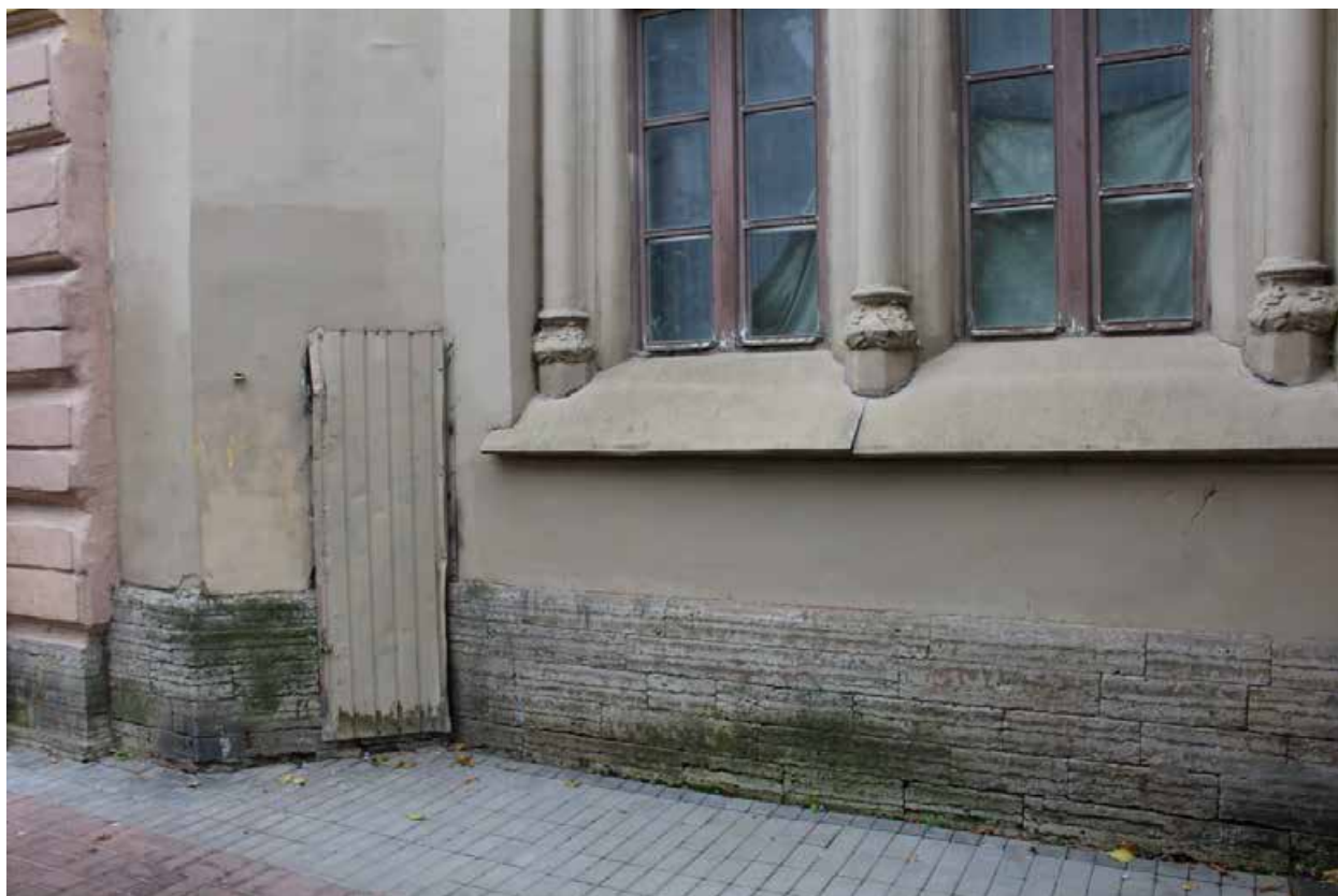
Фото 10. Вид на восточный фасад объекта культурного наследия регионального значения «Лютеранская церковь».
