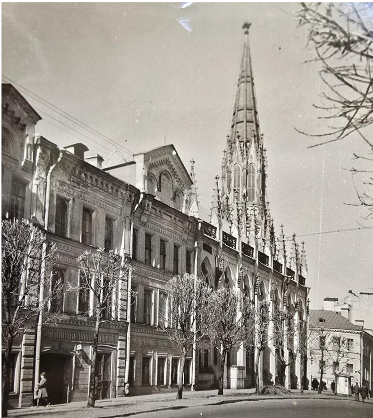
Илл. 89. Вид на восточный фасад. Лютеранская церковь святого Михаила. Зайцева К.А. 1969 г. (источник: архив КГИОП. Фототека П. 379).
