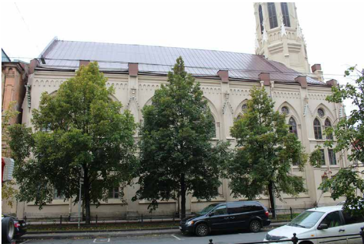
Фото 7. Вид на восточный фасад объекта культурного наследия регионального значения «Лютеранская церковь».
