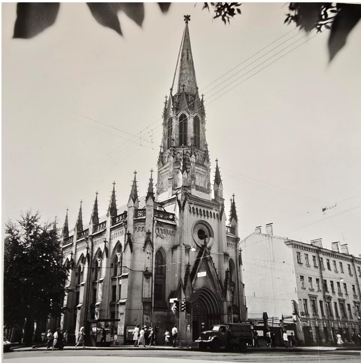
Илл. 106. Общий вид. Средний проспект Васильевского острова. Лютеранская церковь святого Михаила. Егоровский В.Ф. июль 1989 г. (источник: архив КГИОП. Фототека П. 379).
