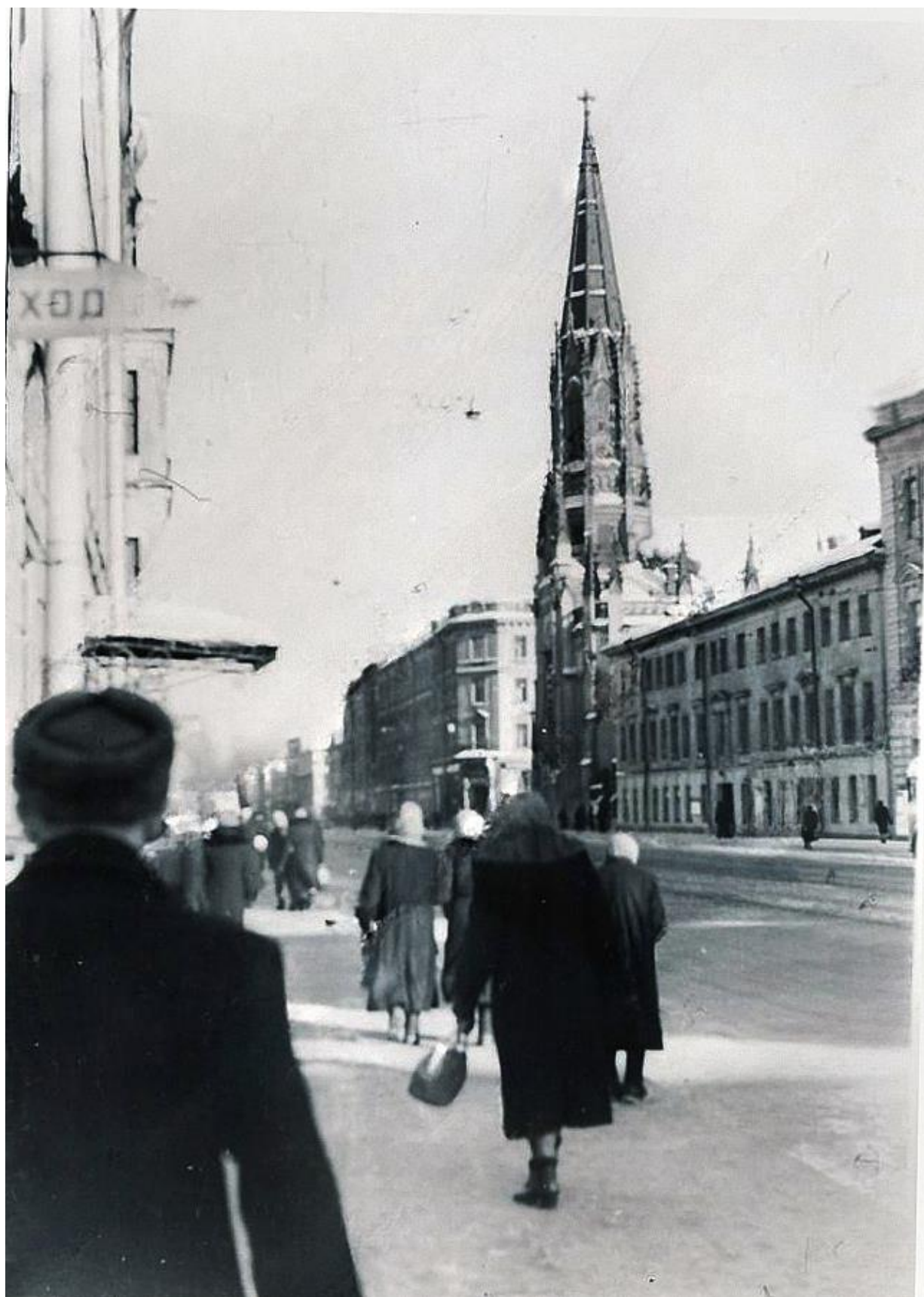
Илл. 85. Вид на Лютеранскую церковь. 1958 г. (источник: https://www.citywalls.ru/photo660114.html ).
