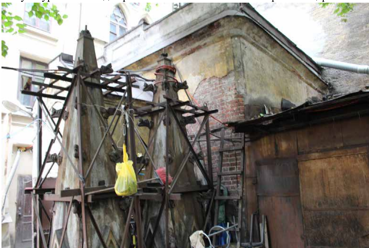
Фото 16. Вид на фасад одноэтажной пристройки-сакристии объекта культурного наследия регионального значения «Лютеранская церковь».
