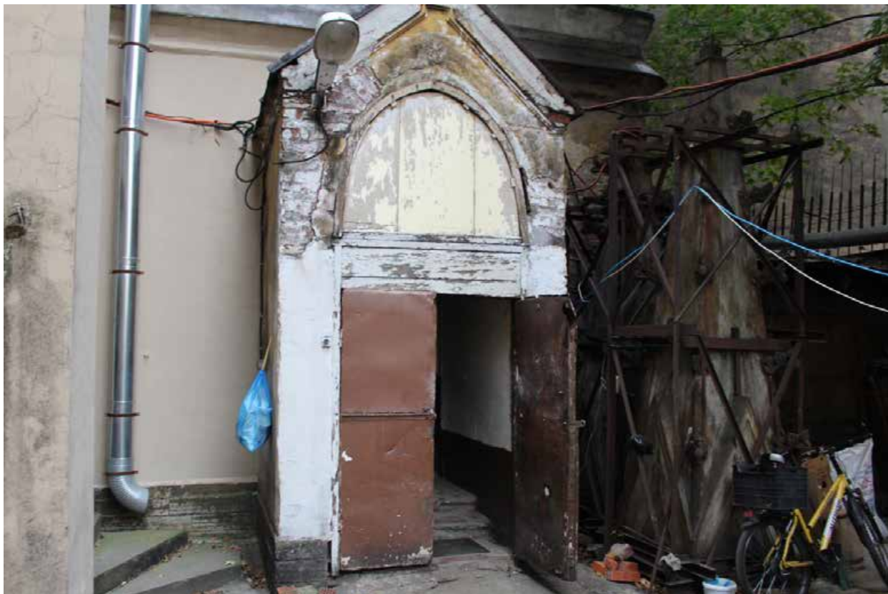
Фото 15. Вид на фасад одноэтажной пристройки-сакристии объекта культурного наследия регионального значения «Лютеранская церковь».
