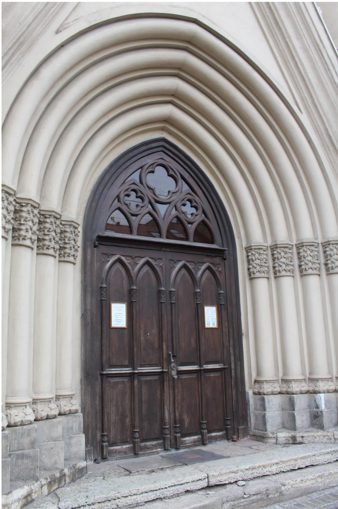
Фото 20. Вид на дверной проем парадного входа объекта культурного наследия регионального значения «Лютеранская церковь».
