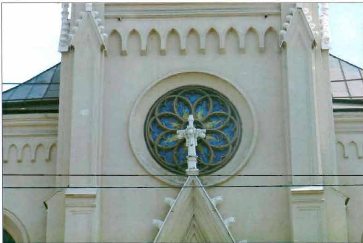
3. Северный фасад. Фрагмент.
