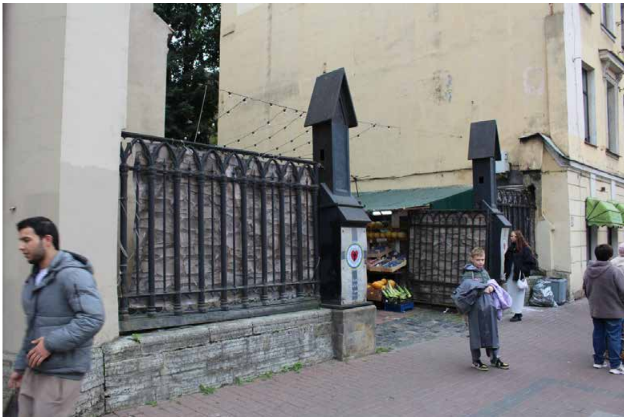
Фото 19. Вид на ограду объекта культурного наследия регионального значения «Лютеранская церковь».
