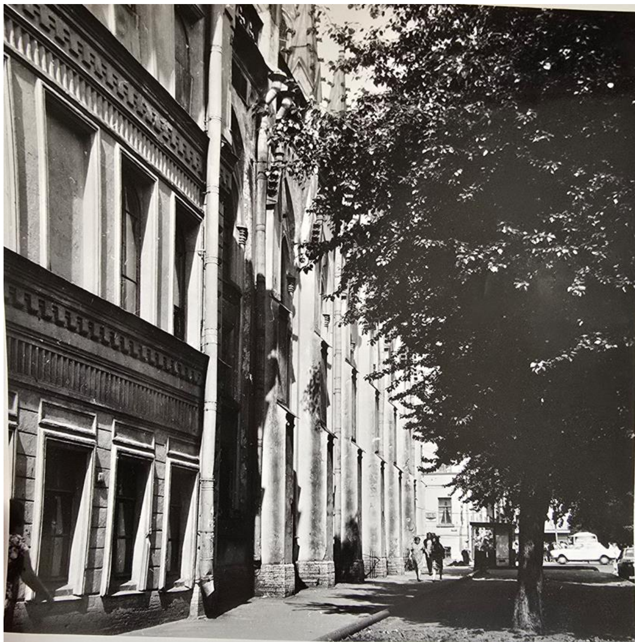
Илл. 101. Фрагмент восточный фасад. Лютеранская церковь святого Михаила. Егоровский В.Ф. июль 1989 г. (источник: архив КГИОП. Фототека П. 379).
