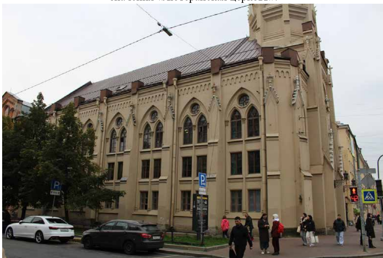
Фото 6. Вид на восточный фасад объекта культурного наследия регионального значения «Лютеранская церковь».
