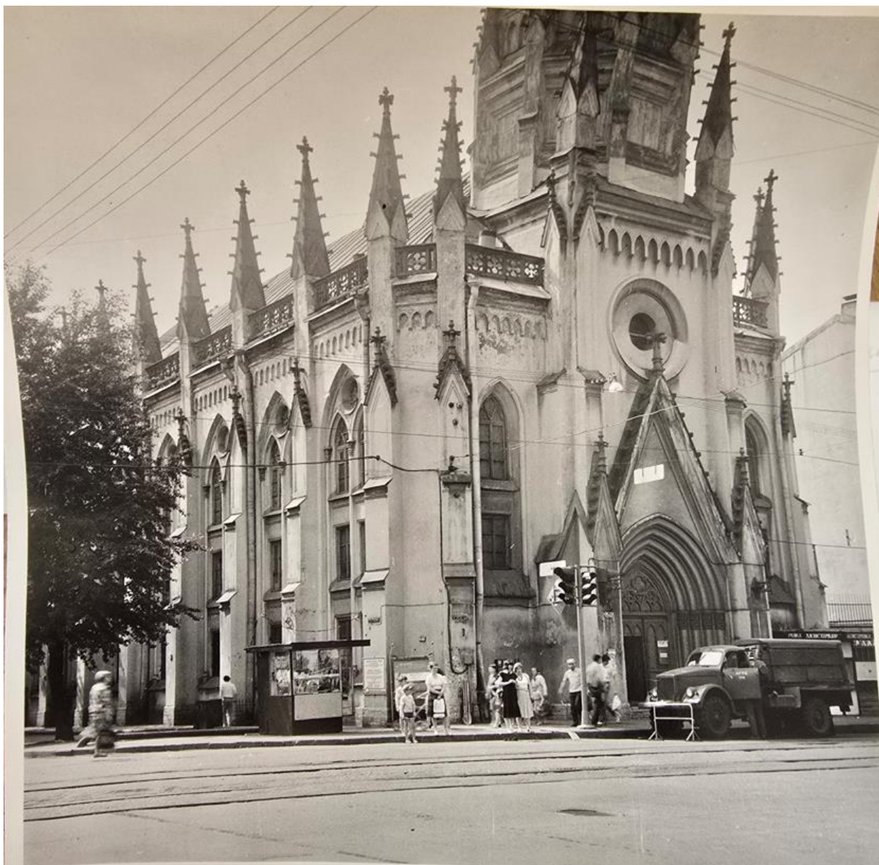
Илл. 105. Главный вход. Средний проспект Васильевского острова. Лютеранская церковь святого Михаила. Егоровский В.Ф. июль 1989 г. (источник: архив КГИОП. Фототека П. 379).
