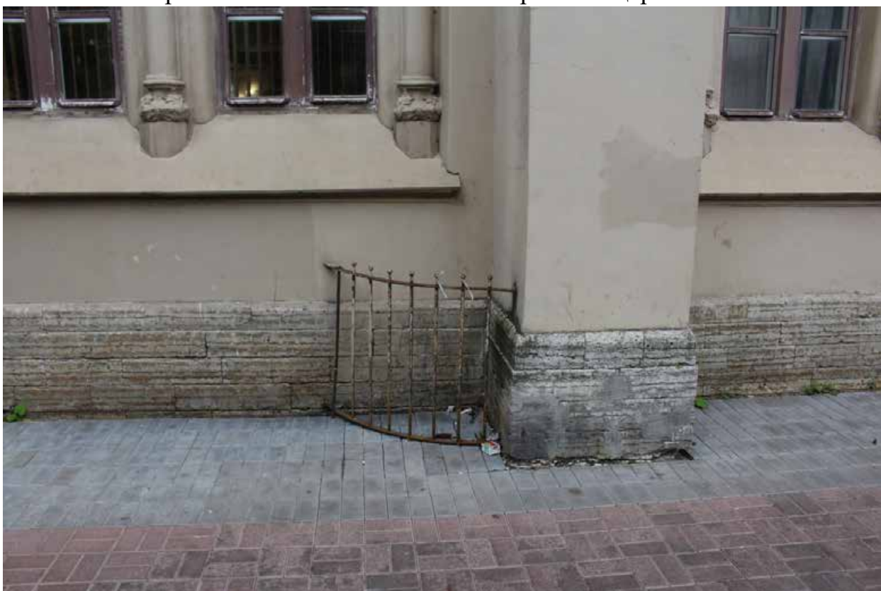
Фото 8. Вид на восточный фасад объекта культурного наследия регионального значения «Лютеранская церковь».
