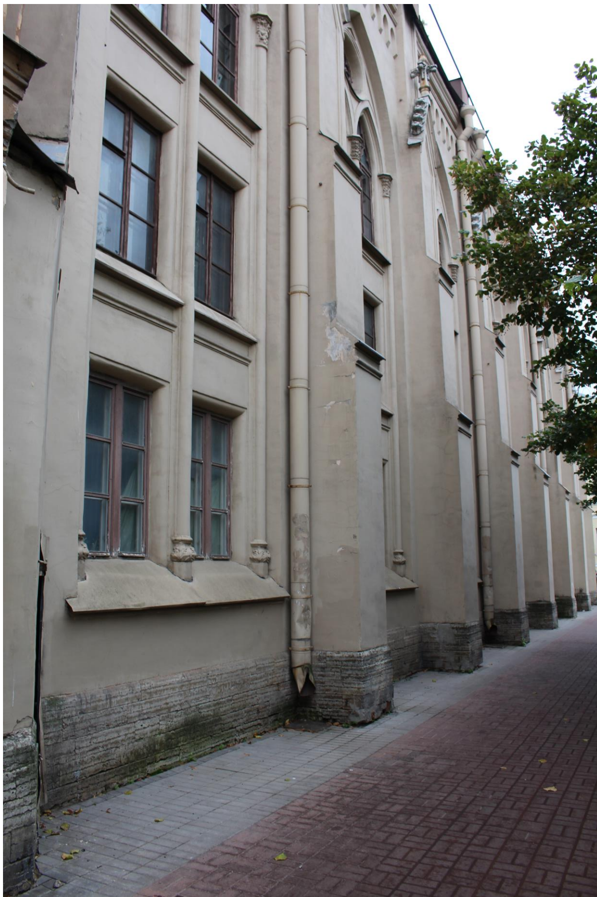
Фото 9. Вид на восточный фасад объекта культурного наследия регионального значения «Лютеранская церковь».
