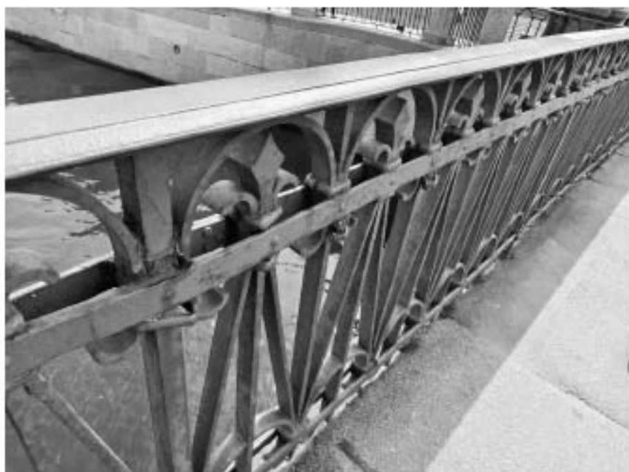
17. «Мост Аларчин» входящий в состав комплекса «Набережные и мосты Екатерининского канала (ныне канала Грибоедова)», через канал Грибоедова по Английскому проспекту. Фрагмент. Фото 09.07.2025г.
