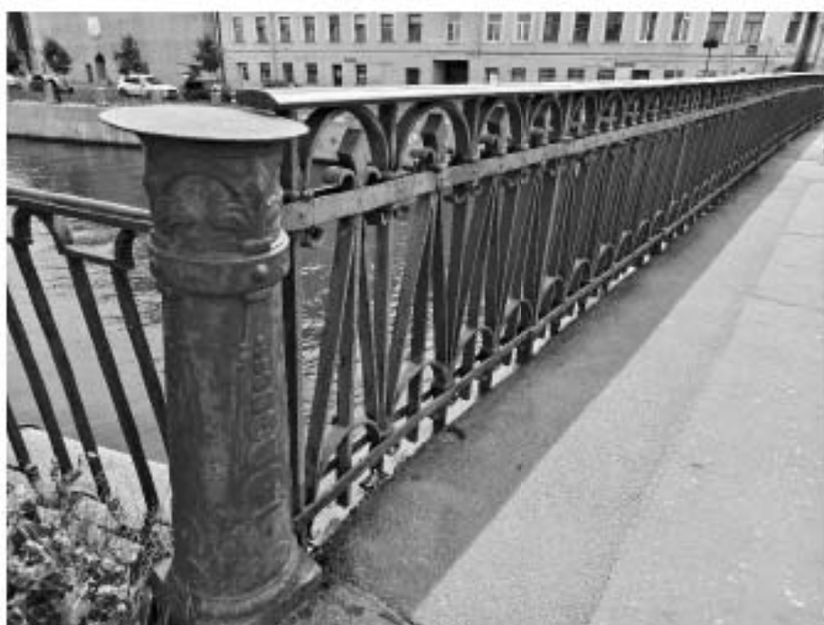
20. «Мост Аларчин» входящий в состав комплекса «Набережные и мосты Екатерининского канала (ныне канала Грибоедова)», через канал Грибоедова по Английскому проспекту. Фрагмент. Фото 09.07.2025г.
