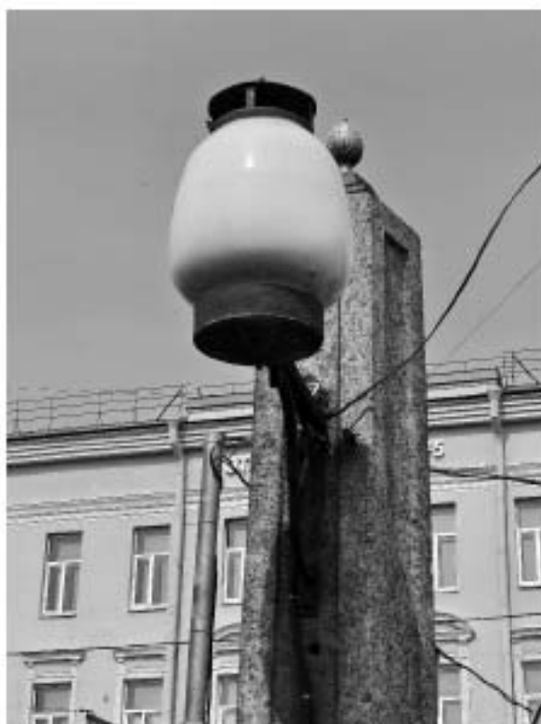
31. «Мост Аларчин» входящий в состав комплекса «Набережные и мосты Екатерининского канала (ныне канала Грибоедова)», через канал Грибоедова по Английскому проспекту. Фрагмент. Фото 09.07.2025г.
