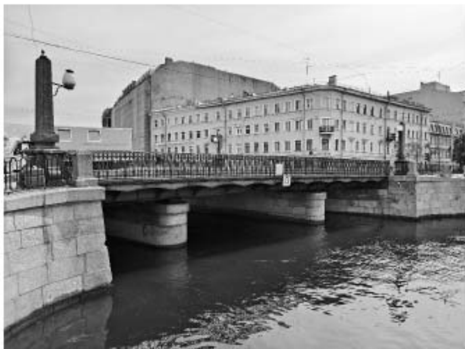
5. «Мост Аларчин» входящий в состав комплекса «Набережные и мосты Екатерининского канала (ныне канала Грибоедова)», через канал Грибоедова по Английскому проспекту. Западный фасад. Общий вид. Фото 09.07.2025г.
