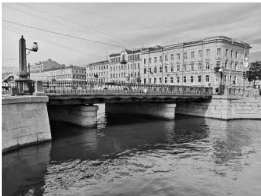
3. «Мост Аларчин» входящий в состав комплекса «Набережные и мосты Екатерининского канала (ныне канала Грибоедова)», через канал Грибоедова по Английскому проспекту. Восточный фасад. Общий вид. Фото 09.07.2025г.
