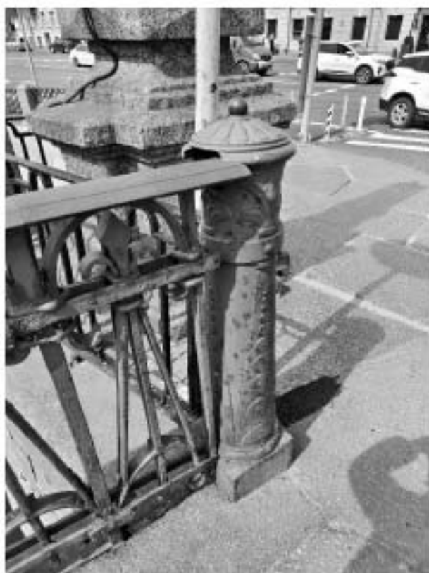
33. «Мост Аларчин» входящий в состав комплекса «Набережные и мосты Екатерининского канала (ныне канала Грибоедова)», через канал Грибоедова по Английскому проспекту. Фрагмент. Фото 09.07.2025г.
