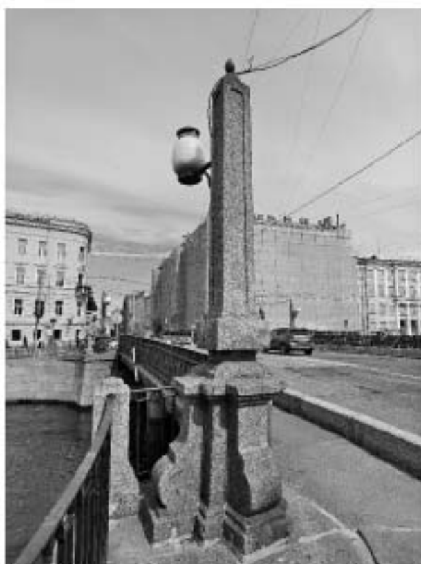
24. «Мост Аларчин» входящий в состав комплекса «Набережные и мосты Екатерининского канала (ныне канала Грибоедова)», через канал Грибоедова по Английскому проспекту. Фрагмент. Фото 09.07.2025г.
