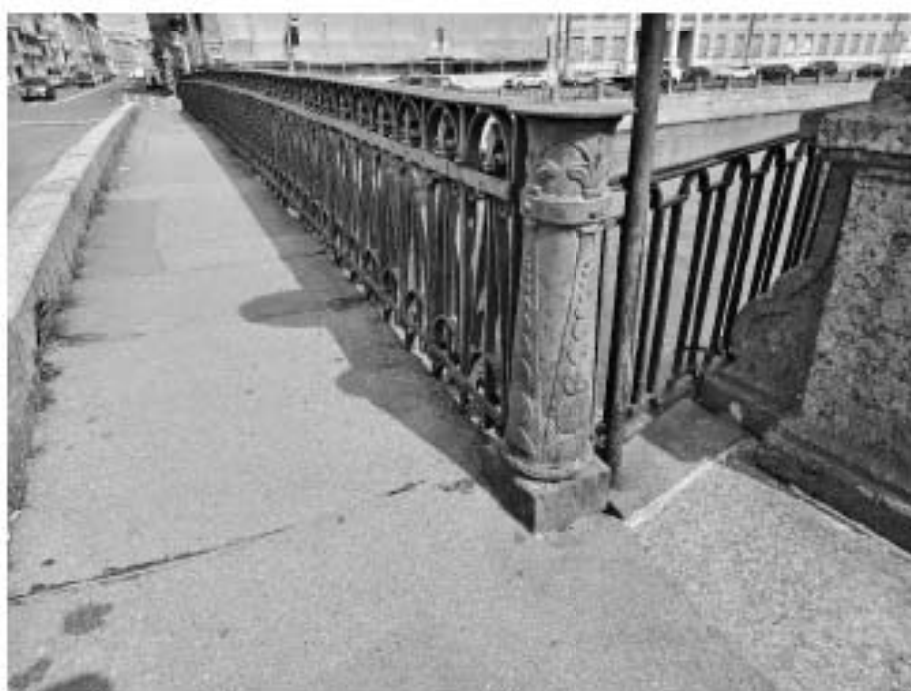
14. «Мост Аларчин» входящий в состав комплекса «Набережные и мосты Екатерининского канала (ныне канала Грибоедова)», через канал Грибоедова по Английскому проспекту. Фрагмент. Фото 09.07.2025г.
