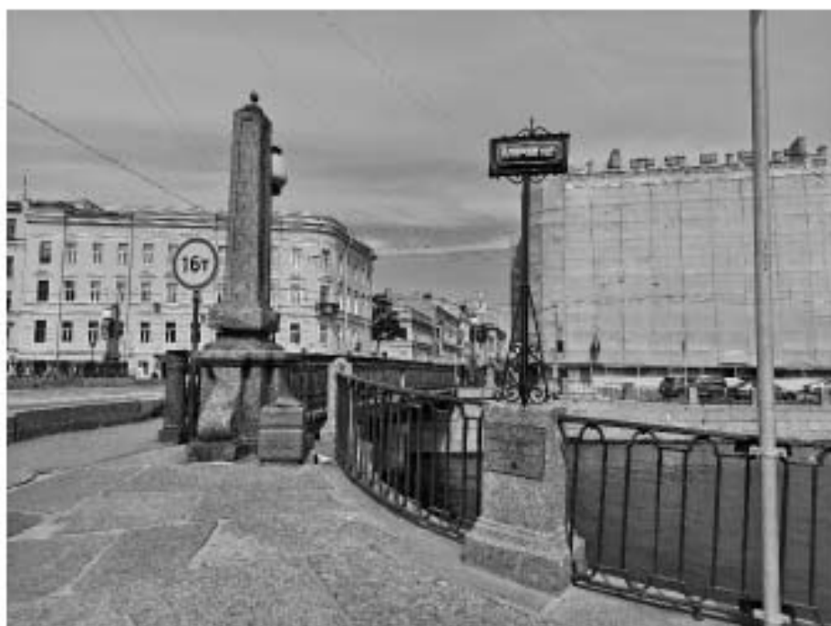
11. «Мост Аларчин» входящий в состав комплекса «Набережные и мосты Екатерининского канала (ныне канала Грибоедова)», через канал Грибоедова по Английскому проспекту. Фрагмент. Фото 09.07.2025г.
