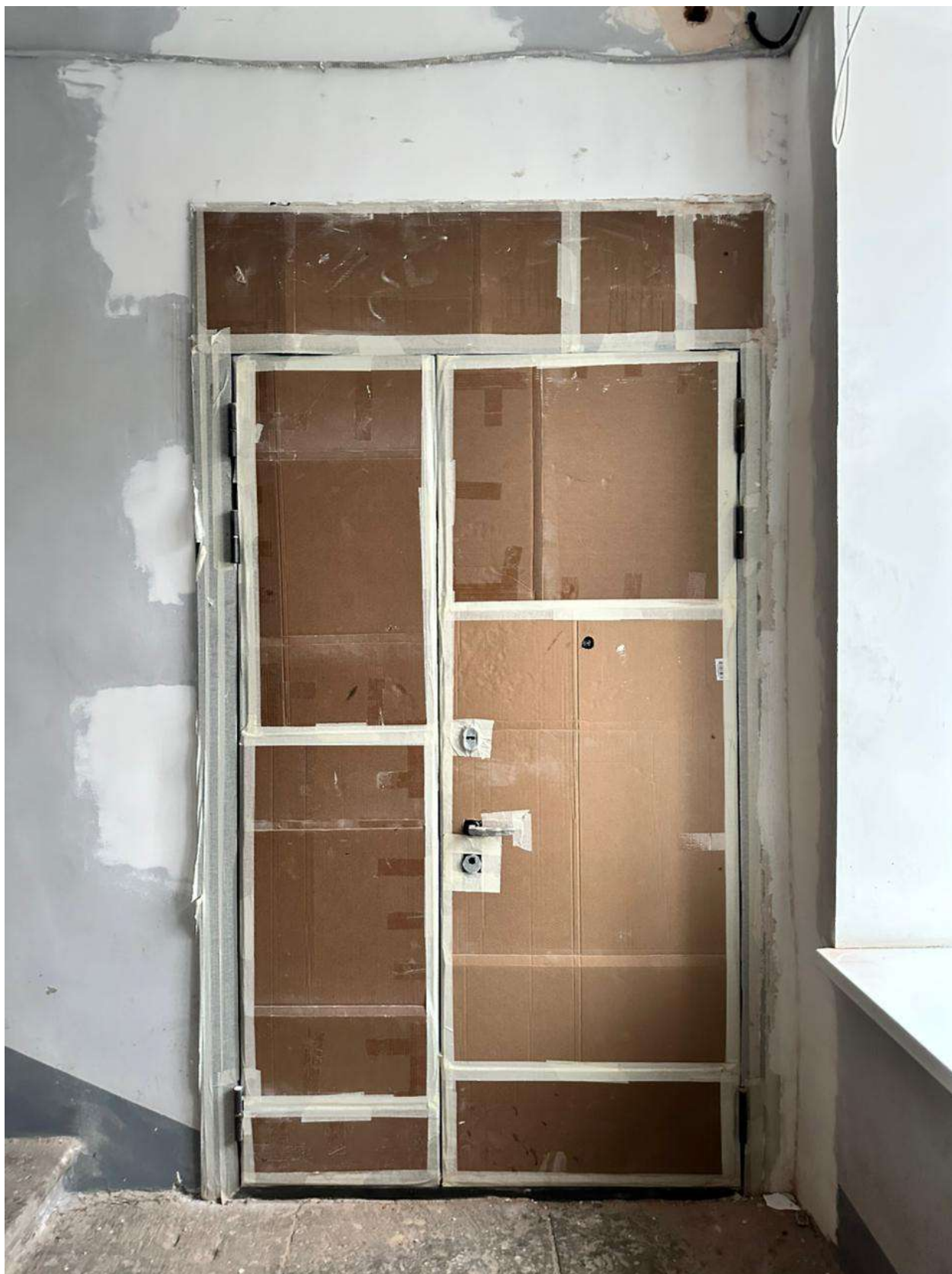
5. Входная дверь (со стороны помещения ЛК5 в соответствии с техническим паспортом).
