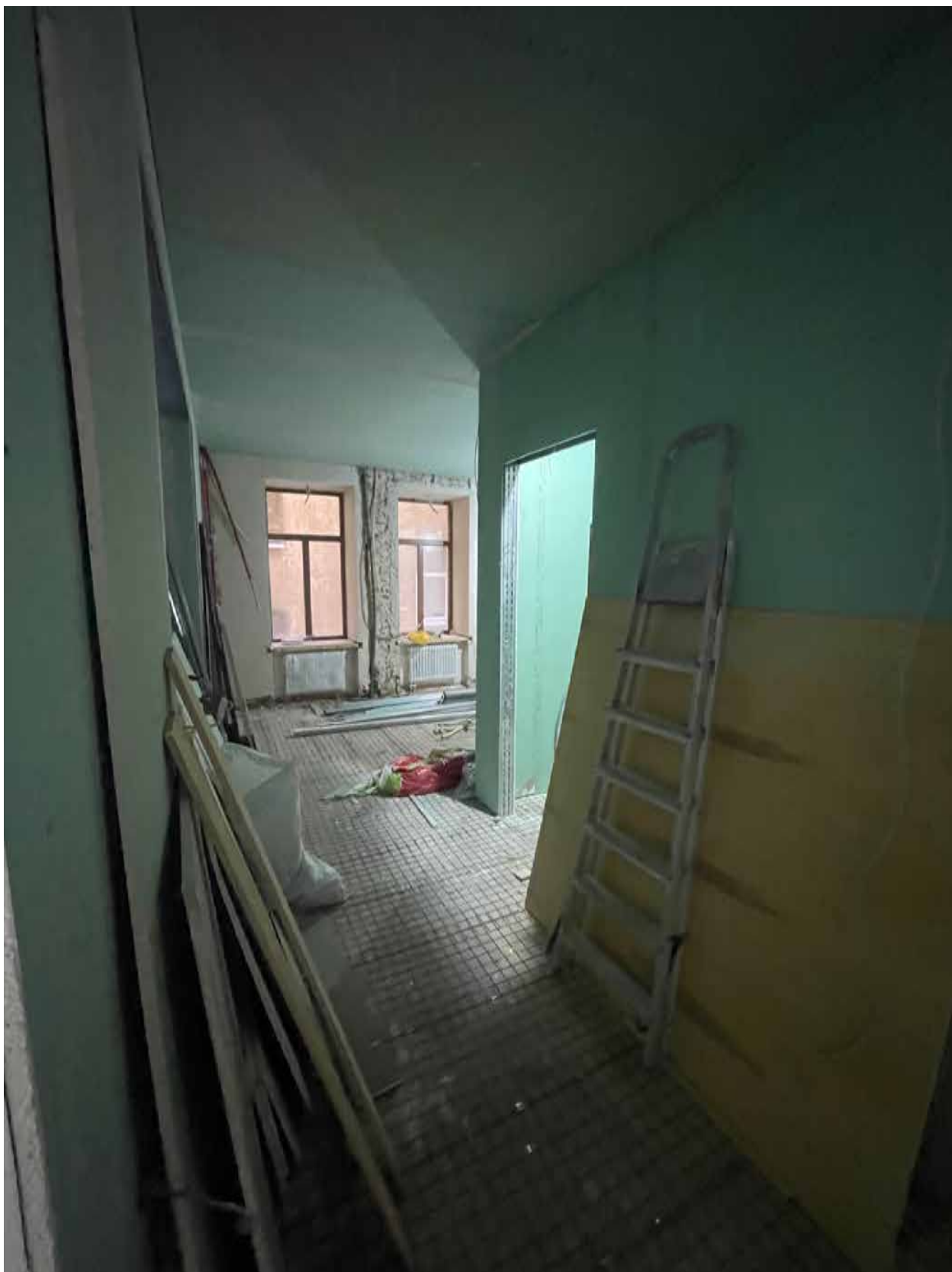
24. Помещение 10 (согласно техническому паспорту). 2 этаж.
