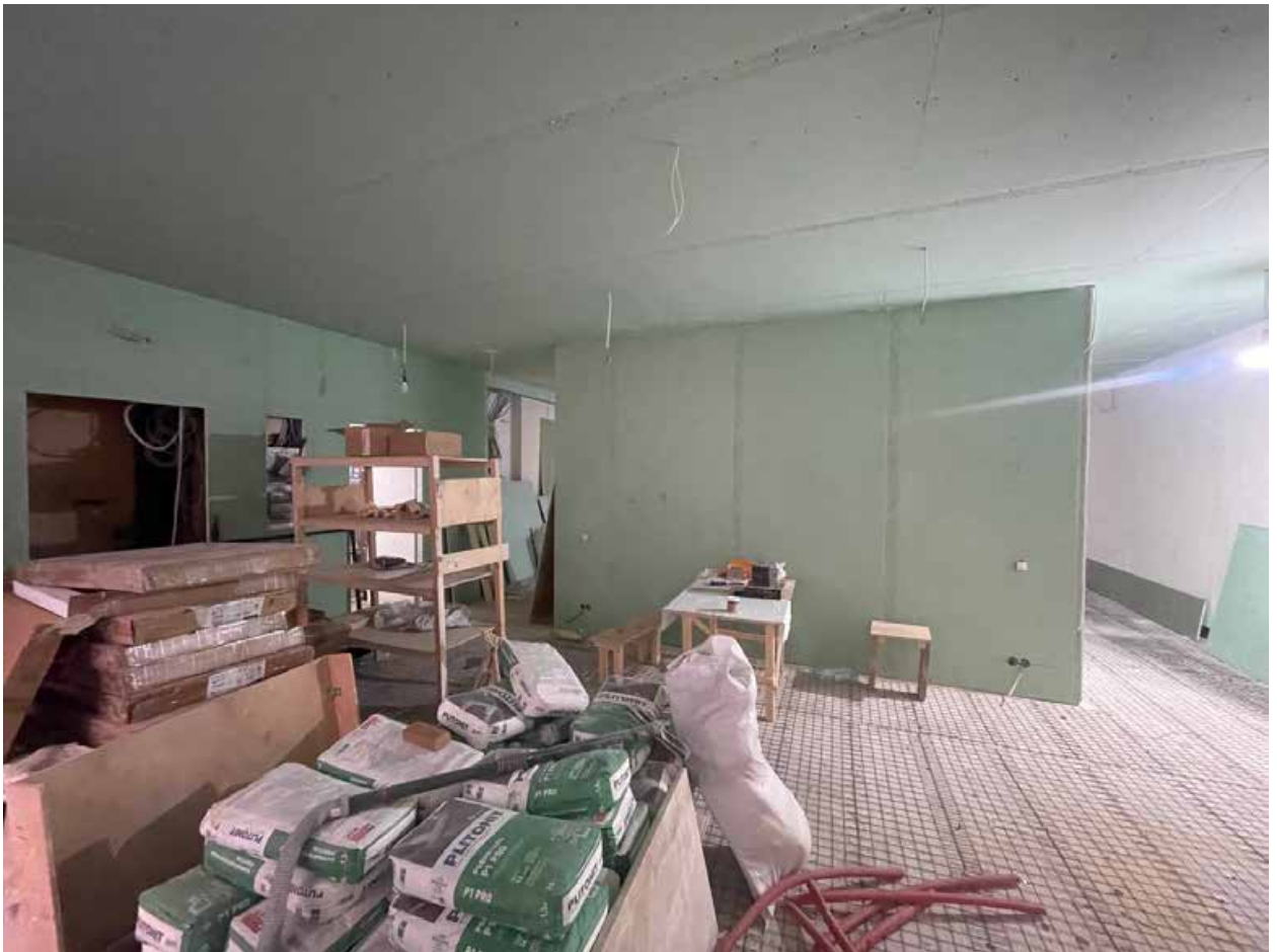
27. Помещение 10 (согласно техническому паспорту). 2 этаж.
