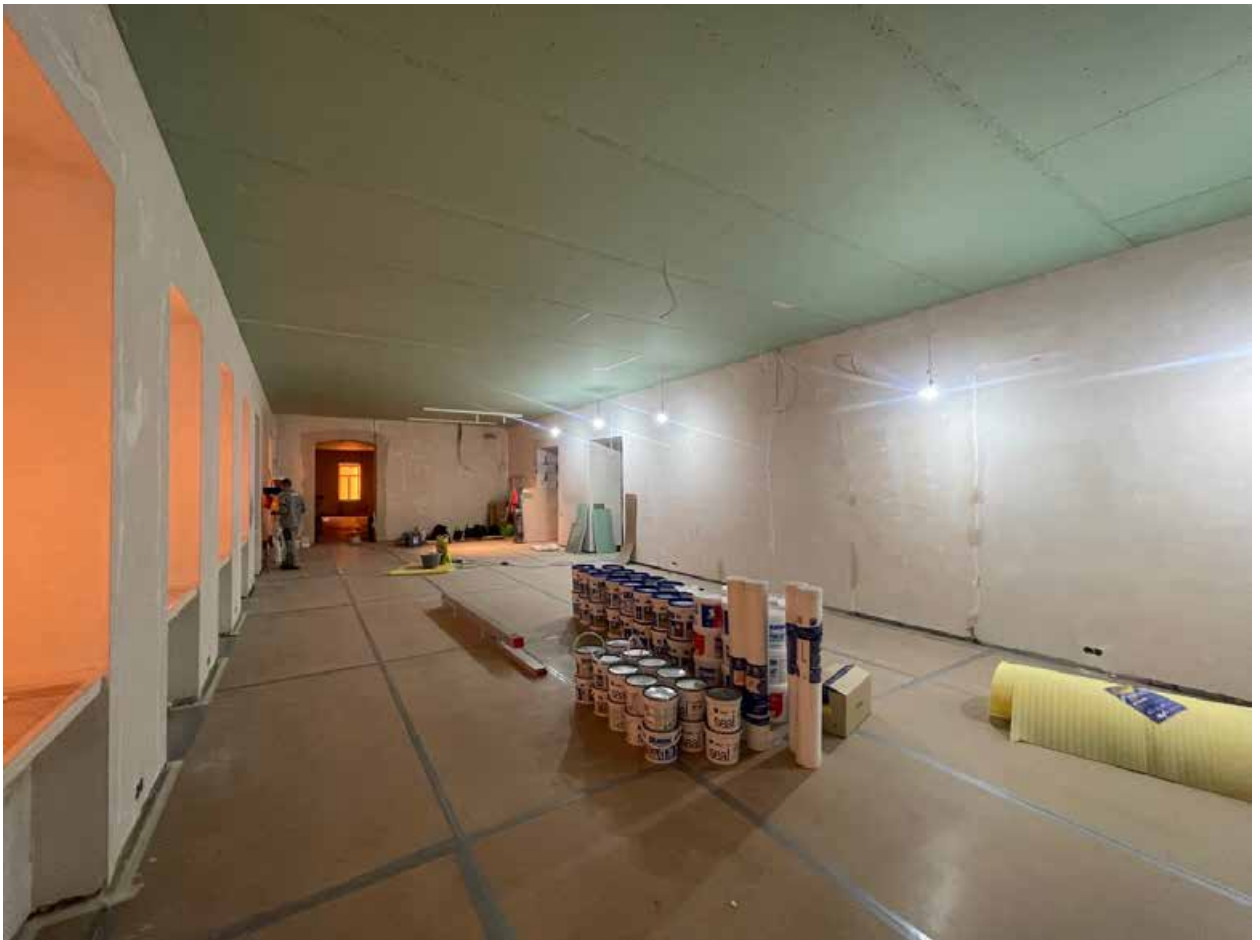
31. Помещение 11 (согласно техническому паспорту). 2 этаж.
