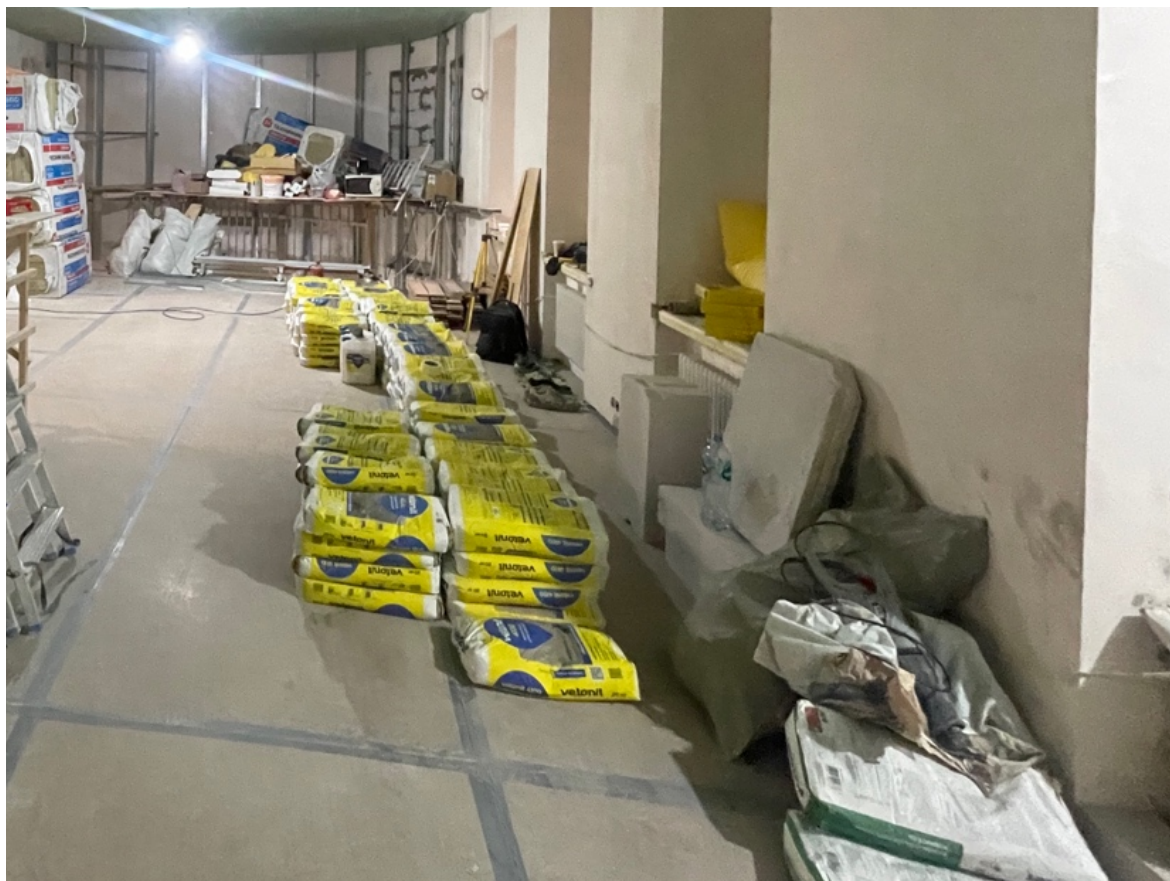
23. Помещение 9 (согласно техническому паспорту). 2 этаж.
