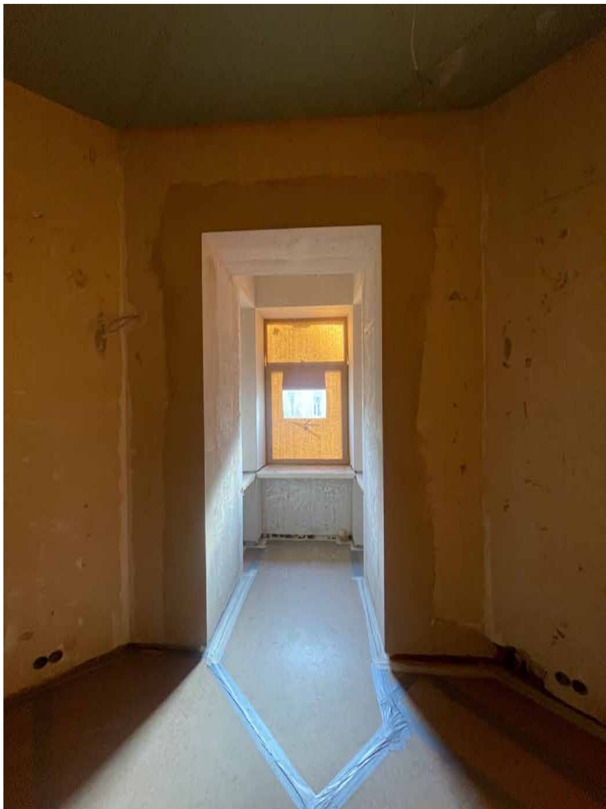
36. Помещение 12 (согласно техническому паспорту). 2 этаж.
