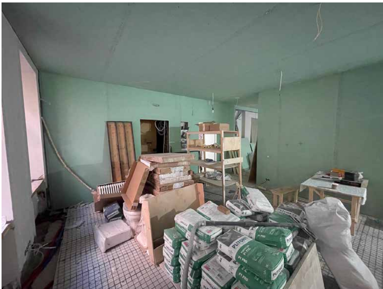
29. Помещение 10 (согласно техническому паспорту). 2 этаж.
