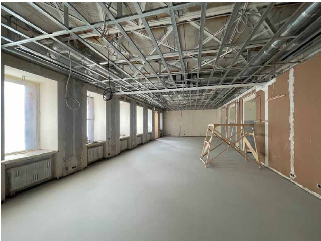
13. Помещение 1 (согласно техническому паспорту). 1 этаж.
