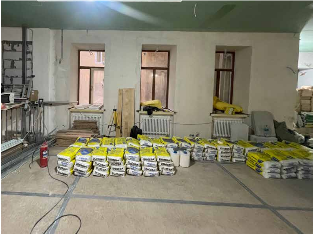
21. Помещение 9 (согласно техническому паспорту). 2 этаж.
