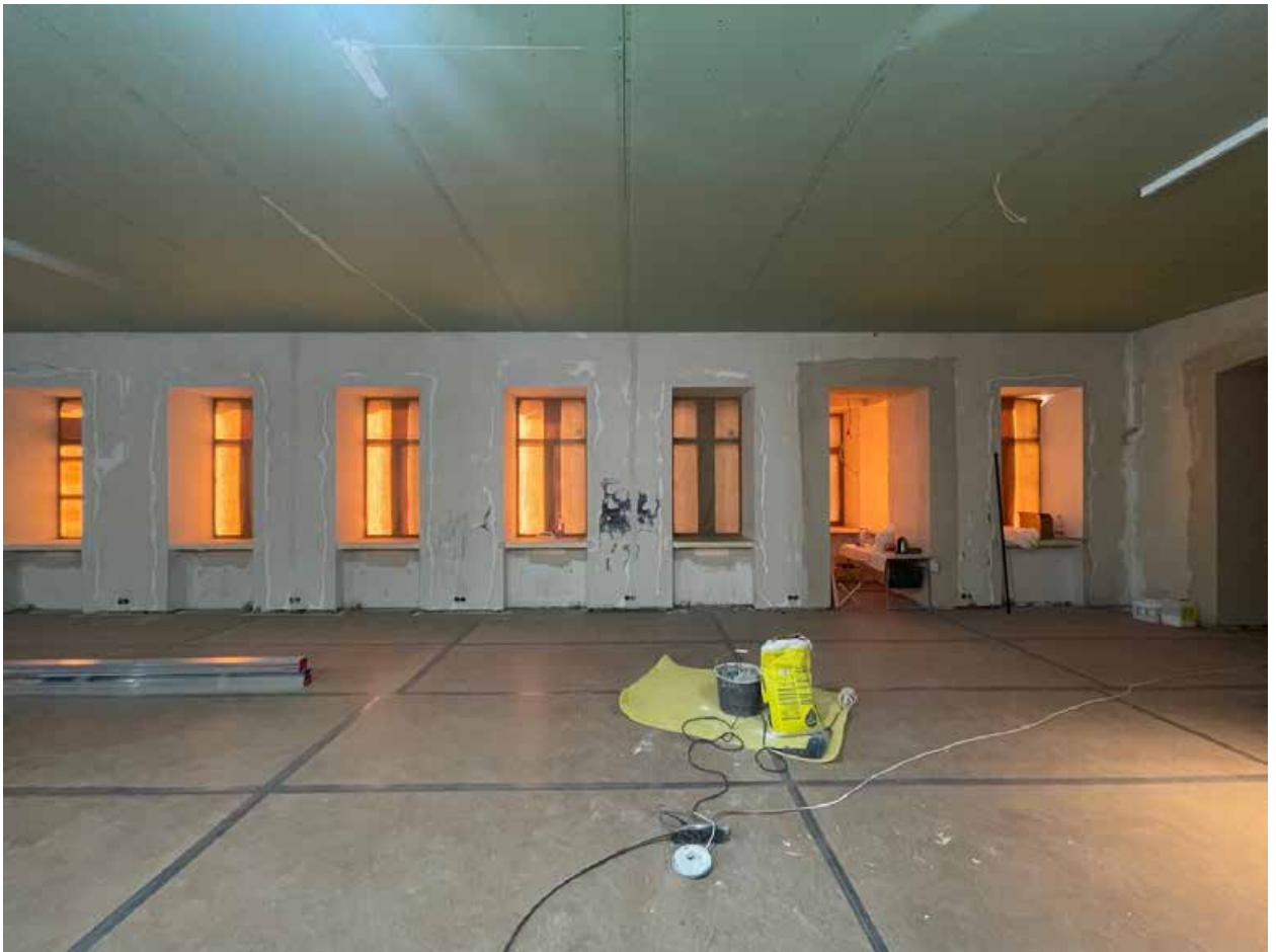
30. Помещение 11 (согласно техническому паспорту). 2 этаж.
