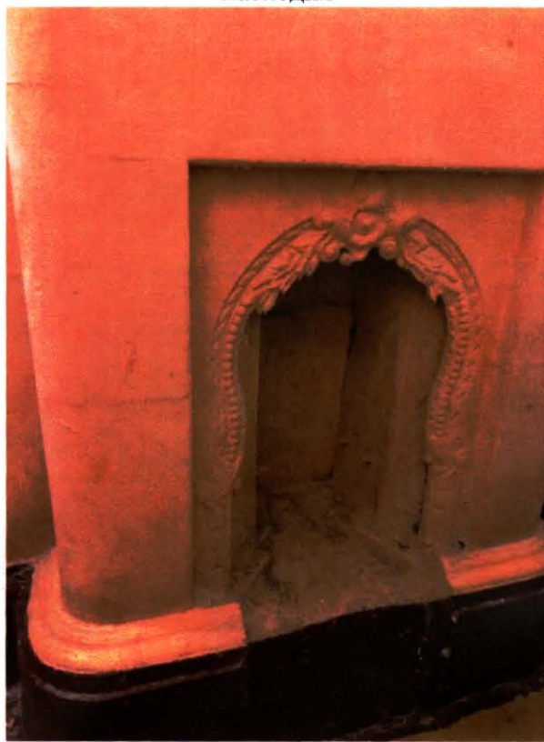
21. Помещение Л-5 объекта культурного наследия. Фото выполнено 22.03.2024.
