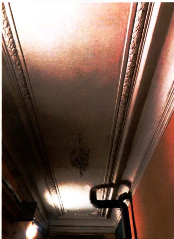
20. Помещение Л-5 объекта культурного наследия. Фото выполнено 22.03.2024.
