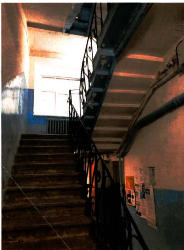
24. Помещение Л-7 объекта культурного наследия. Фото выполнено 22.03.2024.
