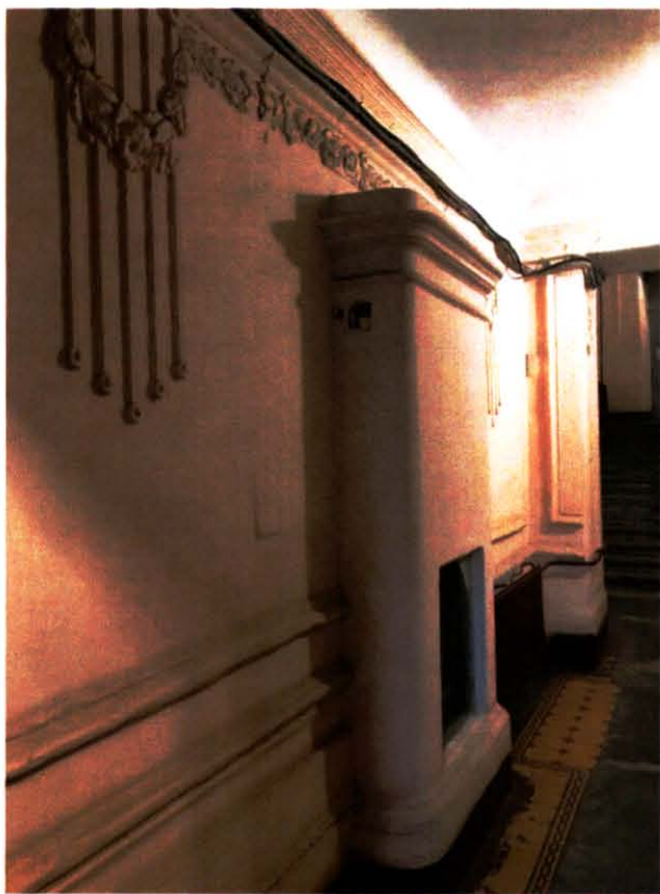
16. Помещение Л-1 объекта культурного наследия. Фото выполнено 22.03.2024.
