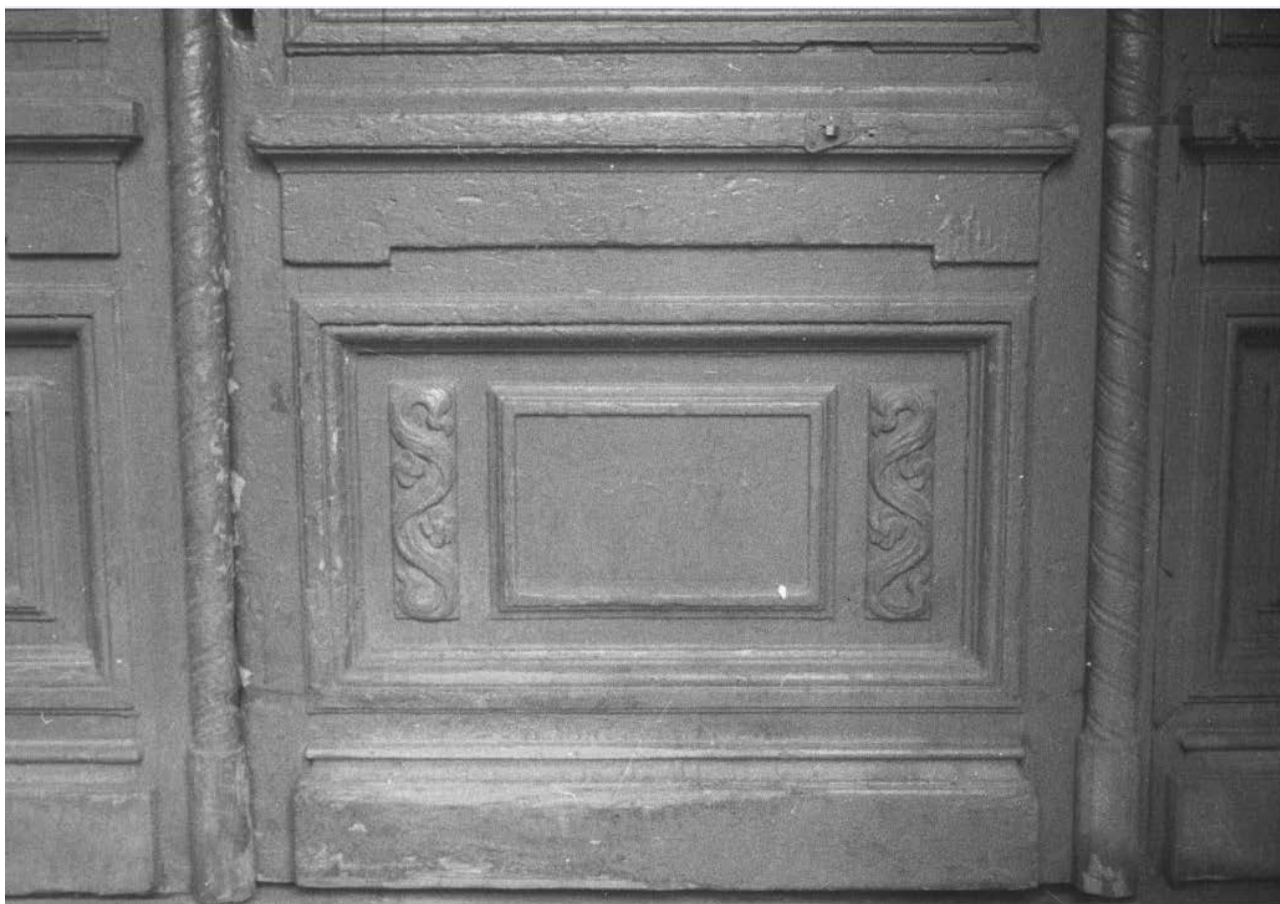
21. Лицевой фасад по Херсонской улице. Парадный вход. Фрагмент дверного полотна. (pastvu.com/1156338). Доходный дом М.П. Шадрина. Адрес дома: Херсонская улица, д. 1 / Бакунина проспект д. 7. Фото С.В. Доспехова 1998. https://www.citywalls.ru
