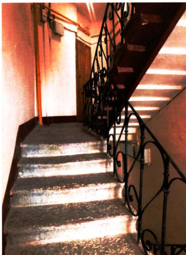
18. Помещение Л-4 объекта культурного наследия. Фото выполнено 22.03.2024.
