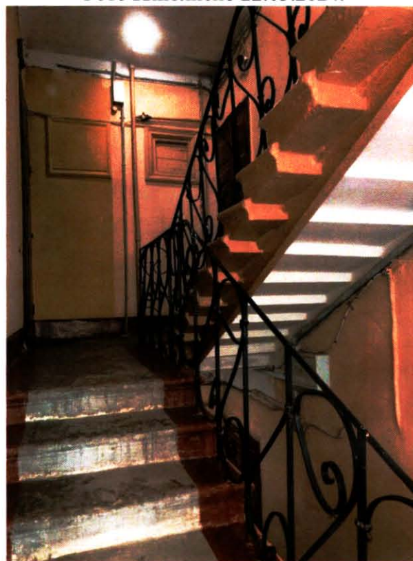
25. Помещение Л-8 объекта культурного наследия. Фото выполнено 22.03.2024.
