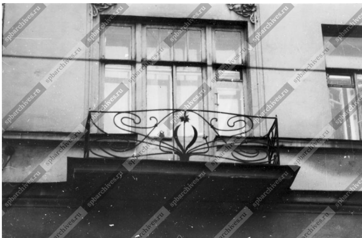
17. Доходный дом М.П. Шадрина. Адрес дома: Херсонская улица, д. 1 / Бакунина проспект д. 7. Вид балконных ограждений жилого дома № 1/7 на углу улицы Херсонской и проспекта Бакунина (бывший доходный дом М.П. Шадрина, архитектор Л.В. Богуский, 1905-1906) Дата съёмки: 25 октября 1987. Автор съёмки: Овчинников Кирилл Владимирович. Фото от 25 октября 1987 из ЦГАКФФД СПб
