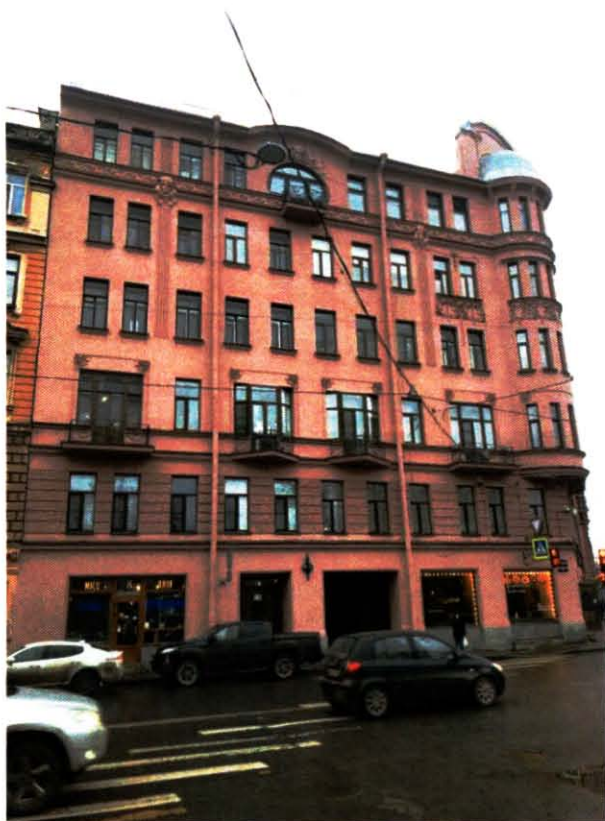
2. Северо-восточный фасад объекта культурного наследия. Фото выполнено 22.03.2024
