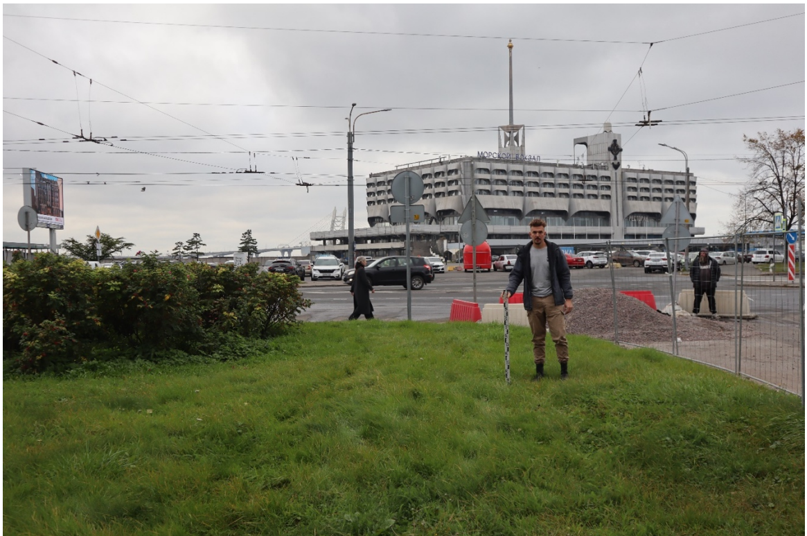
Рис. 45. Санкт-Петербург, Василеостровский р-н, Кировский р-н, Канализационный коллектор от Василеостровской насосной станции до подводящего коллектора ЦСА. Шурф 1-2. Общий вид до начала работ. Вид на запад.
