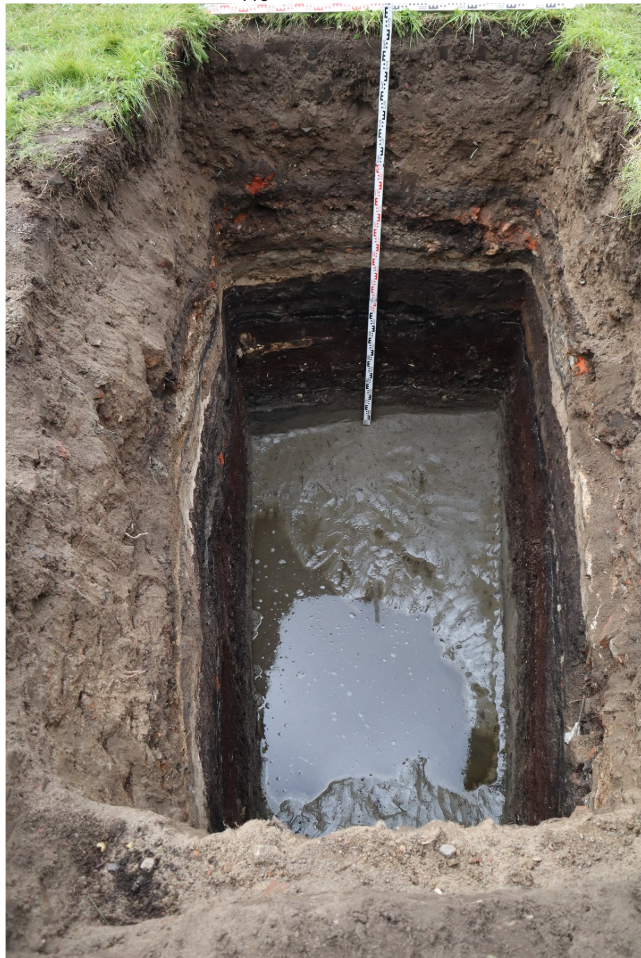
Рис. 48. Санкт-Петербург, Василеостровский р-н, Кировский р-н, Канализационный коллектор от Василеостровской насосной станции до подводящего коллектора ЦСА. Шурф 1-2. Фотофиксация по матерiku (светло-серая супесь). Вид на запад.
