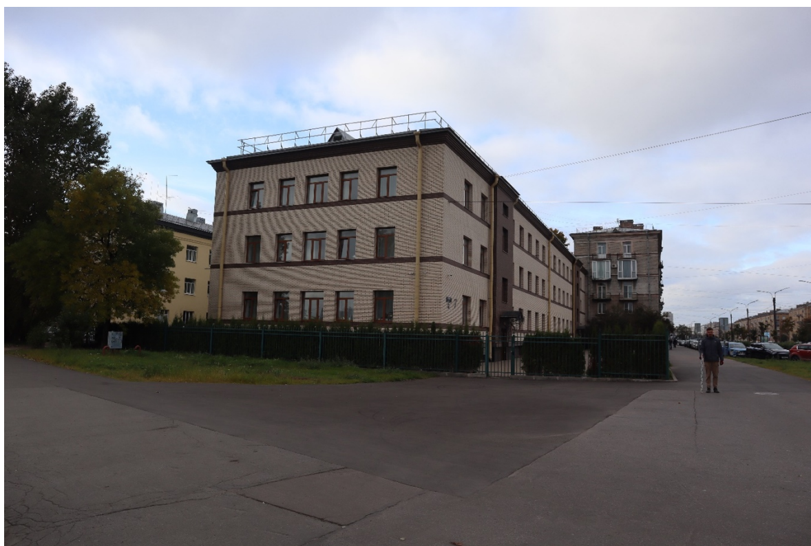
Рис. 43. Санкт-Петербург, Василеостровский р-н, Кировский р-н, Канализационный коллектор от Василеостровской насосной станции до подводящего коллектора ЦСА. Общий вид трассы обследования. Точка съемки 25. Вид на северо-запад.
