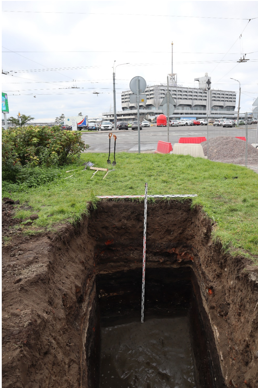
Рис. 53. Санкт-Петербург, Василеостровский р-н, Кировский р-н, Канализационный коллектор от Василеостровской насосной станции до подводящего коллектора ЦСА. Шурф 1-2. Фотофиксация общего вида шурфа с окружающим пейзажем после остановки работ. Вид на запад.
