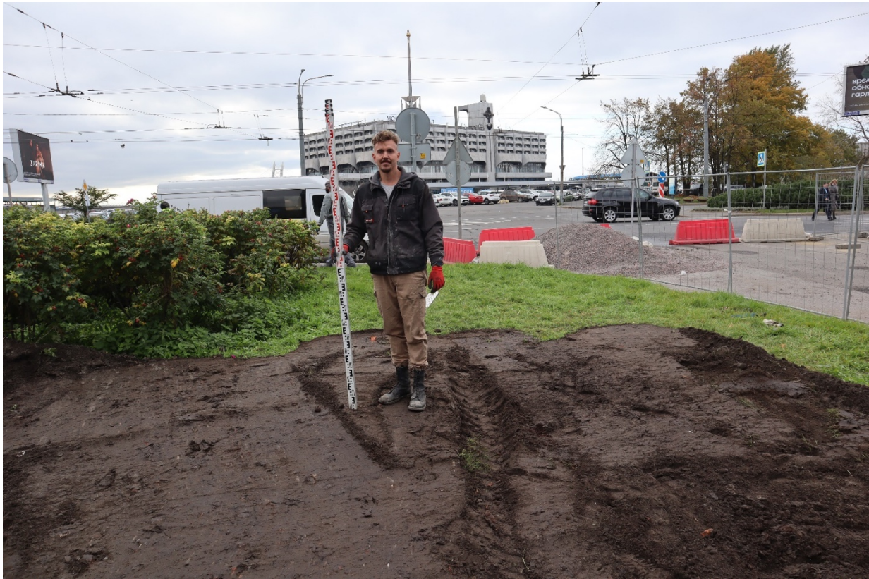
Рис. 54. Санкт-Петербург, Василеостровский р-н, Кировский р-н, Канализационный коллектор от Василеостровской насосной станции до подводящего коллектора ЦСА. Шурф 1-2. Фотофиксация после рекультивации вид на запад.
