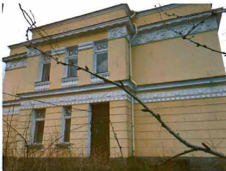
3. Северо-западный фасад здания.
