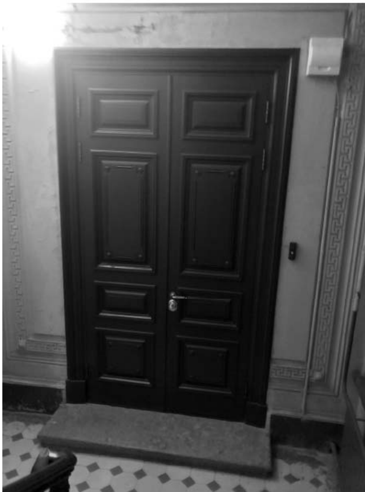
3. Входная дверь квартиры №14 со стороны лестницы 1ЛК.
