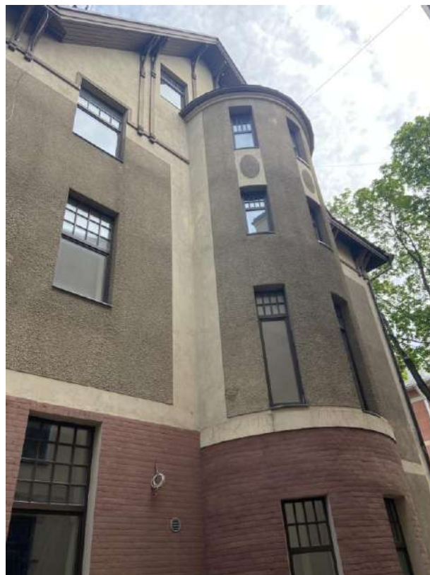
Фото 9. Вид на юго-западный фасад.
