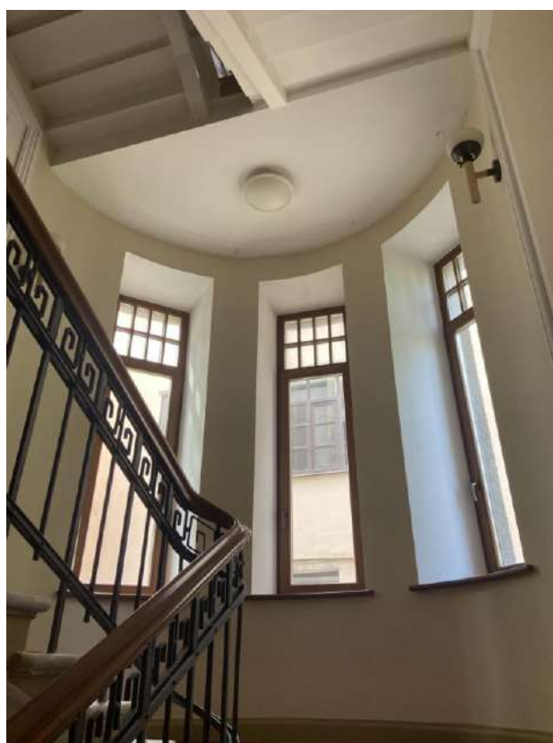
Фото 32. Междуэтажная лестничная площадка.
