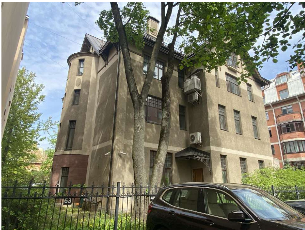
Фото 7. Вид на угол юго-восточного и юго-западного фасадов.
