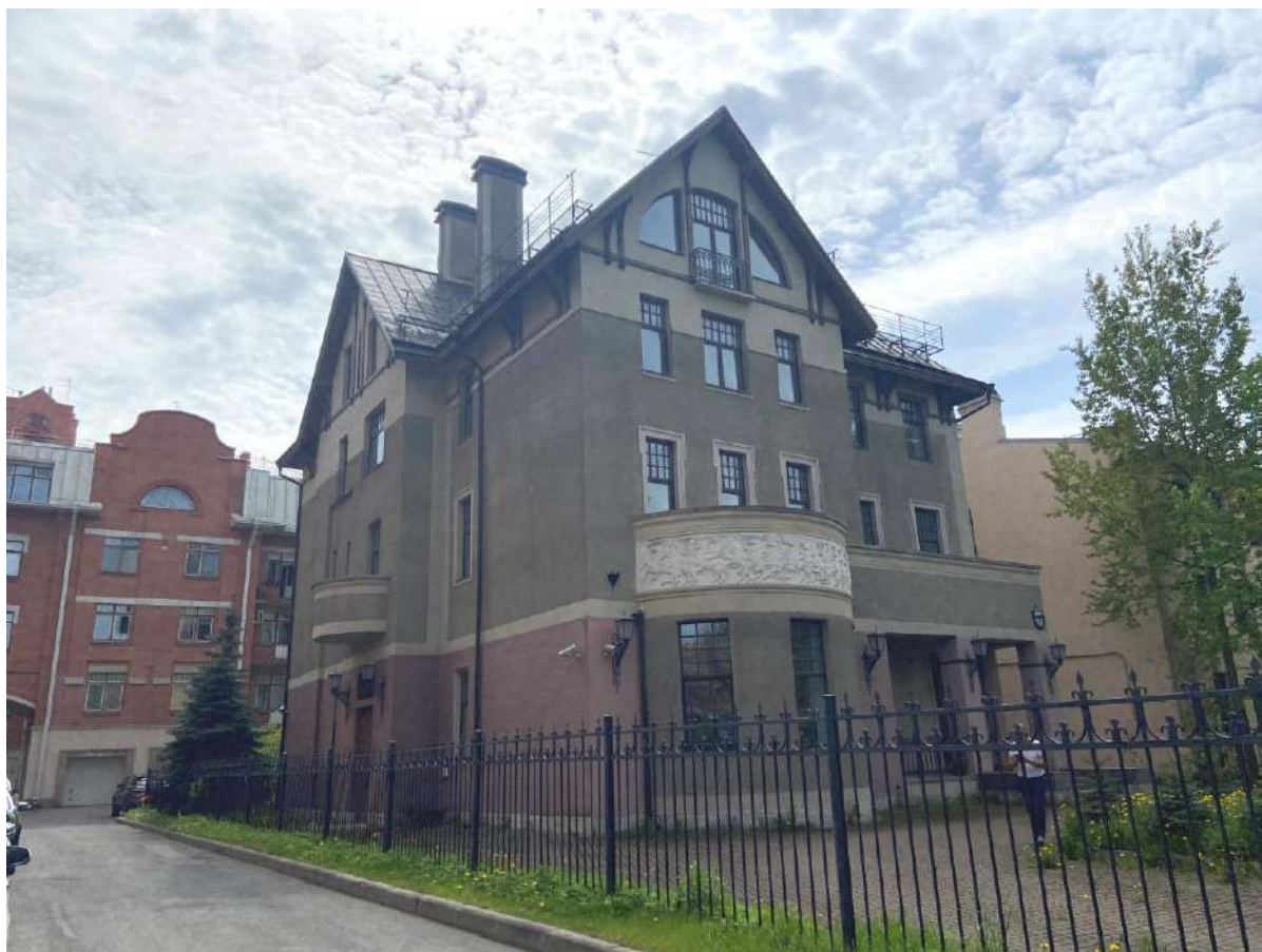
Фото 3. Вид на угол северо-западного и северо-восточного фасадов.
