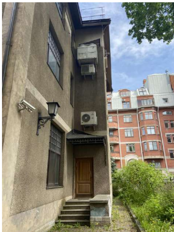
Фото 8. Ризалит и крыльцо юго-восточного фасада.
