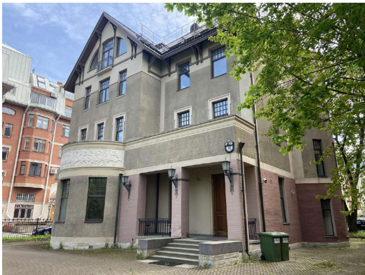
Фото 2. Вид на угол северо-западного и юго-западного фасадов.
