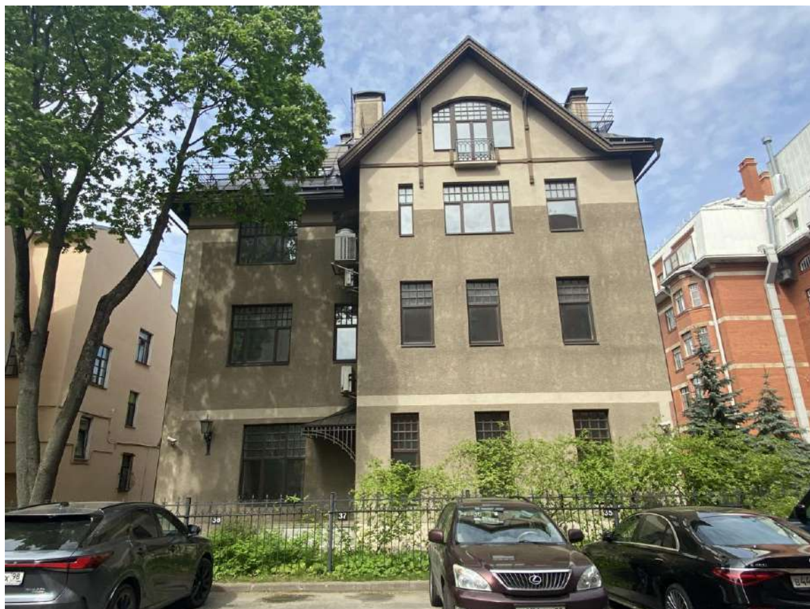
Фото 6. Вид на юго-восточный фасад.
