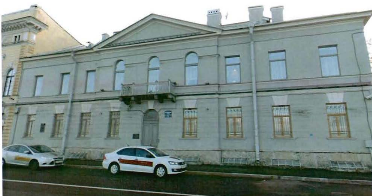
2. Фасад по Английской набережной
