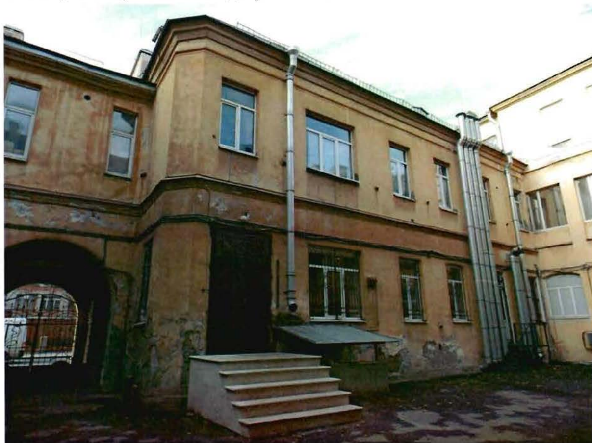
4. Западный дворовый фасад
