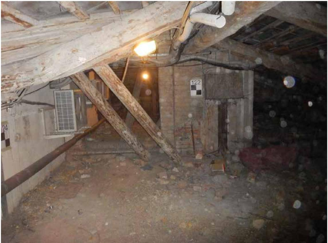
**Фото 19.** Устройство подкосов стропильной системы.
