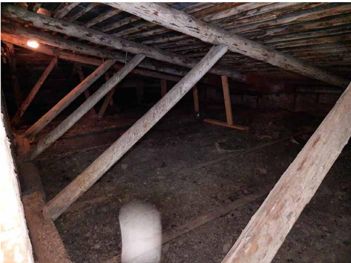
**Фото 14.** Общий вид стропильной системы крыши.
