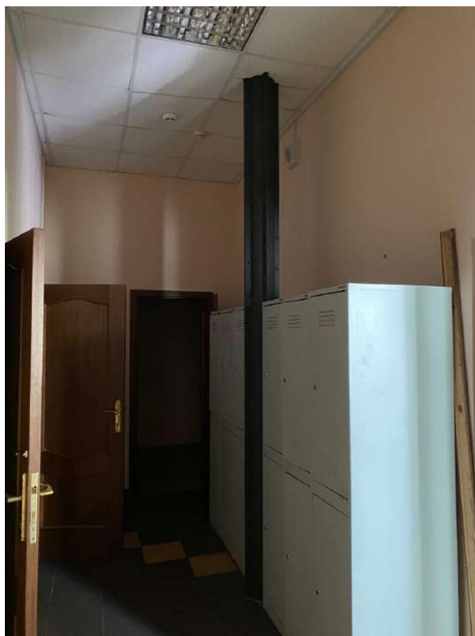
Фото №44. Историческая металлическая несущая колонна в одноэтажной пристройке спортивного зала.
