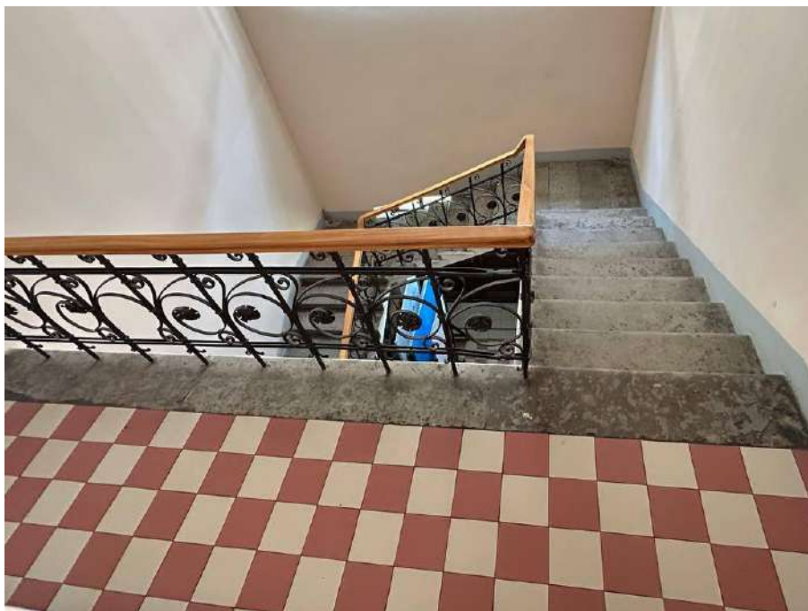
Фото №32. Квадратная лестница восточного корпуса, площадка второго этажа, ограждения отреставрированы.
