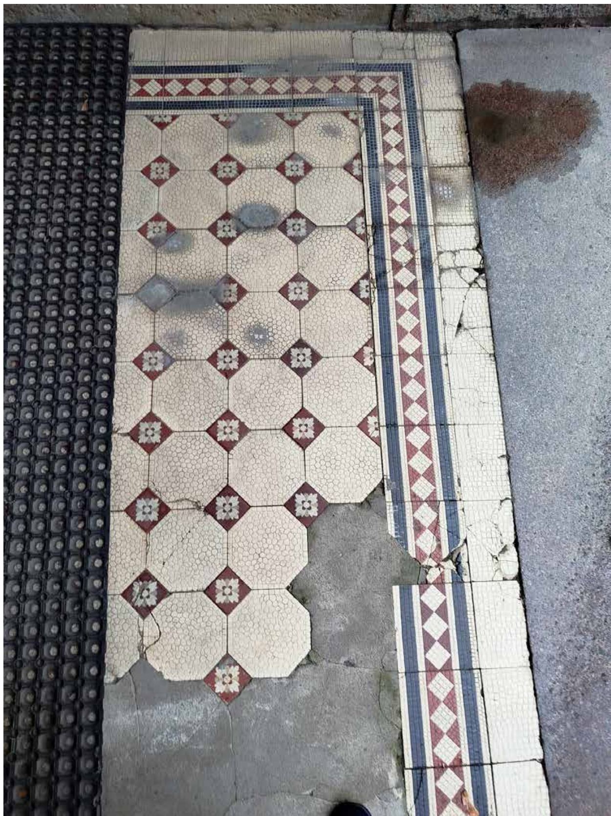
5. Покрытие пола метлахской плиткой перед входной группой в восточной части северного фасада.
