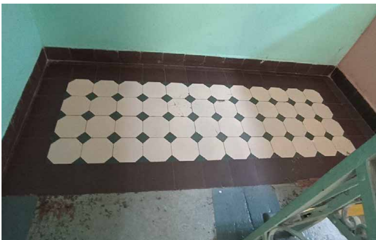
42. Покрытие пола метлахской плиткой лестничной клетки между цокольным и 1 этажами. Пом. 20.
