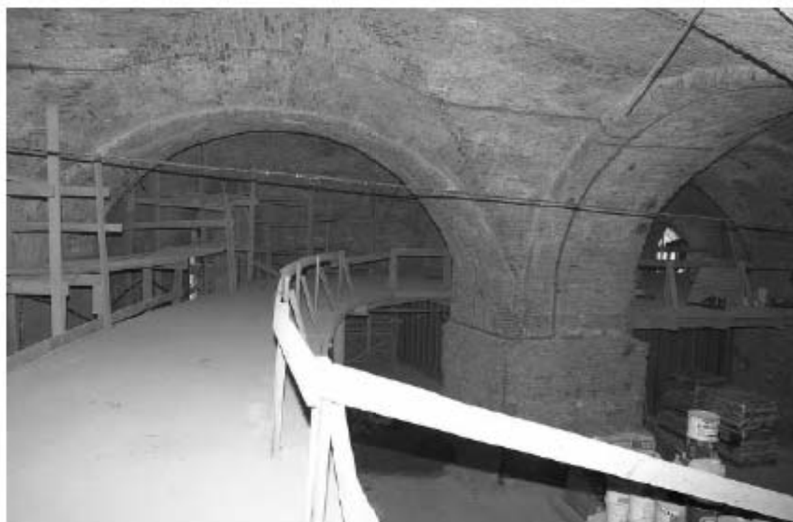
Илл. 56. Фотография 2010 г. Работы по устройству антресольного этажа в помещении Кавальера Анны Иоанновны. КГИОП.
