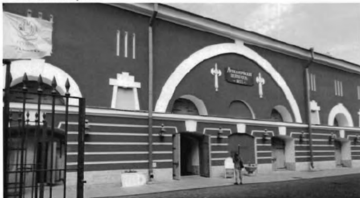
1. Вид на южный фасад.
