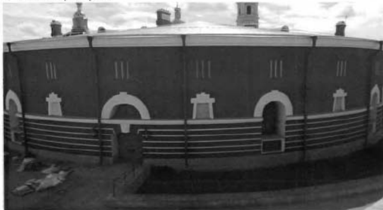
2. Вид на северный фасад.
