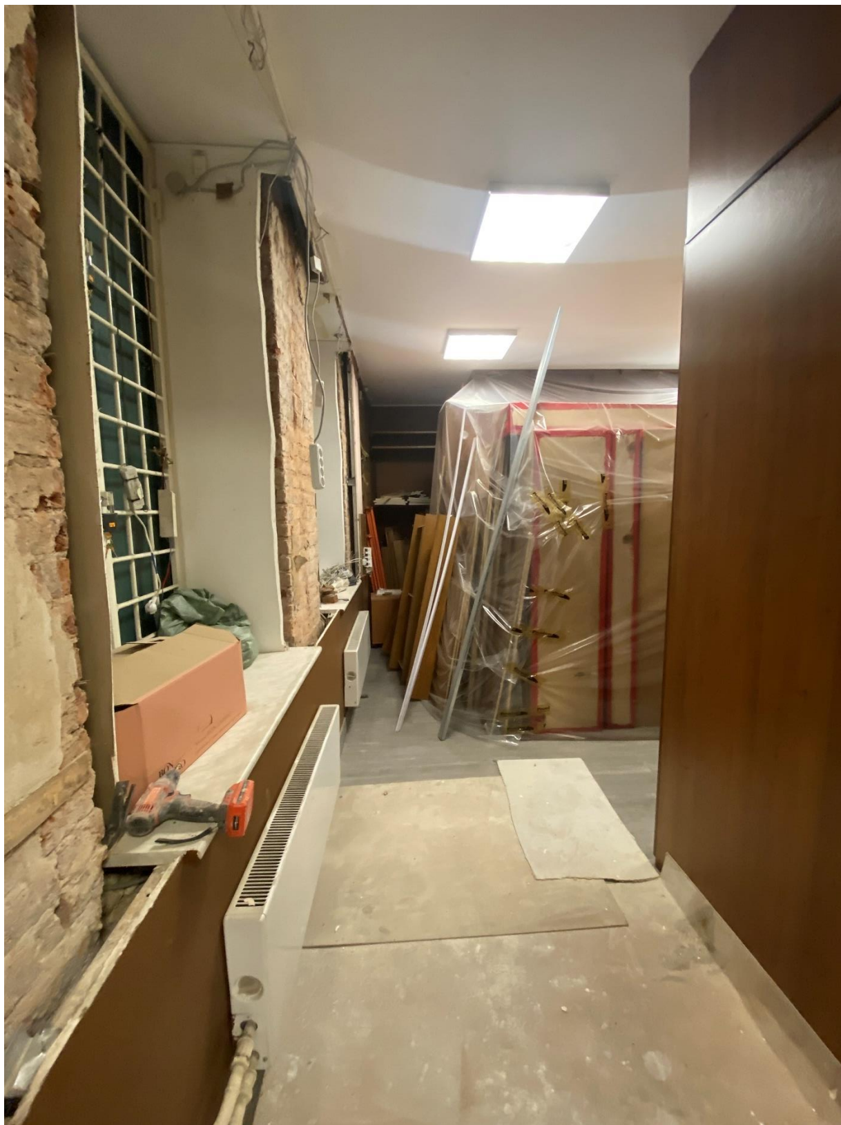
Фото 1. Вид на помещение № 1.
