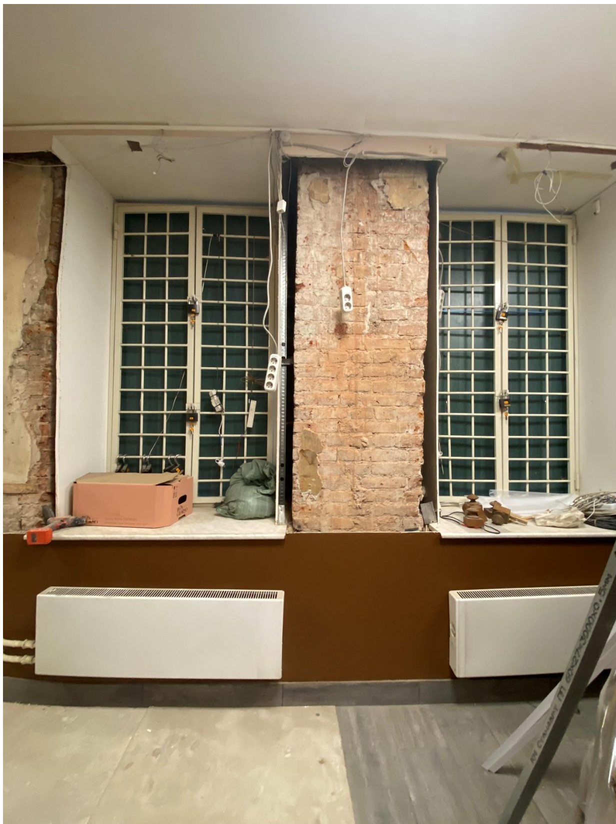
Фото 2. Вид на помещение № 1.
