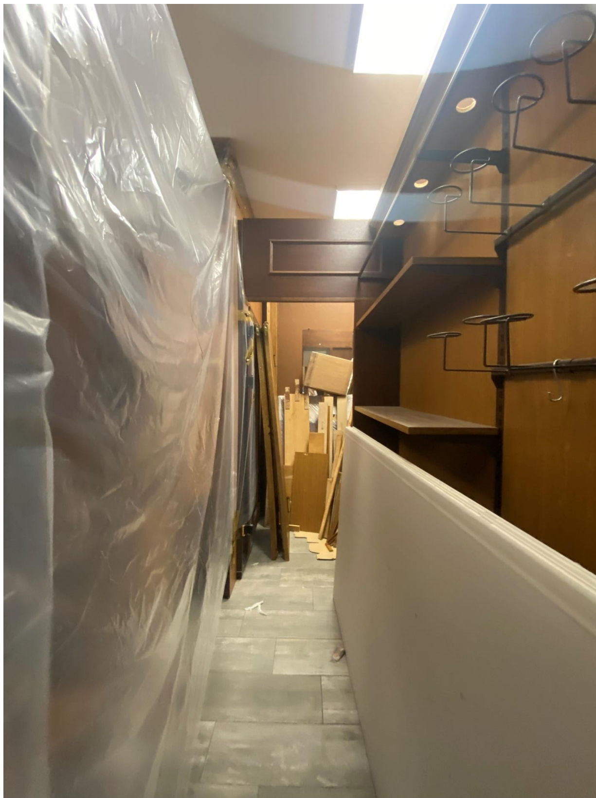
Фото 4. Вид на помещение № 1.
