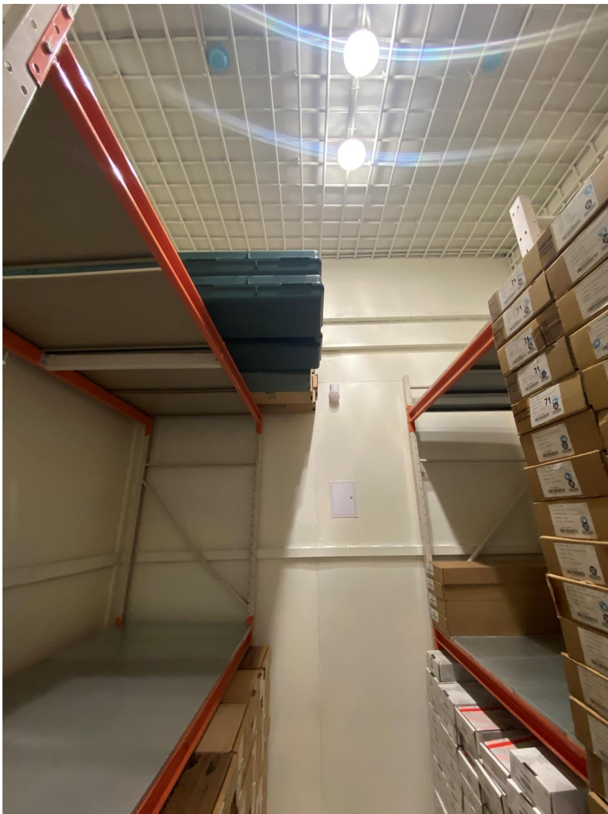
Фото 7. Вид на помещение № 6.
