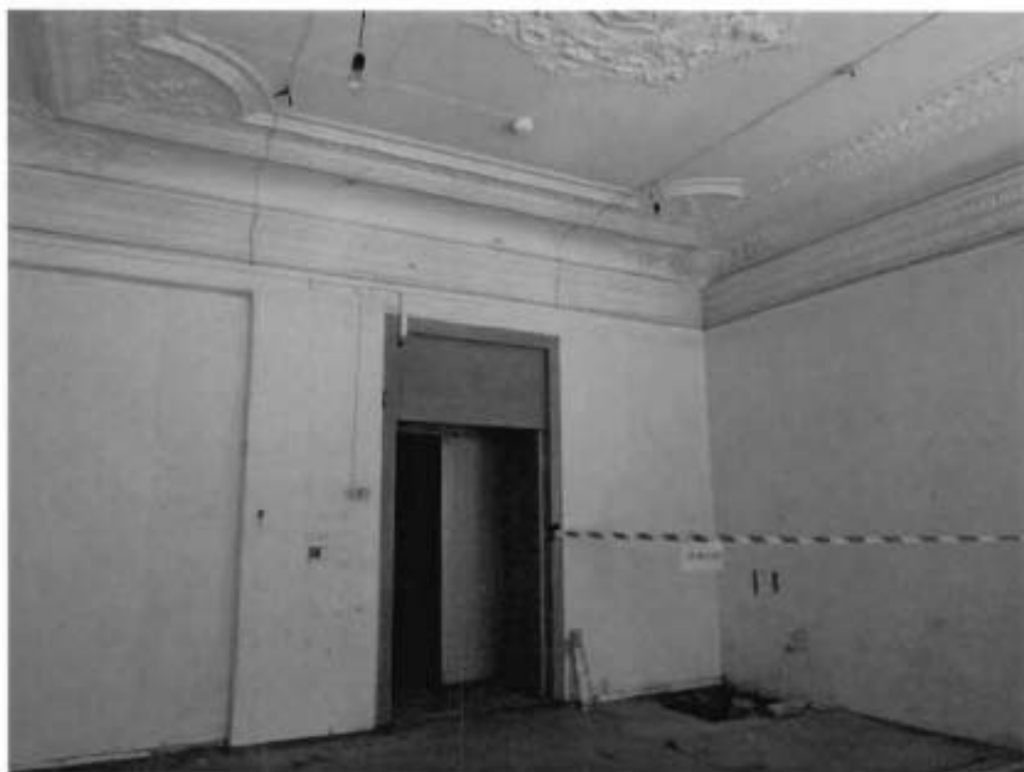
4. Помещение 1 этажа (13-Н(17)).
