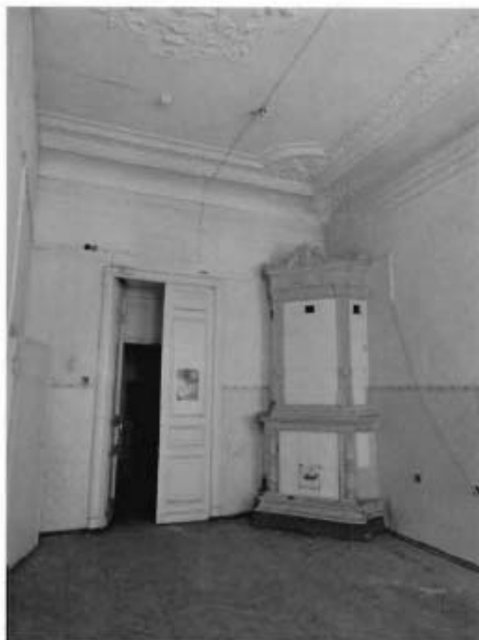
6. Помещение 2 этажа (18-Н(16)).
