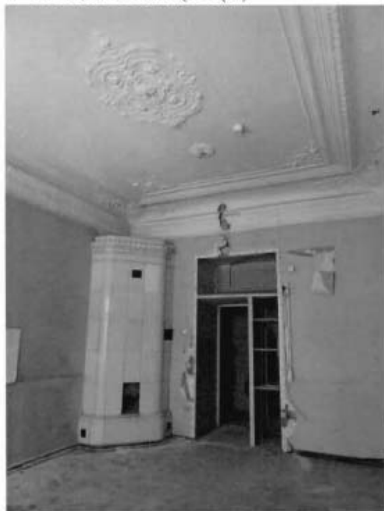
5. Помещение 1 этажа (14-Н(8)).
