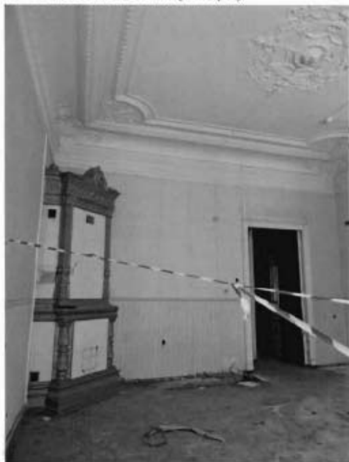
7. Помещение 2 этажа (19-Н(3)).
