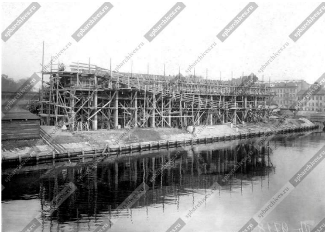
20. Фотография стадиона им. В. И. Ленина во время строительства. Вид со стороны юго-востока у Тучкова моста. Леса для строительства трибун. Автор фотографии неизвестен. Начало 1930-х. (Архивы Санкт-Петербурга: https://spbarchives.ru/ , дата обращения: 31.08.2022)
