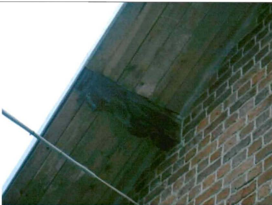
Деревянные кобылки. Съёмка 20.11.2012, Воронина Н.В.
