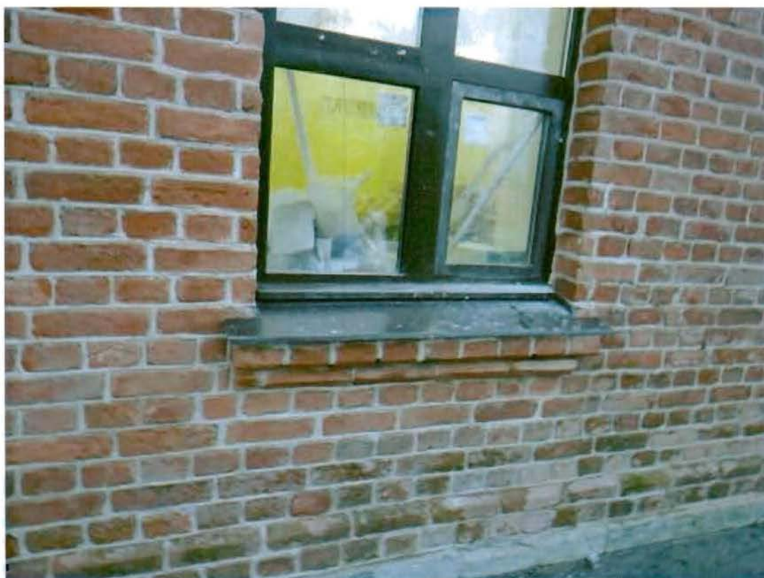
Ступенчатые подоконные доски. Съемка 20.11.2012, Воронина Н.В.
