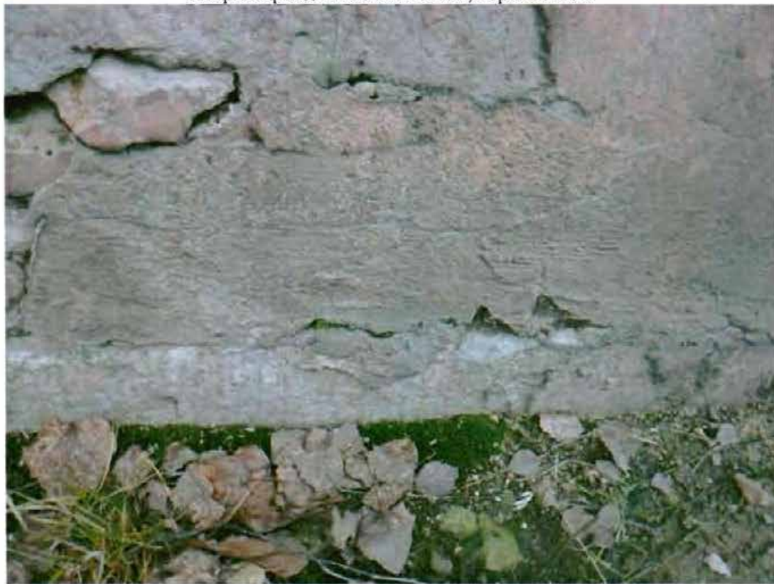
Цоколь, облицованный известняковой скобой. Съемка 27.11.2012, Воронина Н.В.
