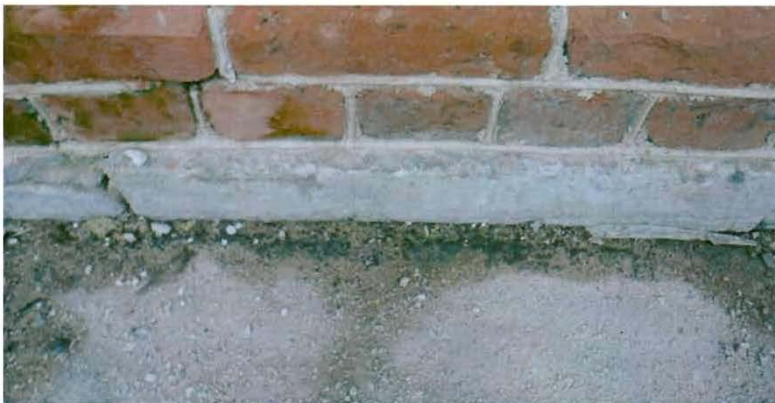
Цоколь, облицованный известняковой скобой. Съемка 20.11.2012, Воронина Н.В.
