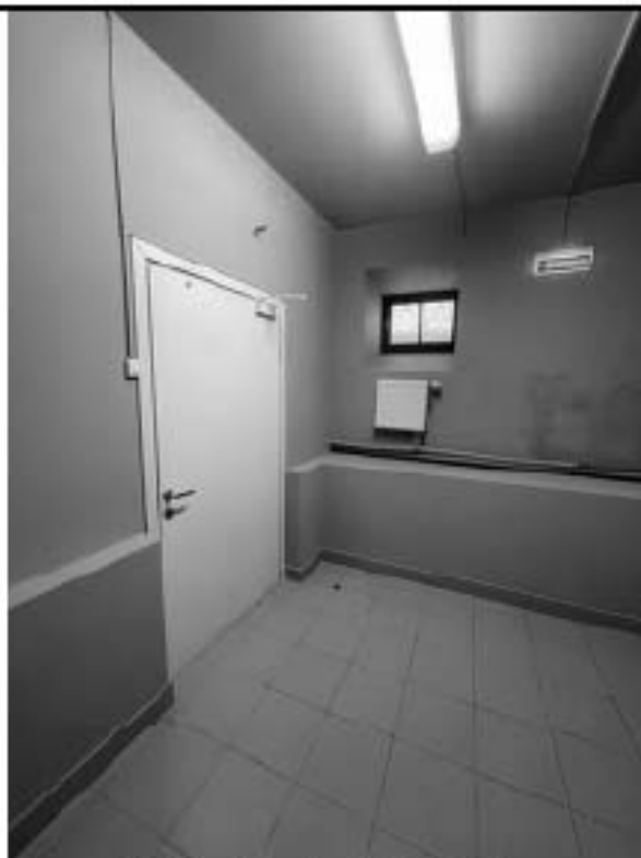
Фото 1.16 Коридор (ч.п.42). Вид в сторону Гардеробной (ч.п.41) и наружной стены
