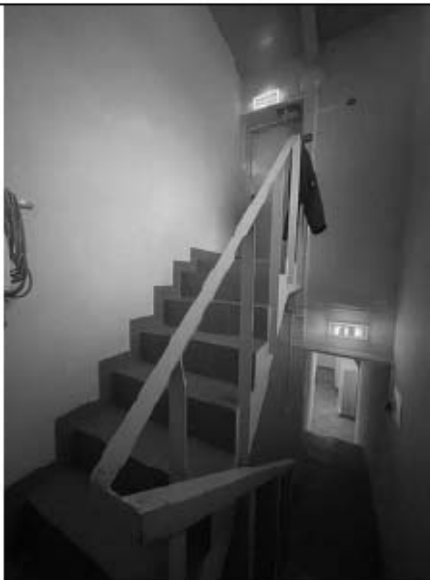
Фото 8.1 Лестница (ч.п.291). Выход на кровлю здания.
