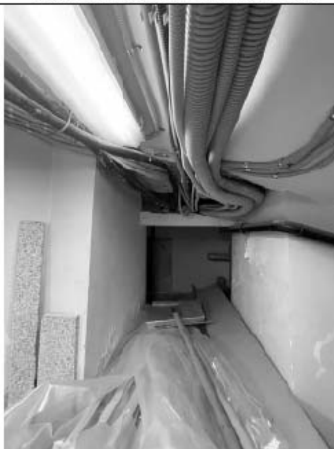
Фото 1.83 Техническое помещение (ч.п.5)
