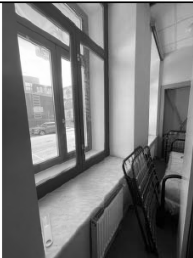
Фото 2.6 Коридор (ч.п.68). Вид в сторону наружной стены здания
