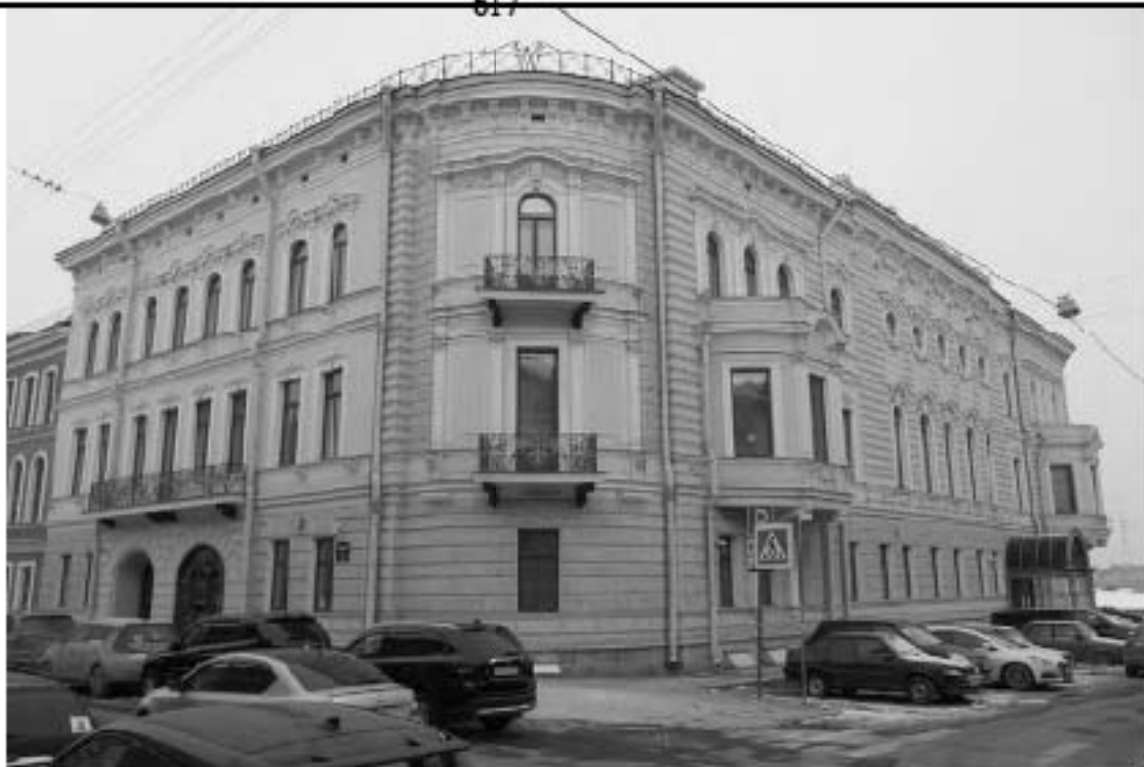
Фото 10.2 Общий вид лицевых фасадов здания с угла Шпалерной улицы и Кричевского переулка
