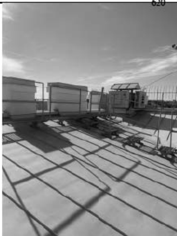
Фото 11.4 Фрагмент кровли здания
