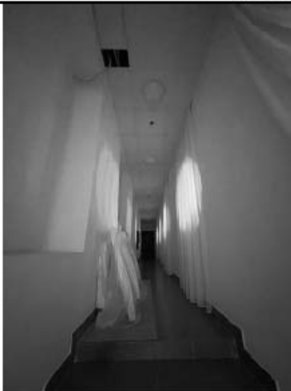
Фото 5.60 Коридор (ч.п.197) Вид в сторону Лестницы (ч.п.200)
