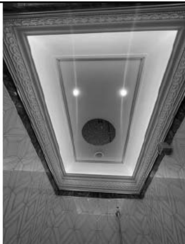
Фото 5.97 Душевая (ч.п.217). Вид потолка.
