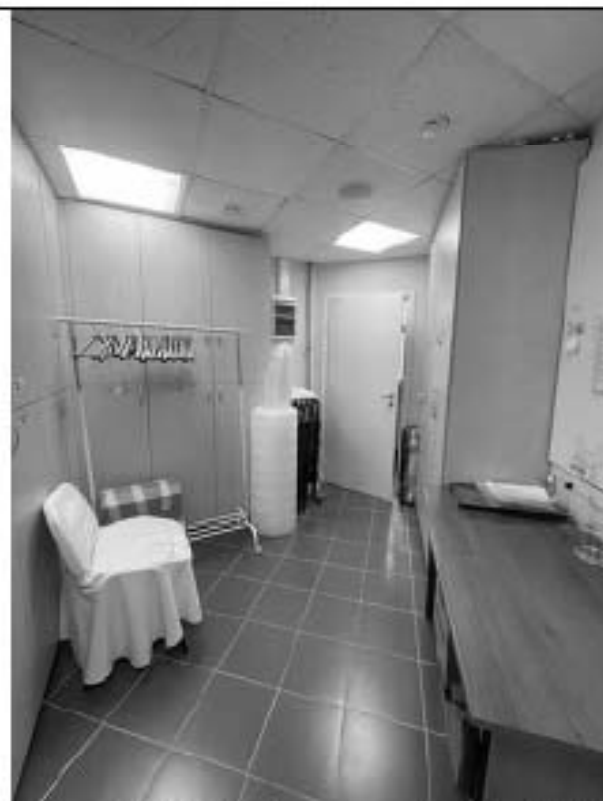
Фото 5.111 Подсобное помещение (ч.п.205) Вид в сторону Коридора (ч.п.204)
