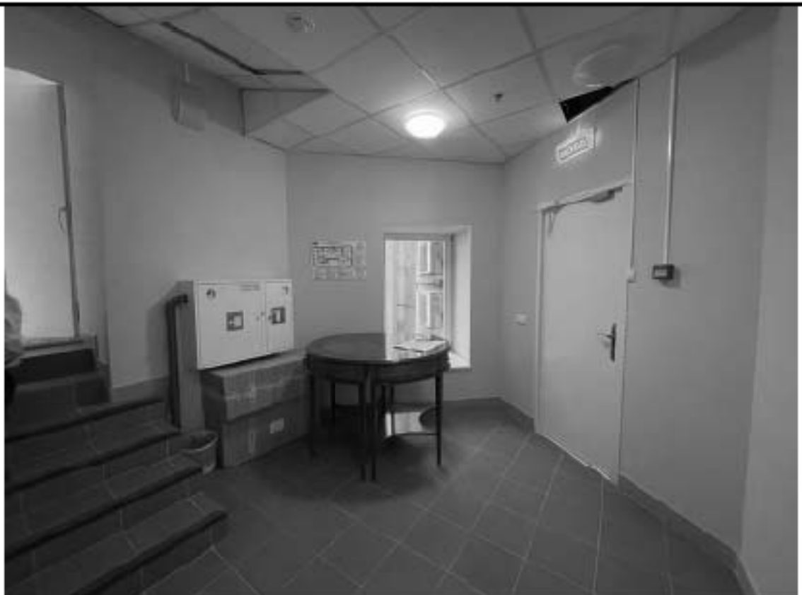
Фото 6.2 Коридор (ч.п.251). Вид в сторону наружной стены здания
