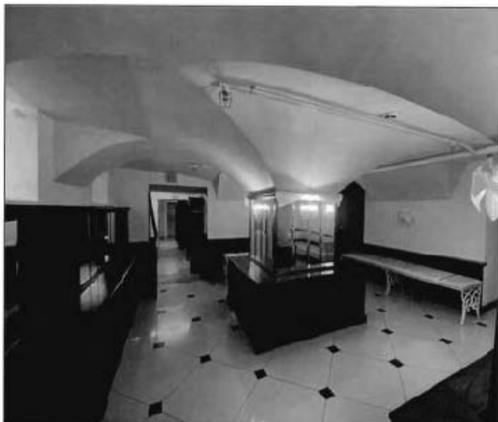
15. Сводчатые перекрытия помещений на столбах
