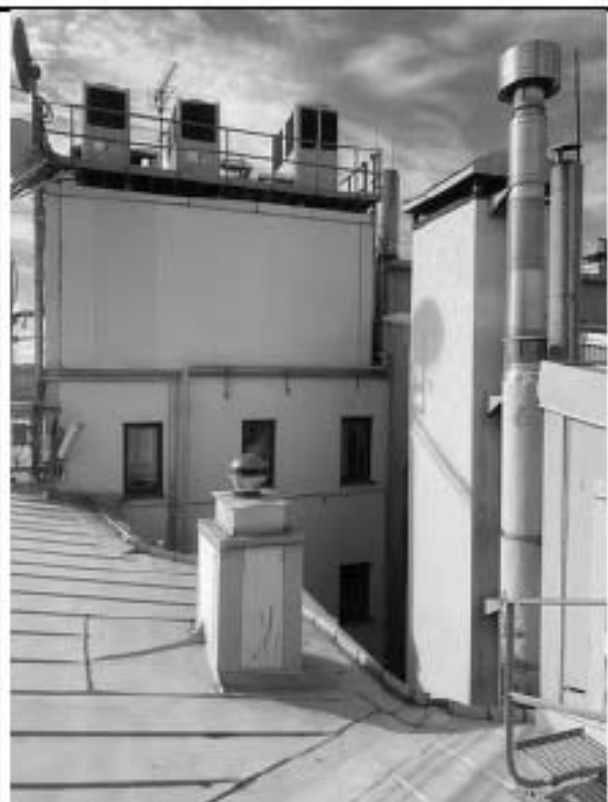
Фото 11.5 Фрагмент кровли здания
