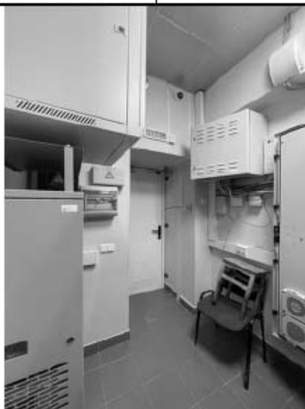
Фото 2.60 Подсобное помещение(ч.п.72). Вид в сторону Коридора (ч.п.69)
