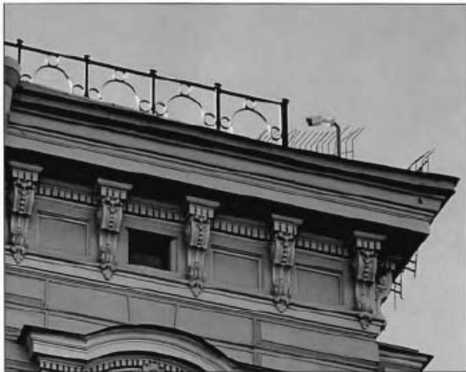
14. Карниз с выносом, декорированный филенками, на фигурных кронштейнах.
