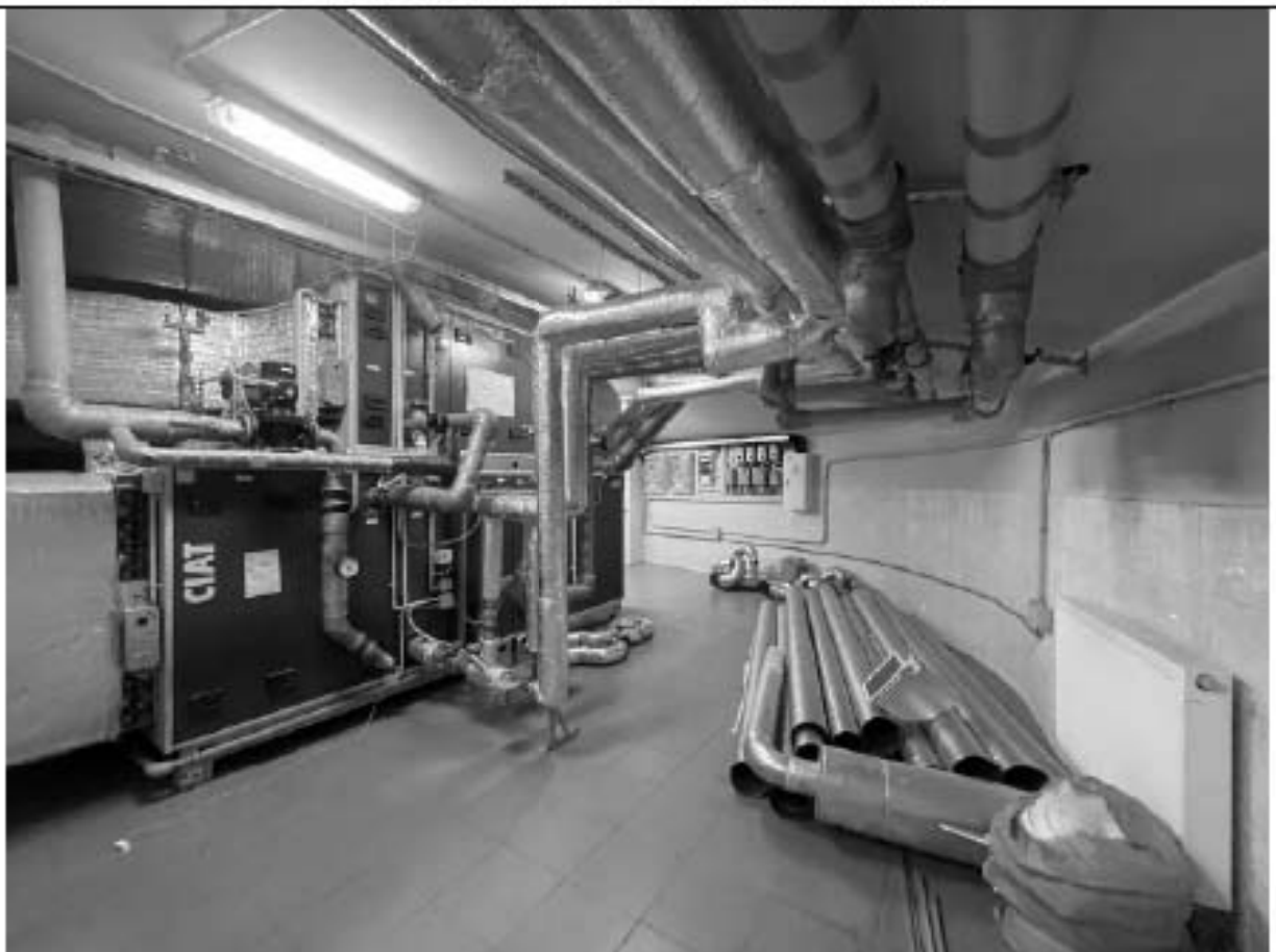
Фото 6.110 Техническое помещение (ч.п.246)
