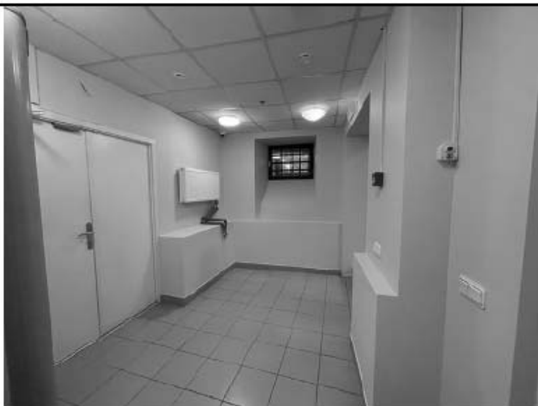
Фото 1.12 Коридор (ч.п.44) Вид в сторону наружной стены здания.
