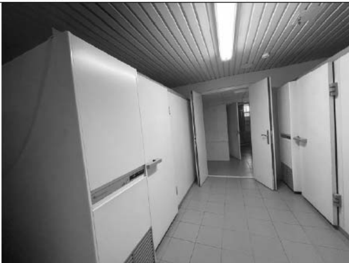
Фото 155 Помещение (ч.п.23). Вид в сторону коридора (ч.п.17)
