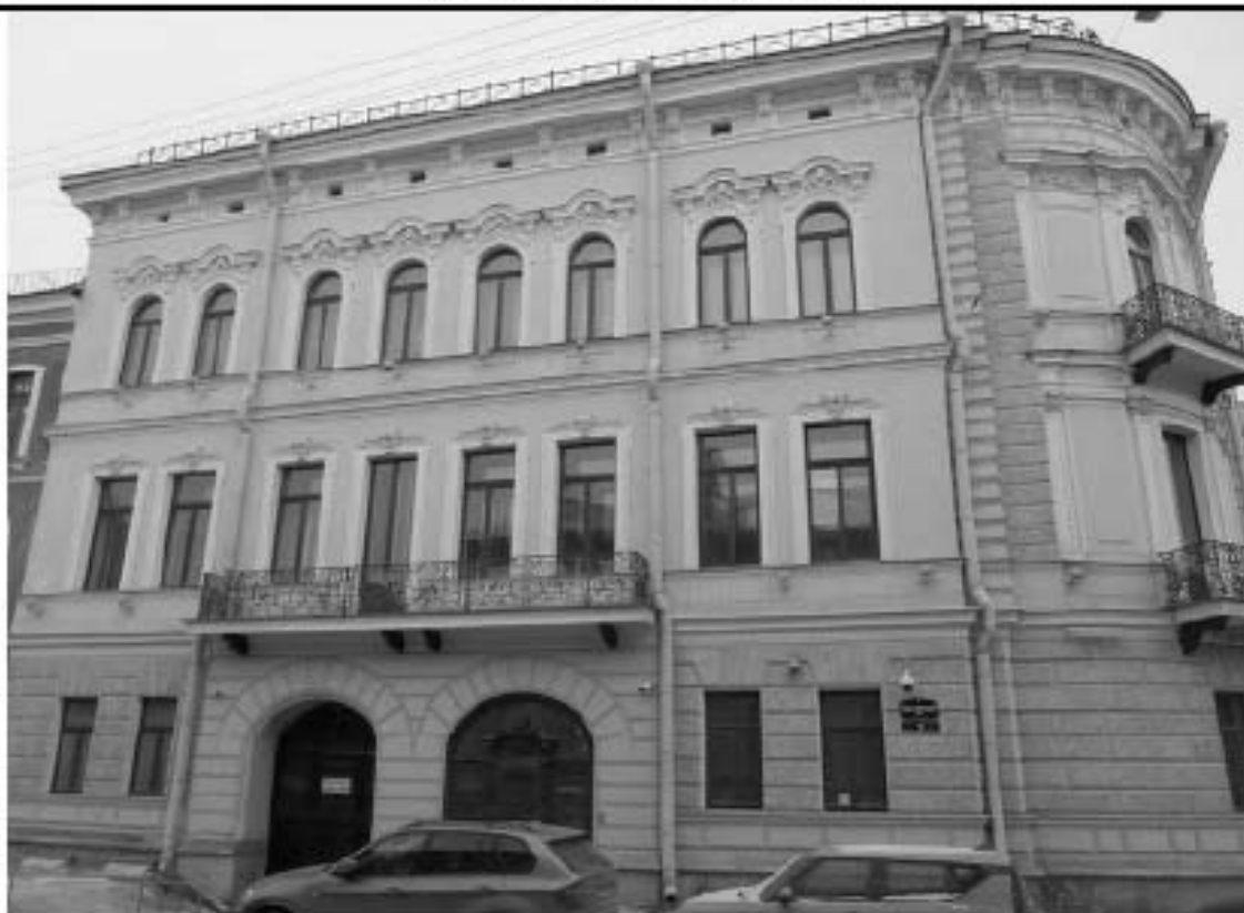
Фото 10.1 Общий вид лицевого фасада здания со стороны Шпалерной улицы
