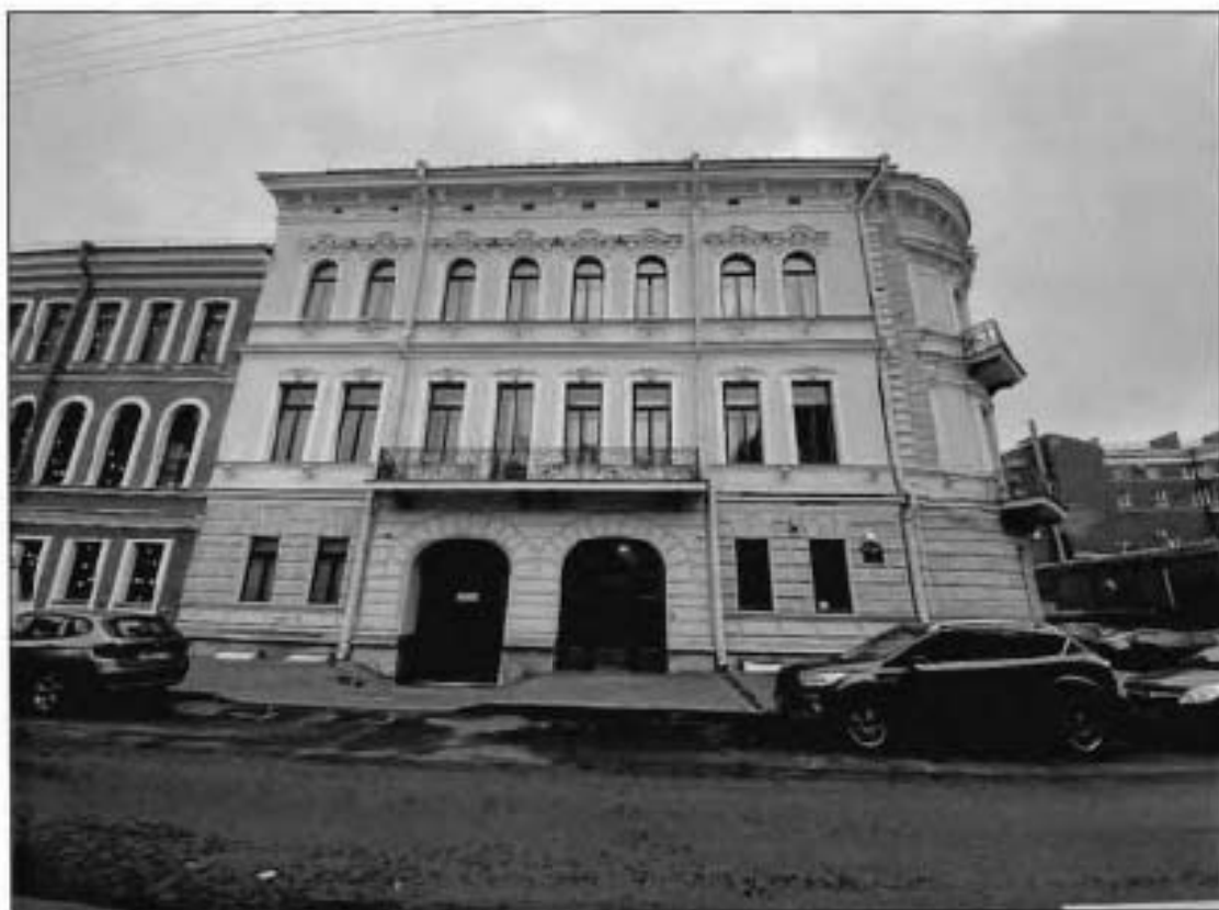
5. Южный фасад объекта культурного наследия.
