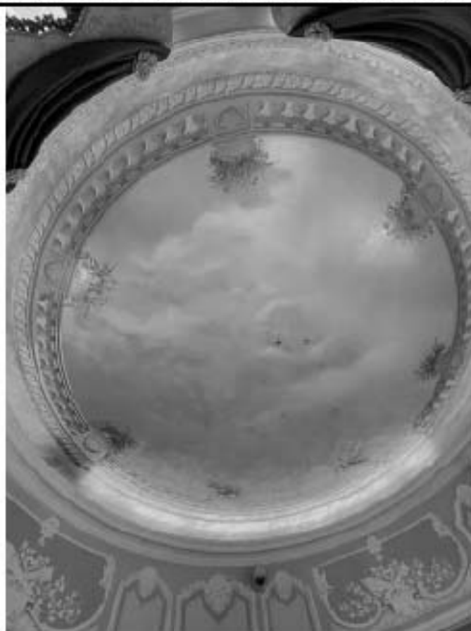
Фото 3.50 Зал (ч.п.126) Вид потолка.
