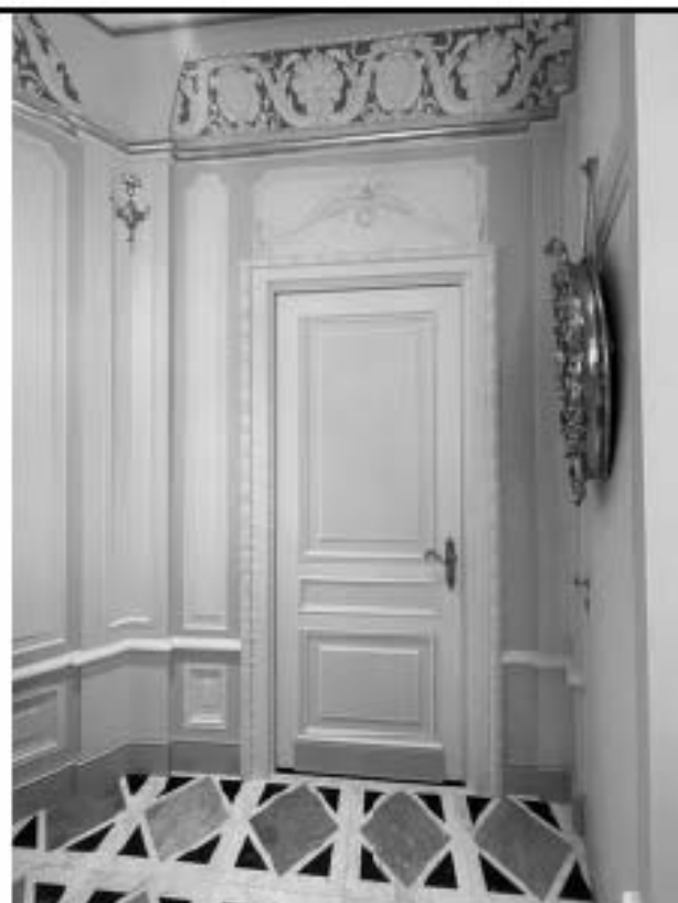
Фото 3.91 Туалет (ч.п.124) Вид дверного заполнения.
