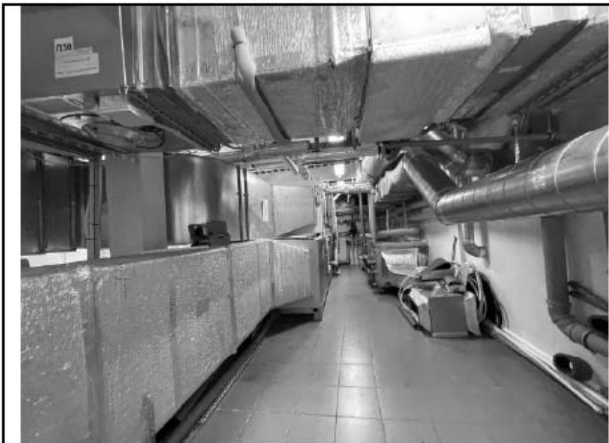
Фото 7.8 Техническое помещение (ч.п.289)
