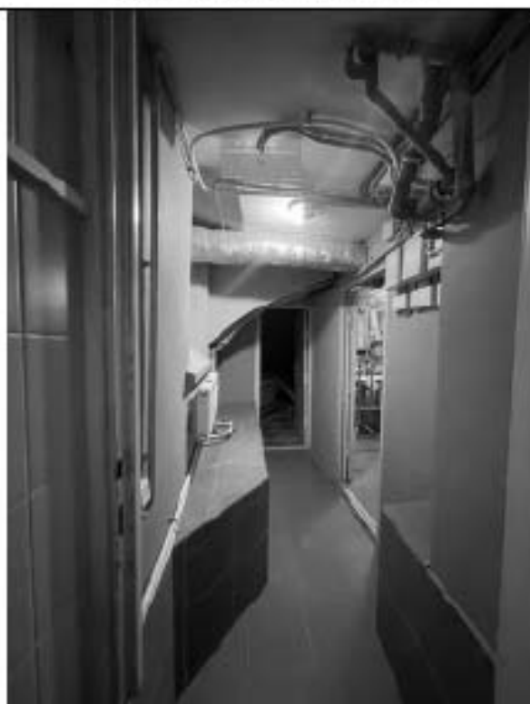
Фото 1.79 Помещение (ч.п.1). Вид в сторону Коридора (ч.п.3)
