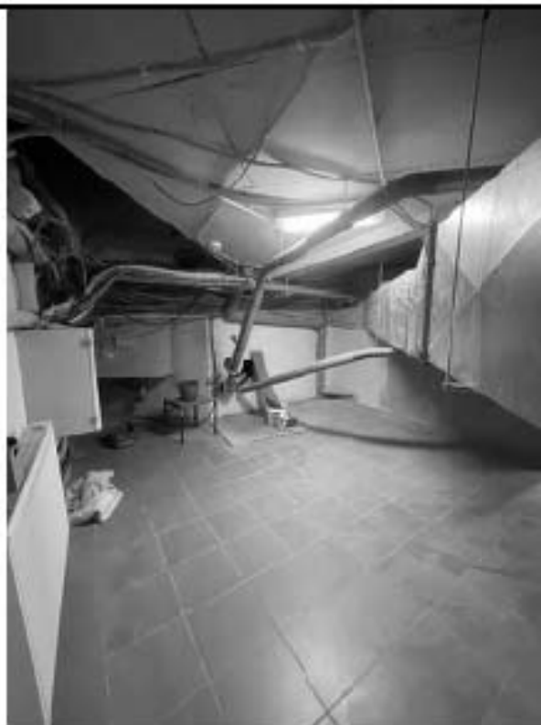
Фото 6.105 Техническое помещение (ч.п.246)
