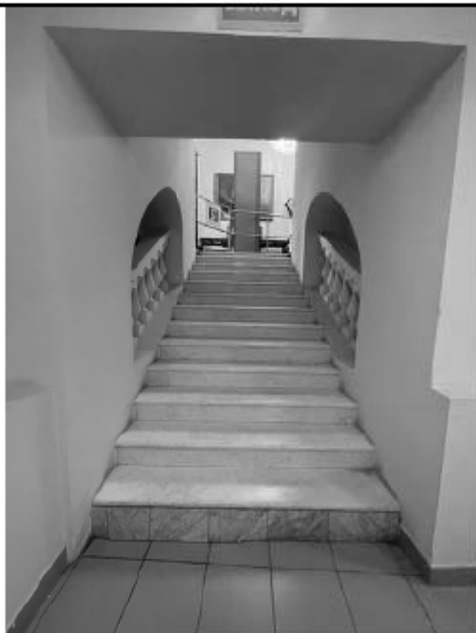
Фото 1.5 Коридор (ч.п.44) Вид лестницы в уровень помещений 1 этажа
