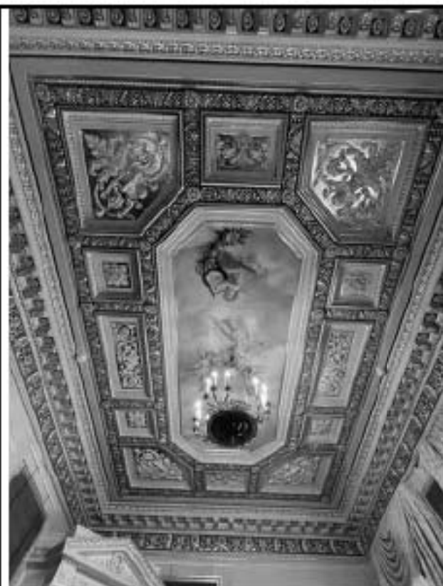
Фото 3.35 Зал (ч.п.121) Вид потолка.
