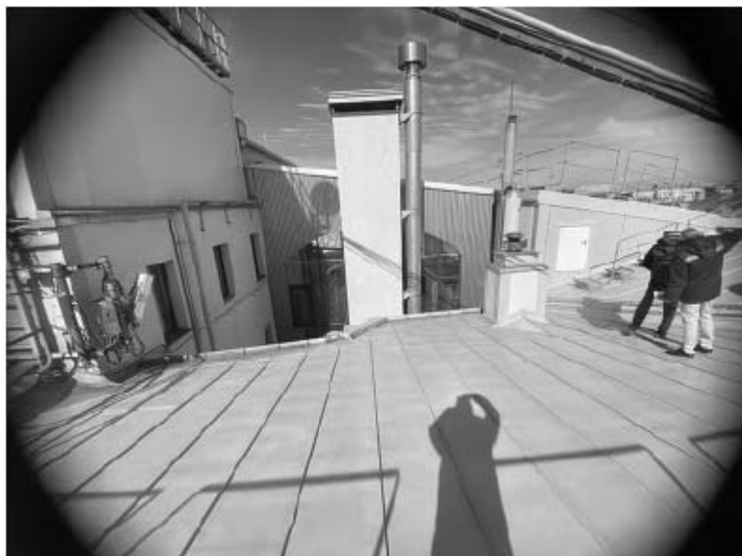
Фото 11.6 Фрагмент кровли здания
