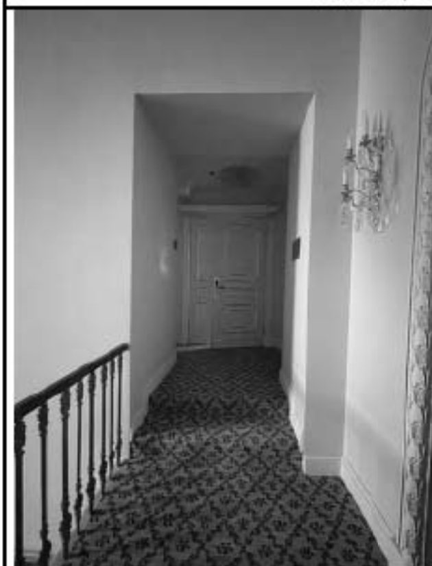
Фото 5.68 Лестница (ч.п.211). Вид в сторону Коридора (ч.п.206)
