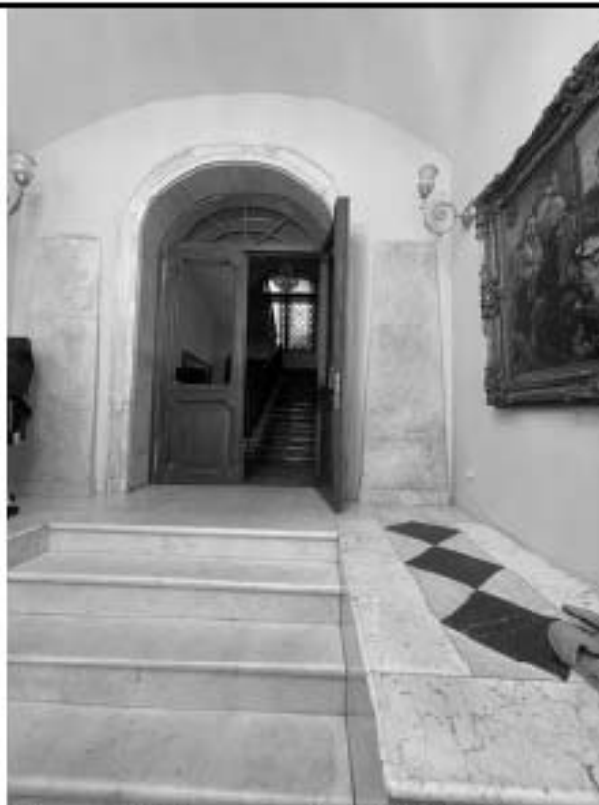
Фото 2.16 Лестница (ч.п.55) Вид в сторону Лестницы (ч.п.56)
