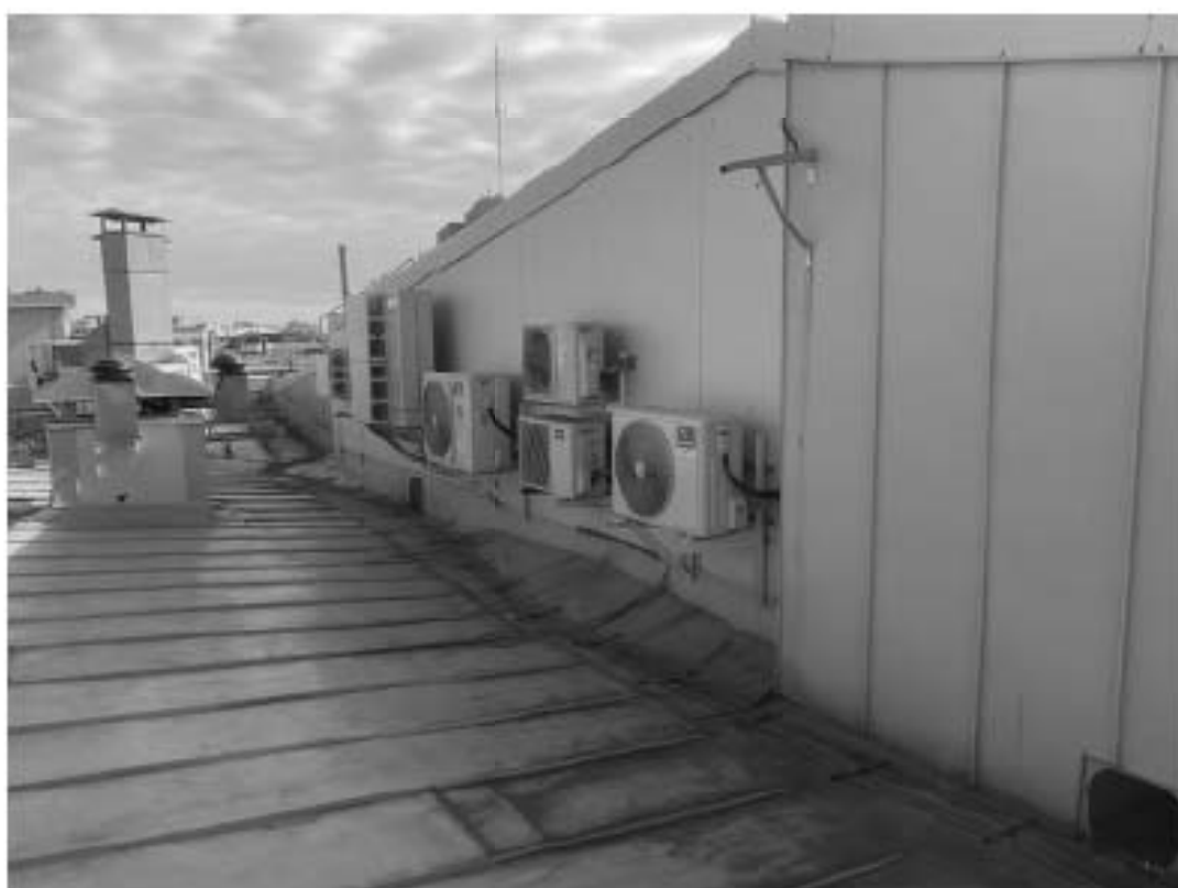
Фото 11.3 Фрагмент кровли здания
