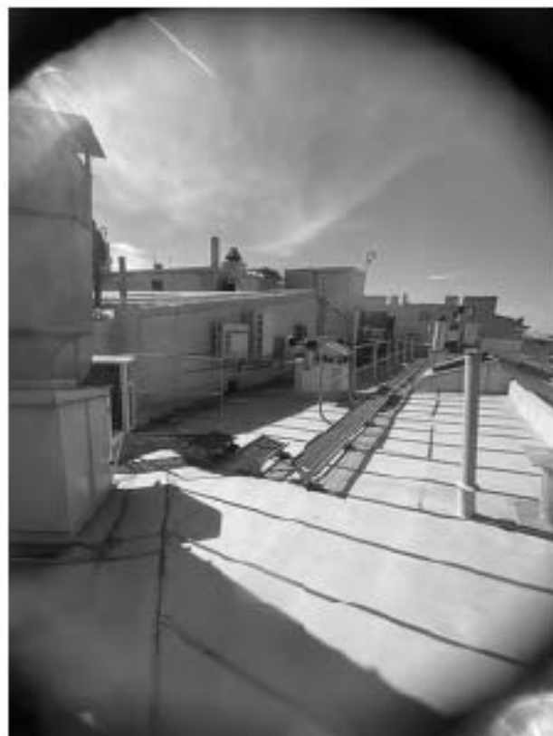
Фото 11.2 Фрагмент кровли здания
