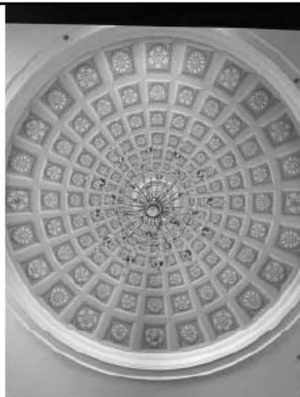
Фото 5.46 Зал (ч.п.190). Вид потолка.
