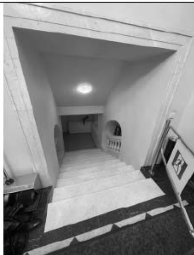
Фото 2.39 Лестница (ч.п.55). Вид в сторону лестницы в уровень подвала
