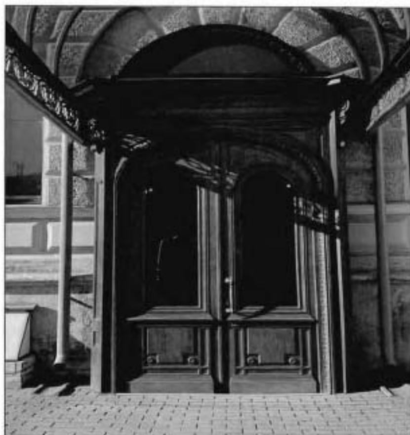
7. Деревянное дубовое заполнение парадного входа с переулка Кричевского.
