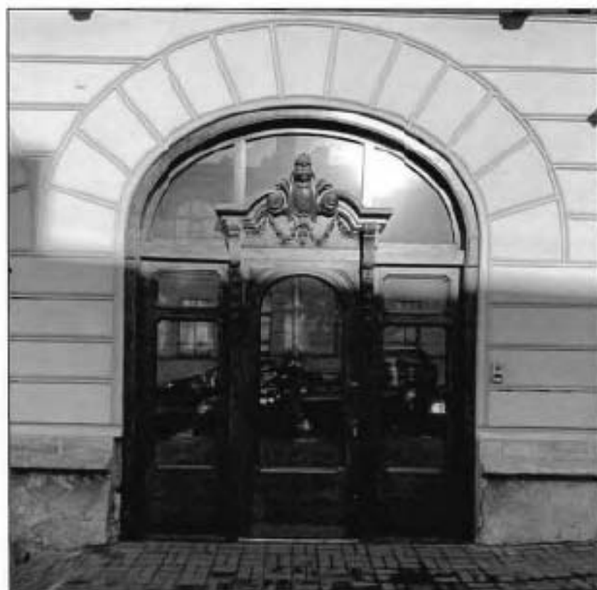
8. Деревянное заполнение входа со стороны Шпалерной улицы.
