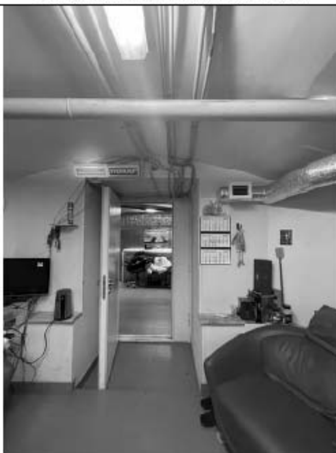
Фото 151 Мастерская (ч.п.24). Вид в сторону Технического помещения (ч.п.26)
