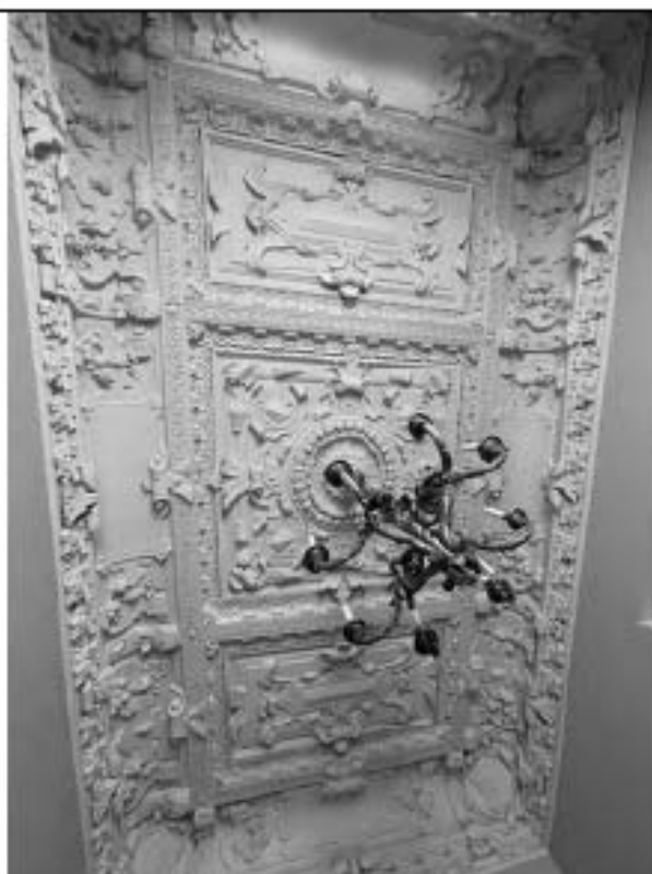
Фото 3.58 Коридор (ч.п.136) Вид потолка
