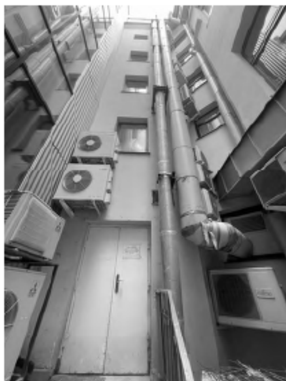
Фото 9.2 Вид дворового юго-западного фасада здания
