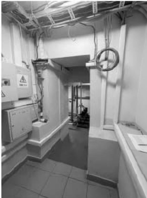
Фото 1.1 Тамбур (ч.п.45). Вид в сторону Водомерного узла (ч.п.46)
