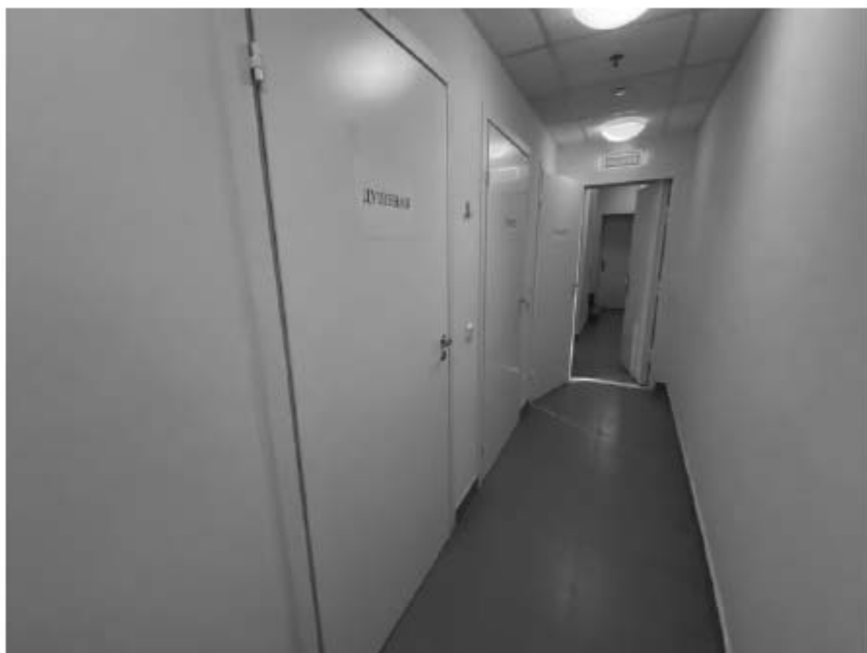
Фото 32. ОКН РЗ «Особняк Шереметьева» (СПб, Шпалерная ул., д.18, лит. А). Антресоль 2 этажа. Помещение 1-Н(157).
