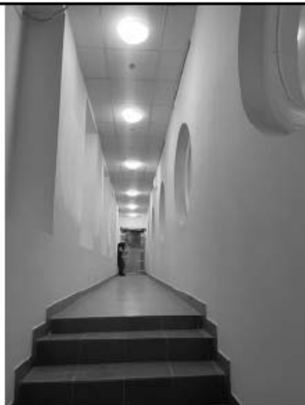
Фото 5.112 Коридор (ч.п.197) Вид в сторону Лестницы (ч.п.196)
