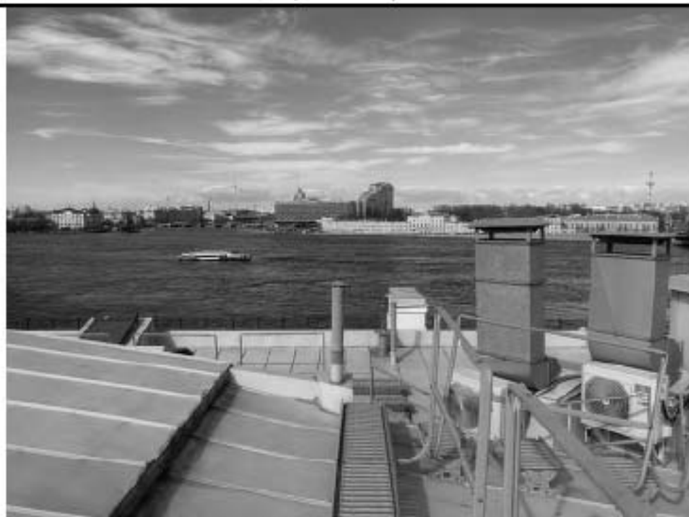
Фото 10.8 Фрагмент кровли здания
