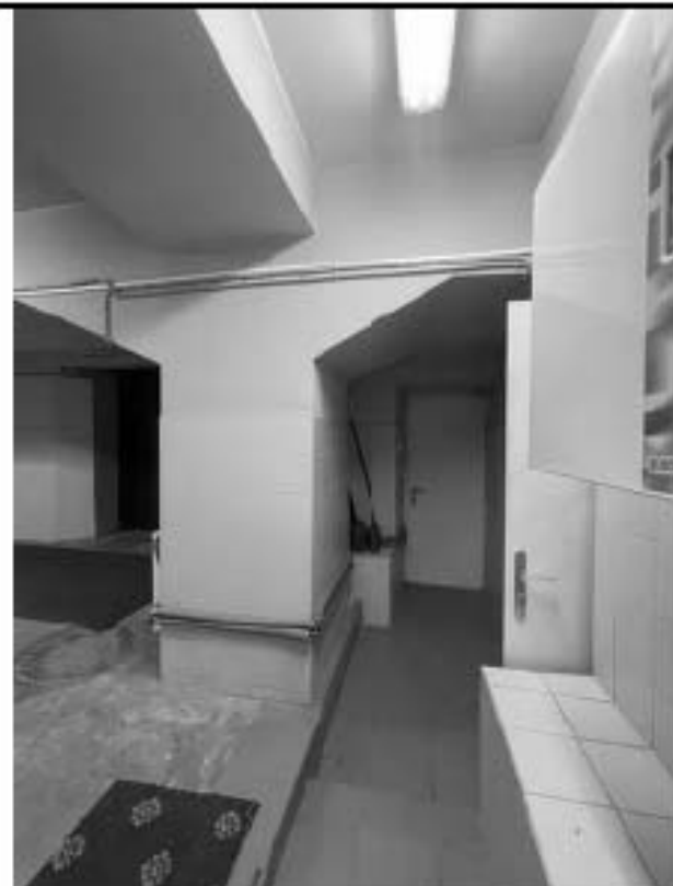
Фото 1.72 Помещение (ч.п.1) Вид в сторону Коридора (ч.п.3)
