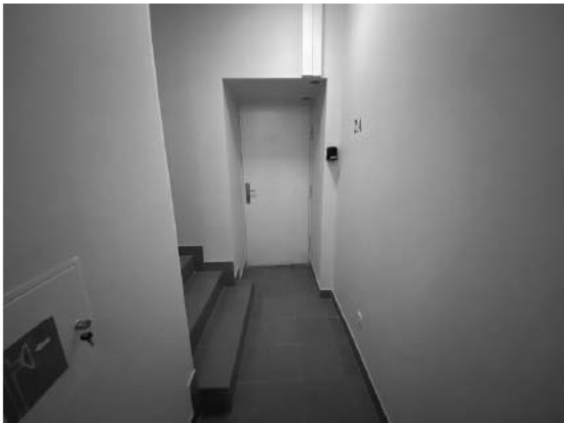
Фото 34. ОКНРЗ «Особняк Шереметьева» (СПб, Шпалерная ул., д.18, лит. А). Антресоль 2 этажа. Помещение 1-Н(148).
