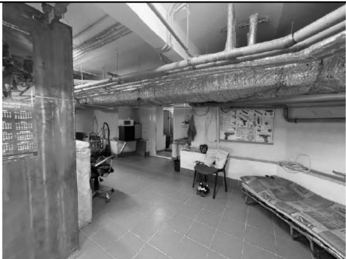
Фото 154 Техническое помещение (ч.п.26) Вид в сторону Мастерской (ч.п.24)
