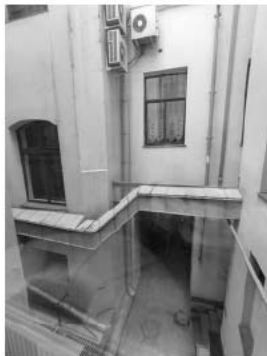
Фото 9.4 Вид дворового северо-западного фасада здания
