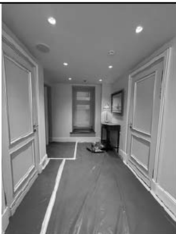
Фото 3.98 Коридор (ч.п.147) Вид в сторону наружной стены здания
