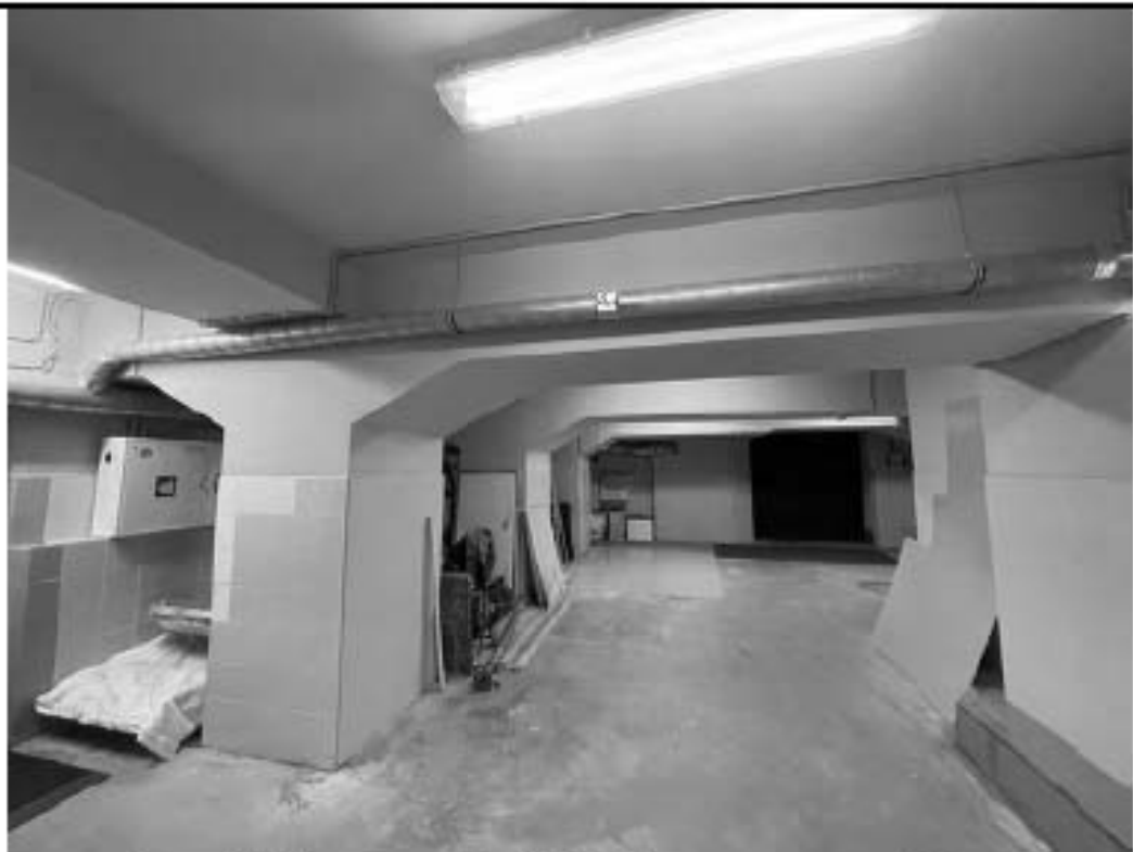
Фото 1.33 Помещение (ч.п.1). Вид в сторону наружной двери
