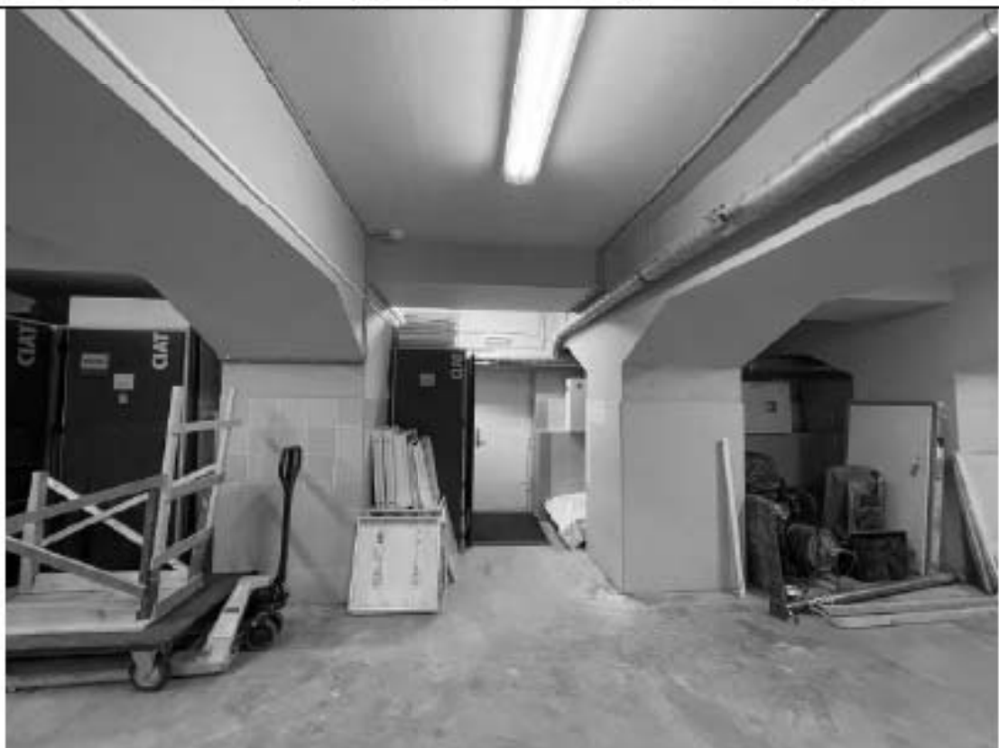
Фото 1.32 Помещение (ч.п.1).Вид в сторону Коридора(ч.п.28)
