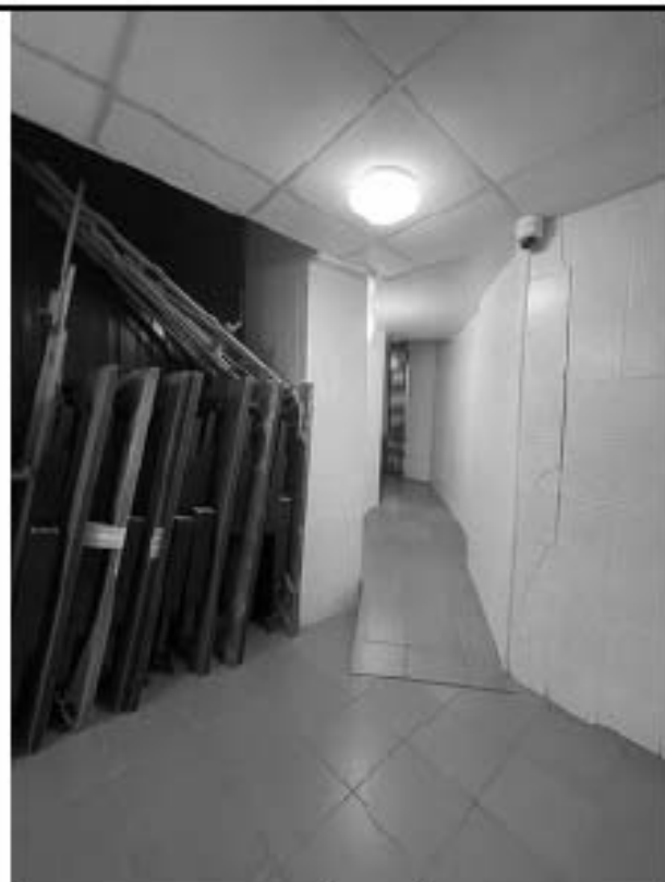
Фото 2.117 Коридор (ч.п.93). Вид в сторону прохода к кухне (ч.п.96)
