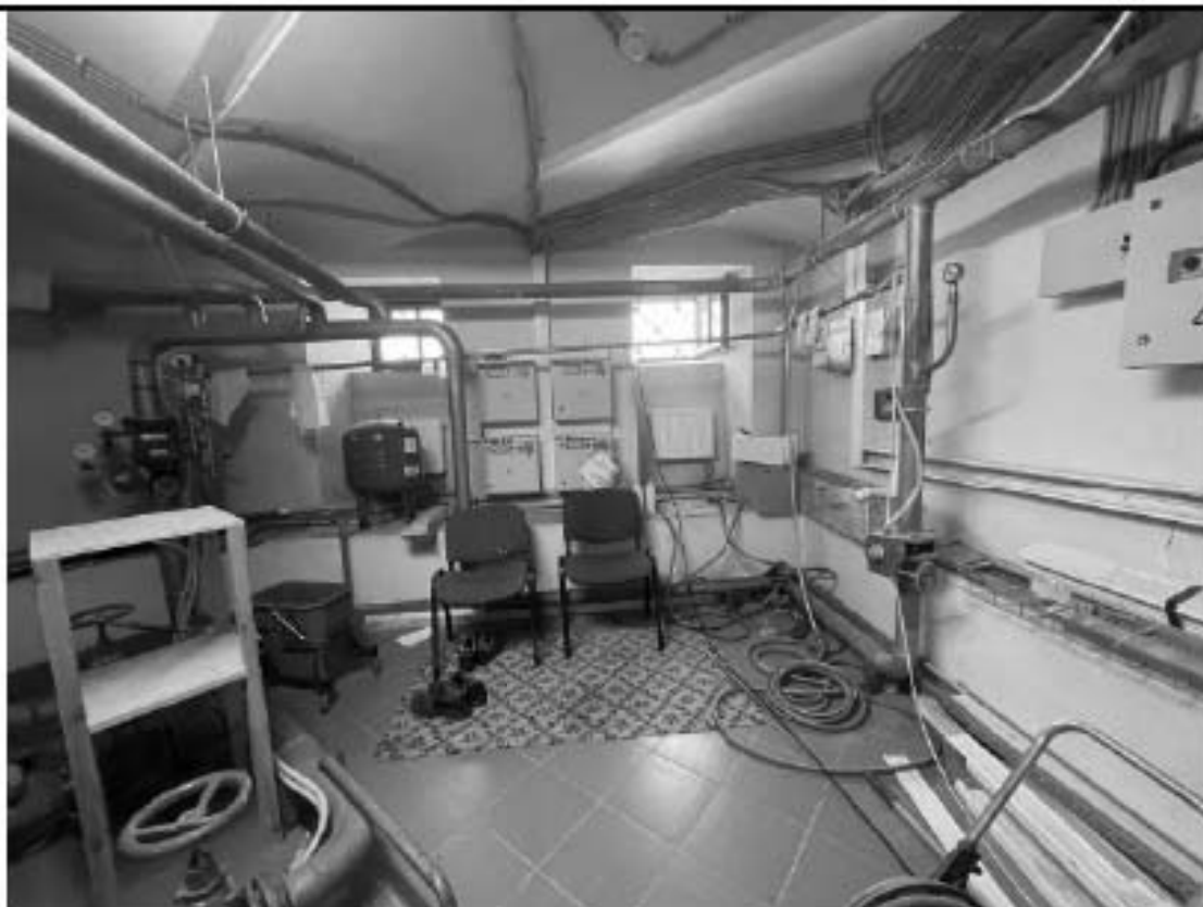
Фото 1.52 Техническое помещение (ч.п.26) Вид в сторону наружной стены здания
