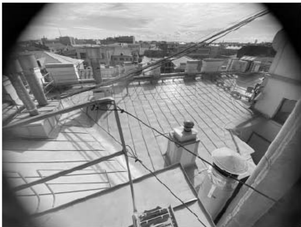
Фото 11.7 Фрагмент кровли здания
