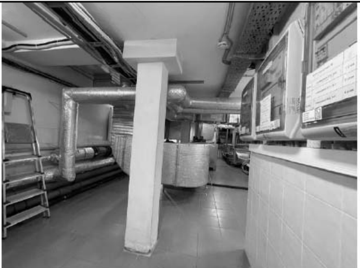
Фото 7.1 Техническое помещение (ч.п.289)
