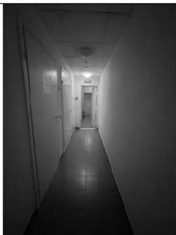
Фото 4.18 Коридор (ч.п.168). Вид в сторону Лестницы (ч.п.156)
