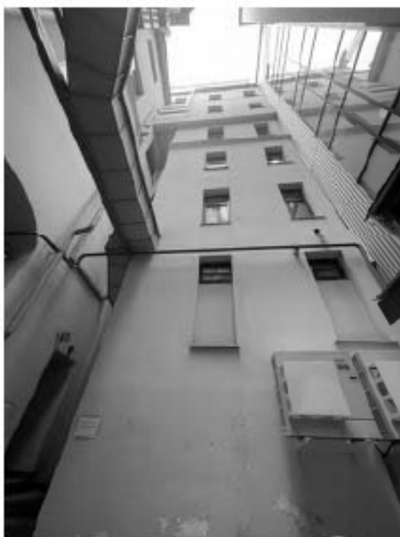
Фото 9.1 Вид дворового северо-восточного фасада здания
