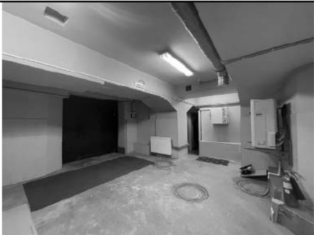
Фото 1.34 Помещение (ч.п.1). Вид в сторону наружной двери
