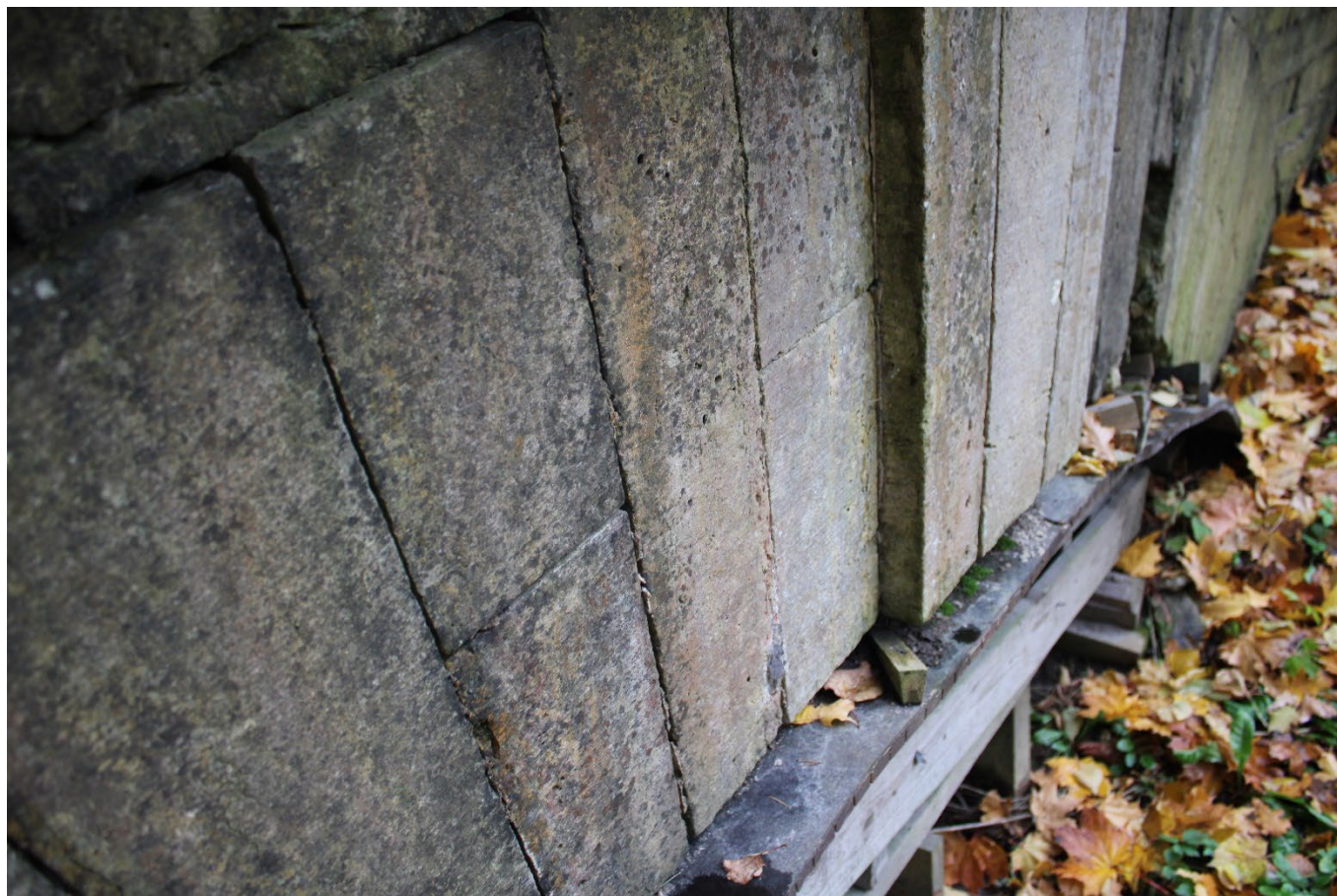
Фото 18. Гранитный блоки с веерной выкладкой и профилировкой по верхнему краю. Фрагмент. Вид с восточной стороны. Дата фотофиксации: 24.10.25
