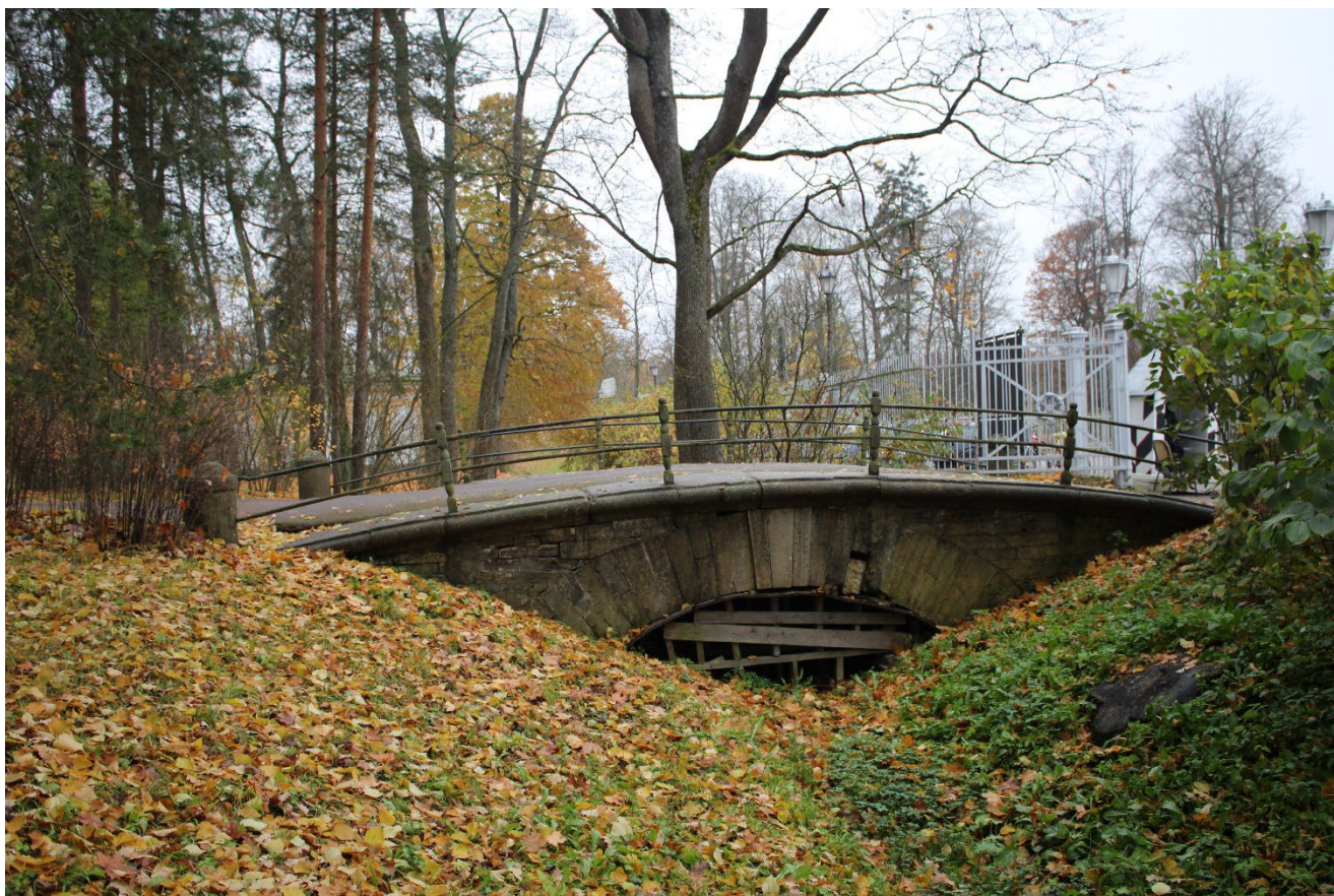
Фото 4. Однопролётный каменный мост с каменными устоями и цилиндрическим сводом. Общий вид. Восточная сторона. Дата фотофиксации: 24.10.25
