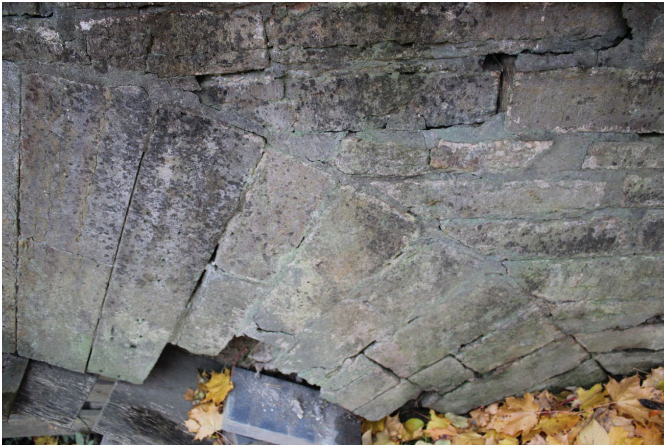
Фото 11. Гранитные блоки с всерной выкладкой и профилировкой по верхнему краю. Фрагмент. Дата фотофиксации: 24.10.25
