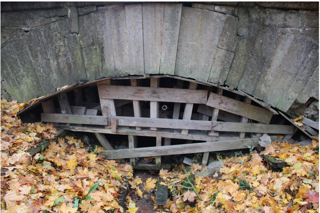
Фото 14. Гранитный блоки с веерной выкладкой и профилировкой по верхнему краю. Фрагмент. Вид с западной стороны. Дата фотофиксации: 24.10.25
