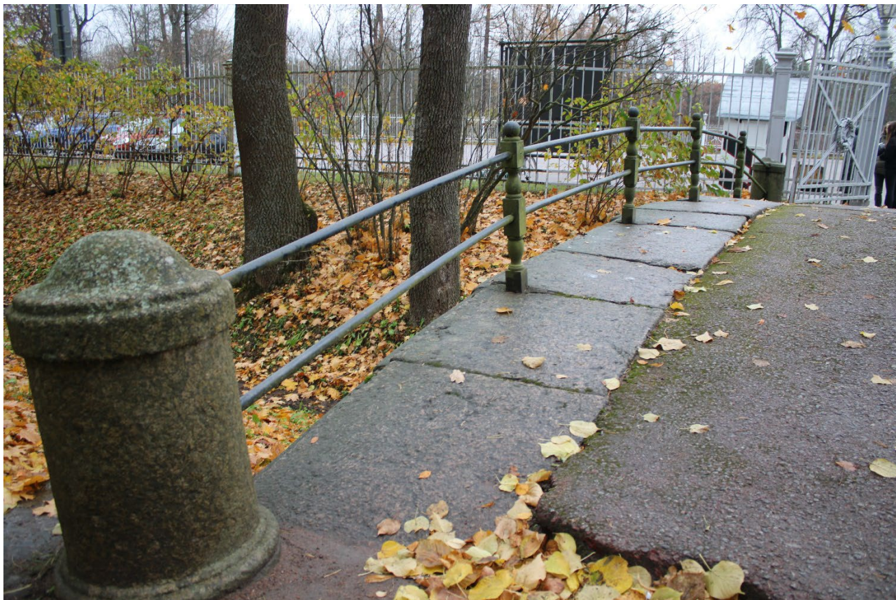
Фото 9. Металлическое перильное ограждение с фигурными вертикальными стойками и горизонтальными направляющими. Общий вид. Западная сторона. Дата фотофиксации: 24.10.25
