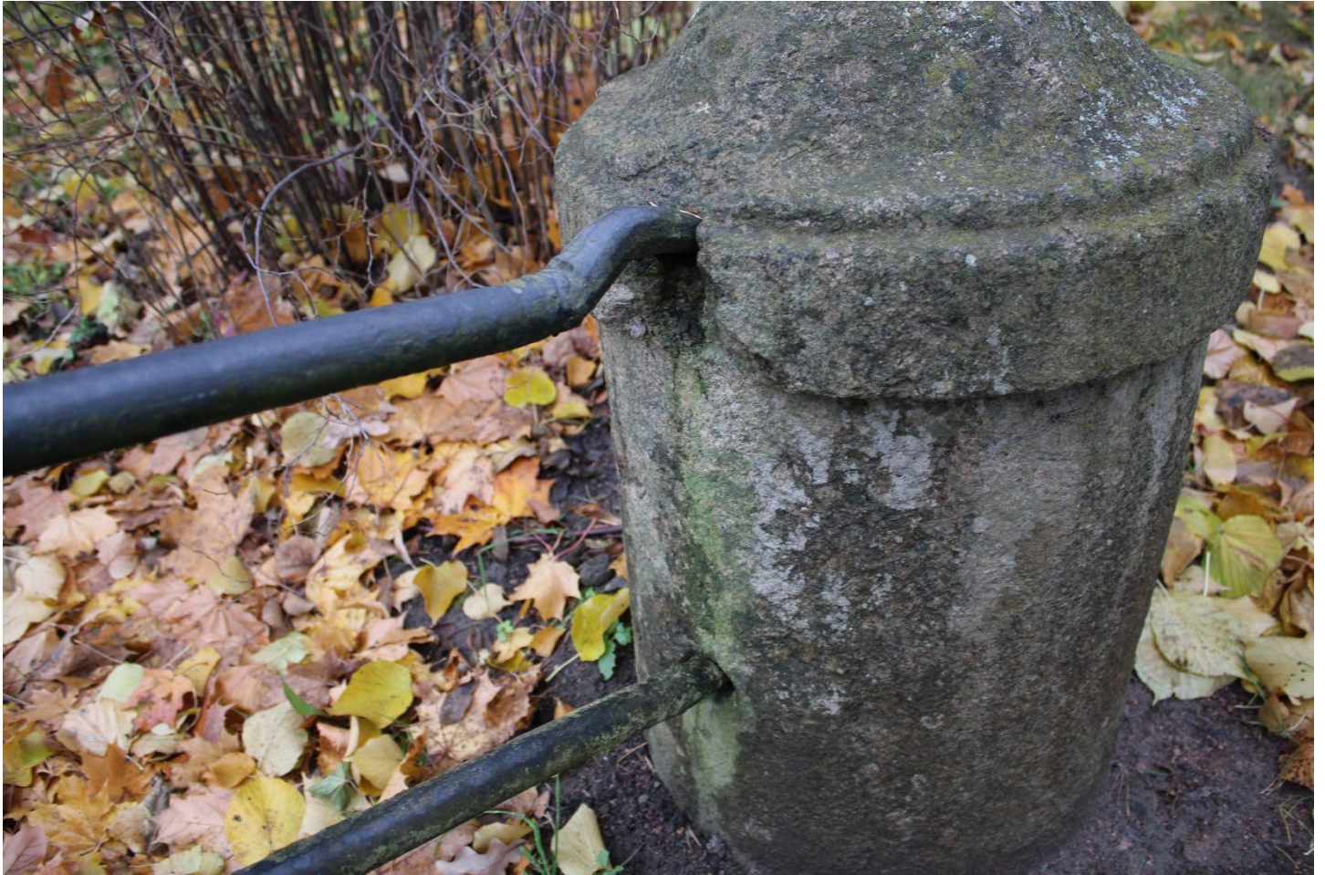
Фото 19. Место соединения металлического перильного ограждения и круглой в сечении гранитной тумбы. Общий вид. Восточная сторона. Дата фотофиксации: 24.10.25
