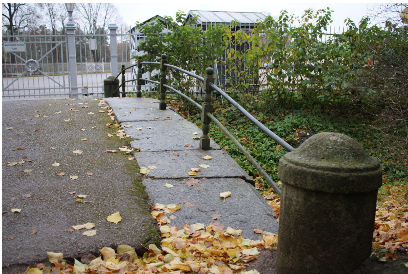
Фото 8. Металлическое перильное ограждение с фигурными вертикальными стойками и горизонтальными направляющими. Общий вид. Восточная сторона. Дата фотофиксации: 24.10.25
