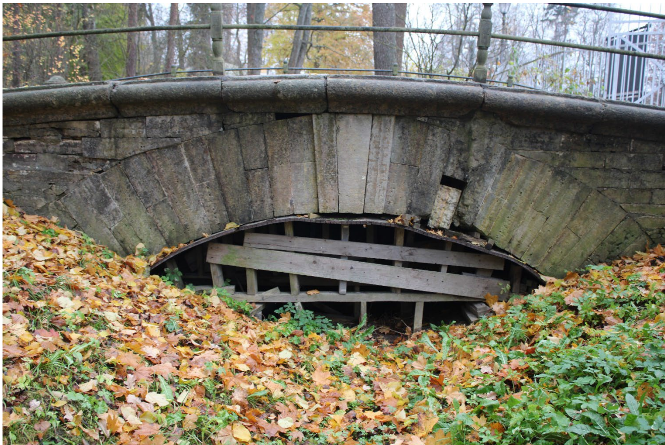
Фото 15. Гранитный блоки с всерной выкладкой и профилировкой по верхнему краю. Фрагмент. Вид с восточной стороны. Дата фотофиксации: 24.10.25
