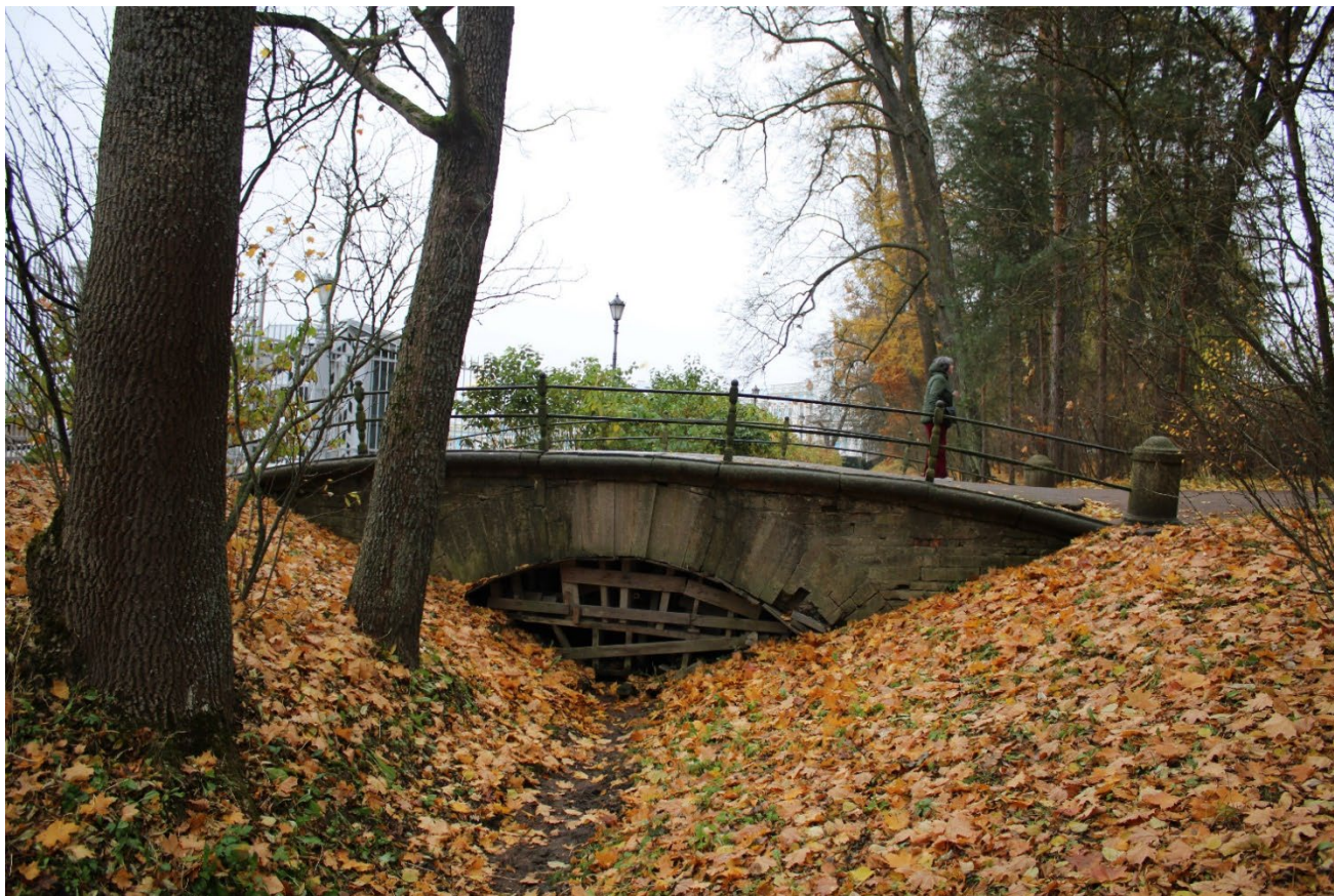
Фото 3. Однопролётный каменный мост с каменными устоями и цилиндрическим сводом. Общий вид. Западная сторона. Дата фотофиксации: 24.10.25
