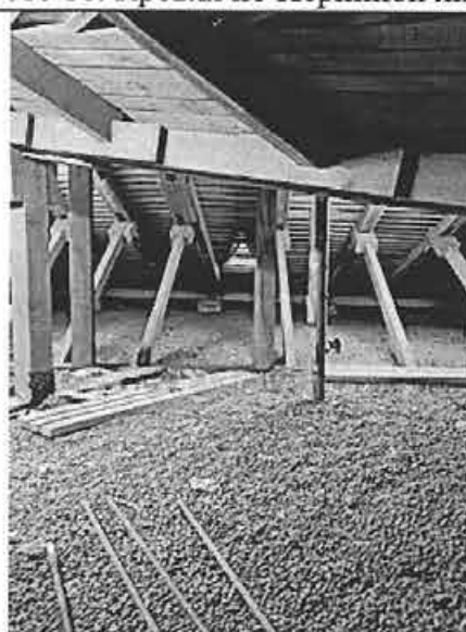
Фото 19-20. Чердачные помещения и стропильная система
