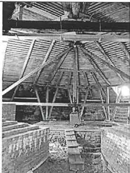
Фото 19-20. Чердачные помещения и стропильная система
