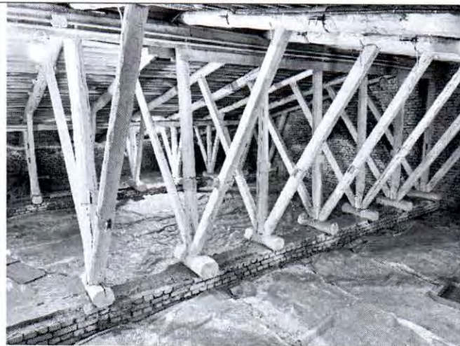
Фото 47. Чердак. Фрагмент стропильной системы. Фото от 24.10.2022.
