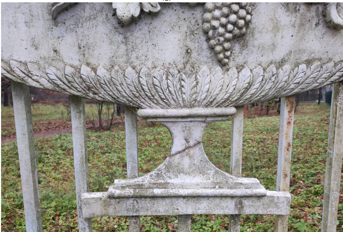
43. Решетка. Трещина на ножке фруктовой вазы.
