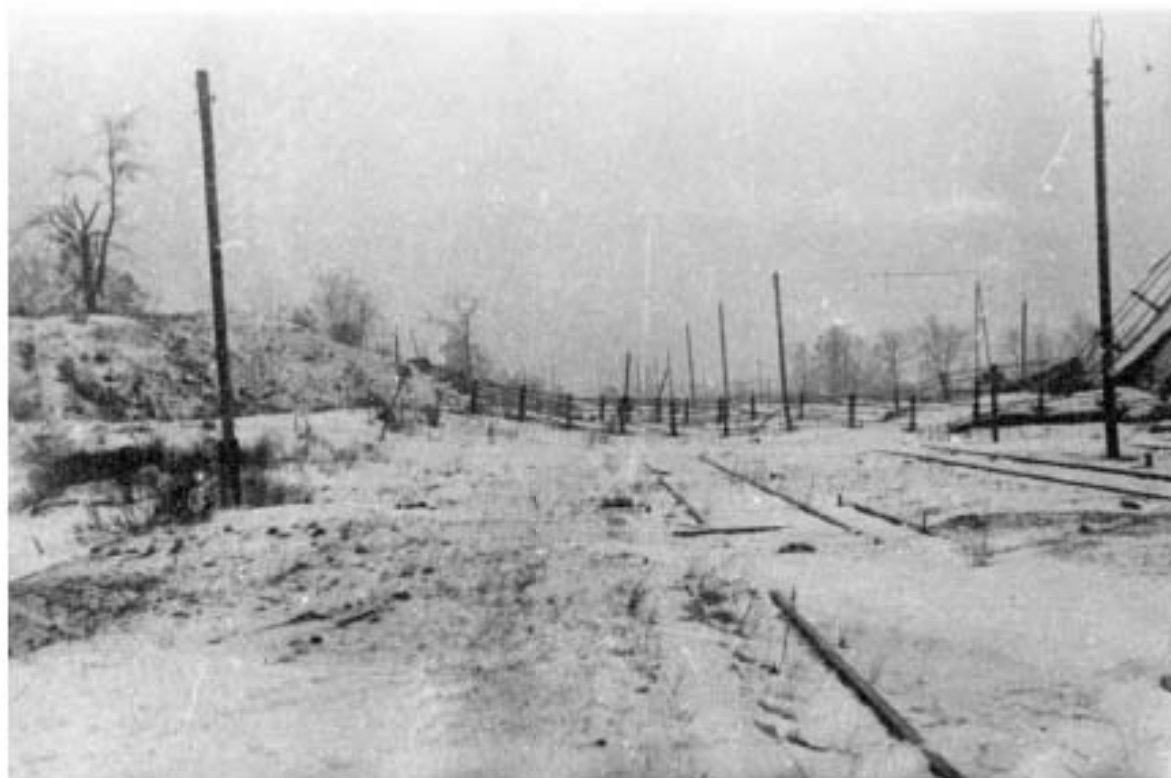
Илл. 68. Станция Павловск. Взорванный мост через железную дорогу. 1944 г. (источник: https://pastvu.com/p/115803 ).
