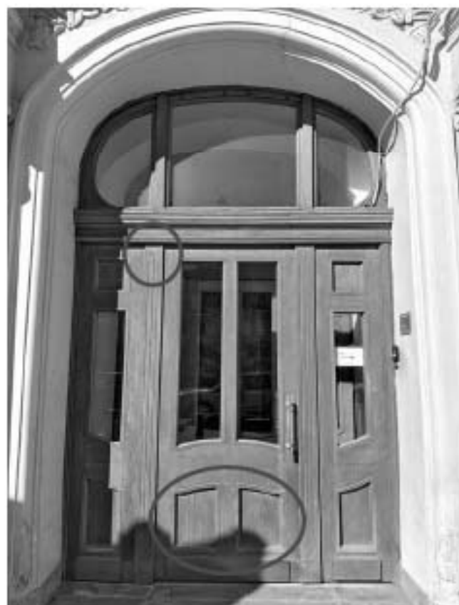
Фото 2025 г. Австрийская пл. Парадный вход. Новое дверное заполнение (изменены форма и расположение филенок в нижней части двери; отсутствуют раскреповки в тяге над дверным заполнением)
