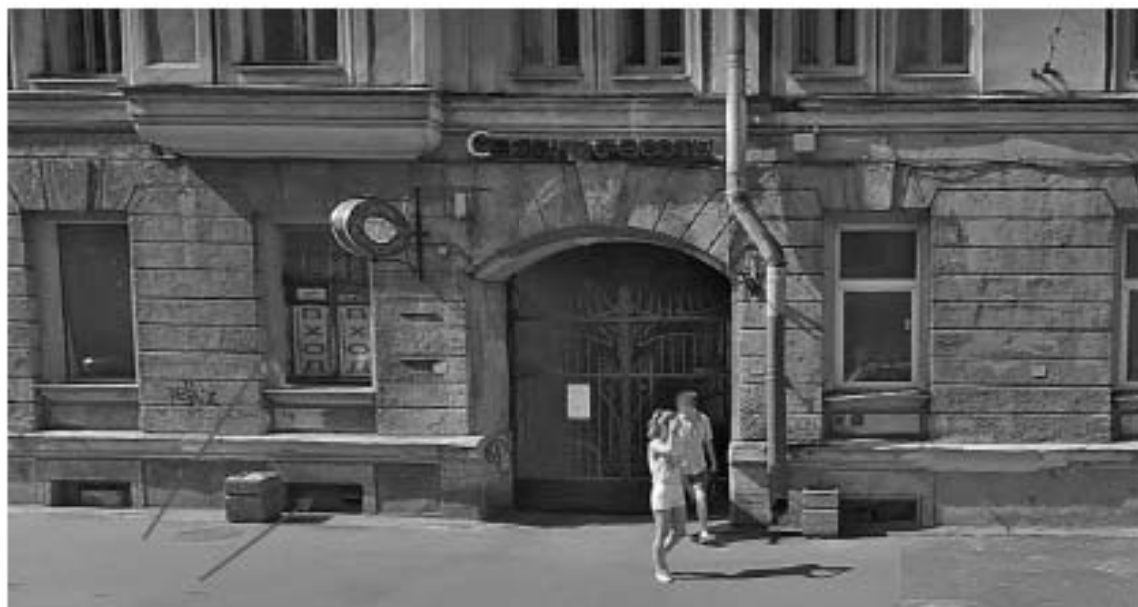
2013 г. Ул. Мира. Слева от арочного проезда оконные проемы в уровне 1 и цокольного этажей
