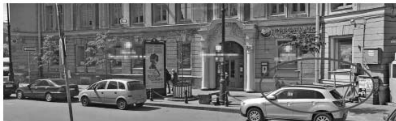
2016 г. Австрийская пл. С правой стороны ведется строительство приямка
