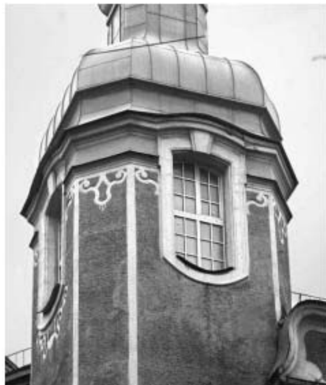
Фото 2025 г. Утрачен узорный рельефный фартук на большом окне башни фасада по Каменноостровскому пр.
