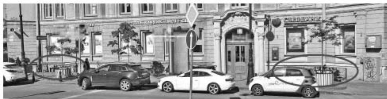
2019 г. Австрийская пл. С левой и правой сторон устроены входы в подвальный этаж через приямки
