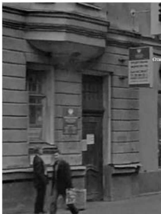
Фото 2009 г. Каменноостровский пр. Дверной проем оборудован фрамугой с исторической (вероятно) мелкой расстекловкой
