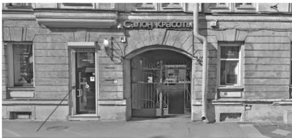
2024 г. Ул. Мира. Слева от арочного проезда на месте оконных устроен дверной проем
