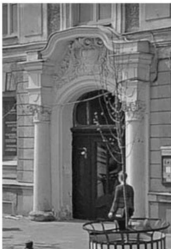
Фото 2013 г. Австрийская пл. Парадный вход. Дверное заполнение.
