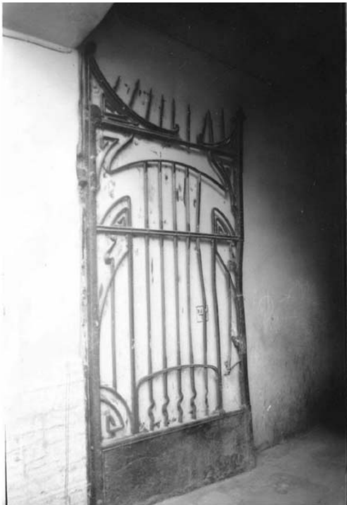
53. Вид створки ворот арочного проезда жилого дома № 10 на улице Мира (бывший доходный дом М.М. Горбова, архитектор В.В. Шауб, 1902-1903 гг.). Фотография. Автор фото – Овчинников Кирилл Владимирович. 21 апреля 1992 г. // Источник: ЦГАКФФД СПб. Фотодокументы. Оп. 1АР-167. Ед.хр.248421.
