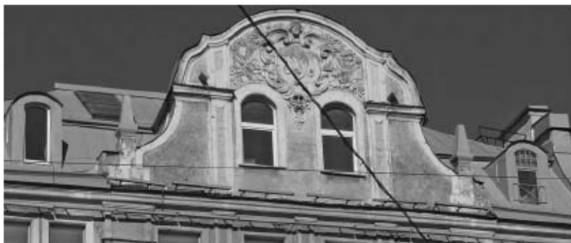
В начале 2000-х гг. лицевые корпуса надстроены шестым мансардным этажом
