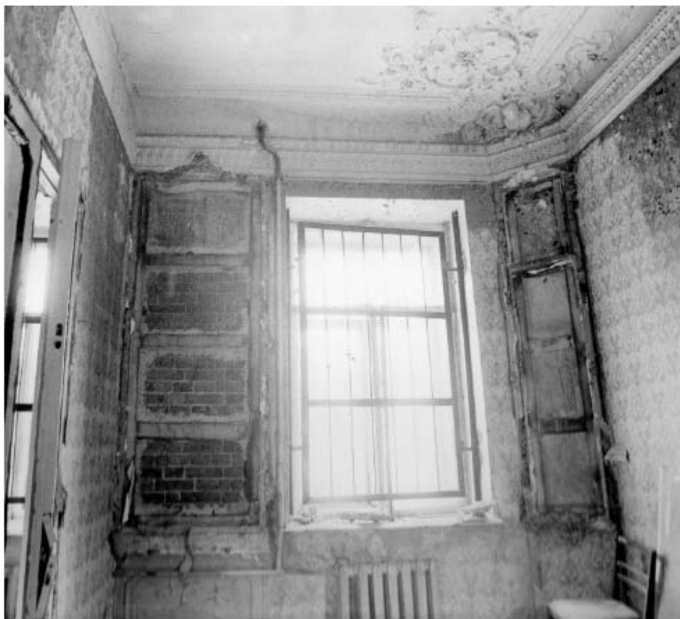
Ил. 96. Дом И.О. Утина. 1857 г. Арх. Р. Кузьмин. Конногвардейский бульвар, 17. Помещение 1-го эт. Фрагмент интерьера. 1990 г. Фото С.А. Шмидт. Архив КГИОП, шифр 292/8
