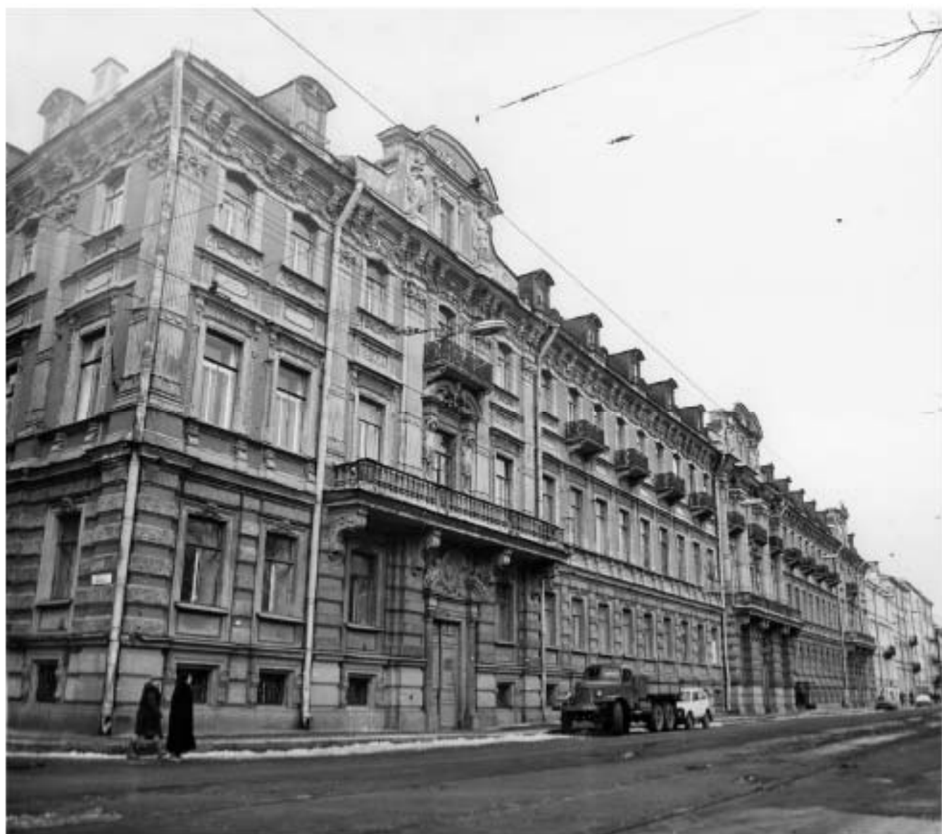
Ил. 90. Дом И.О. Утина. 1857 г. Арх. Р. Кузьмин. Конногвардейский бульвар. Фасад по бульвару Общий вид. 1990 г. Фото С.А. Шмидт. Архив КГИОП, шифр 292/28
