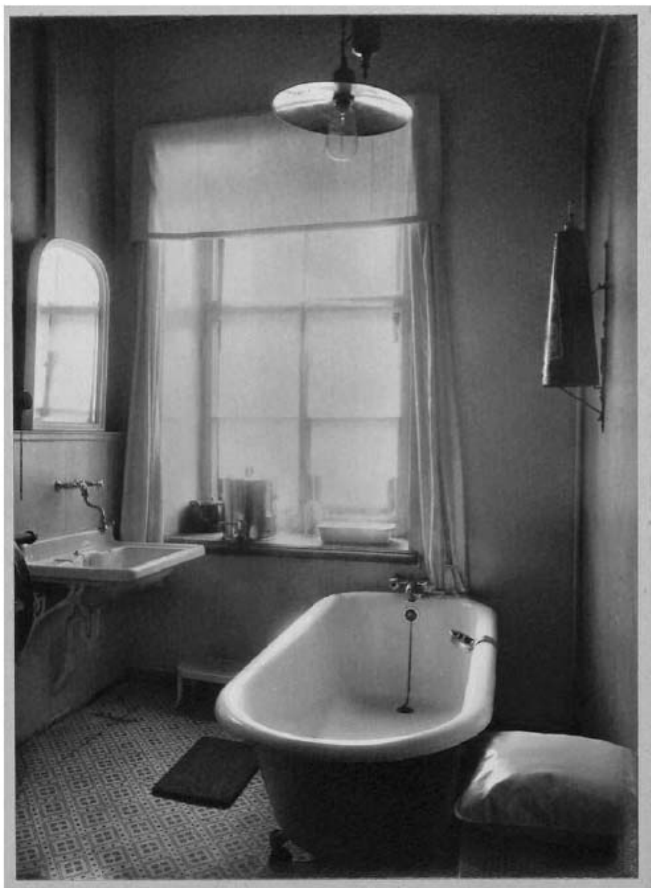
Ил. 83. Вид ванной комнаты (№ 2) госпиталя. 1914-1916 гг. ЦГАКФФД СПб П 358 сн.37
