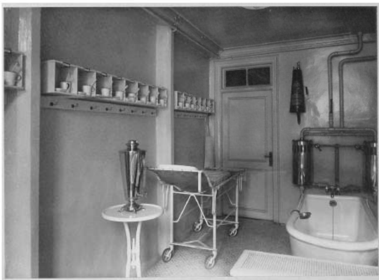
Ил. 68. Вид части ванной комнаты (№ 1) госпиталя. 1914-1916 гг. ЦГАКФФД СПб П 358 сн.22
