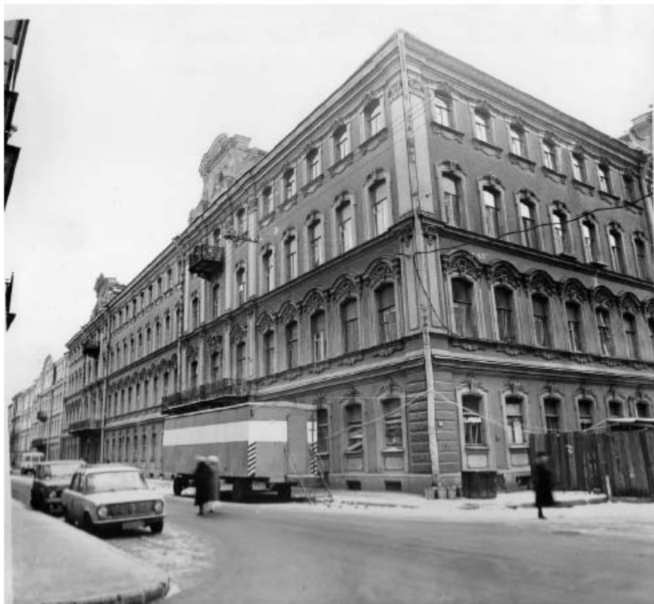
Ил. 89. Дом И.О. Утина. 1857 г. Арх. Р. Кузьмин. Конногвардейский бульвар., 17. Фасад по Красной ул. 1990 г. Фото С.А. Шмидт. Архив КГИОП, шифр 292/26
