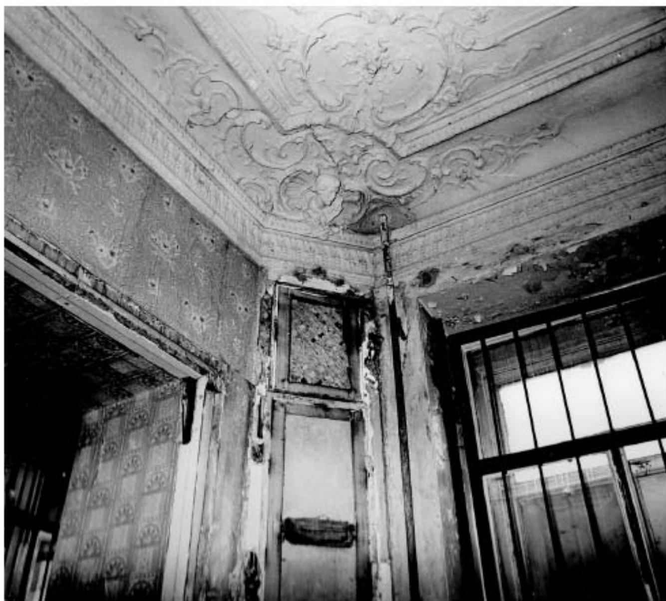
Ил. 108. Дом И.О. Утина. 1857 г. Арх. Р. Кузьмин. Конногвардейский бульвар, 17. Помещение 1-го эт. Фрагмент интерьера. 1990 г. Фото С.А. Шмидт. Архив КГИОП, шифр 292/22
