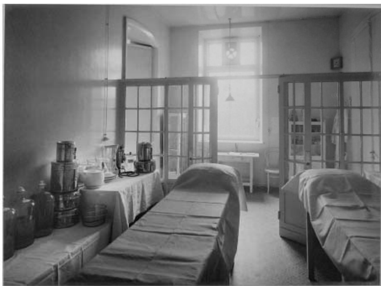
Ил. 59. Вид части перевязочной госпитали. 1914-1916 гг. ЦГАКФФД СПб П 358 с.13
