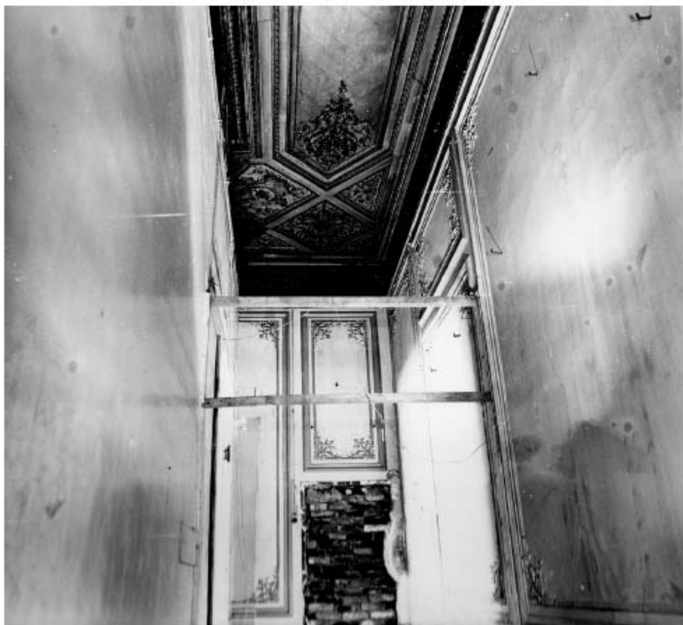
Ил. 103. Дом И.О. Утина. 1857 г. Арх. Р. Кузьмин. Конногвардейский бульвар, 17. Помещение 2-го эт. 1990 г. Фото С.А. Шмидт. Архив КГИОП, шифр 292/16
