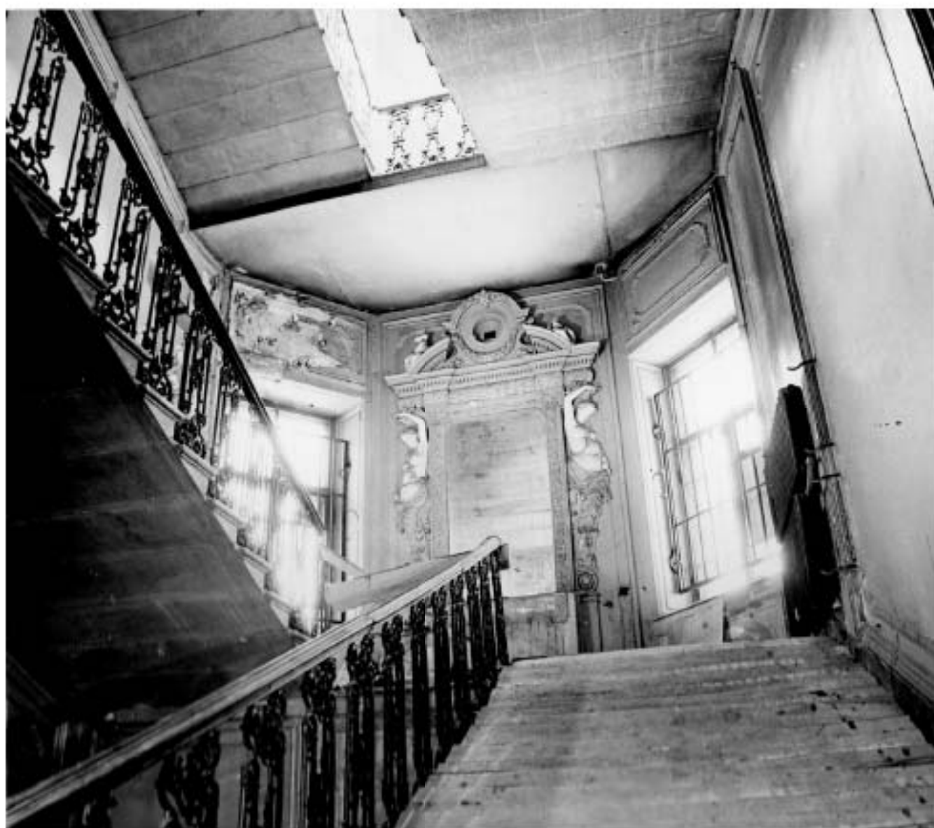
Ил. 99. Дом И.О. Утина. 1857 г. Арх. Р. Кузьмин. Конногвардейский бульвар, 17. Интерьер парадной лестницы. 1990 г. Фото С.А. Шмидт. Архив КГИОП, шифр 292/12
