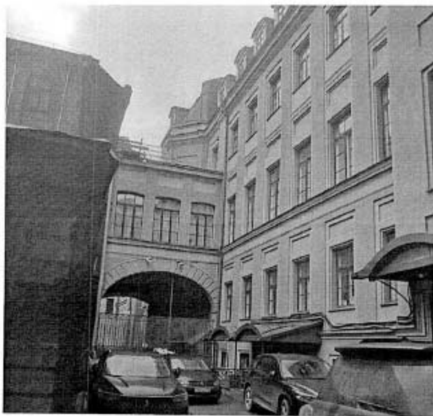
Фрагмент дворового фасада
