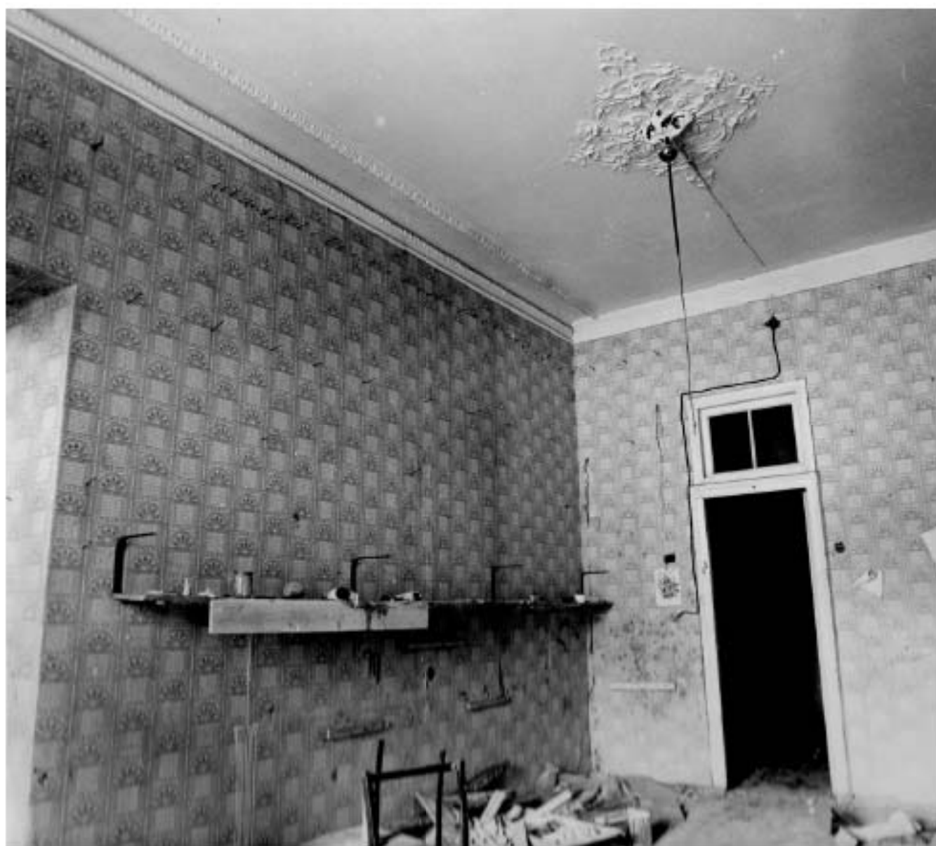
Ил. 107. Дом И.О. Утина. 1857 г. Арх. Р. Кузьмин. Конногвардейский бульвар, 17. Помещение 1-го эт. Фрагмент интерьера. 1990 г. Фото С.А. Шмидт. Архив КГИОП, шифр 292/21
