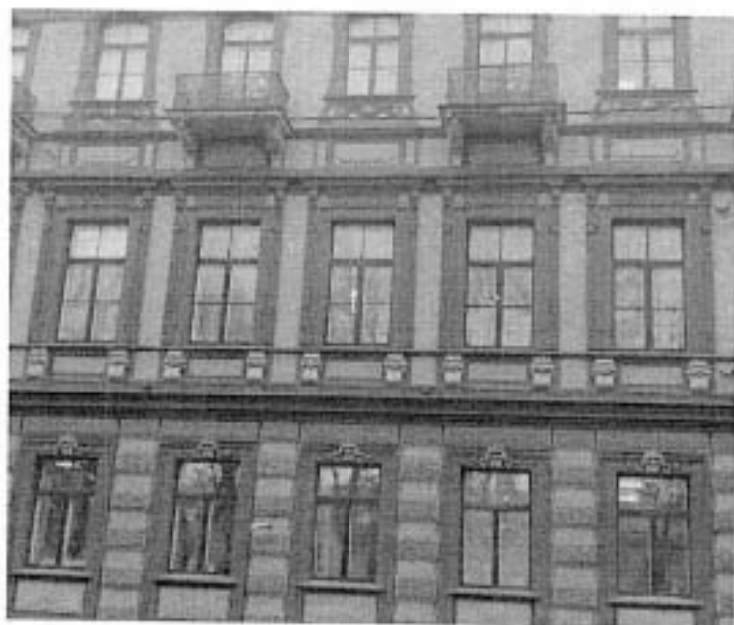
Фрагмент лицевого фасада со стороны Конногвардейского б-ра
