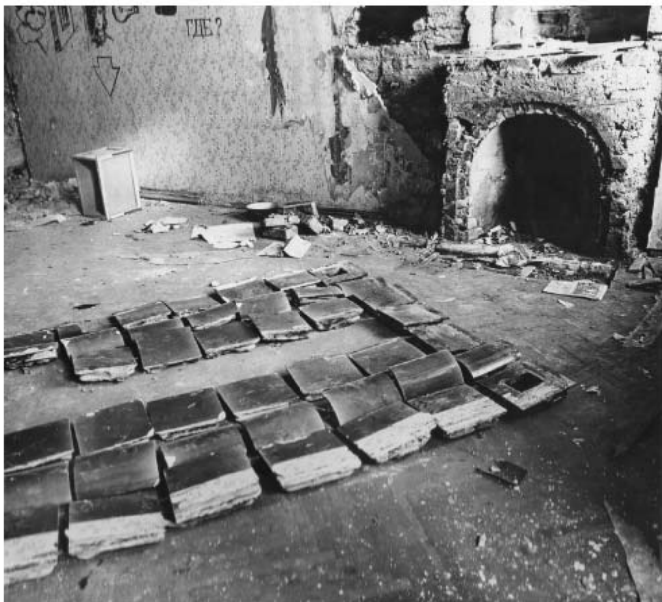
Ил. 93. Дом И.О. Утина. 1857 г. Арх. Р. Кузьмин. Конногвардейский бульвар, 17. Помещение 3-го эт. 1990 г. Фото С.А. Шмидт. Архив КГИОП, шифр 292/5
