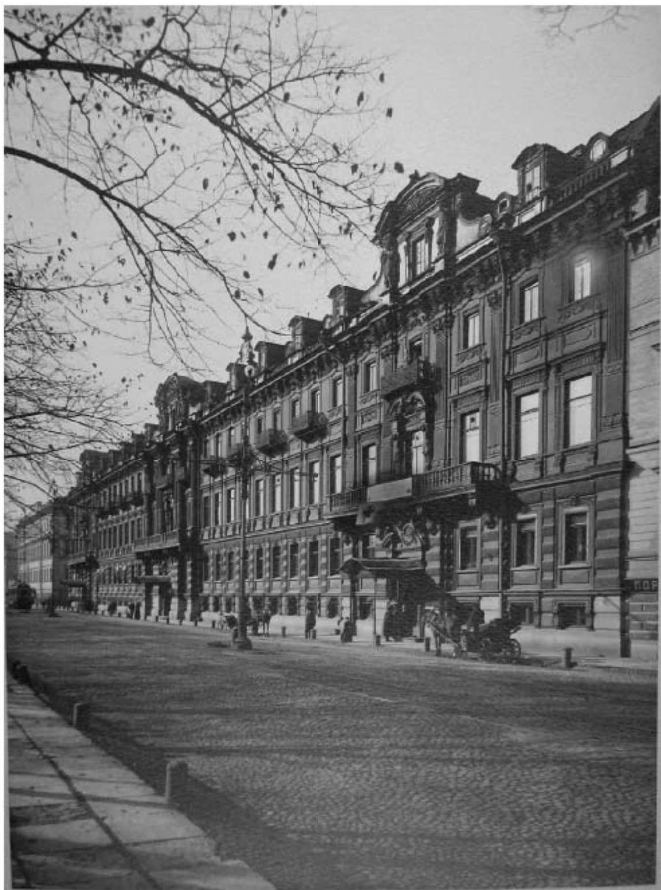
Ил. 47. Вид здания, где размещается лазарет (Конногвардейский бульвар, 17). 1914-1916 гг. ЦГАКФФД СПб П 358 сн.1
