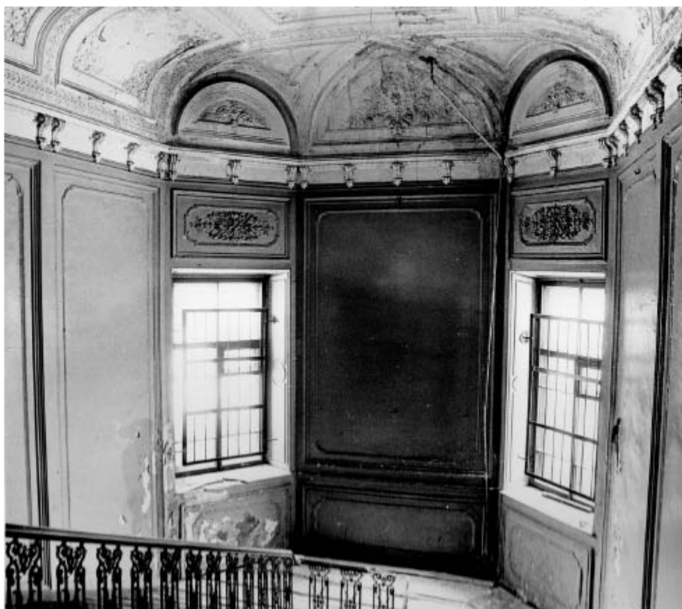
Ил. 97. Дом И.О. Утина. 1857 г. Арх. Р. Кузьмин. Конногвардейский бульвар, 17. Лестница со стороны бульвара. 1990 г. Фото С.А. Шмидт. Архив КГИОП, шифр 292/9
