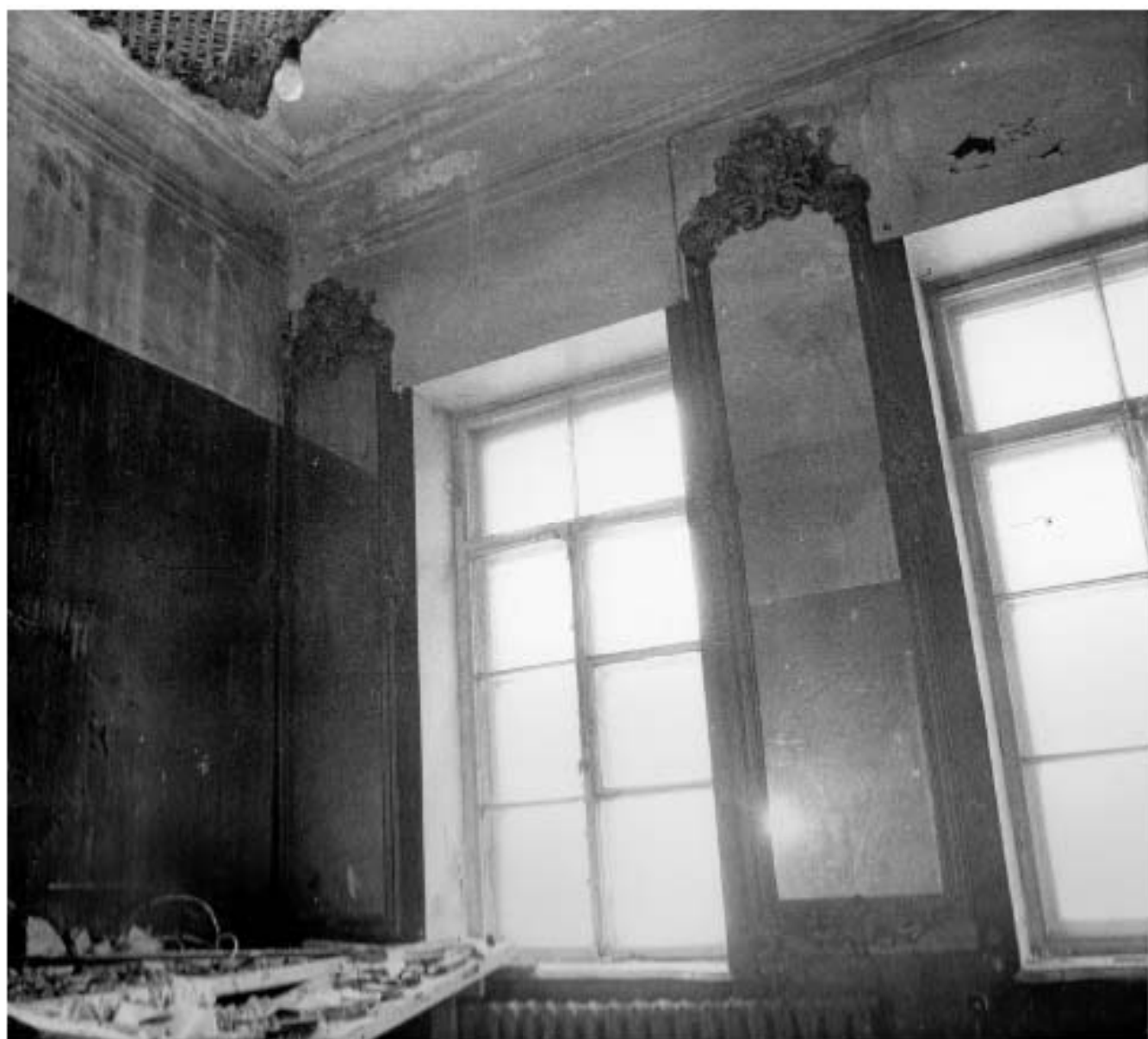
Ил. 102. Дом И.О. Утина. 1857 г. Арх. Р. Кузьмин. Конногвардейский бульвар, 17. Помещение 2-го эт. Фрагмент интерьера. 1990 г. Фото С.А. Шмидт. Архив КГИОП, шифр 292/15
