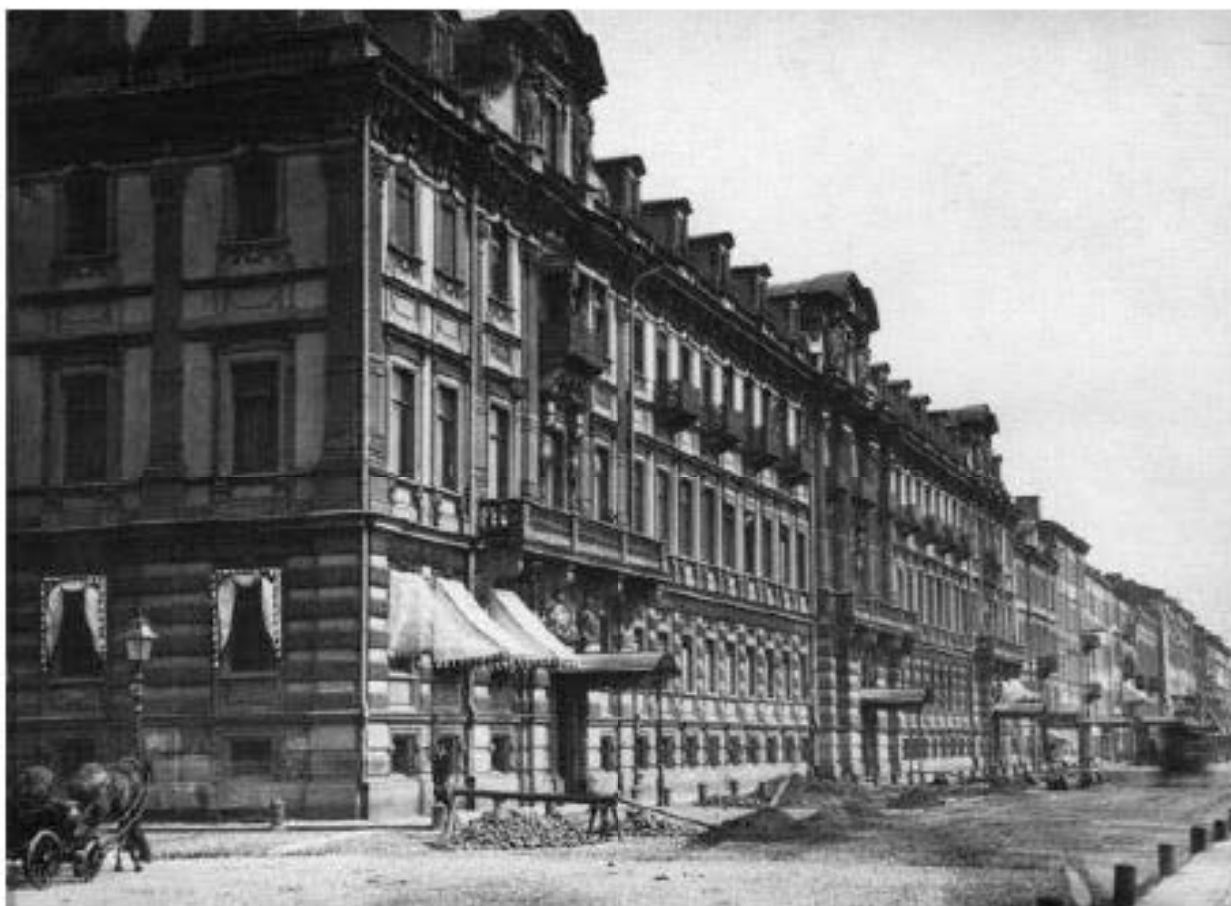
Ил. 46. Кашовский бульвар, дом Гинзбурга. Фото 1870-е, Буффа Ф. (отпечаток на альбуминовой бумаге). /https://www.citywalls.ru/photo145654.html?s=180bc9526g6sk0aq92v8kvr3k6
