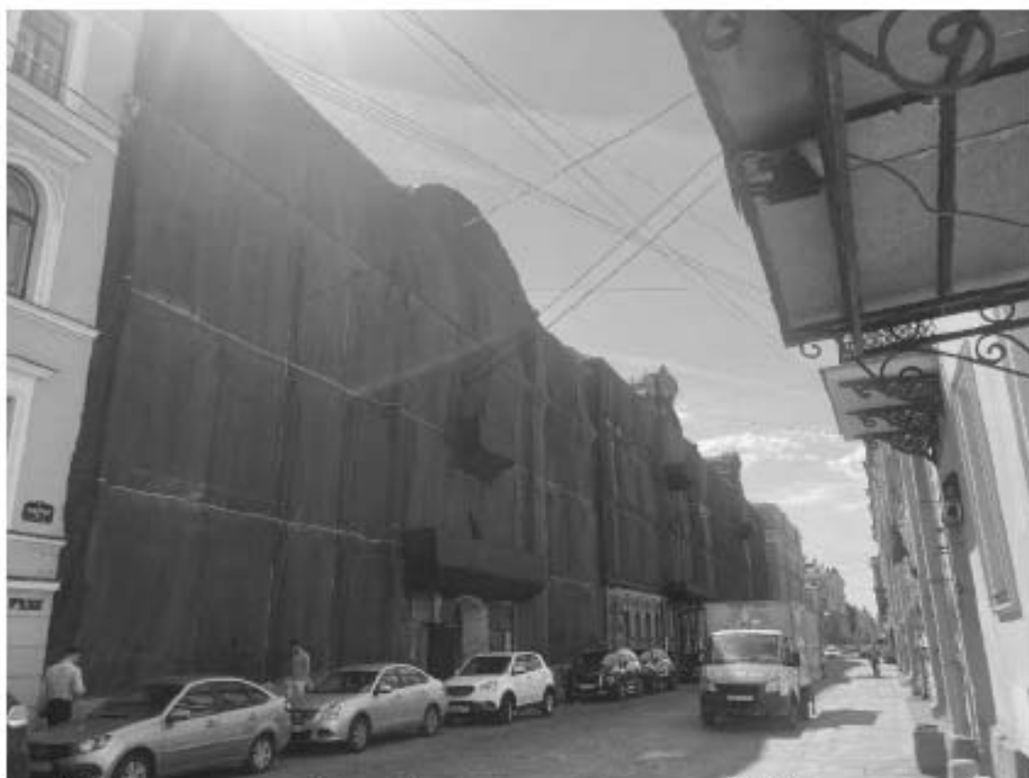
3. Здание по адресу: Санкт-Петербург, ул. Галерная, д. 20-22, строение 1 (часть здания ОКН по пер. Замятина и Галерной ул.) Общий вид на здание. Дата съемки: 10.07.2025
