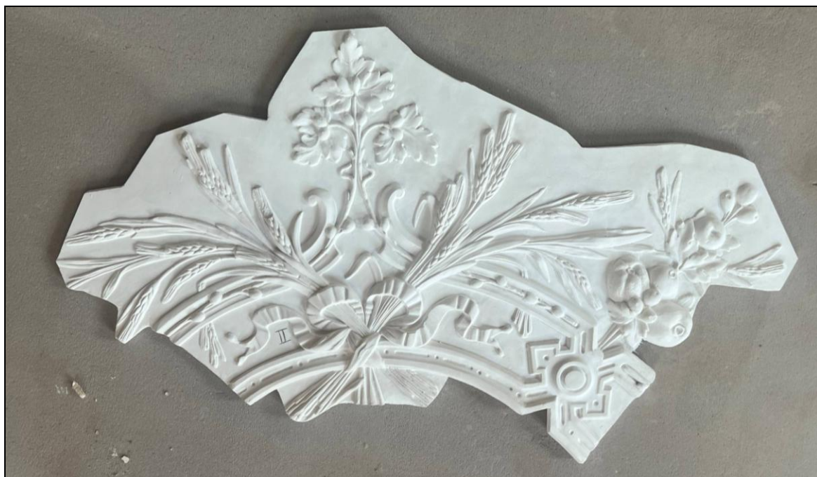
27. Объект культурного наследия регионального значения «Дом, где с 1886 г. жил и в 1890 г. умер создатель первого в мире самолета Можайский А.Ф.». Изготовленная модель деталей лепного декора, подлежащих восстановлению (лепной декор в помещениях №№ 15, 20 и 21 согласно паспорту на квартиру).
