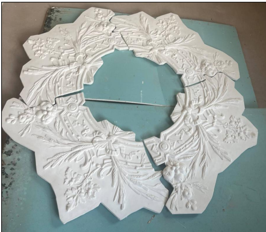
26. Объект культурного наследия регионального значения «Дом, где с 1886 г. жил и в 1890 г. умер создатель первого в мире самолета Можайский А.Ф.». Изготовленная модель деталей лепного декора, подлежащих восстановлению (лепной декор в помещениях №№ 15, 20 и 21 согласно паспорту на квартиру).
