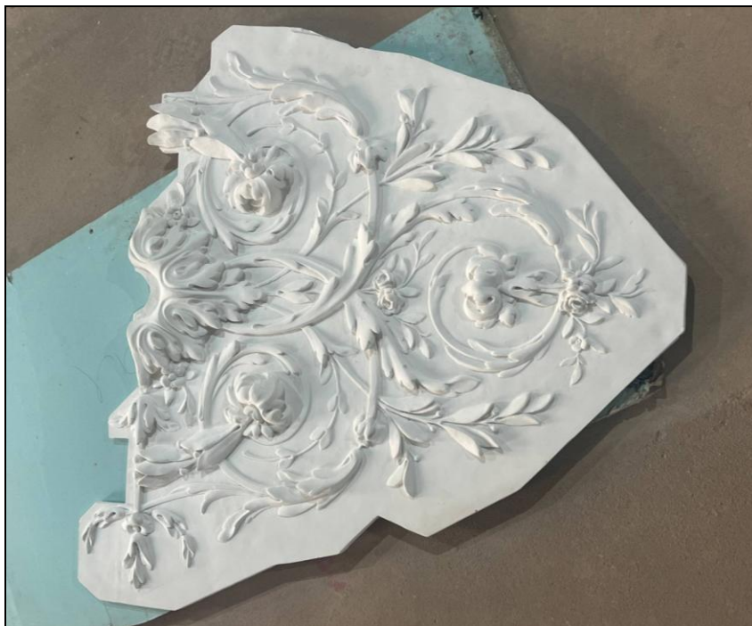
28. Объект культурного наследия регионального значения «Дом, где с 1886 г. жил и в 1890 г. умер создатель первого в мире самолета Можайский А.Ф.». Изготовленная модель деталей лепного декора, подлежащих восстановлению (лепной декор в помещении № 16 согласно паспорту на квартиру).
