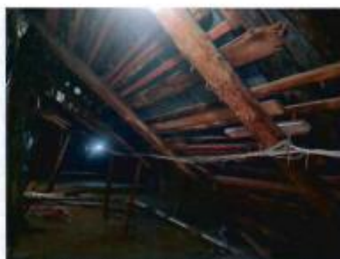
13. Фрагмент стропильной системы. Подпорки под стропилами. (25.09.2023)
