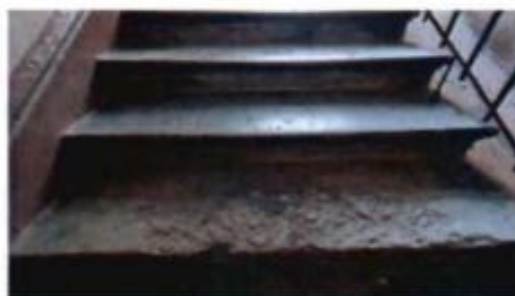
26. Ступени 3-ЛК. Сколы, трещины, истертости. (25.09.2023)
