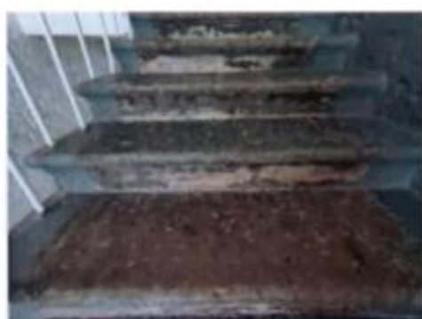
36. Ступени 2-ЛК. Сколы, трещины. (25.09.2023)
