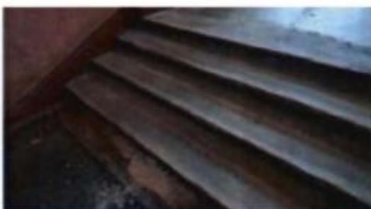
25. Известняковые ступени вестибюля 3-ЛК залиты бетоном. (25.09.2023)
