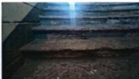
16. Ступени 1-ЛК. Сколы, трещины, истертости. (25.09.2023)
