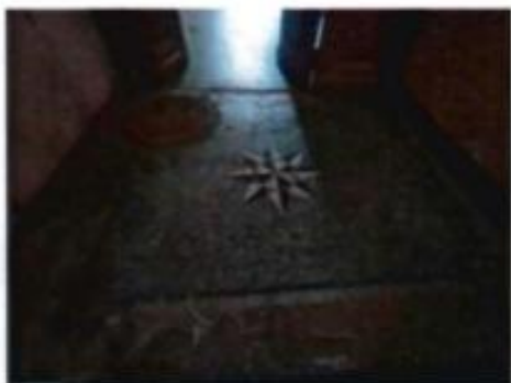
23. Покрытие полов 3-ЛК. Сколы, трещины. (25.09.2023)
