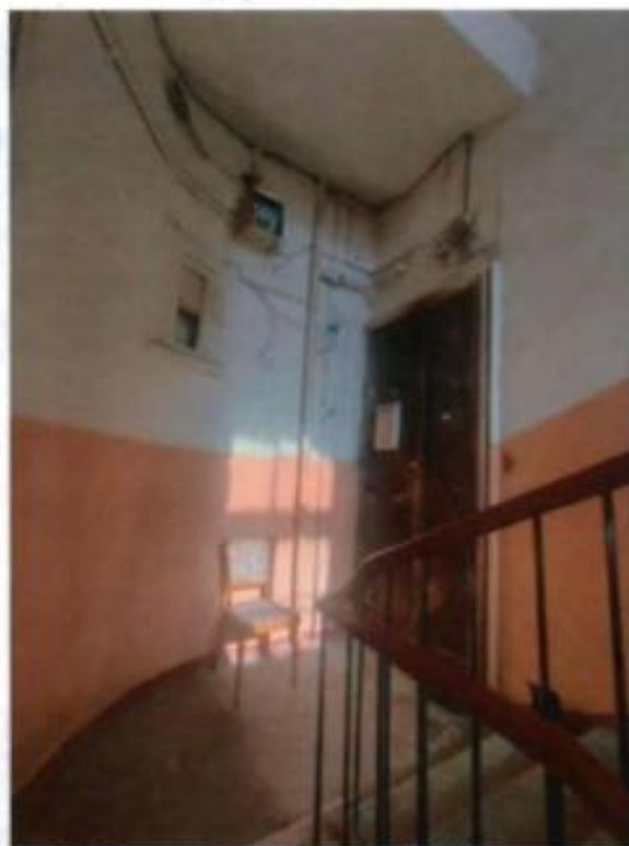
39. Лестничная клетка 4-ЛК. Шелушение окрасочного слоя стен. (25.09.2023)
