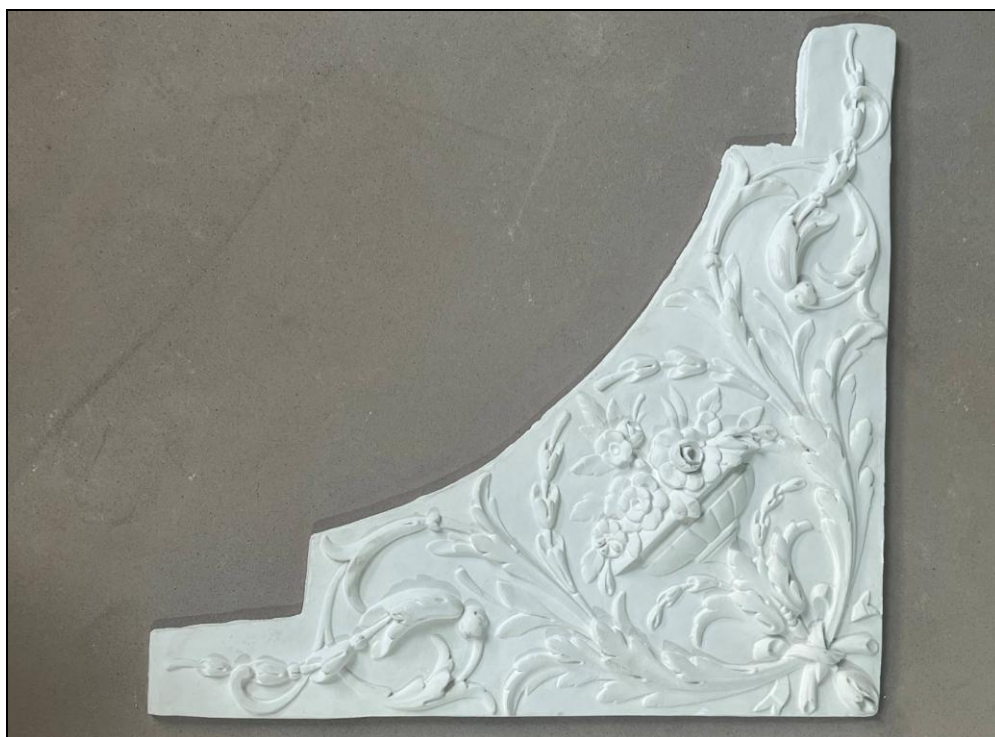
29. Объект культурного наследия регионального значения «Дом, где с 1886 г. жил и в 1890 г. умер создатель первого в мире самолета Можайский А.Ф.». Изготовленная модель деталей лепного декора, подлежащих восстановлению (лепной декор в помещении № 11 согласно паспорту на квартиру).
