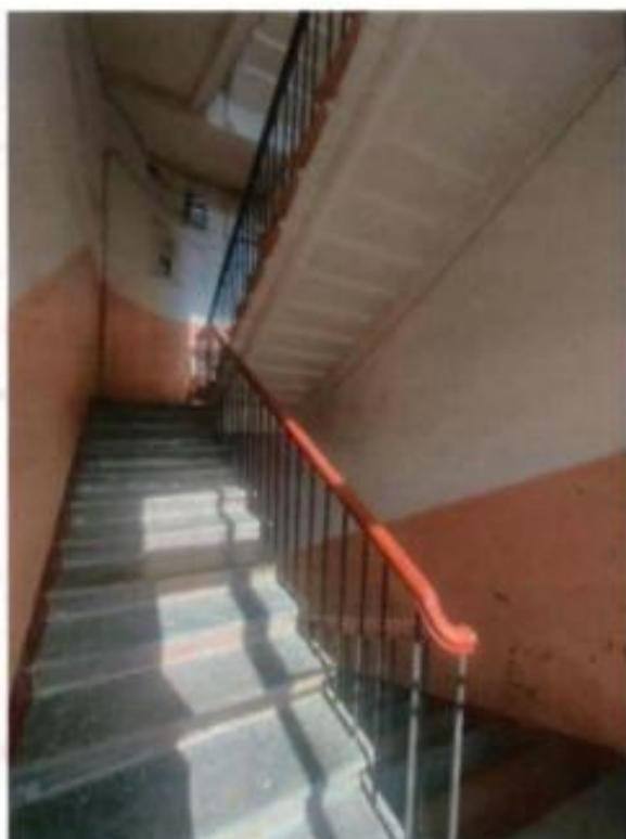
38. Лестничная клетка 4-ЛК. Шелушение окрасочного слоя стен. (25.09.2023)
