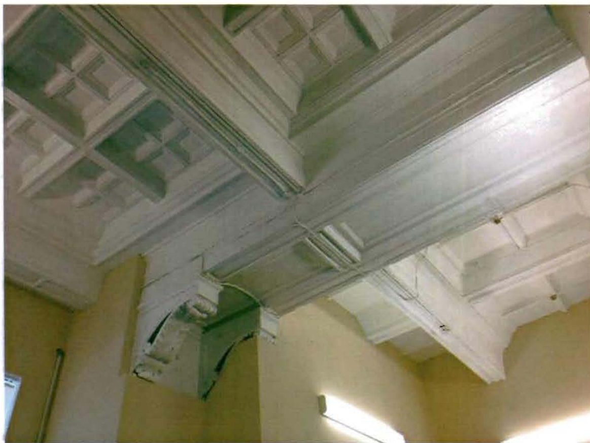
7. Оформление потолка пом. 35-Н (17).
